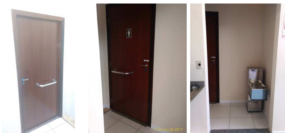
Figura 14: Porta Banheiro PNE
