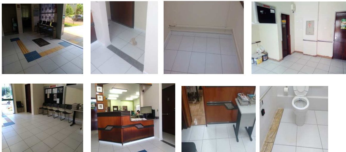
Figura 19 - Piso podotátil na recepção e cerâmica escura, OAB e banheiro adaptado. Soleiras em granito cinza andorinha e rodapés Santa Luzia, brancos.
