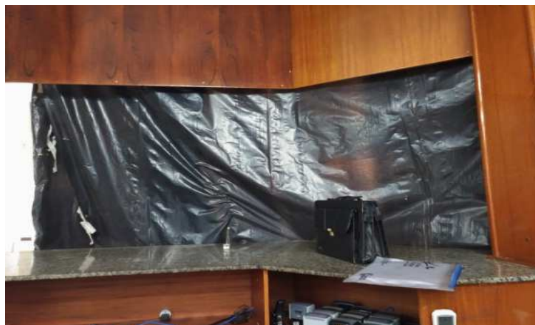
Figura 6 - Fechamento com painel e lona plástica.
