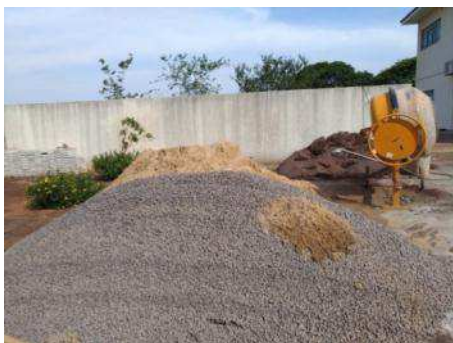
Figura 10 - Material para contra piso.
