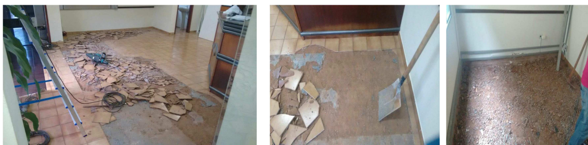
Figura 7 - Demolição de piso secretaria e OAB
