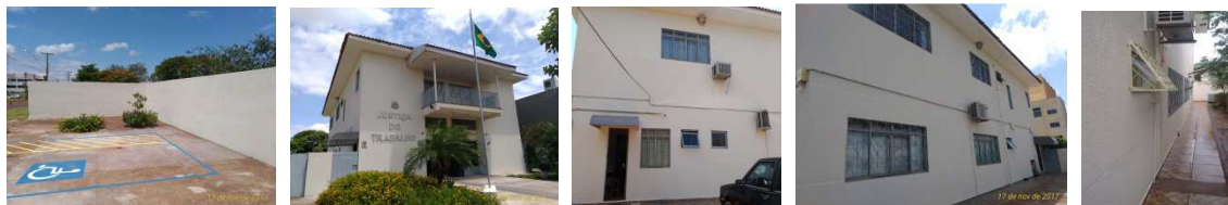
Figura 20 - Pintura do muro (lado externo), pintura de fachada, laterais e fundos.
