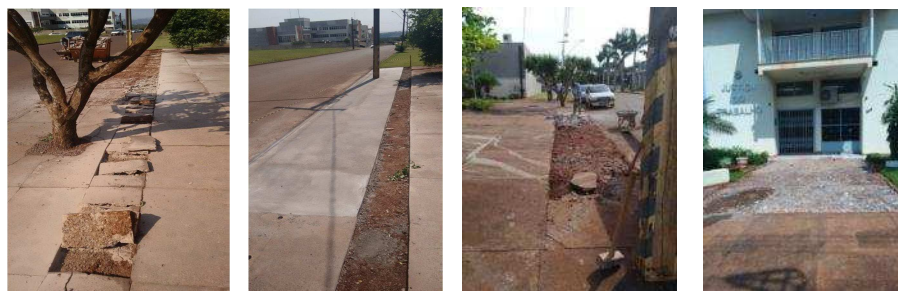
Figura 4 - Demolição de calçada frontal.
