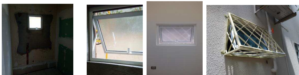
Figura 15: Janela banheiro PNE - Máximo ar
