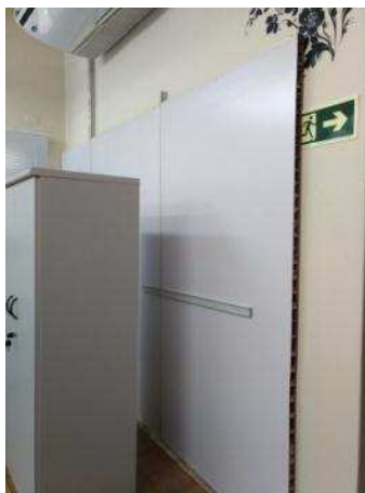
Figura 6 - Fechamento com painel e lona plástica.
