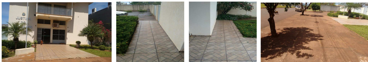
Figura 2 - Imagens externas antes da obra.
