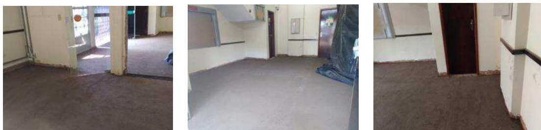
Figura 18 - Contra piso espera, OAB e banheiro adaptado.
