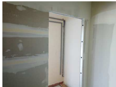
Figura 15: Divisórias em gesso acartonado e alvenaria na parede banheiro.
