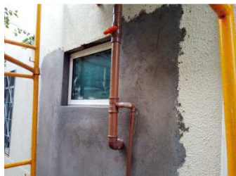
Figura 16: Chapisco e emboço em alvenaria na parede banheiro. Azulejos banheiro
