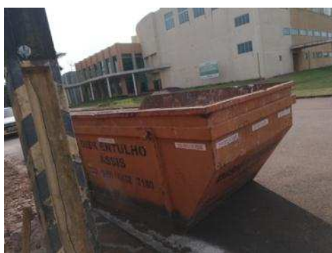
Figura 3 - Uso de caçamba para remoção de entulho.
