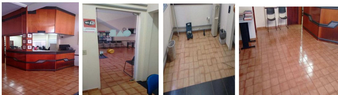
Figura 5 - Imagens internas antes da obra.
