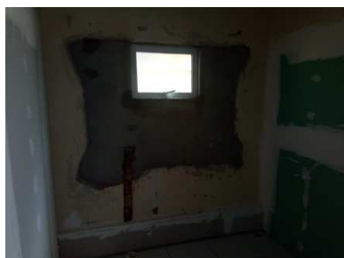
Figura 15: Divisórias em gesso acartonado e alvenaria na parede banheiro.
