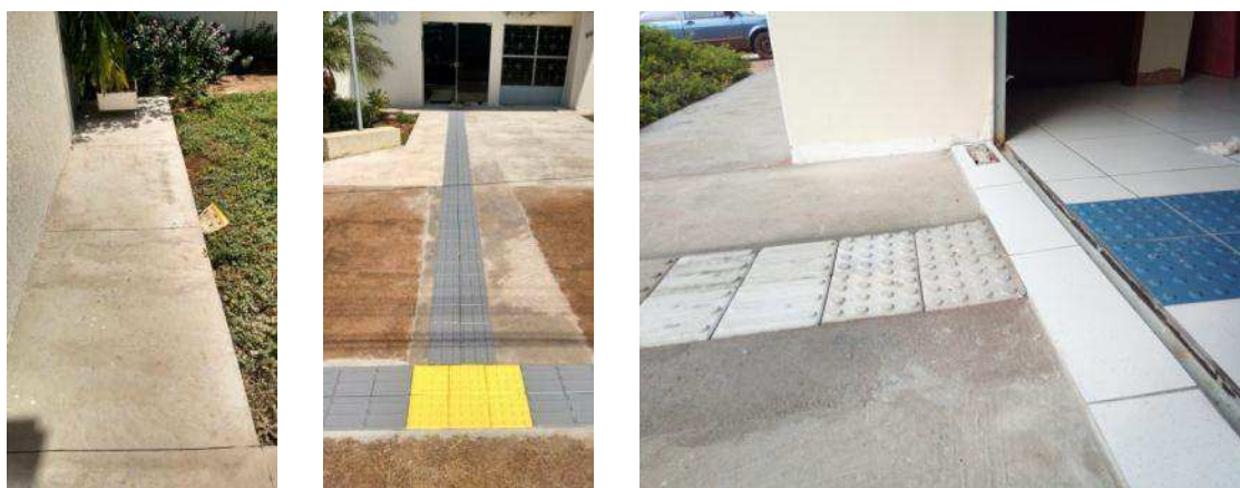
Figura 13 - Calçada em concreto e instalação de piso podotátil.
