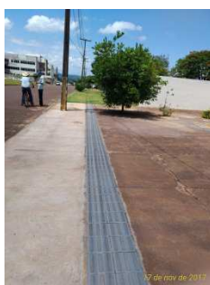
Figura 12 - Preparação acesso estacionamento, instalação e pintura de piso tátil.
