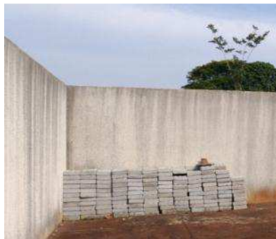
Figura 11 - Piso tátil concreto.
