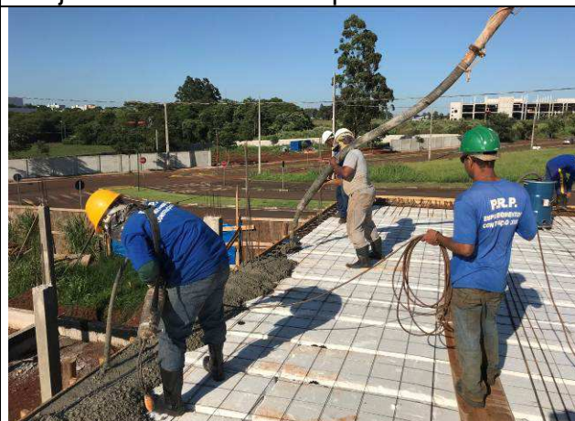
Figura 30C: Concretagem das vigas e lajes da cobertura.
