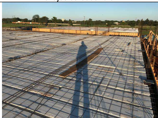
Figura 19C: Formas e armaduras das vigas e lajes da cobertura.
