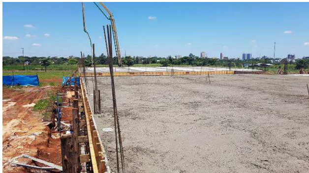
Figura 39C: Concretagem das vigas e lajes da cobertura.
