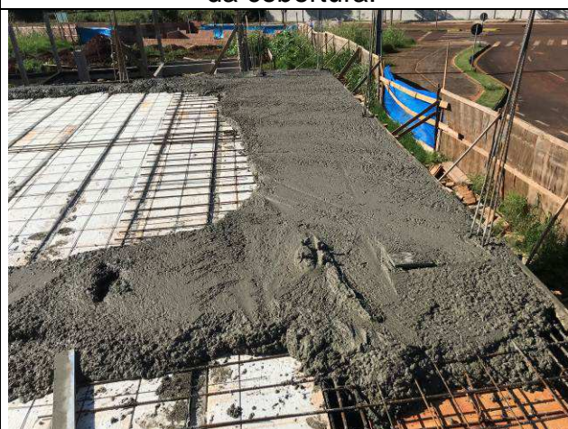
Figura 32C: Concretagem das vigas e lajes da cobertura.
