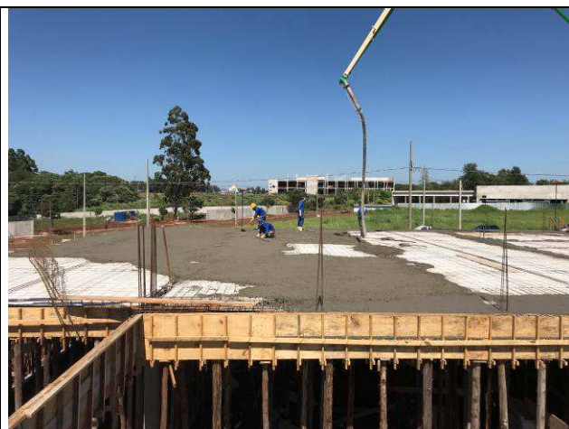
Figura 34C: Concretagem das vigas e lajes da cobertura.
