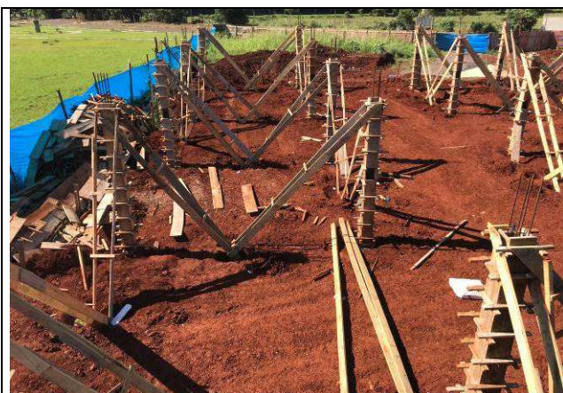
Figura 05C: Formas e armaduras dos pilares.
