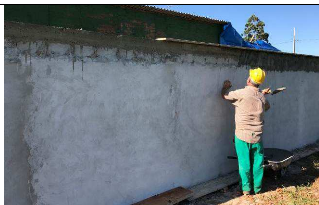
Figura 51C: Muro de fechamento dos fundos.
