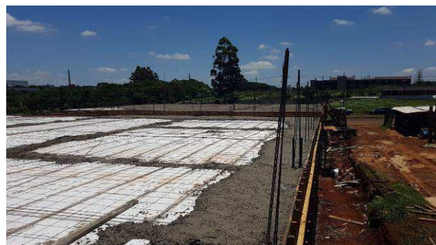
Figura 37C: Concretagem das vigas e lajes da cobertura.
