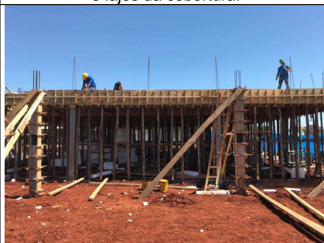
Figura 24C: Formas e armaduras das vigas e lajes da cobertura.
