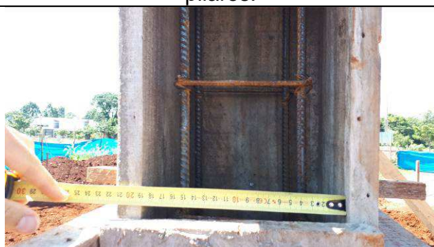
Figura 12C: Formas e armaduras dos pilares.
