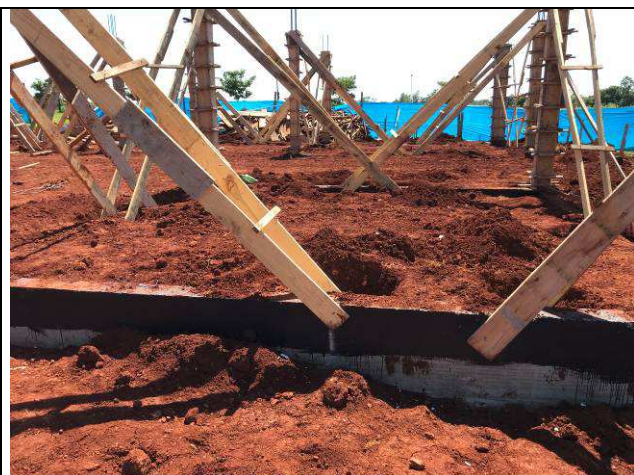
Figura 58C: Reaterro compactado na área de solo removido.
