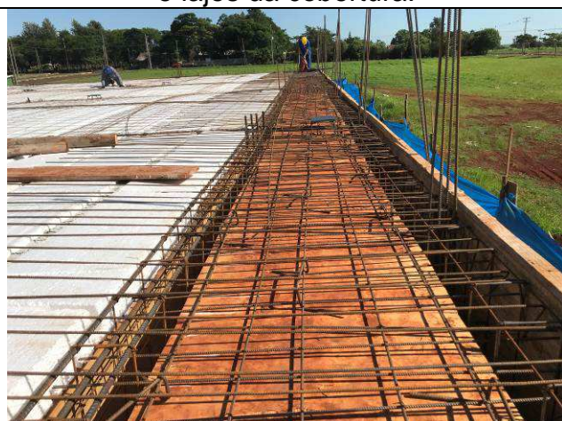
Figura 23C: Formas e armaduras das vigas e lajes da cobertura.
