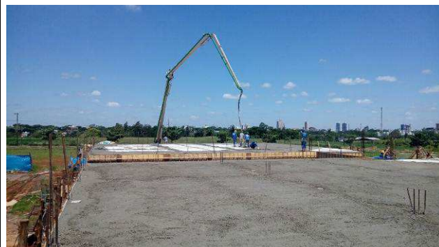
Figura 42C: Concretagem das vigas e lajes da cobertura.
