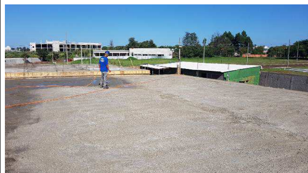
Figura 44C: Concretagem das vigas e lajes da cobertura.
