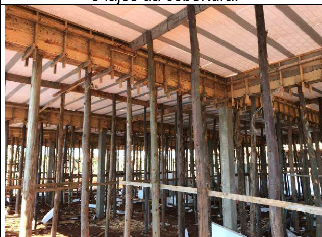
Figura 26C: Formas e armaduras das vigas e lajes da cobertura.
