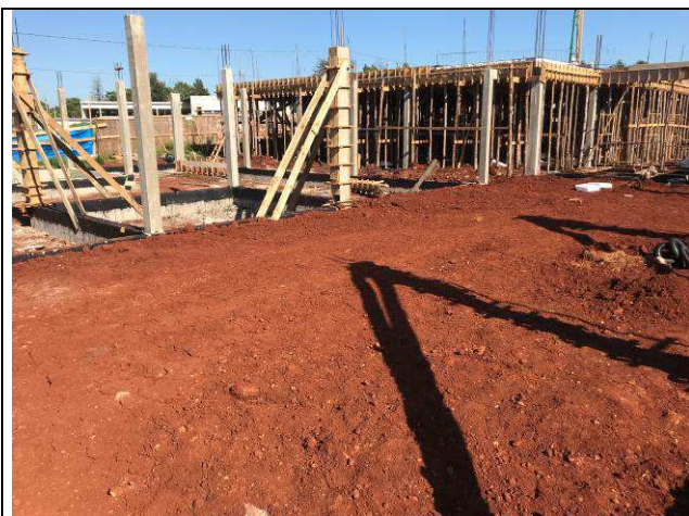
Figura 57C: Reaterro compactado na área de solo removido.
