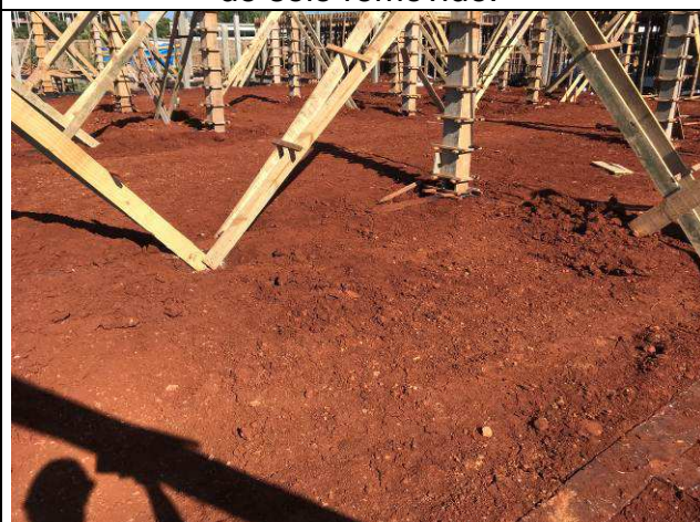
Figura 56C: Reaterro compactado na área de solo removido.
