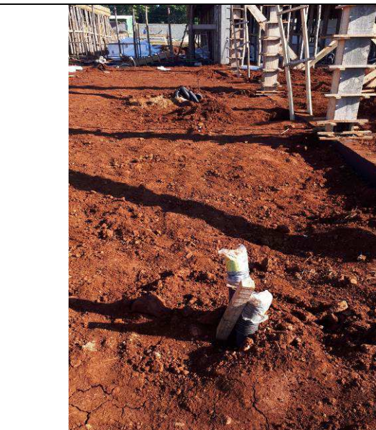
Figura 09E: Eletrodutos circuitos externos - área frontal da edificação.
