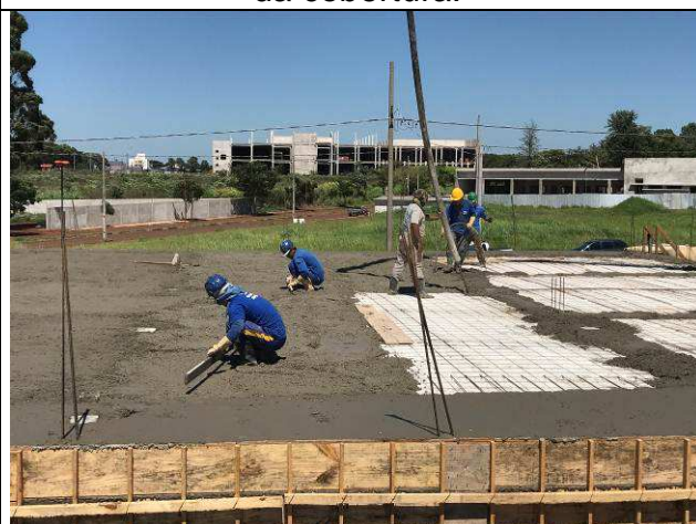
Figura 36C: Concretagem das vigas e lajes da cobertura.
