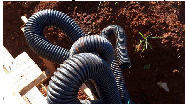
Figura 08E: Eletrodutos circuitos externos - área frontal da edificação.
