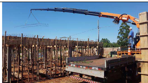
Figura 15C: Formas e armaduras das vigas e lajes da cobertura - içamento armaduras.
