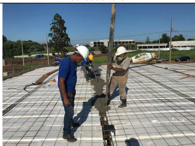
Figura 31C: Concretagem das vigas e lajes da cobertura.
