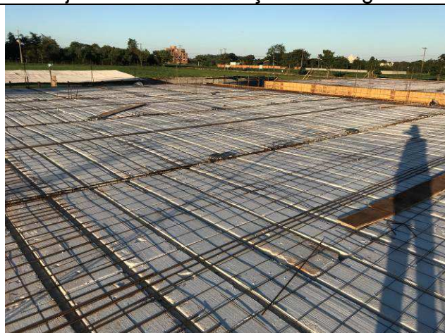
Figura 18C: Formas e armaduras das vigas e lajes da cobertura.
