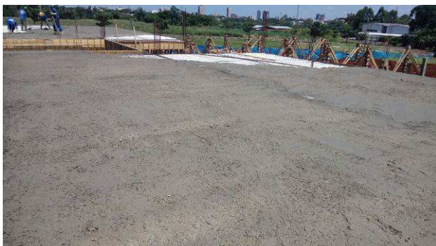
Figura 41C: Concretagem das vigas e lajes da cobertura.
