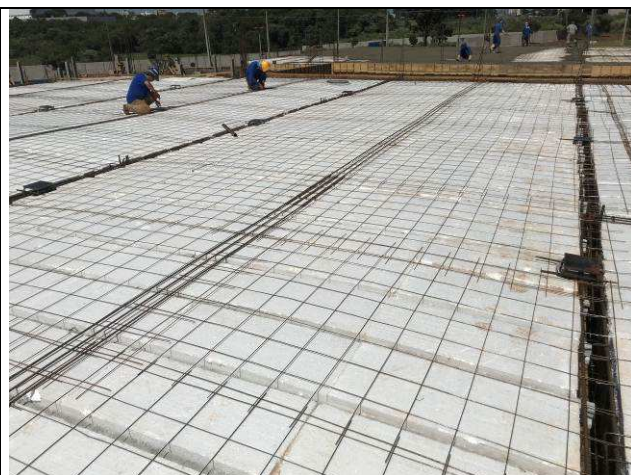
Figura 22C: Formas e armaduras das vigas e lajes da cobertura.
