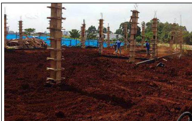
Figura 53C: Reaterro compactado na área de solo removido.
