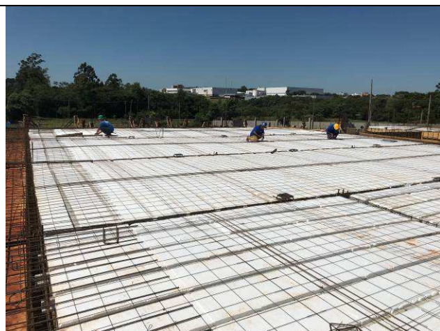
Figura 21C: Formas e armaduras das vigas e lajes da cobertura.
