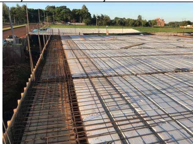
Figura 17C: Formas e armaduras das vigas e lajes da cobertura.
