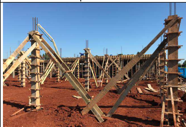
Figura 08C: Formas e armaduras dos pilares.
