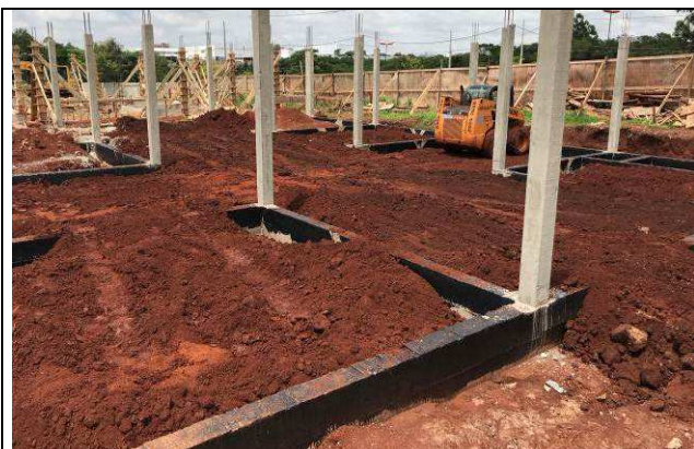
Figura 03C: Reaterro entre baldrames.
