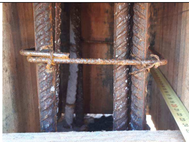
Figura 10C: Formas e armaduras dos pilares.
