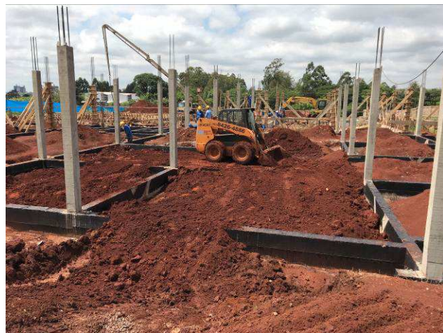
Figura 01C: Reaterro entre baldrames.
