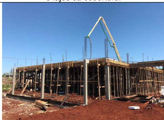
Figura 25C: Formas e armaduras das vigas e lajes da cobertura.
