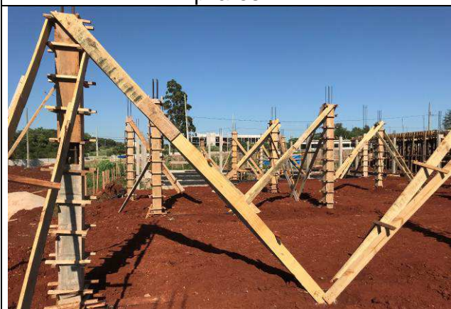
Figura 07C: Formas e armaduras dos pilares.
