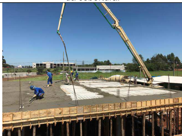
Figura 35C: Concretagem das vigas e lajes da cobertura.
