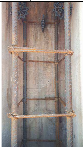
Figura 13C: Formas e armaduras dos pilares.
