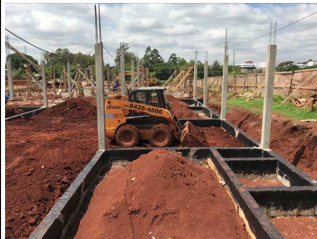
Figura 02C: Reaterro entre baldrames.
