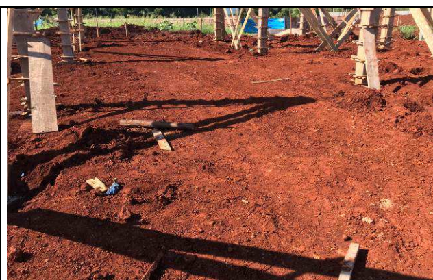
Figura 54C: Reaterro compactado na área de solo removido.
