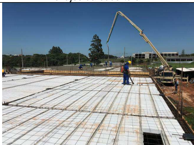
Figura 20C: Formas e armaduras das vigas e lajes da cobertura.
