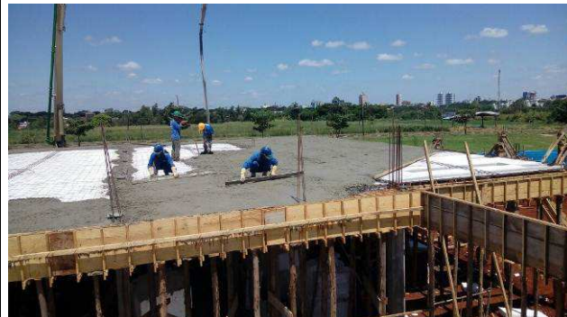
Figura 40C: Concretagem das vigas e lajes da cobertura.
