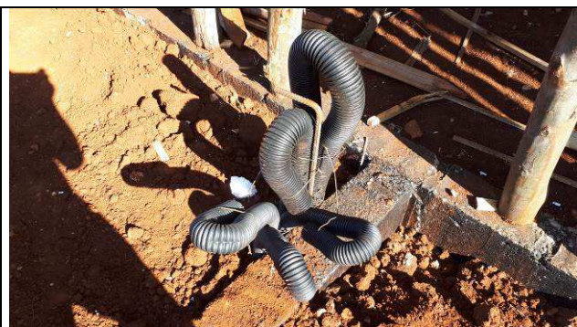
Figura 12E: Eletrodutos sala site rack-Telecomunicações.
