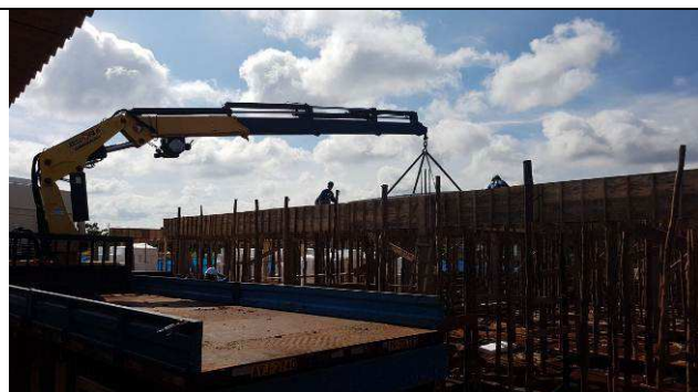
Figura 16C: Formas e armaduras das vigas e lajes da cobertura - içamento vigotas.
