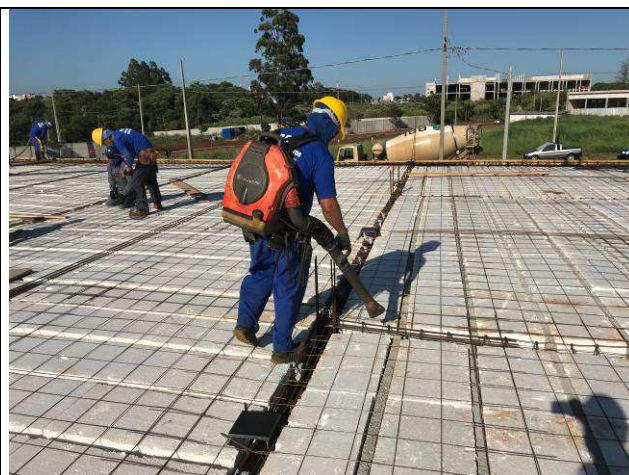
Figura 28C: Formas e armaduras das vigas e lajes da cobertura - limpeza dos resíduos.
