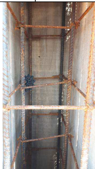
Figura 14C: Formas e armaduras dos pilares.
