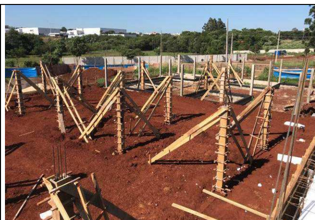
Figura 06C: Formas e armaduras dos pilares.
