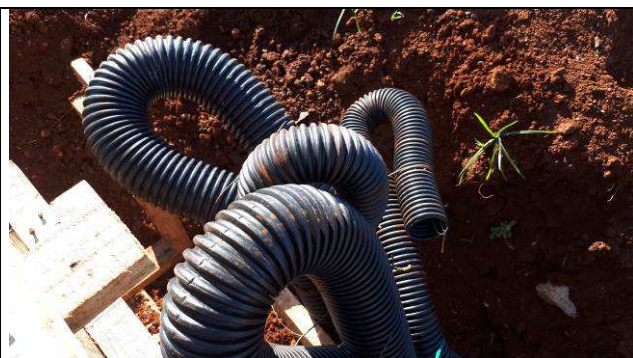
Figura 11E: Eletrodutos circuitos externos - área frontal da edificação.
