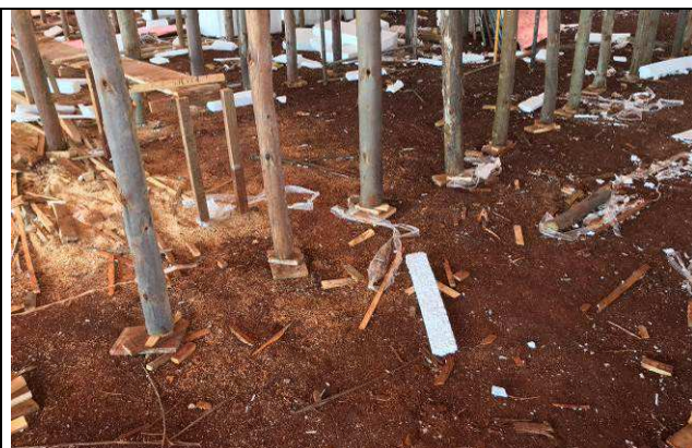
Figura 04C: Reaterro entre baldrames.
