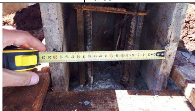
Figura 11C: Formas e armaduras dos pilares.
