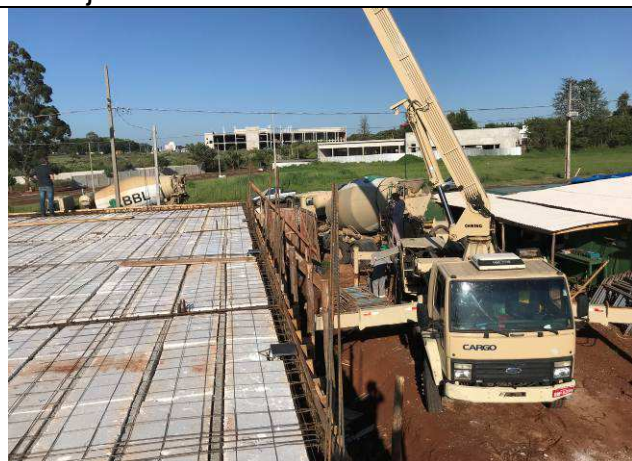
Figura 29C: Concretagem das vigas e lajes da cobertura.
