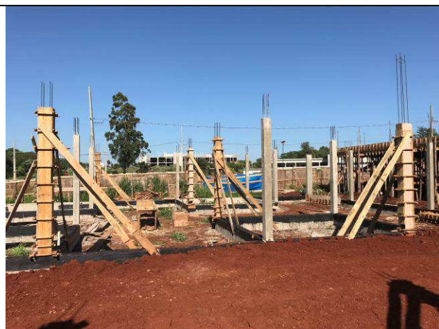
Figura 09C: Formas e armaduras dos pilares.
