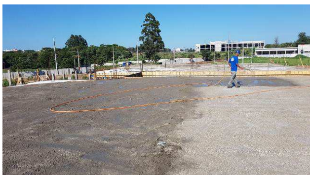
Figura 43C: Concretagem das vigas e lajes da cobertura.
