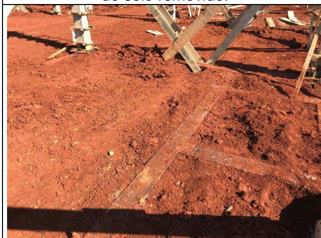
Figura 55C: Reaterro compactado na área de solo removido.
