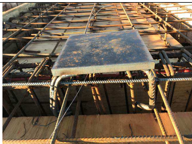
Figura 27C: Formas e armaduras das vigas e lajes da cobertura - insertes metálicos.
