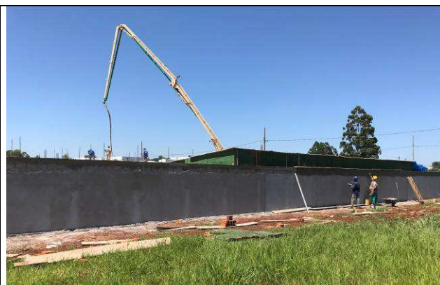
Figura 52C: Muro de fechamento dos fundos.
