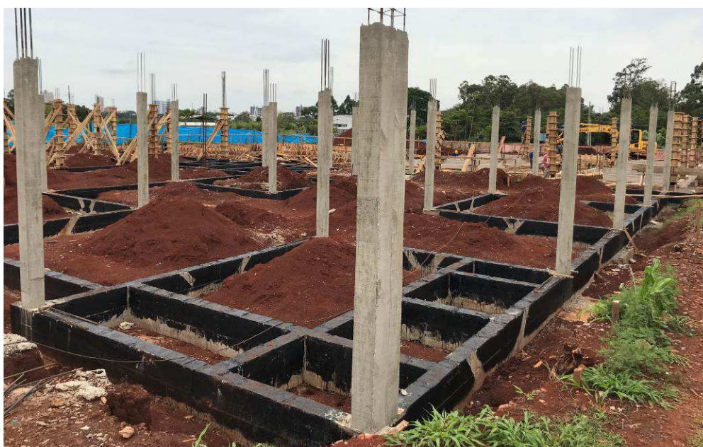
Figura 1 – Vista geral do canteiro de obras - vigas baldrame e pilares.
