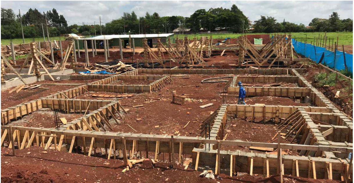
Figura 2 – Vista geral do canteiro de obras - vigas baldrames e pilares.
