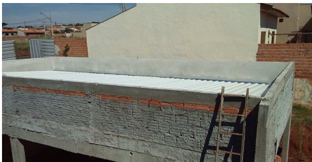
Figura 21: Cobertura e calha instaladas no prédio do arquivo
