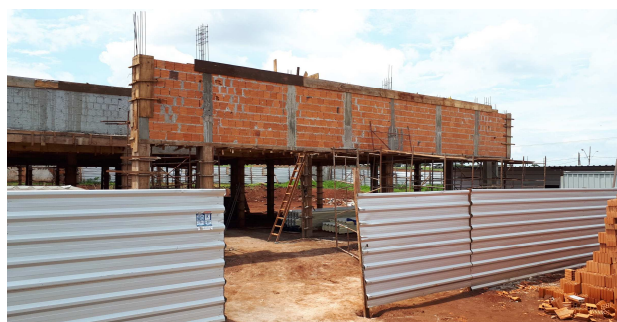
Figura 3: Pilaretes e viga cinta de amarração da platibanda - fachada frontal
