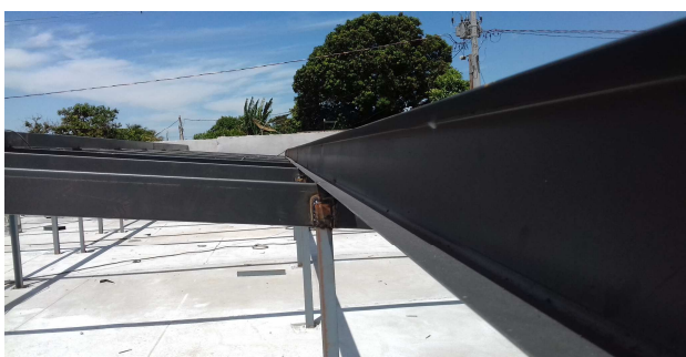
Figura 12: Detalhe de terça sobre montante metálico
