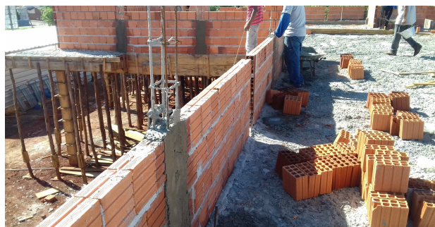
Figura 5: pilarete sendo executado
