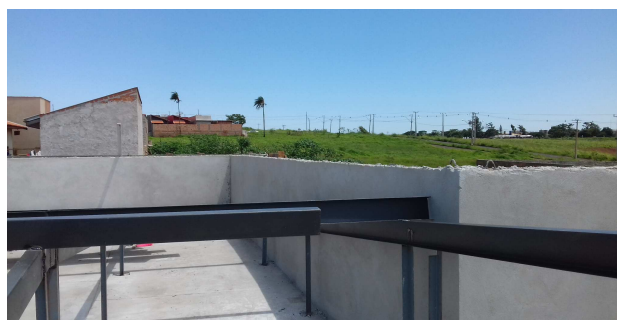
Figura 25: Rebôco interno de platibanda do prédio principal
