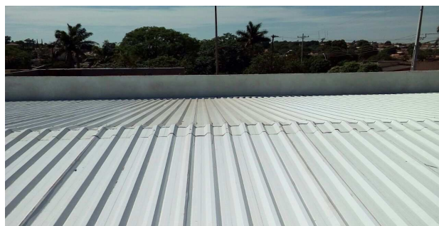
Figura 17: Telhas e cumeeiras instaladas no prédio principal
