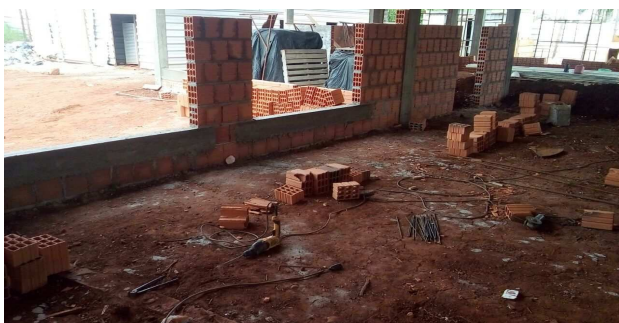
Figura 8: Alvenaria externa na região da sala de audiência 2
