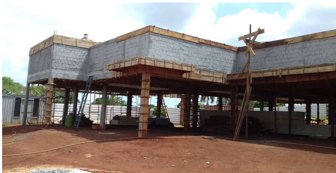
Figura 1: Vista geral da obra - retiradas as escoras das lajes e vigas
