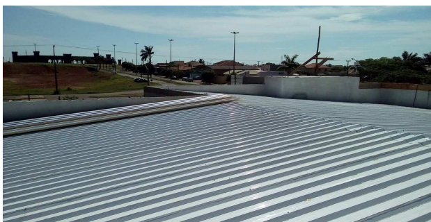
Figura 18: Telhas instaladas no prédio principal
