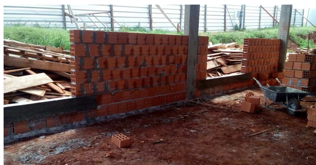
Figura 9: Alvenaria externa sendo erguida na secretaria
