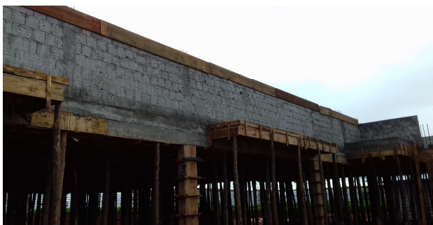
Figura 4: Pilaretes e cinta de amarração na lateral direita
