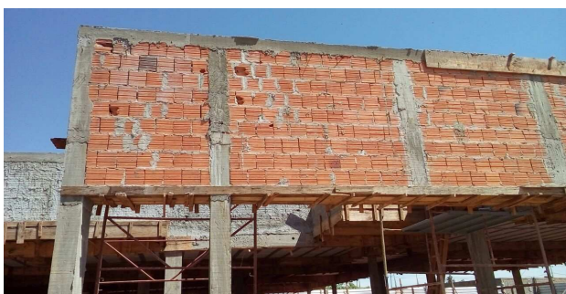
Figura 2: Pilaretes e viga cinta de amarração da platibanda
