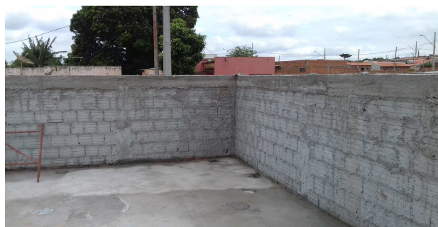
Figura 23: Chapisco nas platibandas (faces internas) dos fundos e lateral esquerda
