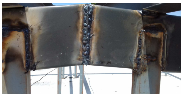
Figura 13: Detalhe da solda aplicada na junção dos montantes metálicos
