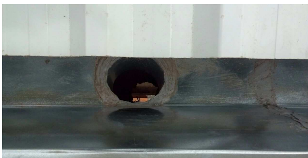
Figura 19: Detalhe de bocal de descarga da calha
