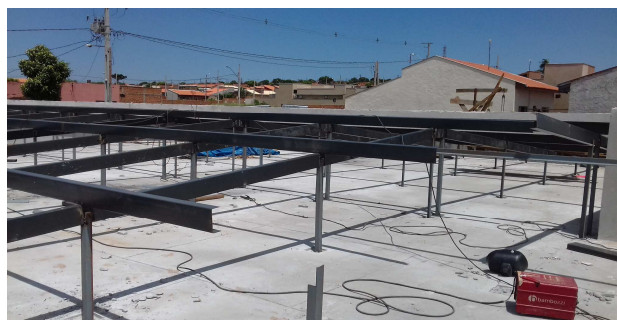
Figura 11: Estrutura de cobertura no prédio principal
