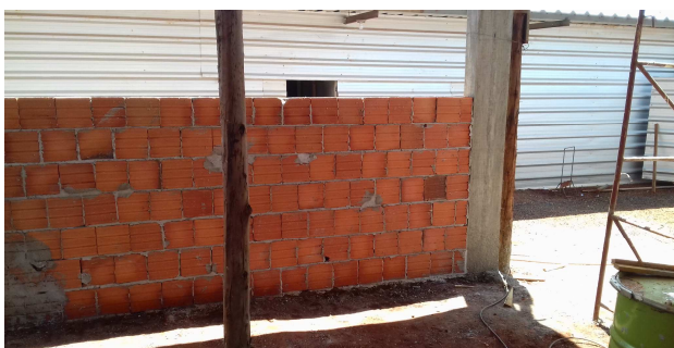
Figura 6: Alvenaria de fechamento externo
