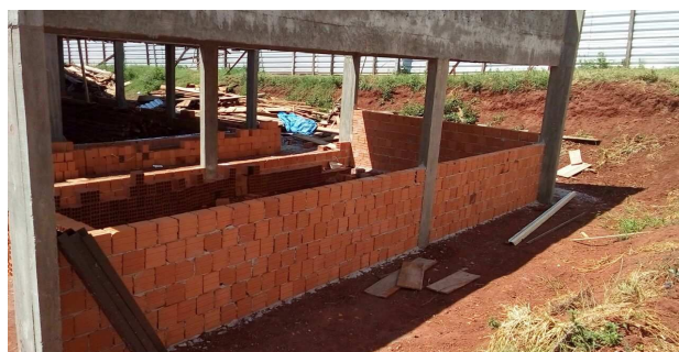
Figura 7: Execução da alvenaria de fechamento externo do arquivo
