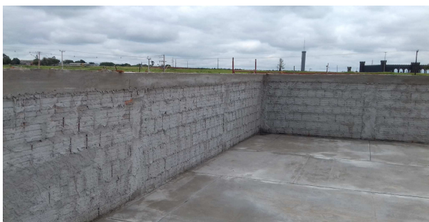
Figura 22: Chapisco na face interna de platibanda - fundos e lateral direita
