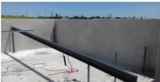
Figura 26: Rebôco interno de platibanda do prédio principal
