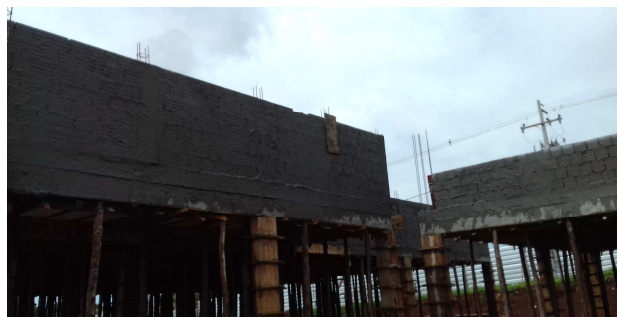
Figura 10: Chapisco nas platibandas dos fundos do prédio principal e arquivo
