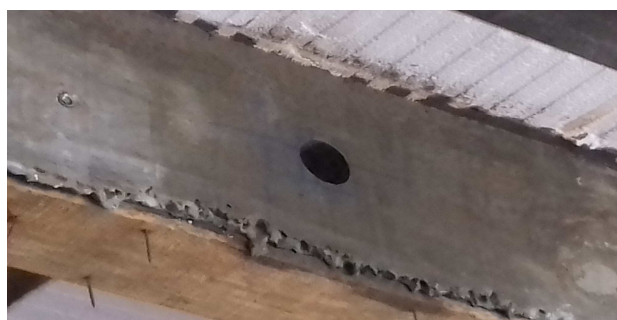
Figura 18: Situação de uma viga, após a retirada da amostra. Foram selecionados tramos pouco carregados e regiões da Linha Neutra. Fopi utilizado, também, detector de armadura e apoio do projeto estrutural. A retirada das 7 amostras foi um sucesso, nas palavras da empresa responsável
