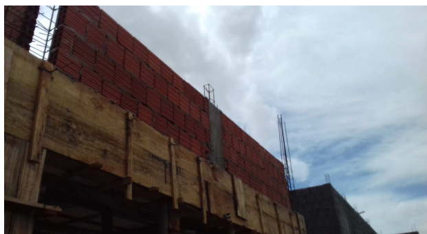
Figura 5: Platibanda localizada na extrema direita da obra
