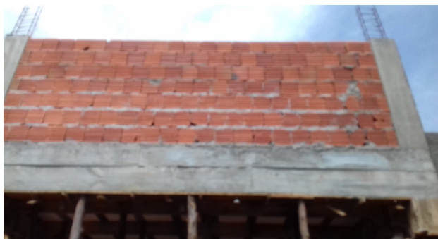
Figura 3: Execução da alvenaria de platibanda na lateral direita
