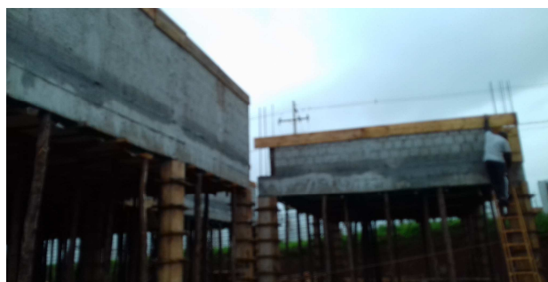
Figura 12: Chapisco nas platibandas dos fundos do prédio principal e arquivo
