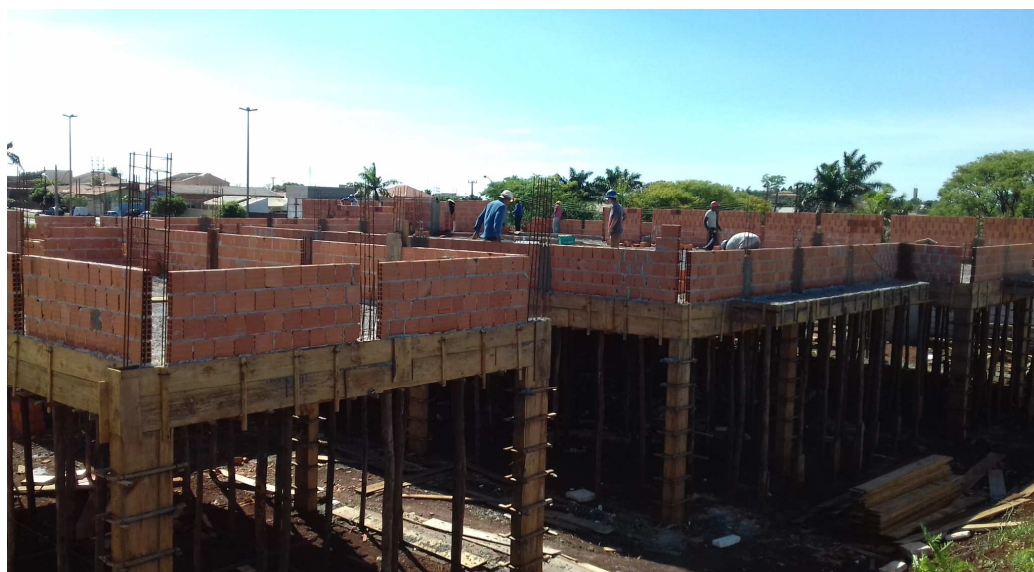
Figura 1: Vista geral da obra - Operários executando as platibandas em alvenaria
