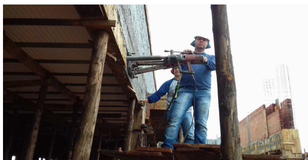
Figura 16: Realização da retirada de amostras do concreto, após a cura de 28 dias. As amostras retiradas serão submetidas a ensaio, para confirmar o Fck de projeto (25MPa). A fiscalização proibiu a remoção das escoras antes dos resultados do ensaio
