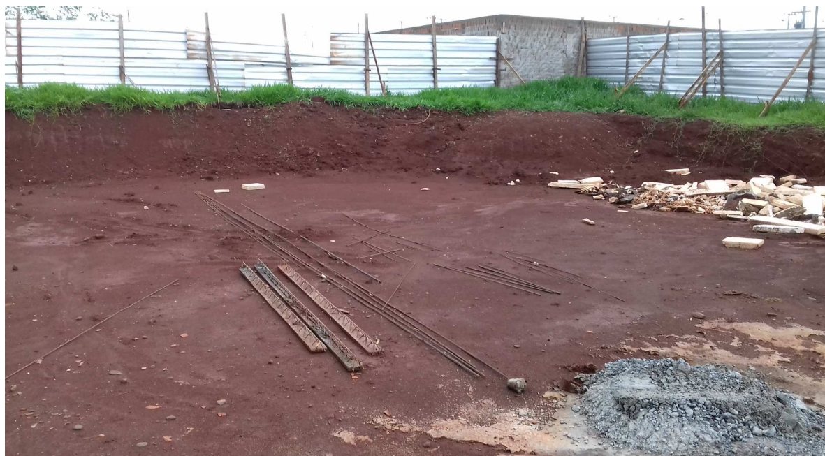
Figura 2: Acerto do terreno na região do estacionamento privativo
