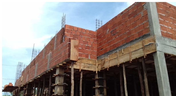
Figura 4: Execução da alvenaria de platibanda, na fachada frontal
