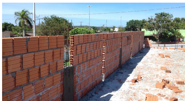
Figura 8: Detalhe dos pilaretes de travamento das platibandas
