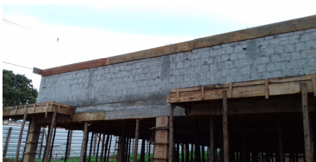
Figura 11: Chapisco de platibanda na fachada frontal (sudeste)
