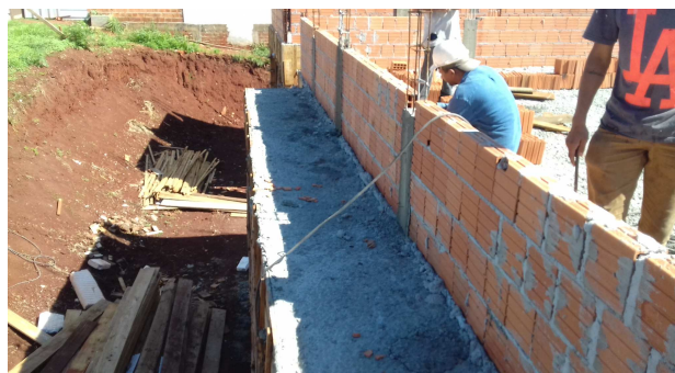
Figura 6: Platibanda sendo levantada na lateral esquerda
