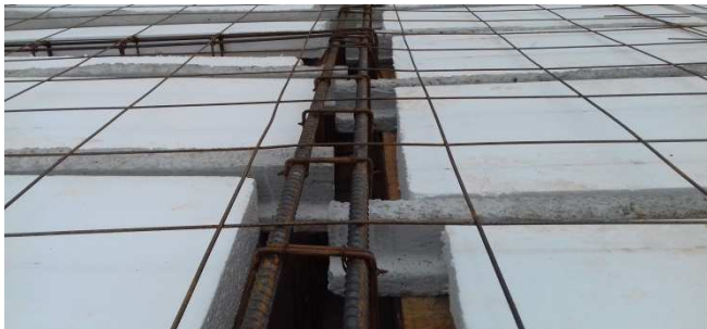
Figura 09: no detalhe, armadura de viga e vigotas entrando na viga
