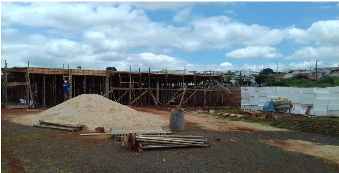
Figura 01: visão geral da obra
