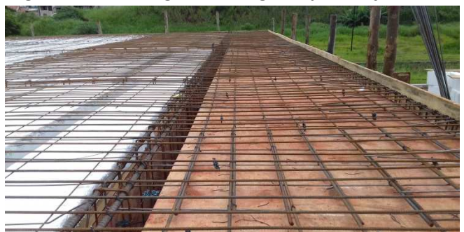
Figura 13: detalhe das armaduras de uma laje maciça - marquise direita
