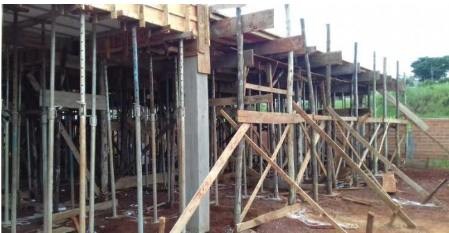
Figura 03: escoramento de lajes maciças, pré-moldadas e Figura 04: fôrmas de vigas e escoramentos vigas
