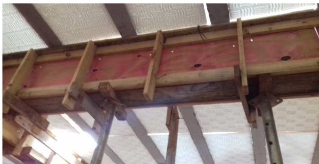
Figura 05: fôrma de uma viga vista por baixo
