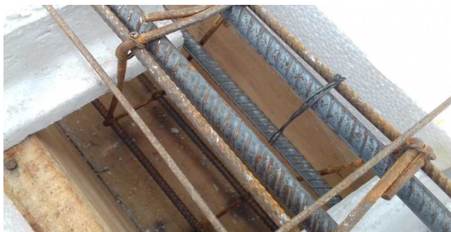
Figura 07: Ferragem longitudinal e transversal em viga
