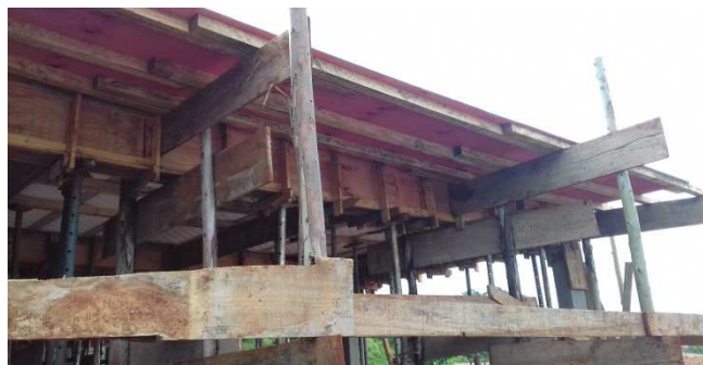
Figura 06: fôrma de laje maciça (marquise)
