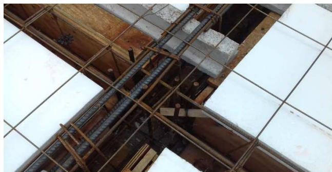
Figura 08: armadura negativa de vigas, junto a pilar
