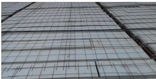
Figura 14: armaduras de distribuição, aplicadas em laje pré-moldada
