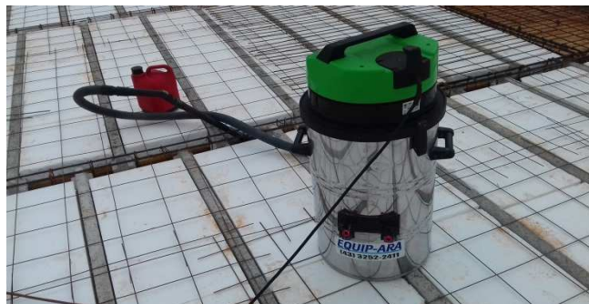
Figura 15: aspirador de pó, sendo usado para eliminar sujeira nas fôrmas, antes da concretagem
