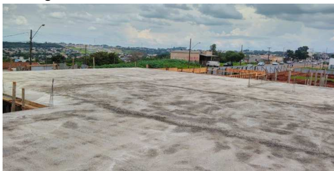
Figura 18: laje pré-moldada, após concretagem
