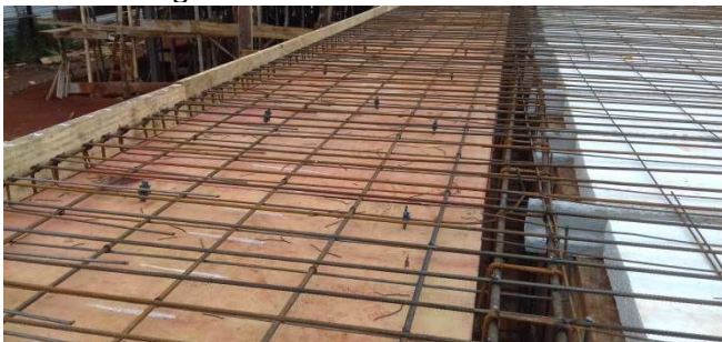
Figura 10: armaduras negativas, positivas e de distribuição de laje maciça
