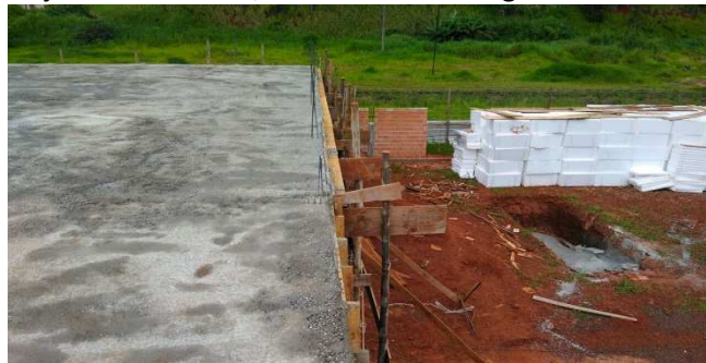
Figura 17: laje maciça, após concretagem
