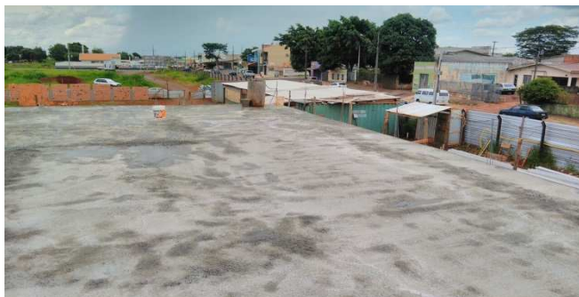
Figura 16: lajes pré-moldadas e maciças, após concretagem
