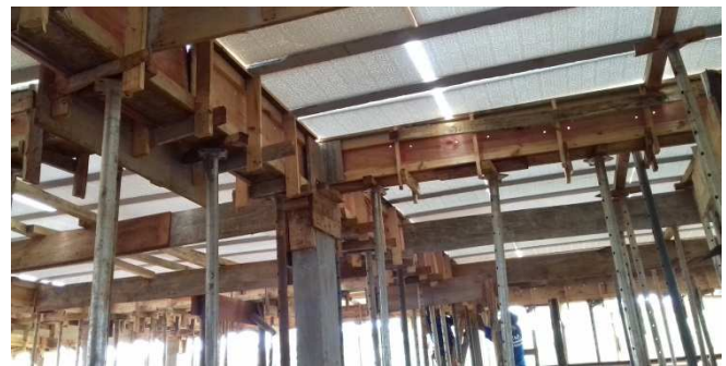
Figura 03: escoramento de lajes maciças, pré-moldadas e Figura 04: fôrmas de vigas e escoramentos vigas
