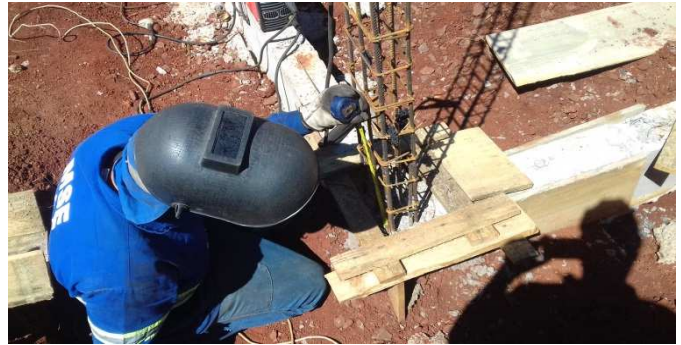
Figura 6C: Operário realizando a solda das ferragens (arranque com armadura longitudinal)
