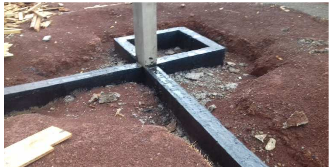
Figura 20C: Aplicação de impermeabilizante betuminoso nas vigas baldrame
