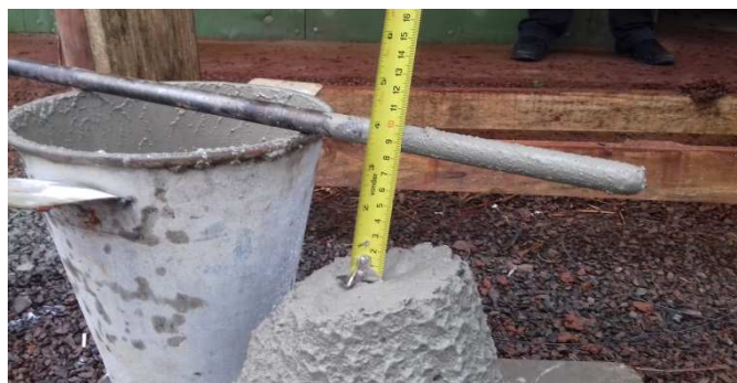
Figura 14C: Teste de Slump, realizado no recebimento do concreto
