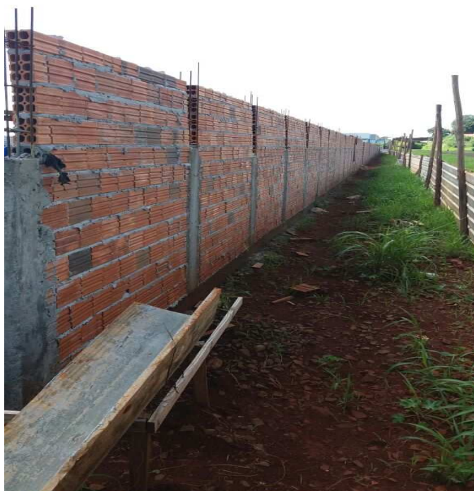
Figura 23C: Muro em alvenaria executado quase completamente, nos fundos.
