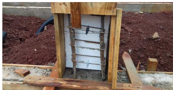
Figura 12C: Aplicação de EPS na separação entre pilares gêmeos (junta estrutural de dilatação)
