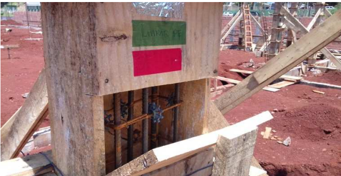
Figura 2C: Detalhe de uma janela de concretagem, localizada no meio do pilar
