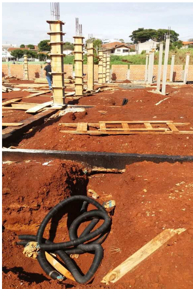
Figura 05E: Valas aberta e Tubulação elétrica (4") e lógica (3") Figura 06E: Tubulações elétricas chegando até o ponto onde será executada a sala técnica
