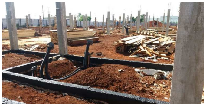
Figura 22C: Aplicação de impermeabilizante betuminoso nas vigas baldrame
