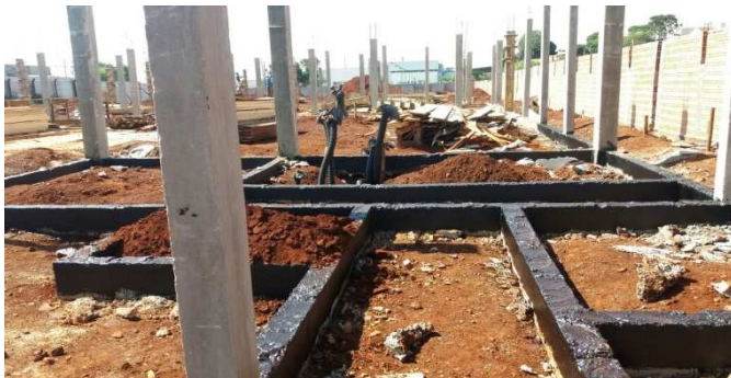
Figura 19C: Aplicação de impermeabilizante betuminoso nas vigas baldrame
