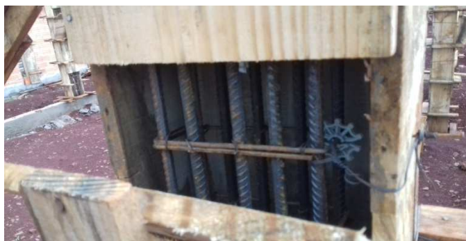
Figura 11C: No detalhe, amarração das armaduras para evitar movimentação durante a concretagem
