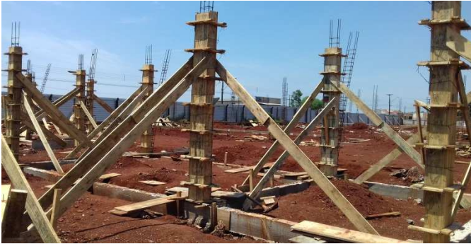
Figura 1C: Fôrmas de pilares, com escoras montadas e já aprumadas
