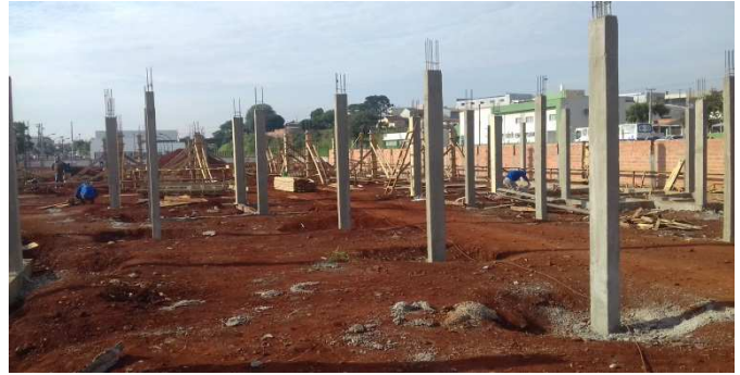
Figura 18: Visão geral dos pilares após concretagem (a maioria já desformada)
