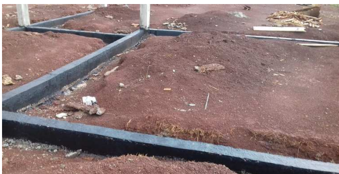
Figura 21C: Aplicação de impermeabilizante betuminoso nas vigas baldrame
