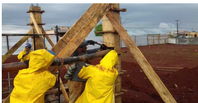
Figura 15C: Início da concretagem de um pilar, através da janela intermediária
