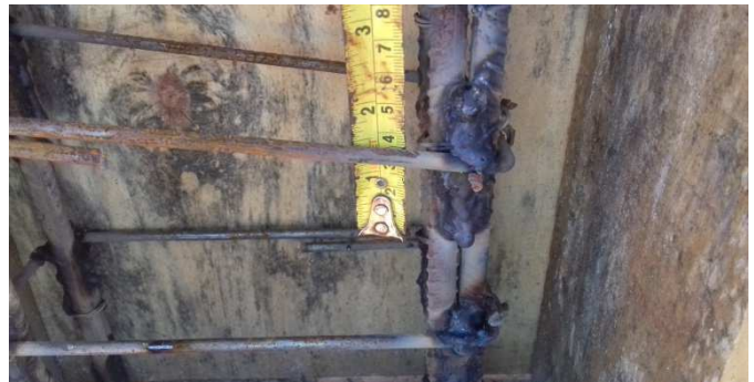
Figura 8C: Fiscalização realizando a aferição dos cordões adotados seguindo a orientação do parecer técnico fornecido pelo Engenheiro Gustavo Vince Rodrigues
