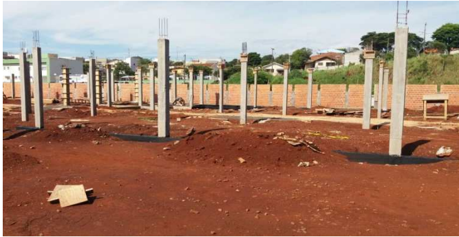
Figura 17: Visão geral dos pilares após concretagem (a maioria já desformada)
