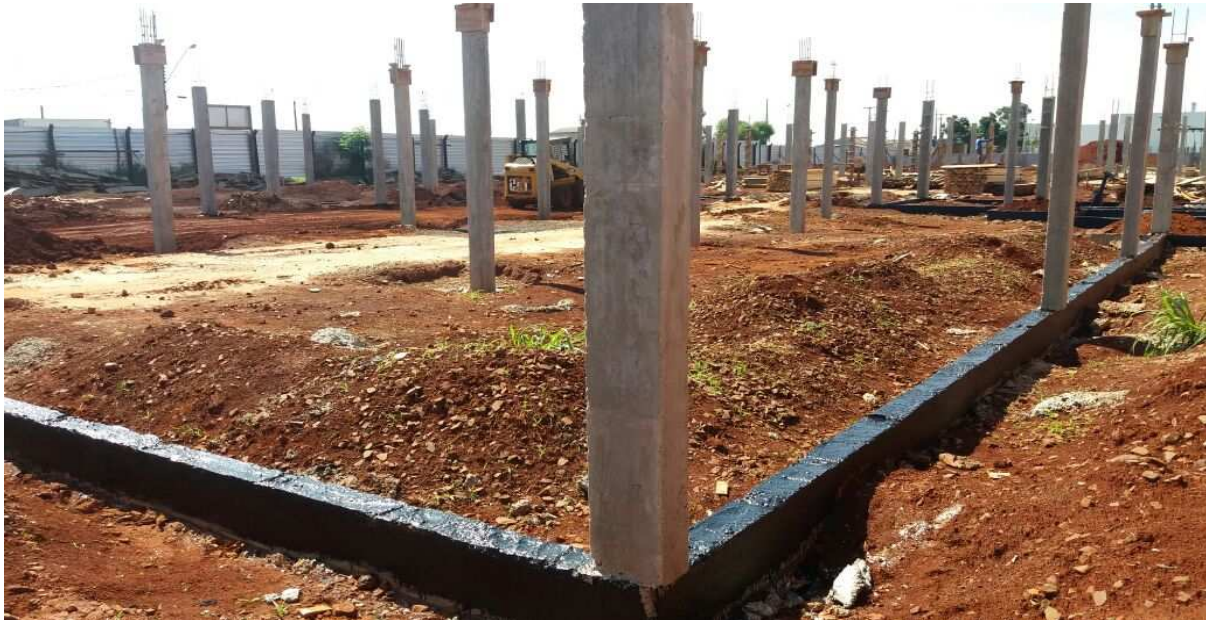
Vista geral da obra
