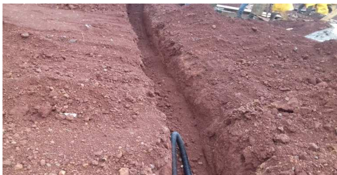
Figura 03E: Vala aberta para passagem de tubulação elétrica Figura 04E: Tubulação elétrica (4") e lógica (3")
