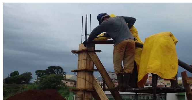
Figura 16C: Finalização da concretagem do mesmo pilar de 15C, pelo seu topo
