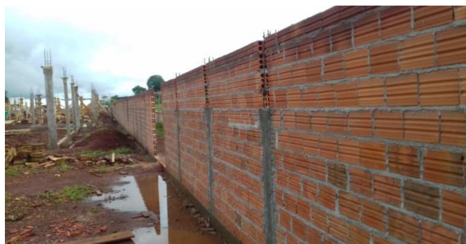
Figura 24C: Vista geral do muro de fechamento do terreno
