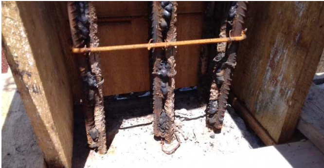
Figura 5C: No detalhe, um conjunto de barras de 1/2", já soldadas
