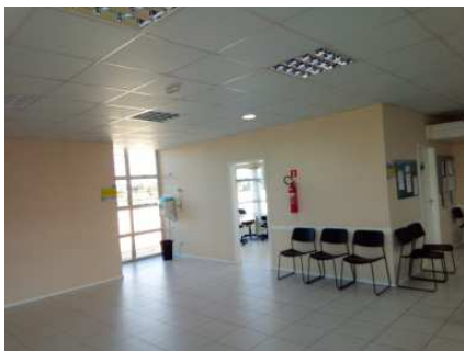
Figura 9 - Sala da AOB - Antes
