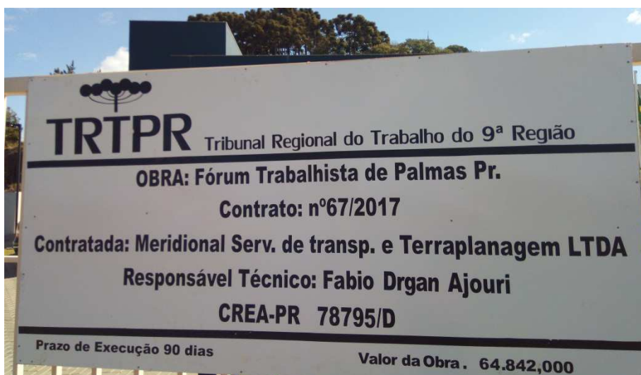
Figura 1 - Instalação de placa de obra.
