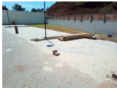
Figura 5 - Instalação de paver, meio fio e grama.
