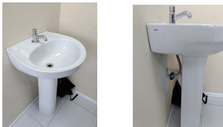
Figura 12 - Sala de Perícias - Após instalação de lavatório.
