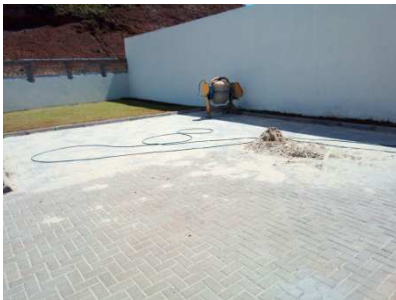
Figura 5 - Instalação de paver, meio fio e grama.
