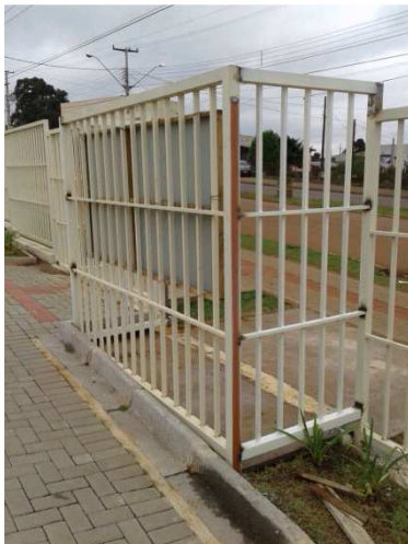
Figura 15 - Gradil recortado e instalado
