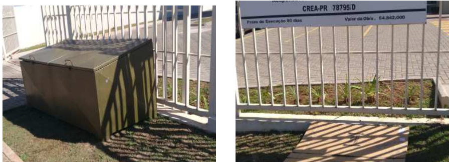
Figura 13 - Relocação de lixeira - antes
