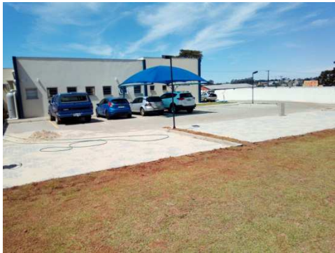
Figura 4 - Instalação de paver, meio fio e grama.
