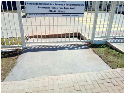
Figura 14 - Contra piso para instalação da lixeira
