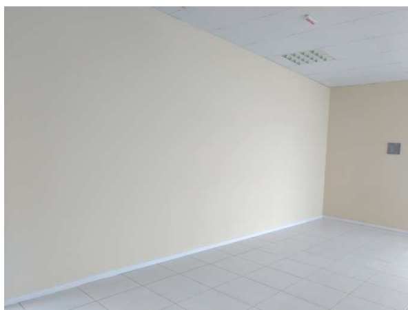
Figura 11 - Sala da AOB - Depois da instalação de divisória.
