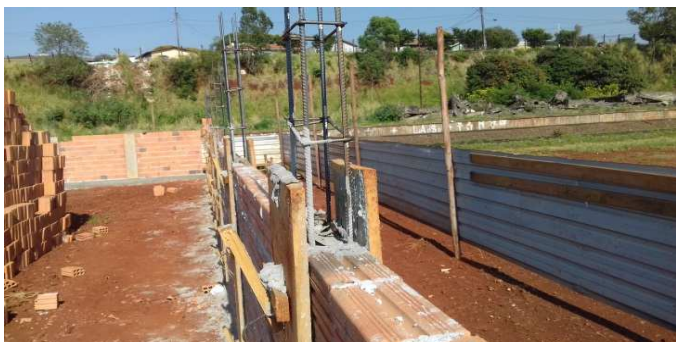
Figura 16: Detalhe dos pilaretes de travamento do muro de fechamento do terreno
