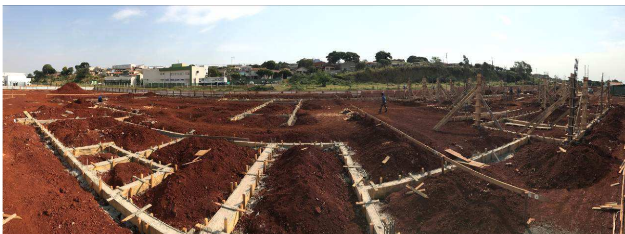
Figura 1 – Vista geral do canteiro de obras - vigas baldrame.
