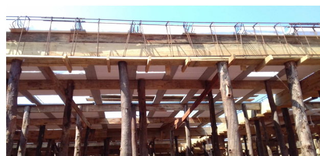
Figura 20: Detalhe das travessas nas escoras
