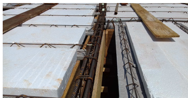
Figura 15: Montagem de armaduras em viga central - alta taxa de armadura
