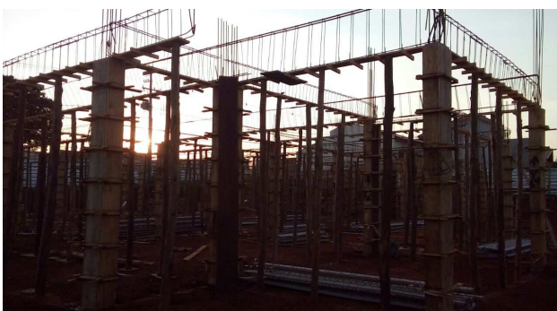
Figura 7: Ferrengens e fundo de fôrmas das vigas sendo instaladas
