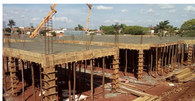
Figura 29: Término da concretagem dos panos de laje e das vigas
