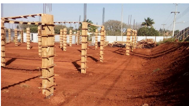
Figura 5: Detalhe do aterro entre baldrame - visto pela lateral esquerda da obra
