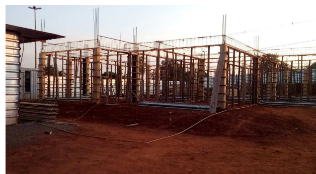
Figura 6: Início da execução das fôrmas das vigas - Ferragens e fundo das fôrmas
