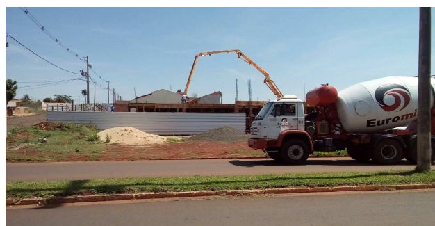
Figura 27: Uso de equipamento dotado de lança, para concretagem rápida das lajes
