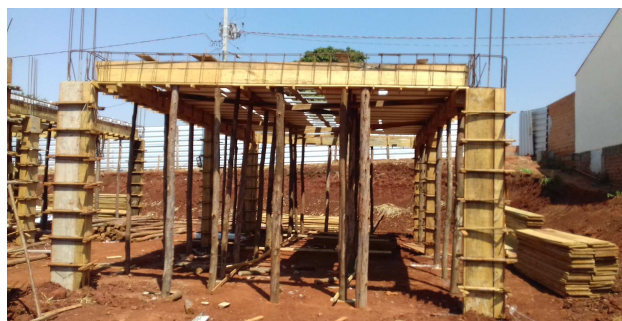
Figura 11: Escoramento de vigas e lajes, sendo executado no arquivo
