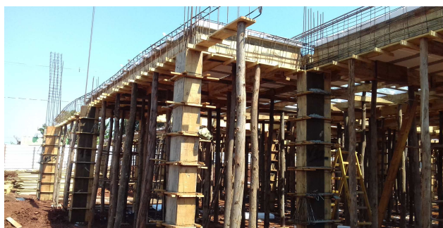
Figura 12: Escoramento de vigas e lajes, sendo executado no prédio principal
