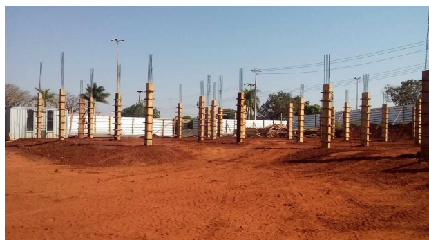
Figura 3: Aterro entre baldrame - visto pela lateral direita da obra
