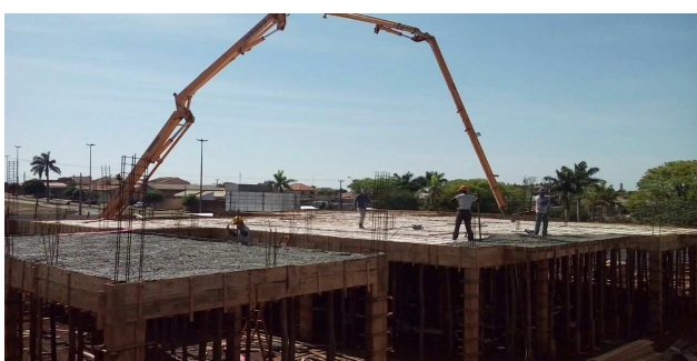
Figura 28: Início da concretagem dos panos de laje e das vigas
