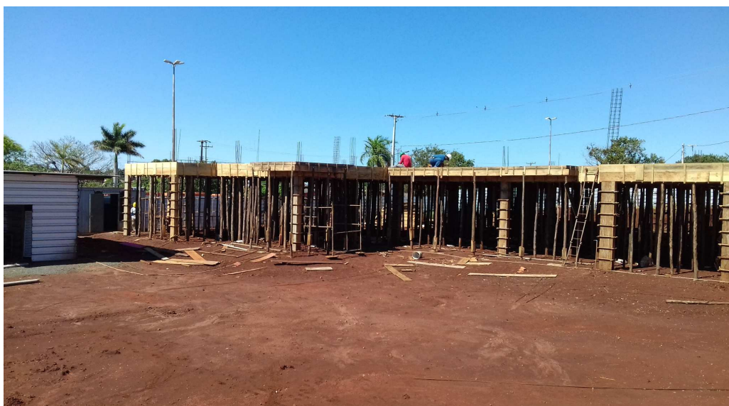
Figura 1: Vista geral da obra - Operários preparam armaduras das lajes e vigas para concretagem
