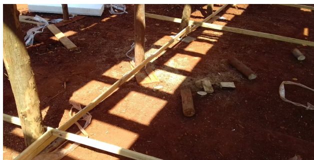
Figura 10: Travamento instalado nos pés das escoras
