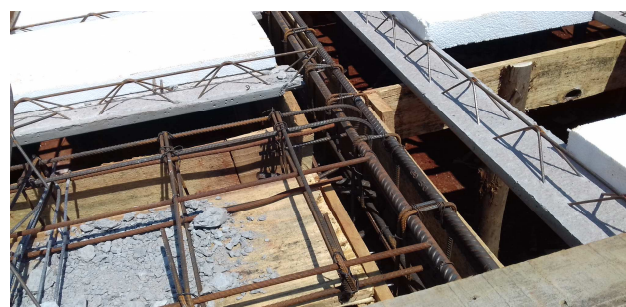
Figura 19: Encontro de vigas centrais
