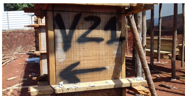
Figura 9: Detalhe de identificação dos inícios das vigas, nos pilares
