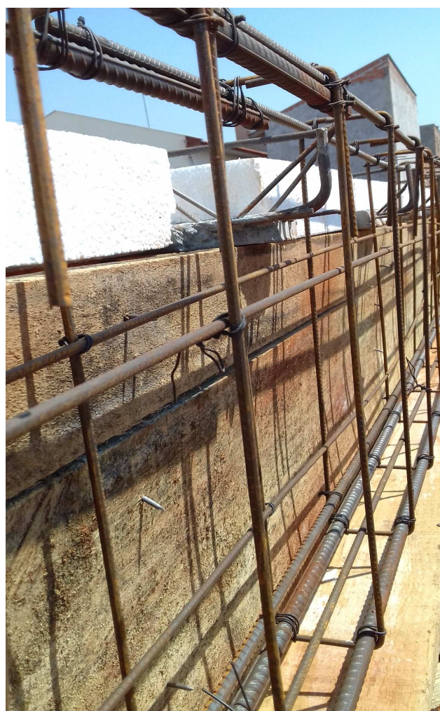
Figura 18: Viga externa, com detalhe de armadura longitudinal, estribo e armadura de pele. Na mesma imagem, detalhe de vigota treliçada e sua ancoragem na viga
