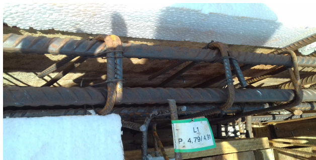
Figura 16: Detalhe de ferragem em viga central e etiqueta de marcação em vigota treliçada
