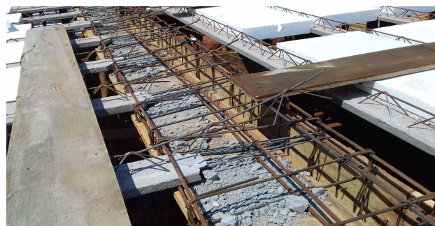
Figura 13: Montagem de armaduras em uma viga "L"
