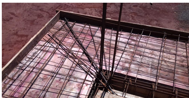
Figura 22: Preparo de armaduras longitudinais e de distribuição em marquise
