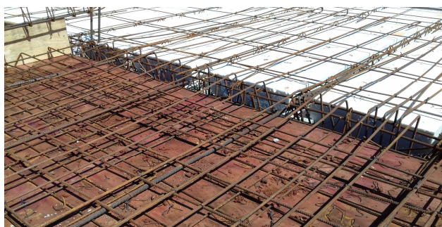
Figura 24: Preparo de armaduras longitudinais positivas e negativas na laje L1
