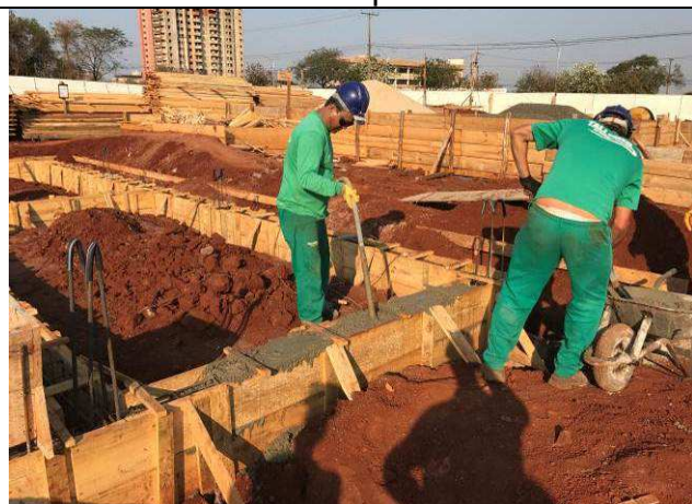
Figura 61C: Concretagem das vigas baldrame do prédio do arquivo.
