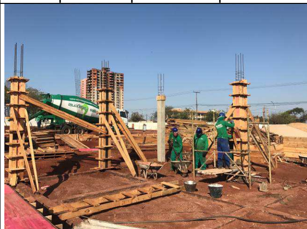
Figura 90C: Concretagem dos pilares do prédio do arquivo.
