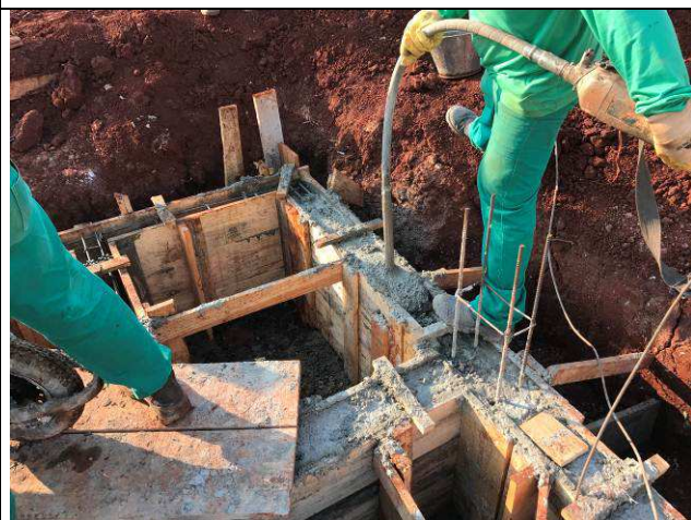
Figura 73C: Concretagem das vigas baldrames da guarita.
