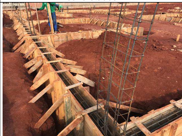
Figura 38C: Formas e armaduras das vigas baldrame do prédio principal.
