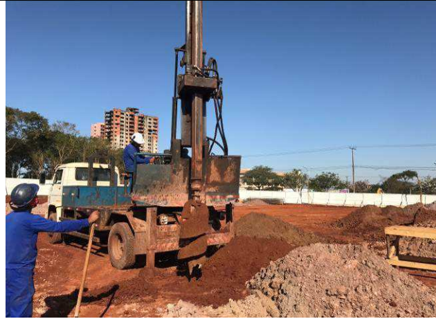
Figura 15C: Escavação das estacas.
