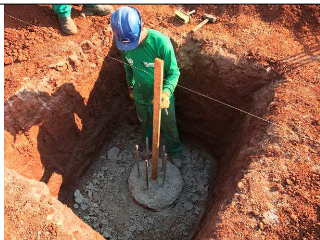
Figura 21C: Corte e preparo da cabeça das estacas.
