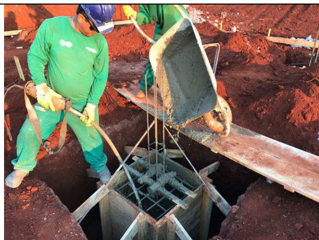
Figura 33C: Concretagem dos blocos do prédio principal.
