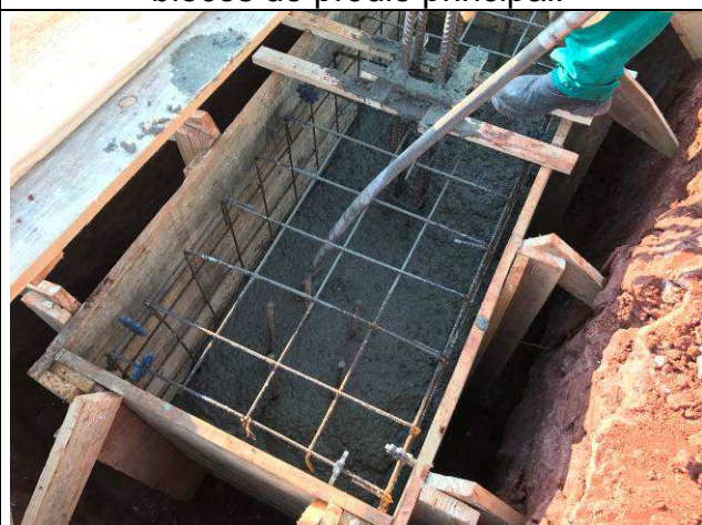
Figura 30C: Concretagem dos blocos do prédio principal.
