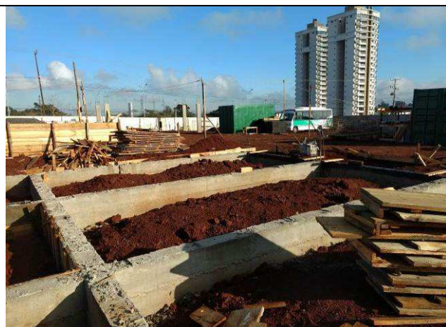
Figura 65C: Vigas baldrames do prédio do arquivo concretadas.
