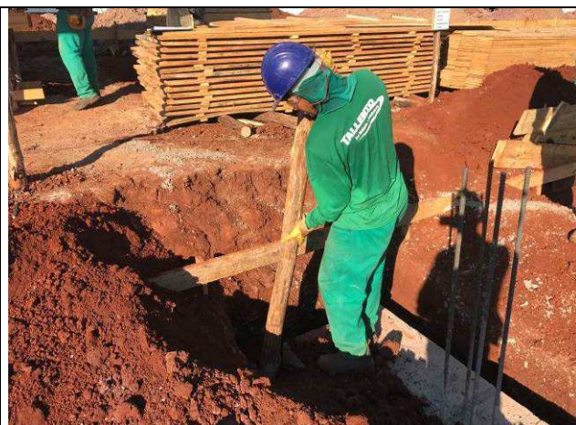
Figura 10C: Reaterro apilado dos blocos do prédio do arquivo.
