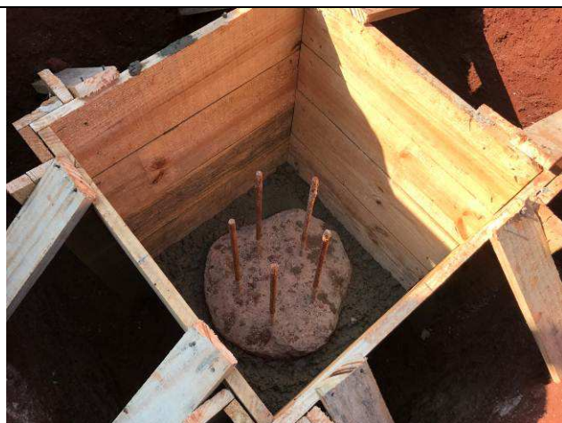
Figura 22C: Estacas preparadas e lastro de concreto no fundo dos blocos.
