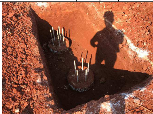
Figura 07C: Escavações para execução dos blocos do prédio principal.
