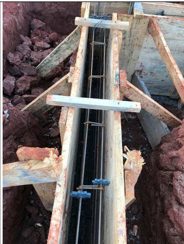
Figura 72C: Formas e armaduras das vigas baldrames da guarita.
