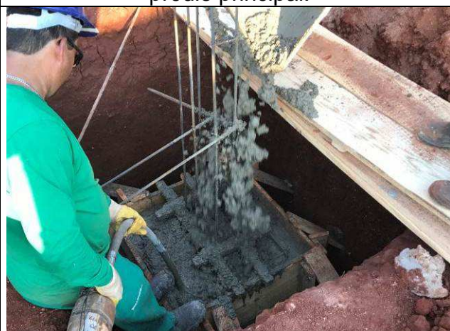
Figura 31C: Concretagem dos blocos do prédio principal.
