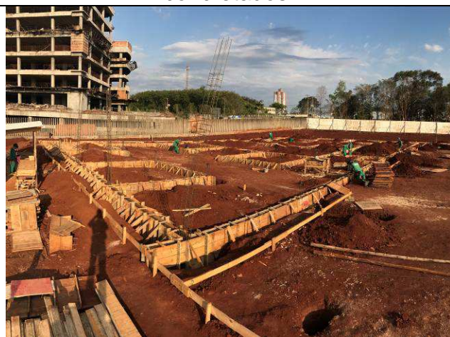
Figura 37C: Formas e armaduras das vigas baldrame do prédio principal.
