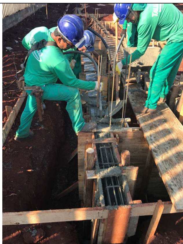
Figura 47C: Concretagem das vigas baldrames do prédio principal.
