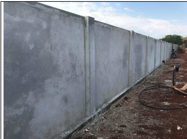
Figura 101C: Chapisco executado - face interna - muro de fechamento.
