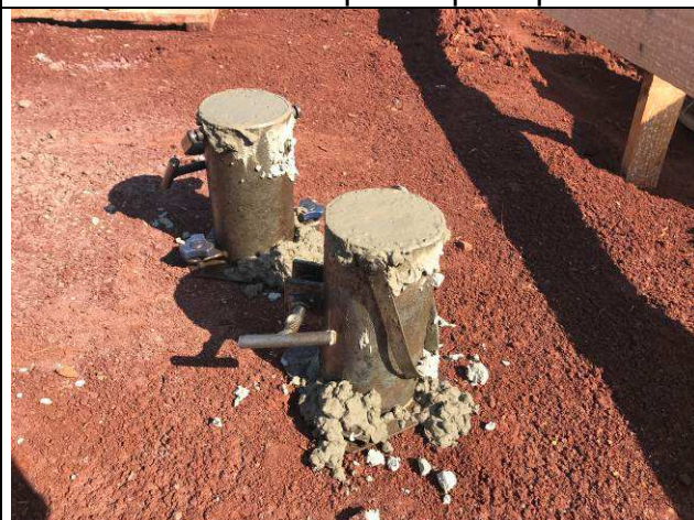
Figura 52C: Controle tecnológico do concreto das vigas baldrames.
