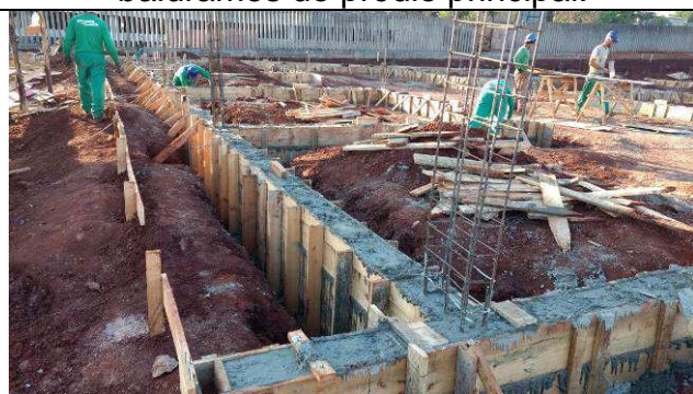
Figura 53C: Vigas baldrames do prédio principal concretadas.
