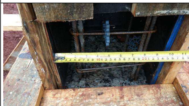
Figura 77C: Formas e armaduras do pilar P01 do prédio do arquivo.
