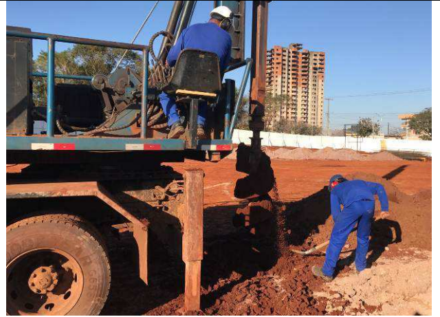
Figura 16C: Escavação das estacas.
