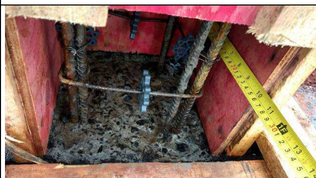
Figura 80C: Formas e armaduras do pilar P07 do prédio do arquivo.
