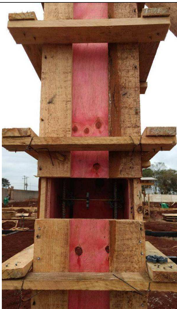
Figura 87C: Abertura intermediária do pilar P09 para concretagem.
