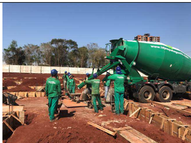
Figura 45C: Concretagem das vigas baldrames do prédio principal.
