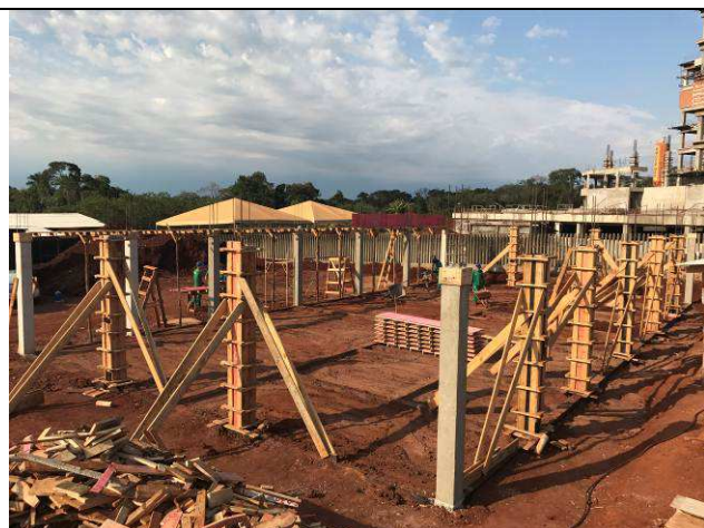
Figura 93C: Pilares do prédio do arquivo concretados.
