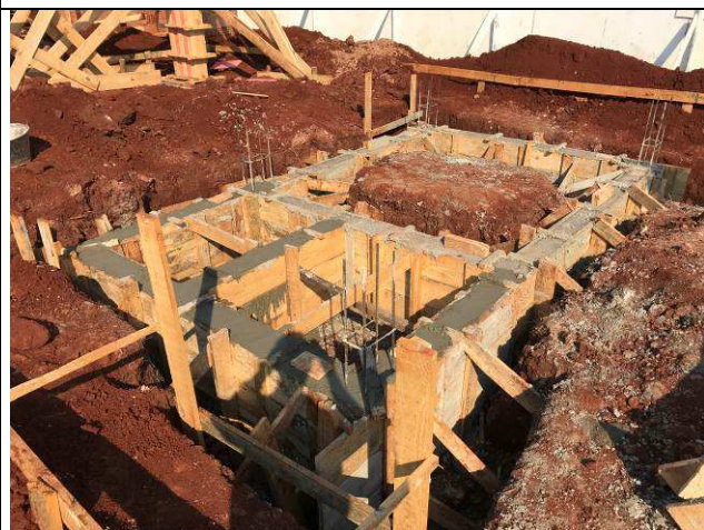
Figura 74C: Vigas baldrames da guarita concretadas.
