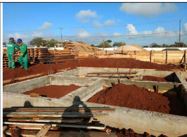
Figura 66C: Vigas baldrames do prédio do arquivo concretadas.
