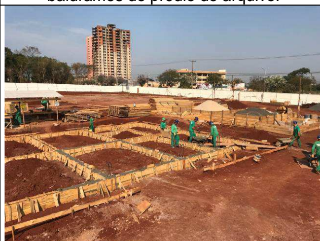
Figura 64C: Concretagem das vigas baldrame do prédio do arquivo.
