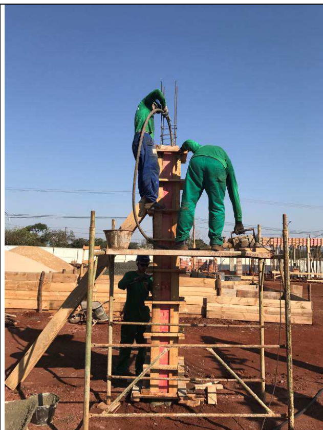
Figura 92C: Concretagem dos pilares do prédio do arquivo.
