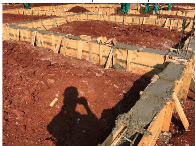
Figura 63C: Concretagem das vigas baldrame do prédio do arquivo.
