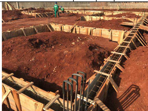
Figura 41C: Formas e armaduras das vigas baldrame do prédio principal.
