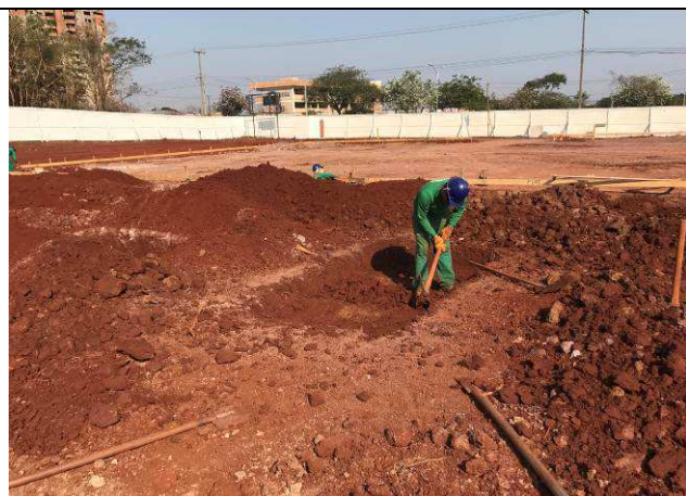
Figura 03C: Escavações para execução dos blocos do prédio principal.
