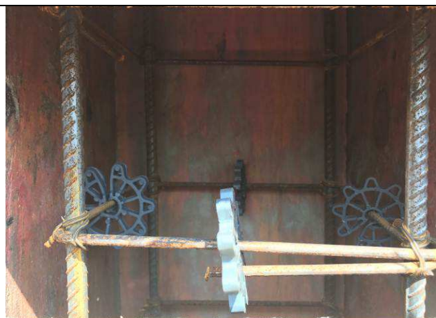
Figura 83C: Formas e armaduras do pilar P0 do prédio do arquivo.
