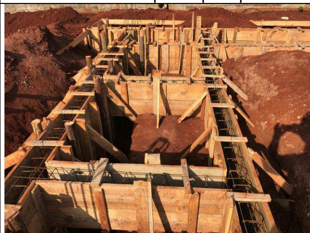
Figura 42C: Formas e armaduras das vigas baldrame do prédio principal.
