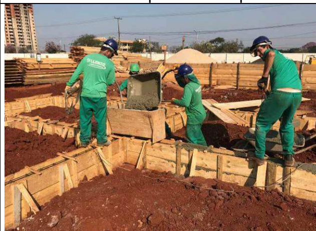
Figura 62C: Concretagem das vigas baldrame do prédio do arquivo.
