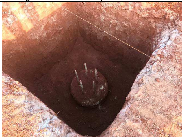
Figura 17C: Estacas concretadas.
