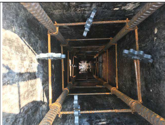
Figura 82C: Formas e armaduras do pilar P08 do prédio do arquivo.
