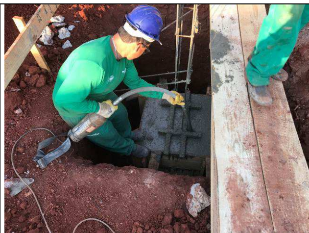
Figura 34C: Concretagem dos blocos do prédio principal.
