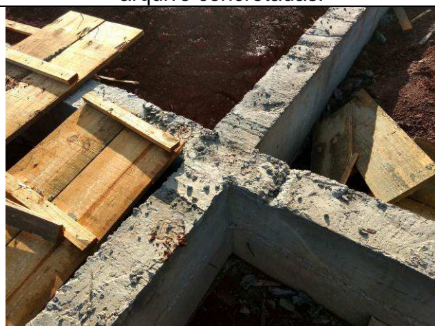
Figura 67C: Vigas baldrames do prédio do arquivo concretadas.
