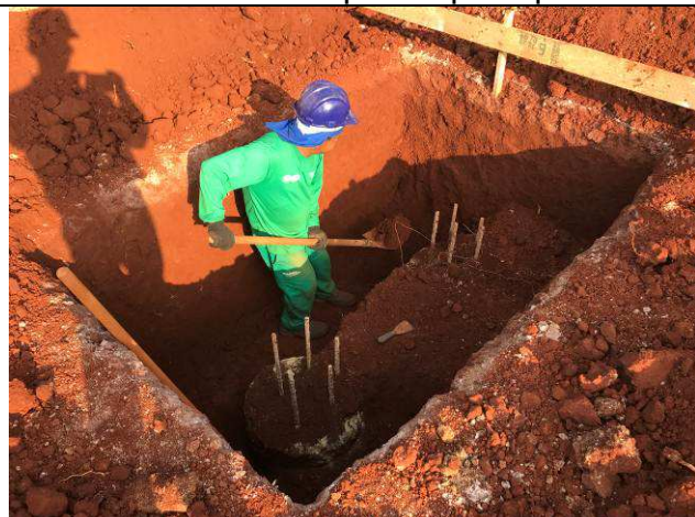
Figura 05C: Escavações para execução dos blocos do prédio principal.
