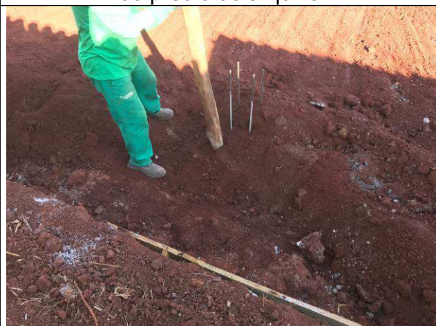
Figura 12C: Reaterro apilado dos blocos do prédio do arquivo.
