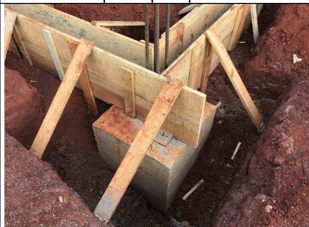
Figura 36C: Blocos do prédio principal concretados.
