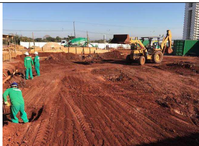
Figura 09C: Reaterro dos blocos do prédio do arquivo.
