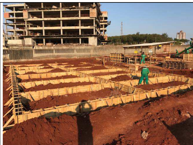
Figura 55C: Formas e armaduras das vigas baldrames do prédio do arquivo.
