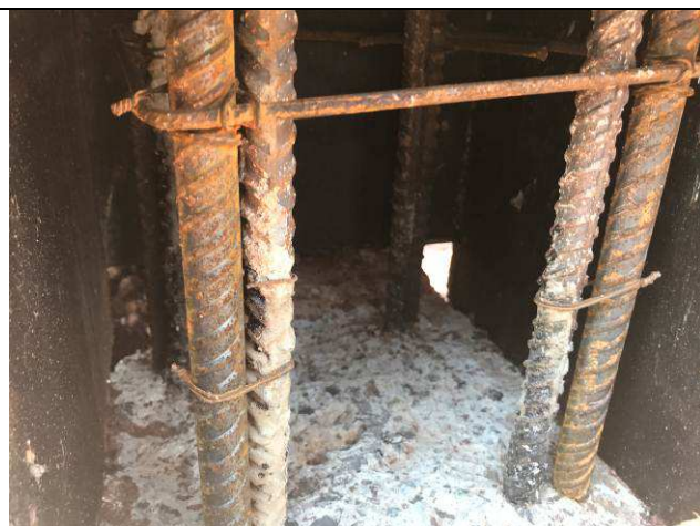
Figura 81C: Formas e armaduras do pilar P06 do prédio do arquivo.
