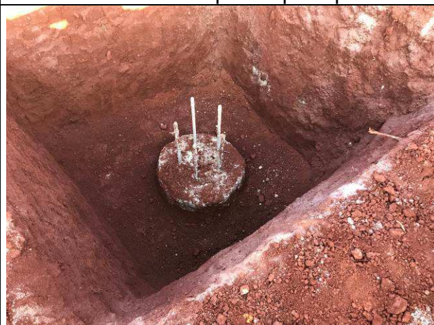
Figura 08C: Escavações para execução dos blocos do prédio principal.
