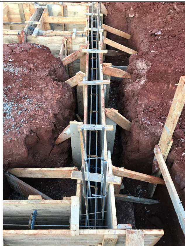
Figura 71C: Formas e armaduras das vigas baldrames da guarita.
