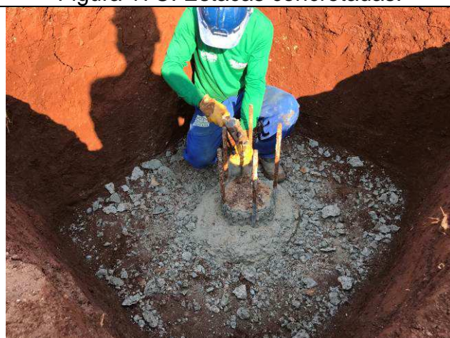
Figura 19C: Corte e preparo da cabeça das estacas.
