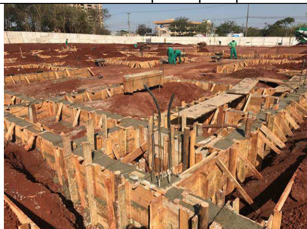
Figura 51C: Concretagem das vigas baldrames do prédio principal.
