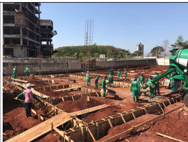
Figura 46C: Concretagem das vigas baldrames do prédio principal.
