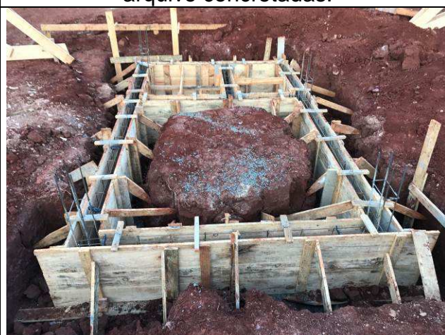
Figura 70C: Formas e armaduras das vigas baldrames da guarita.
