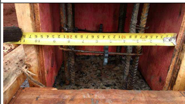
Figura 79C: Formas e armaduras do pilar P07 do prédio do arquivo.
