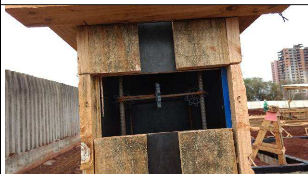
Figura 78C: Abertura intermediária do pilar P01 para concretagem.
