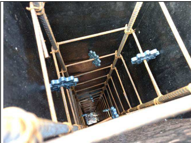
Figura 75C: Formas e armaduras do pilar P01 do prédio do arquivo.
