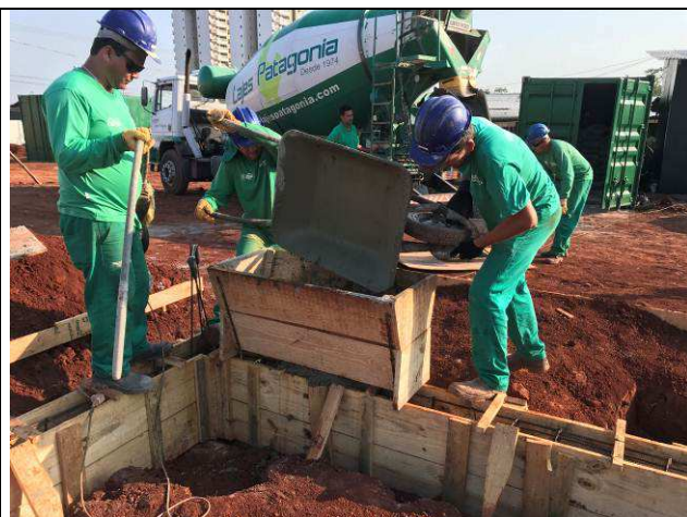
Figura 60C: Concretagem das vigas baldrame do prédio do arquivo.
