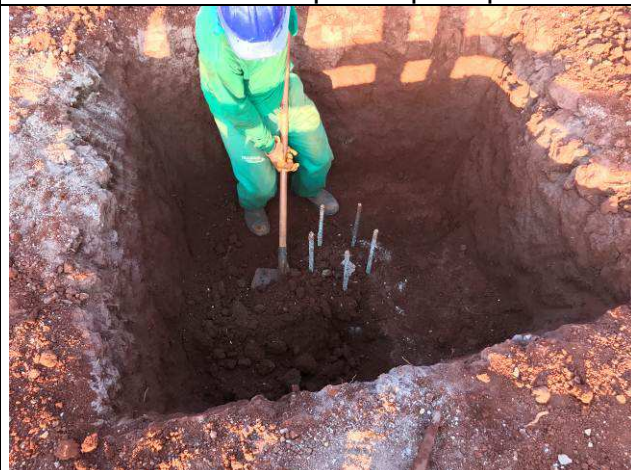
Figura 06C: Escavações para execução dos blocos do prédio principal.
