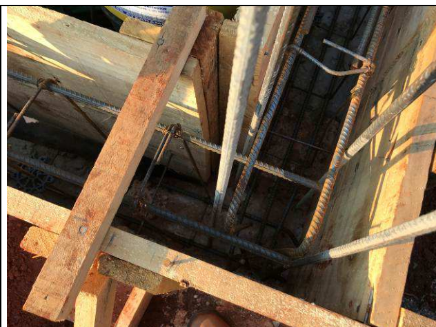
Figura 56C: Formas e armaduras das vigas baldrames do prédio do arquivo.
