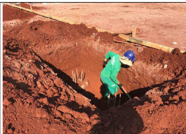
Figura 04C: Escavações para execução dos blocos do prédio principal.
