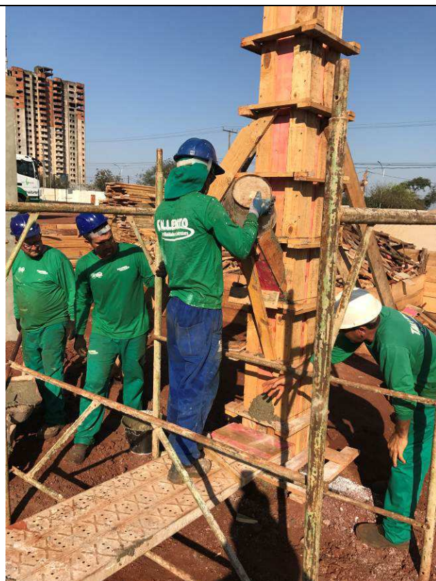
Figura 91C: Concretagem dos pilares do prédio do arquivo.
