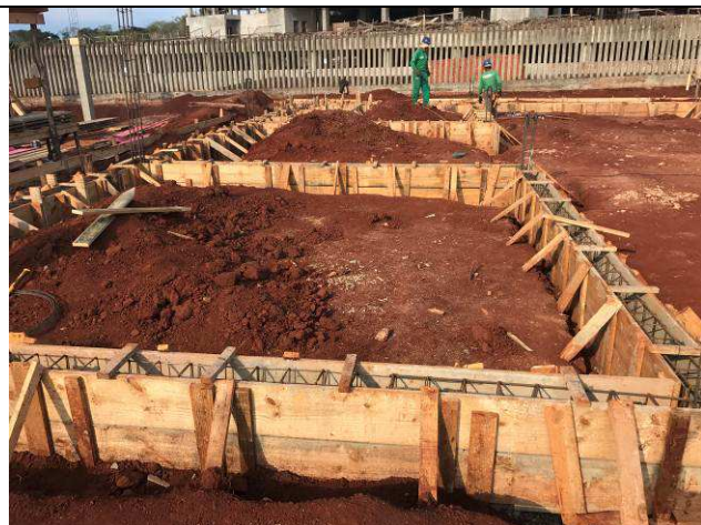
Figura 39C: Formas e armaduras das vigas baldrame do prédio principal.
