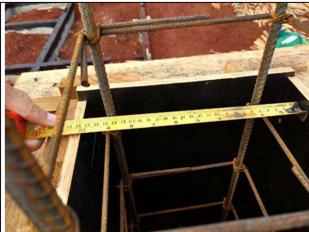
Figura 76C: Formas e armaduras do pilar P01 do prédio do arquivo.
