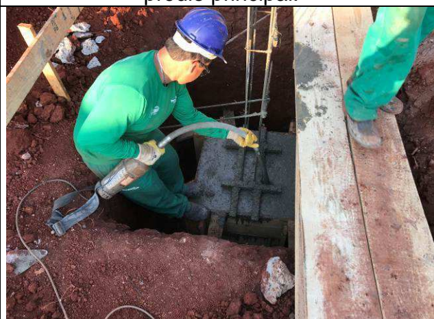
Figura 32C: Concretagem dos blocos do prédio principal.
