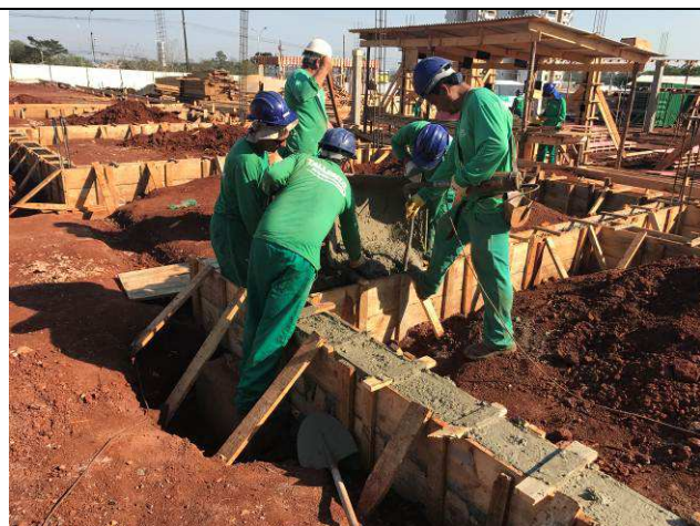
Figura 49C: Concretagem das vigas baldrames do prédio principal.
