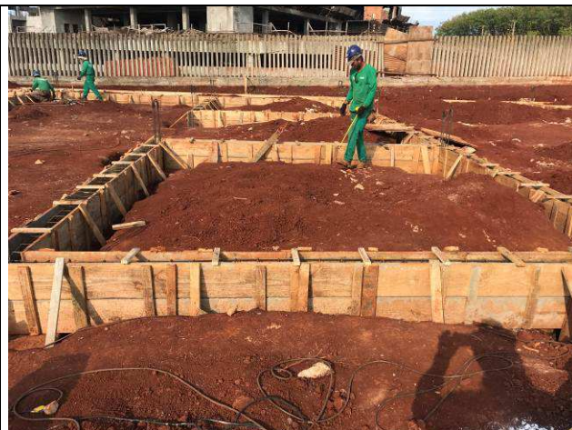
Figura 40C: Formas e armaduras das vigas baldrame do prédio principal.
