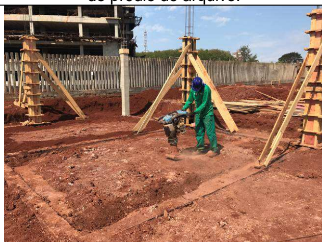
Figura 13C: Compactação do reaterro entre baldrame do prédio do arquivo.
