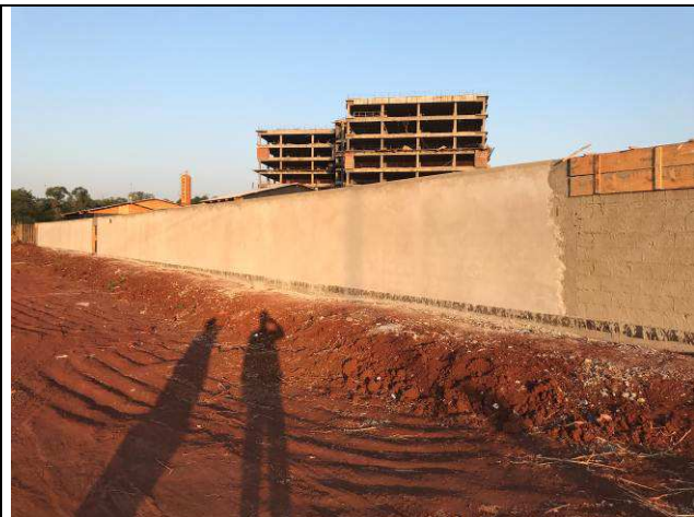
Figura 102C: Massa única executada - face externa - muro de fechamento.
