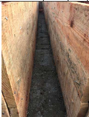
Figura 43C: Lastro de concreto no fundo das vigas baldrame do prédio principal.
