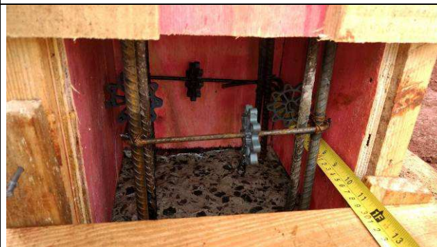
Figura 86C: Formas e armaduras do pilar P18 do prédio do arquivo.
