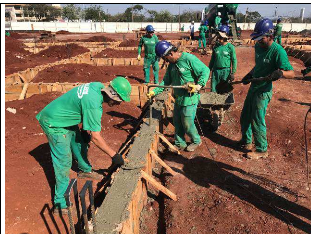
Figura 50C: Concretagem das vigas baldrames do prédio principal.
