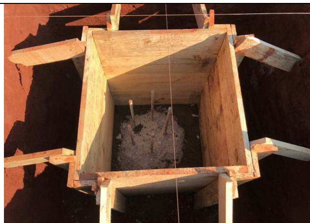
Figura 23C: Estacas preparadas e lastro de concreto no fundo dos blocos.
