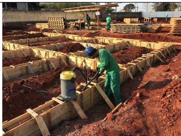
Figura 59C: Limpeza das impurezas na base dos pilares.
