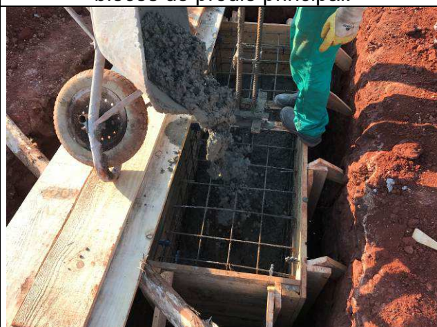
Figura 29C: Concretagem dos blocos do prédio principal.
