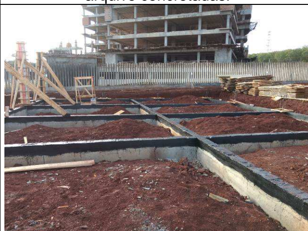
Figura 68C: Vigas baldrames do prédio do arquivo concretadas.
