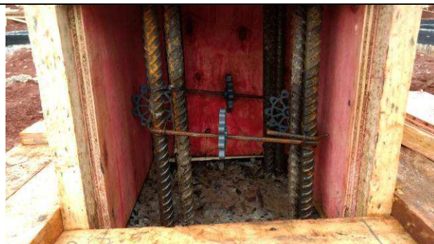
Figura 85C: Formas e armaduras do pilar P11 do prédio do arquivo.
