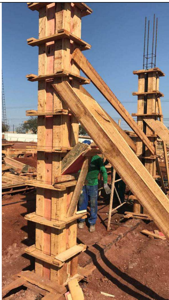
Figura 88C: Formas e armaduras dos pilares do prédio do arquivo.
