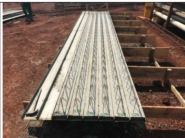
Figura 68C: Moldagem das vigotas treliçadas das lajes.
