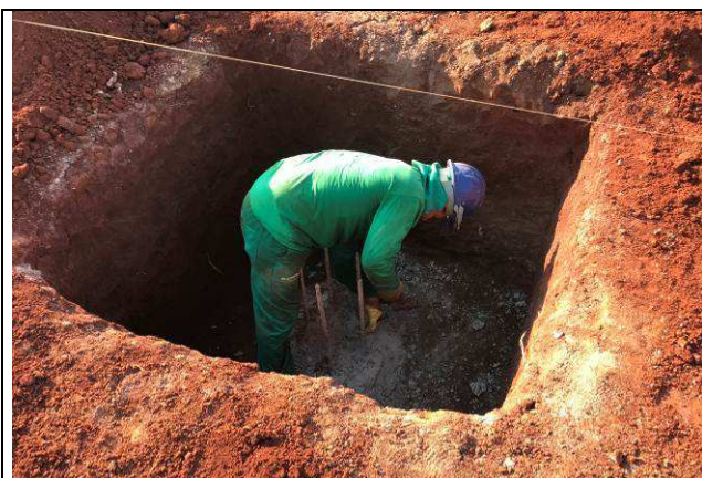
Figura 09C: Corte e preparo da cabeça das estacas.
