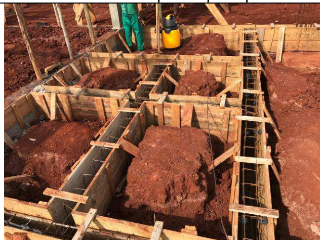
Figura 21C: Formas e armaduras das vigas baldrame do prédio principal.
