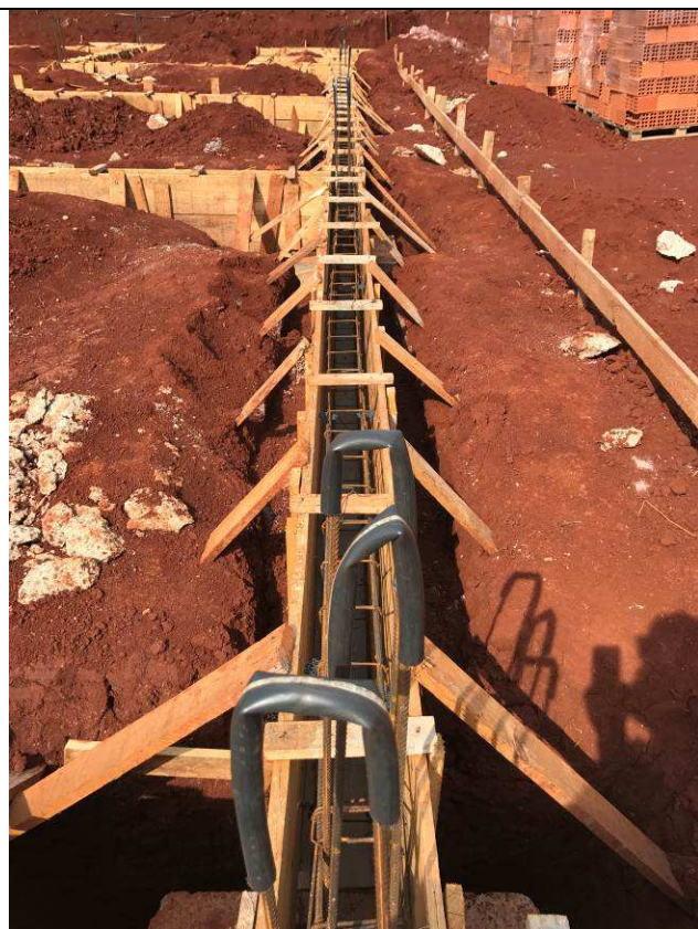
Figura 25C: Formas e armaduras das vigas baldrames do prédio principal.
