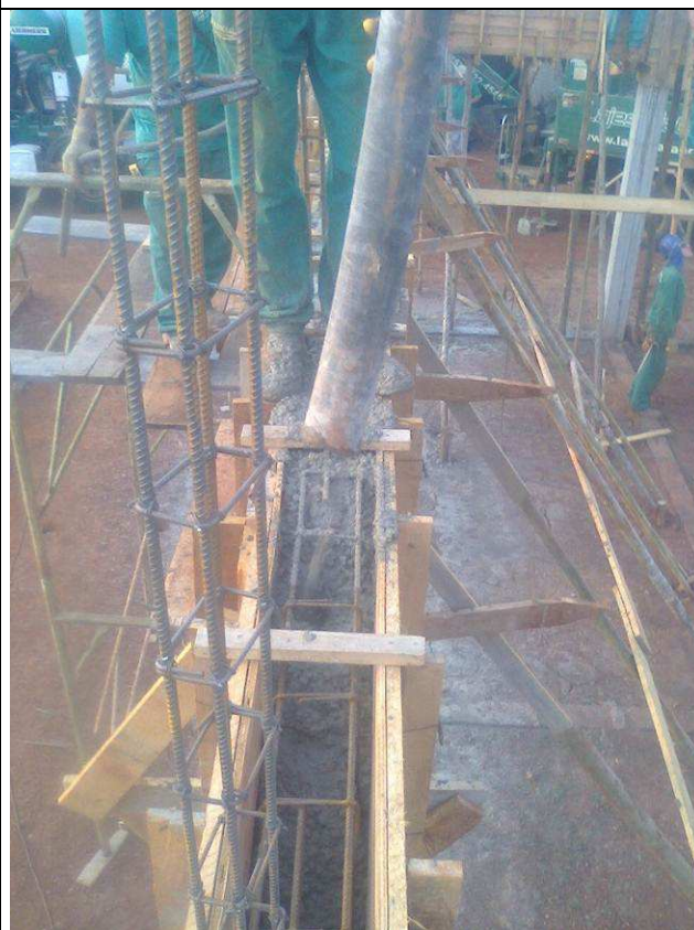
Figura 96C: Concretagem das vigas do arquivo.
