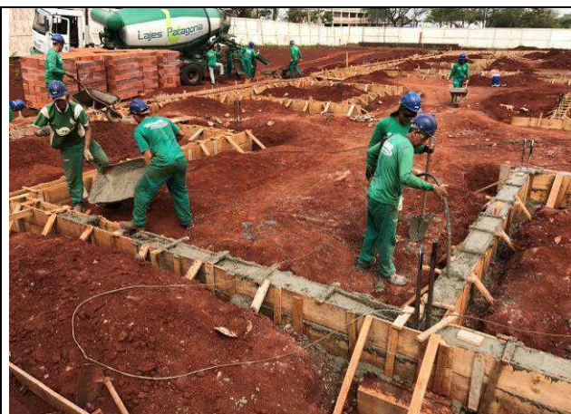
Figura 30C: Concretagem das vigas baldrame do prédio principal.
