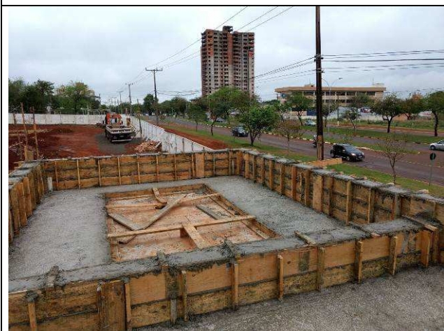
Figura 109C: Vigas e lajes da guarita concretadas.
