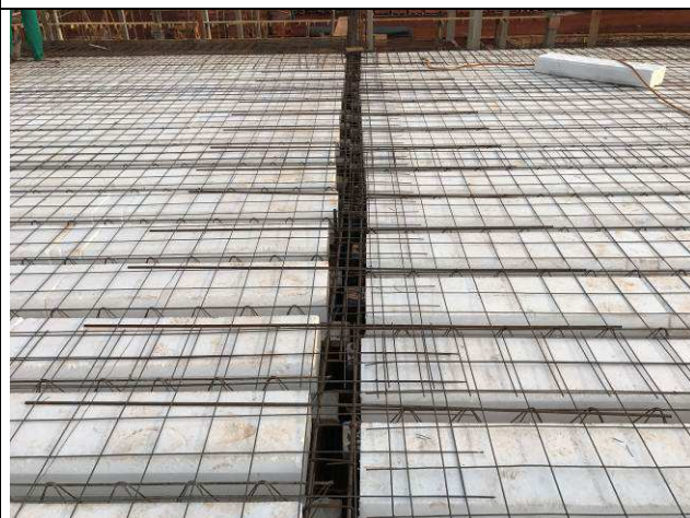
Figura 76C: Laje e vigas de cobertura do prédio principal - eixos 1-5 e D-F.
