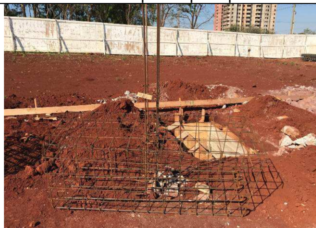
Figura 15C: Armaduras dos blocos do prédio principal.
