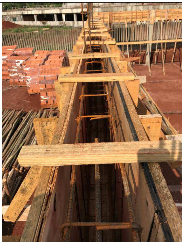
Figura 91C: Formas e armaduras das vigas do arquivo.
