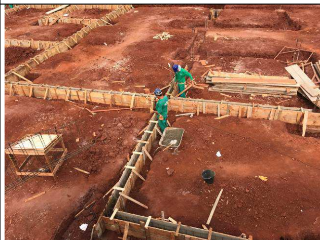
Figura 28C: Formas e armaduras das vigas baldrames do prédio principal.
