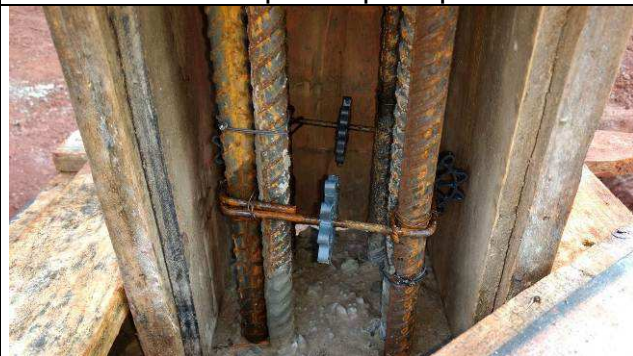
Figura 49C: Formas e armaduras do pilar P13 do prédio principal.
