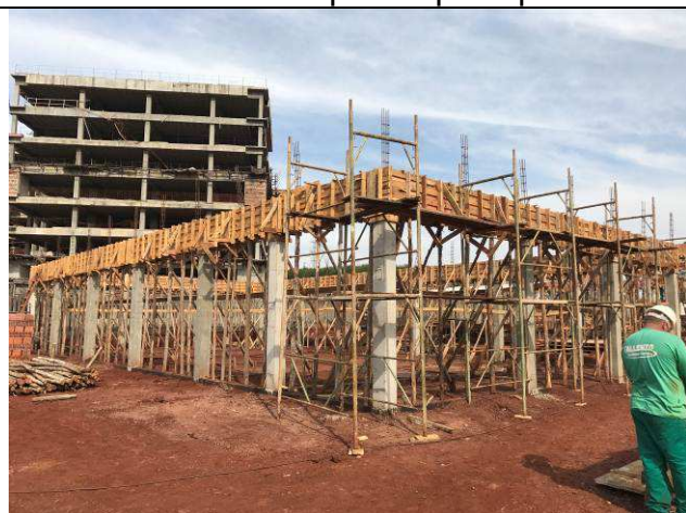
Figura 87C: Formas e armaduras das vigas do arquivo.
