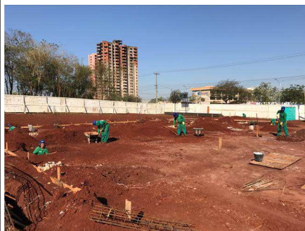
Figura 02C: Escavações para execução dos blocos do prédio principal.
