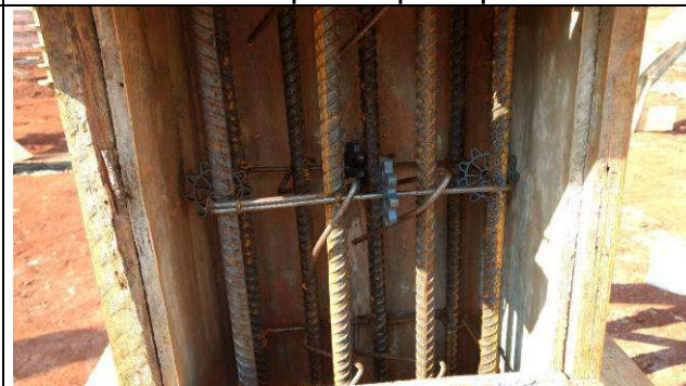
Figura 54C: Formas e armaduras do pilar P26 do prédio principal.
