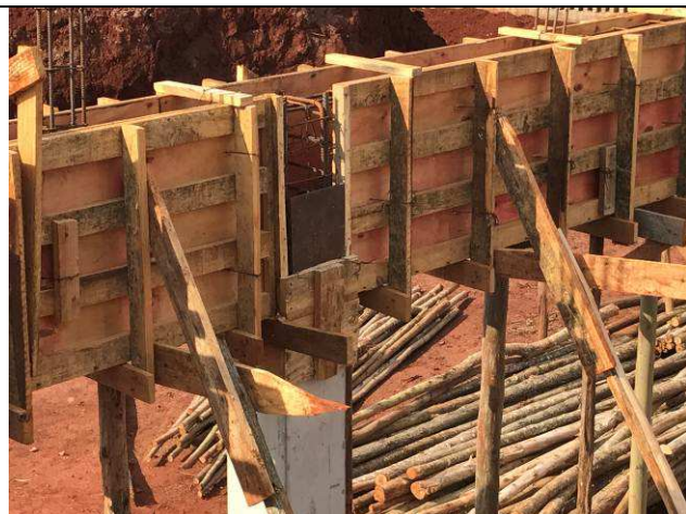
Figura 93C: Insertes metálicos para fixação da estrutura metálica de cobertura.
