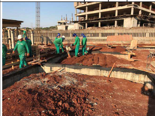
Figura 05C: Reaterro das baldrames do prédio principal.
