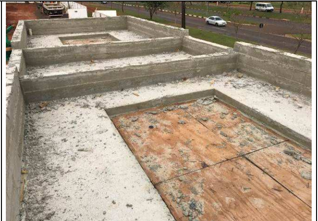
Figura 112C: Vigas e lajes da guarita concretadas.
