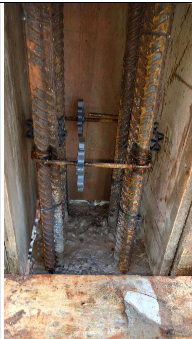
Figura 52C: Formas e armaduras do pilar P13 do prédio principal.
