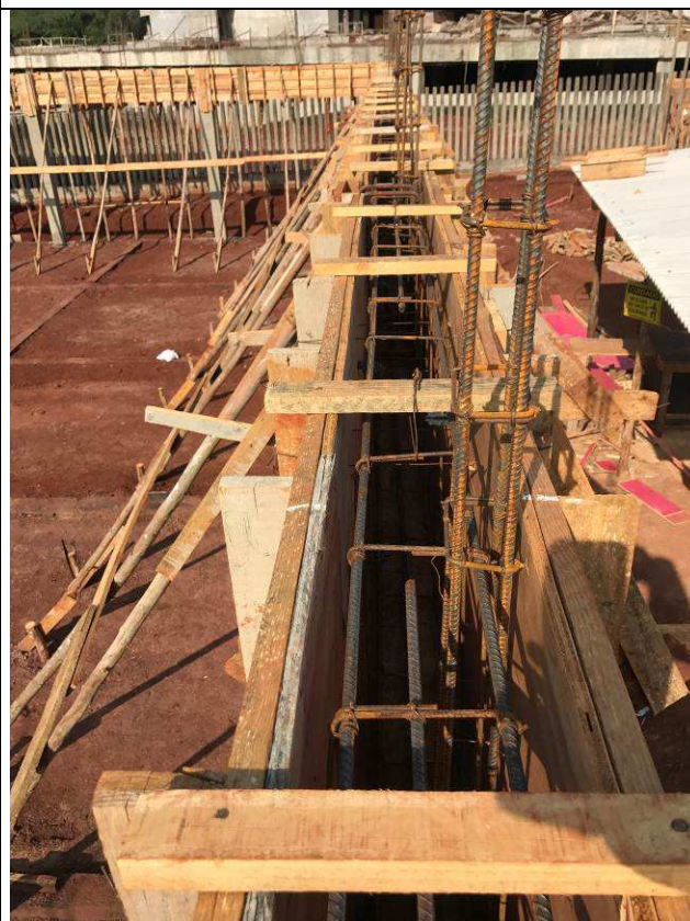
Figura 92C: Formas e armaduras das vigas do arquivo.
