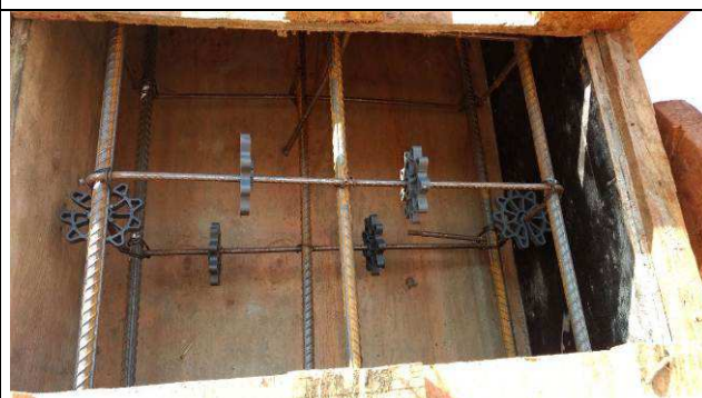
Figura 58C: Formas e armaduras do pilar P40 do prédio principal.
