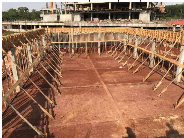
Figura 88C: Formas e armaduras das vigas do arquivo.
