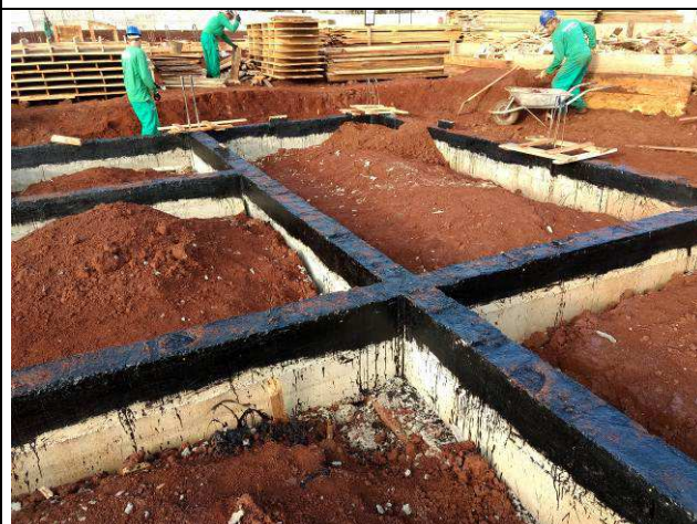
Figura 120C: Impermeabilização das vigas baldrames do prédio principal.
