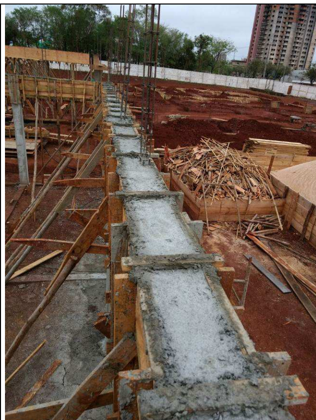
Figura 98C: Vigas do arquivo concretadas.
