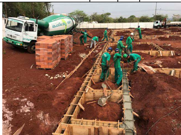
Figura 33C: Concretagem das vigas baldrame do prédio principal.
