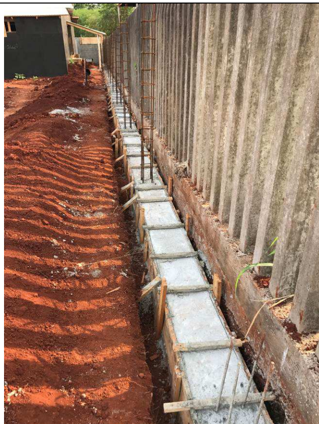
Figura 127C: Vigas baldrame - muro de fechamento - fundos.
