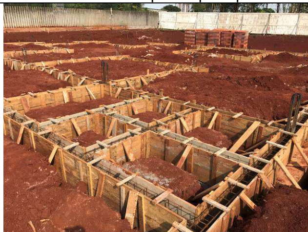
Figura 22C: Formas e armaduras das vigas baldrame do prédio principal.
