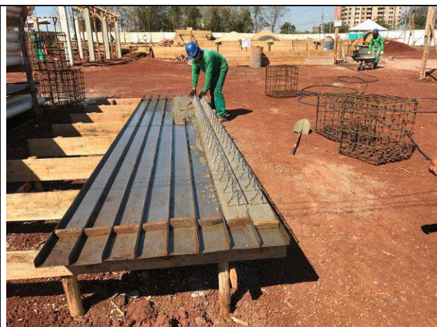
Figura 67C: Moldagem das vigotas treliçadas das lajes.
