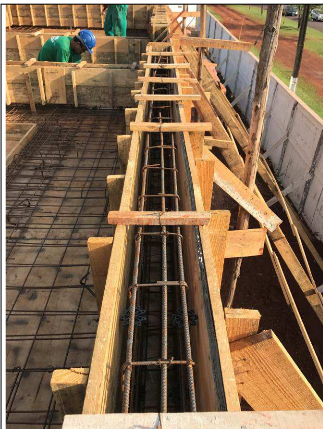
Figura 107C: Formas e armaduras das vigas e lajes da guarita.
