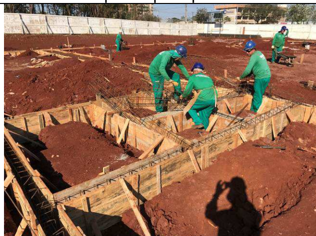
Figura 17C: Formas e armaduras das vigas baldrame do prédio principal.
