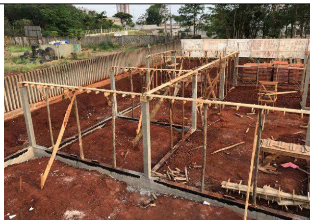
Figura 61C: Pilares do prédio principal concretados.
