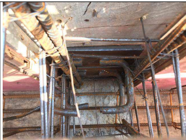
Figura 94C: Insertes metálicos para fixação da estrutura metálica de cobertura.
