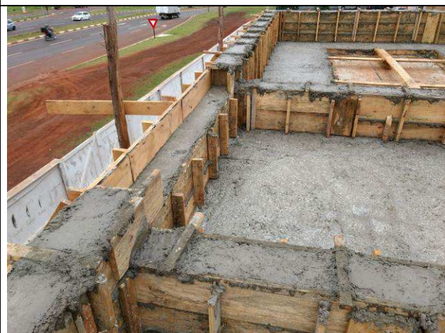
Figura 110C: Vigas e lajes da guarita concretadas.
