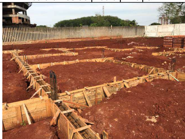
Figura 23C: Formas e armaduras das vigas baldrame do prédio principal.
