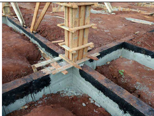
Figura 117C: Impermeabilização das vigas baldrames do prédio principal.
