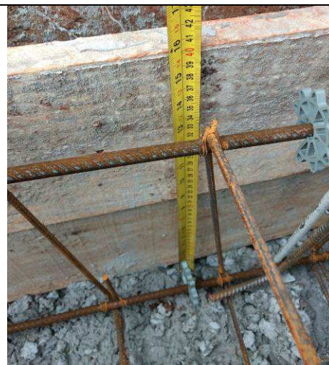
Figura 126C: Vigas baldrame - muro de fechamento - fundos.
