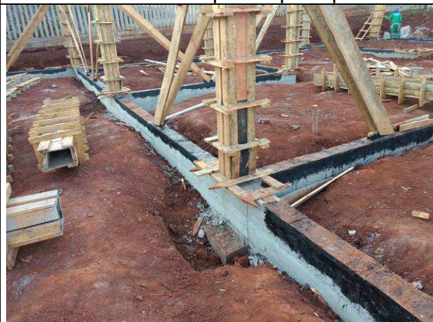
Figura 40C: Vigas baldramas do prédio principal concretadas.
