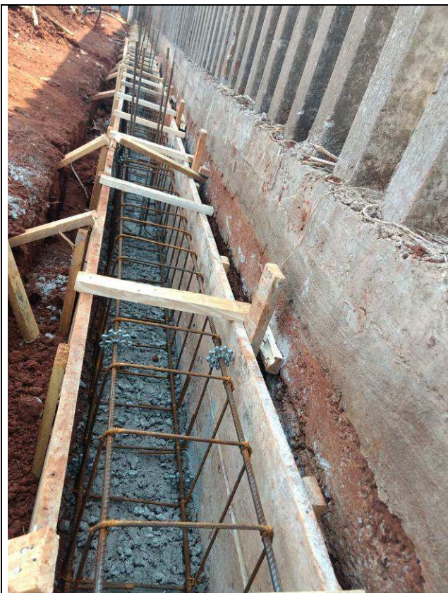
Figura 123C: Vigas baldrame - muro de fechamento - fundos.
