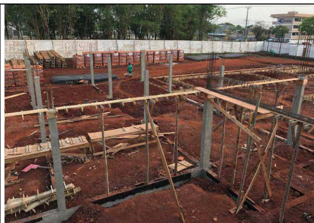
Figura 62C: Pilares do prédio principal concretados.
