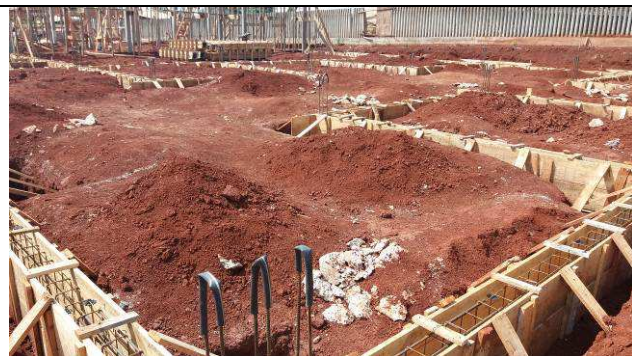
Figura 19C: Formas e armaduras das vigas baldrame do prédio principal.
