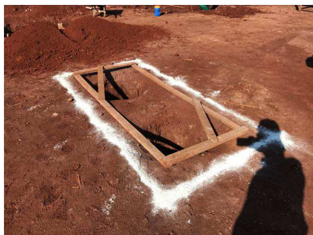
Figura 01C: Escavações para execução dos blocos do prédio principal.
