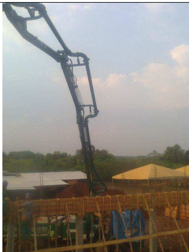
Figura 95C: Concretagem das vigas do arquivo.
