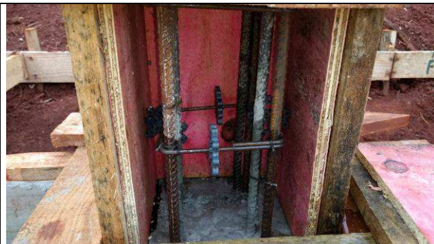
Figura 41C: Formas e armaduras do pilar P03 do prédio principal.
