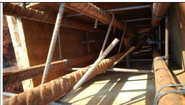
Figura 56C: Formas e armaduras do pilar P37 do prédio principal.
