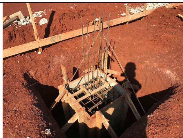
Figura 14C: Formas e armaduras dos blocos do prédio principal.
