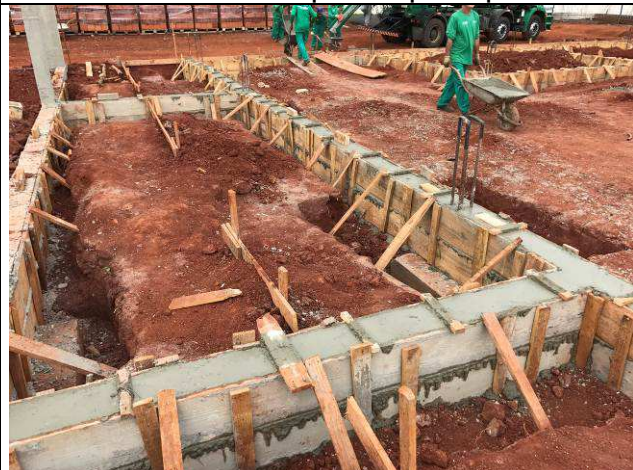
Figura 38C: Concretagem das vigas baldramas do prédio principal.
