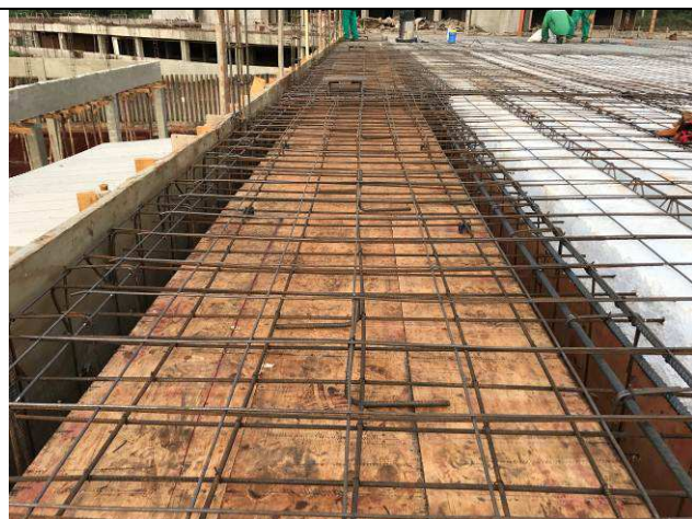
Figura 75C: Laje e vigas de cobertura do prédio principal - eixos 1-5 e D-F.
