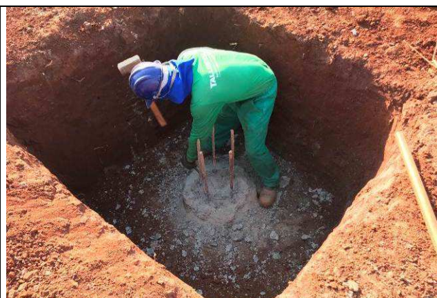
Figura 10C: Corte e preparo da cabeça das estacas.
