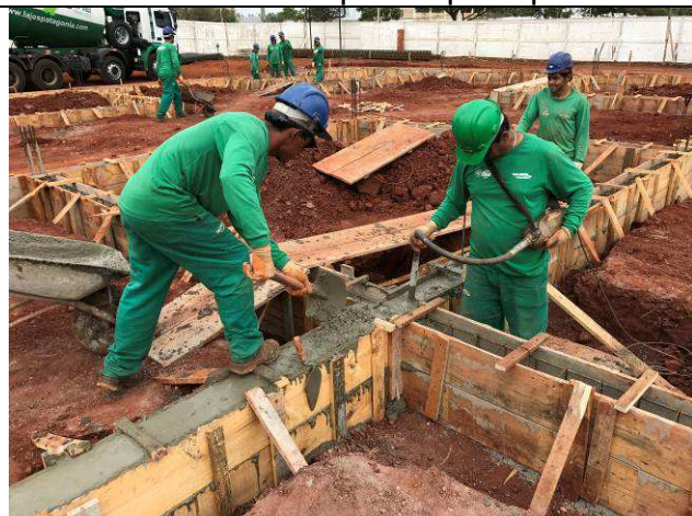
Figura 39C: Concretagem das vigas baldramas do prédio principal.
