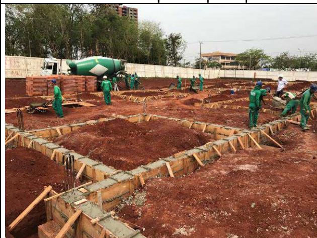
Figura 34C: Concretagem das vigas baldrame do prédio principal.
