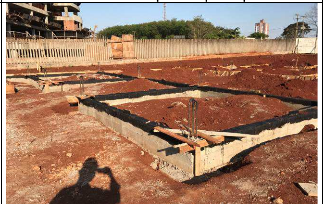
Figura 116C: Impermeabilização das vigas baldrame do prédio principal.
