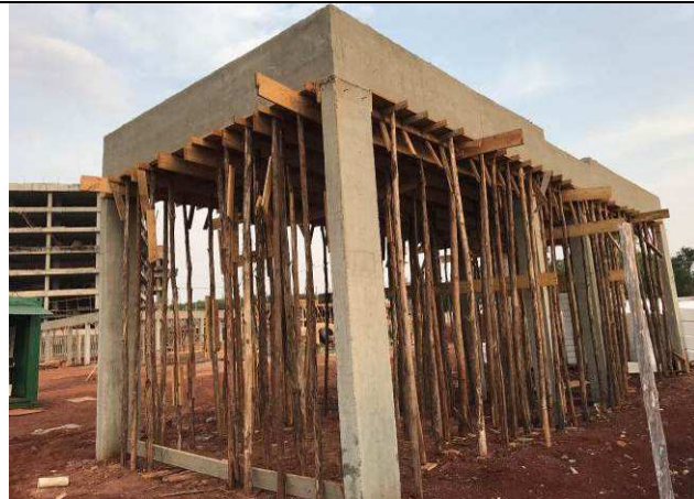
Figura 111C: Vigas e lajes da guarita concretadas.
