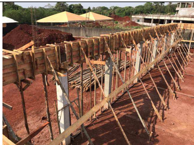
Figura 89C: Formas e armaduras das vigas do arquivo.
