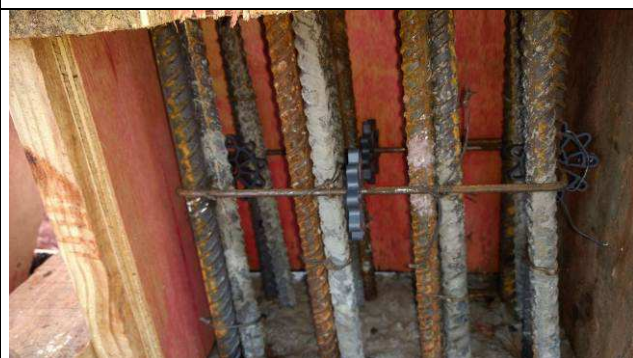
Figura 43C: Formas e armaduras do pilar P25 do prédio principal.
