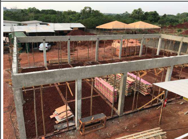
Figura 99C: Vigas do arquivo concretadas.
