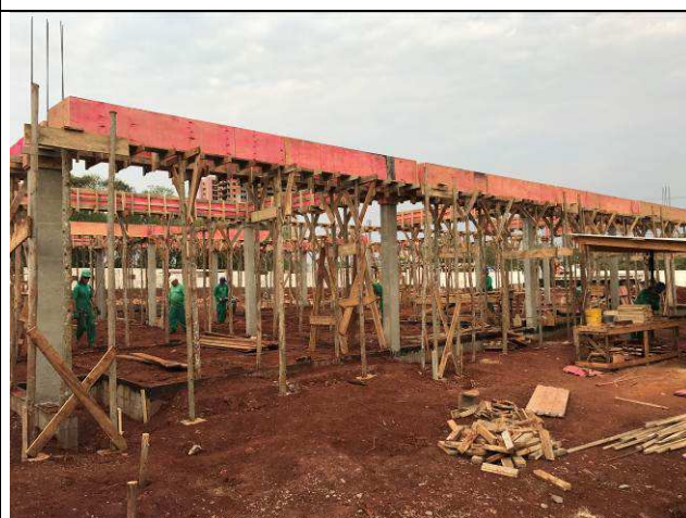
Figura 60C: Pilares do prédio principal concretados.
