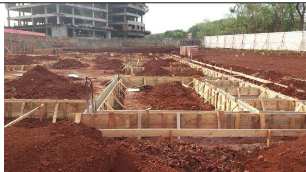
Figura 20C: Formas e armaduras das vigas baldrame do prédio principal.
