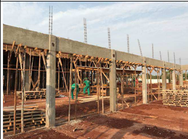
Figura 100C: Vigas do arquivo concretadas.
