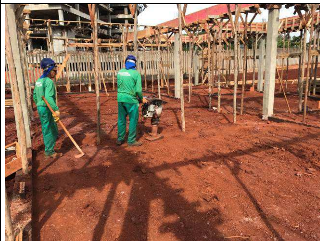
Figura 06C: Reaterro das baldrames do prédio principal.
