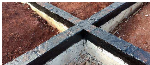
Figura 121C: Impermeabilização das vigas baldrames do arquivo.
