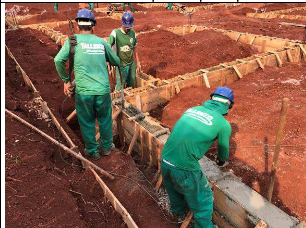
Figura 32C: Concretagem das vigas baldrame do prédio principal.
