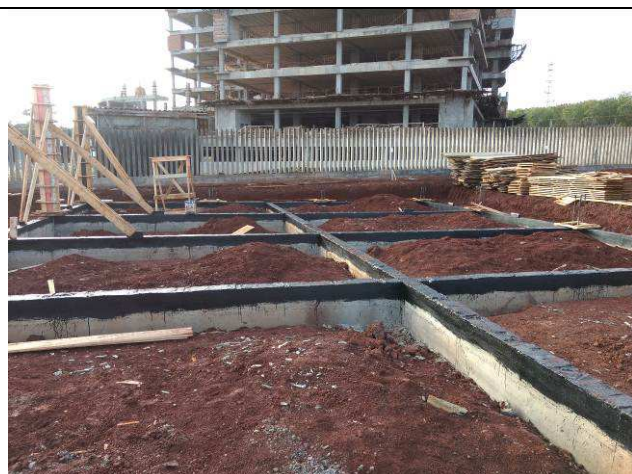
Figura 119C: Impermeabilização das vigas baldrames do arquivo.
