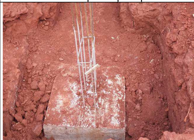
Figura 16C: Blocos do prédio principal concretados.
