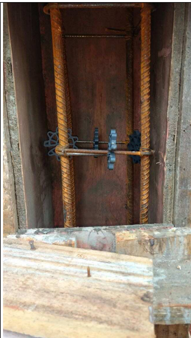
Figura 48C: Formas e armaduras do pilar P04 do prédio principal.
