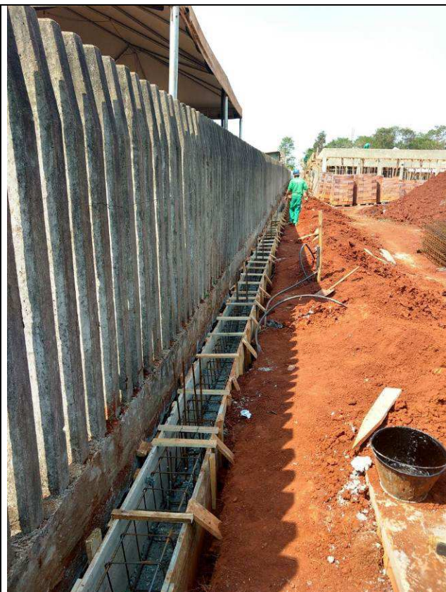
Figura 124C: Vigas baldrame - muro de fechamento - fundos.
