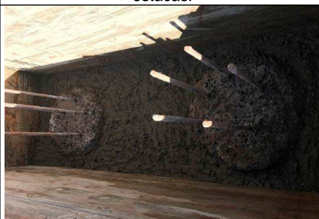
Figura 12C: Estacas preparadas e lastro de concreto no fundo dos blocos.
