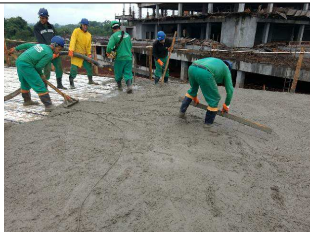
Figura 84C: Concretagem da laje e vigas de cobertura do prédio principal.
