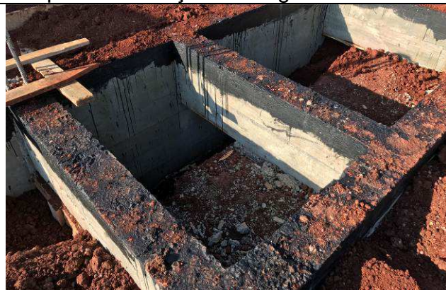
Figura 115C: Impermeabilização das vigas baldrame do prédio principal.
