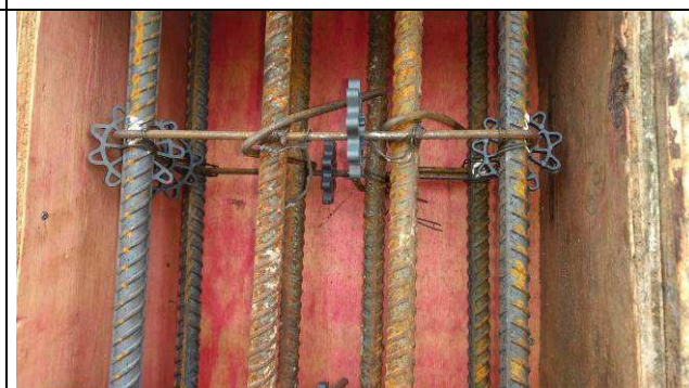
Figura 44C: Formas e armaduras do pilar P25 do prédio principal.
