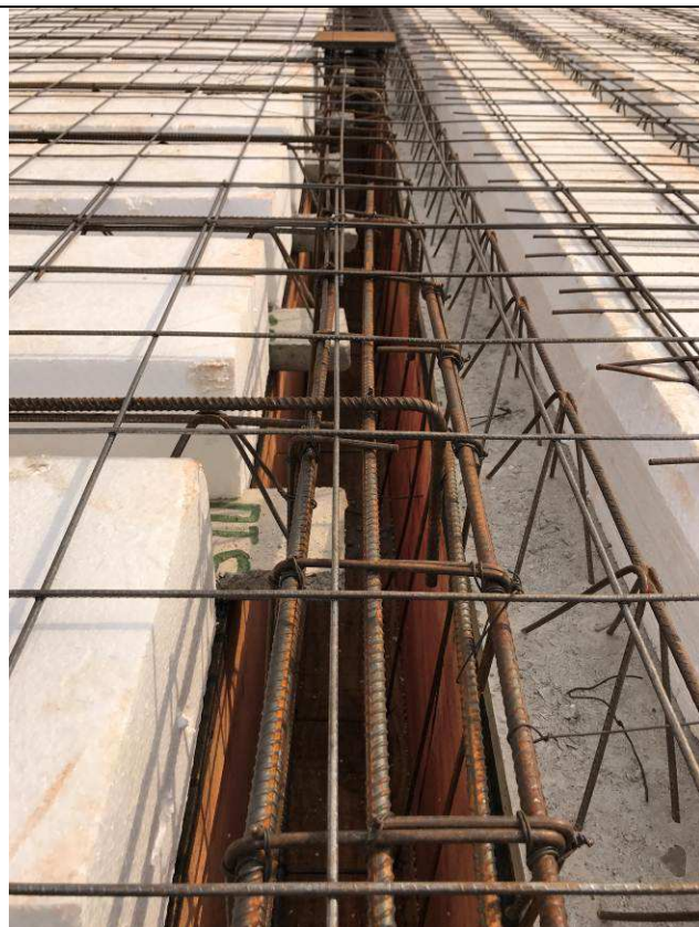
Figura 73C: Laje e vigas de cobertura do prédio principal - eixos 1-5 e D-F.
