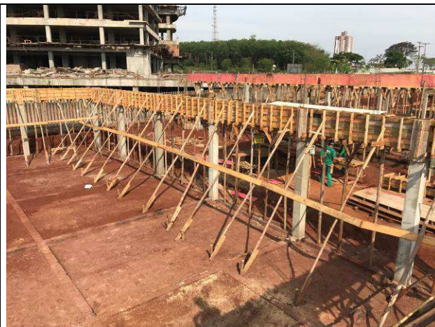
Figura 90C: Formas e armaduras das vigas do arquivo.
