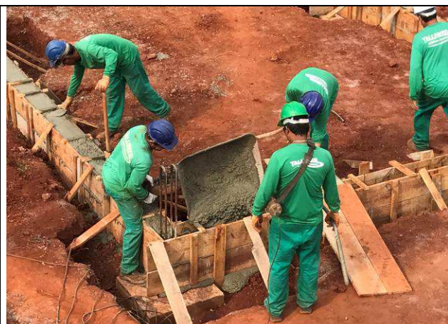
Figura 36C: Concretagem das vigas baldramas do prédio principal.
