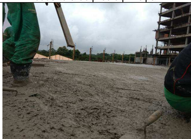
Figura 86C: Concretagem da laje e vigas de cobertura do prédio principal.
