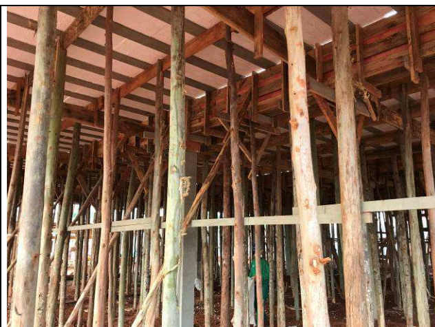
Figura 78C: Laje e vigas de cobertura do prédio principal - eixos 1-5 e D-F.
