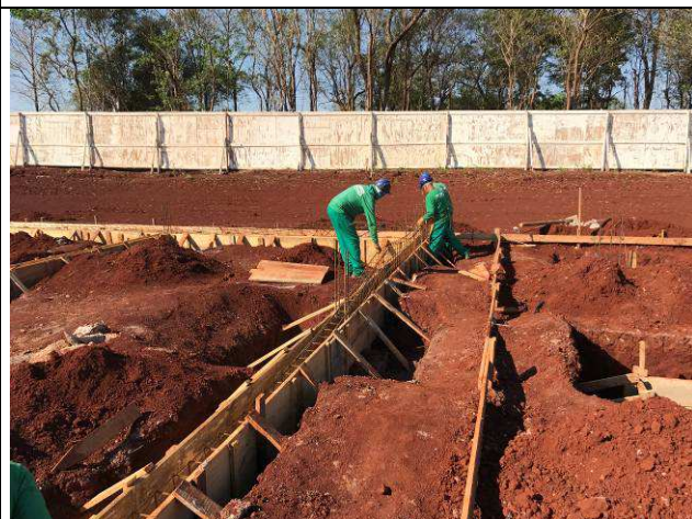
Figura 18C: Formas e armaduras das vigas baldrame do prédio principal.
