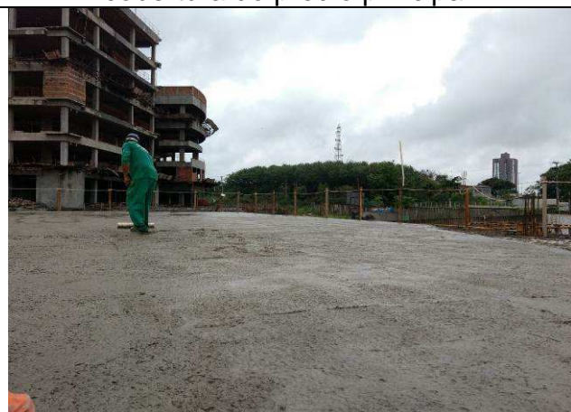
Figura 85C: Concretagem da laje e vigas de cobertura do prédio principal.
