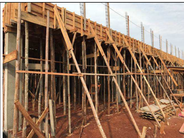
Figura 77C: Laje e vigas de cobertura do prédio principal - eixos 1-5 e D-F.
