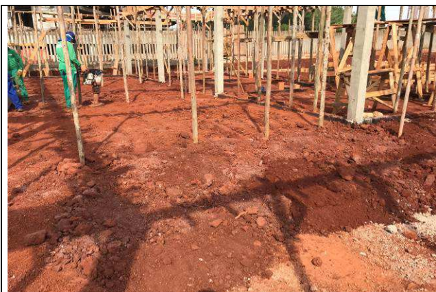
Figura 07C: Reaterro das baldrames do prédio principal.
