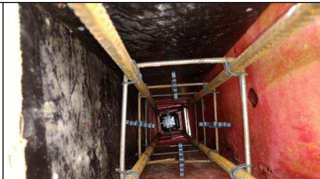
Figura 42C: Formas e armaduras do pilar P03 do prédio principal.
