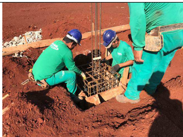
Figura 13C: Formas e armaduras dos blocos do prédio principal.
