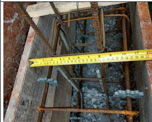
Figura 125C: Vigas baldrame - muro de fechamento - fundos.
