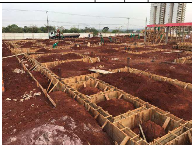
Figura 24C: Formas e armaduras das vigas baldrame do prédio principal.
