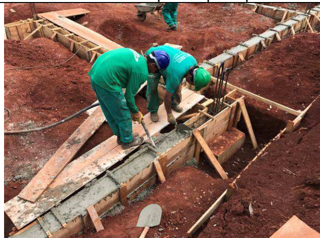
Figura 31C: Concretagem das vigas baldrame do prédio principal.
