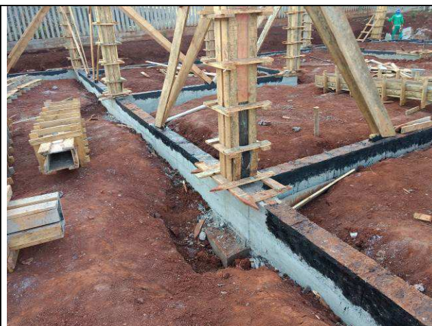
Figura 118C: Impermeabilização das vigas baldrames do prédio principal.
