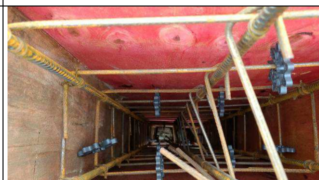
Figura 46C: Formas e armaduras do pilar P33 do prédio principal.
