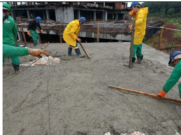
Figura 83C: Concretagem da laje e vigas de cobertura do prédio principal.
