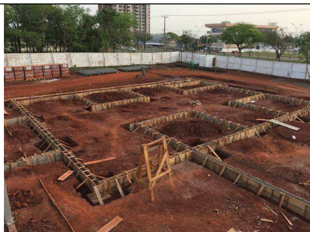
Figura 27C: Formas e armaduras das vigas baldrames do prédio principal.
