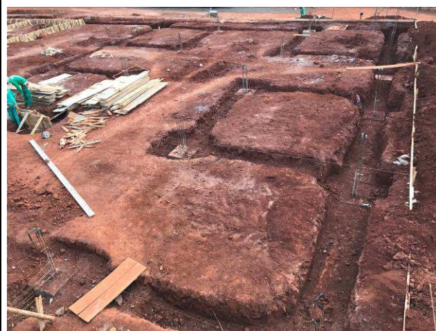
Figura 04C: Escavações para execução das baldrames do prédio principal.
