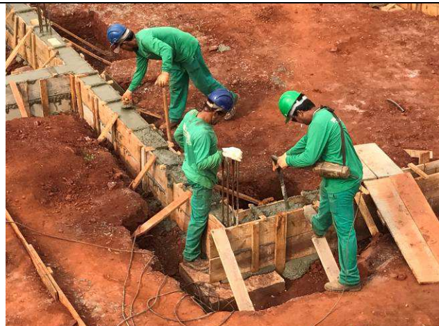
Figura 37C: Concretagem das vigas baldramas do prédio principal.
