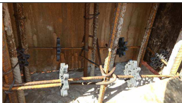
Figura 57C: Formas e armaduras do pilar P40 do prédio principal.
