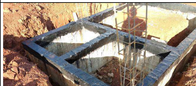
Figura 122C: Impermeabilização das vigas baldrames da guarita.
