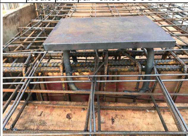
Figura 81C: Inserte para estrutura metálica de cobertura.
