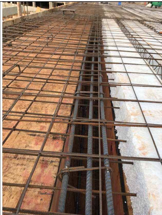
Figura 74C: Laje e vigas de cobertura do prédio principal - eixos 1-5 e D-F.
