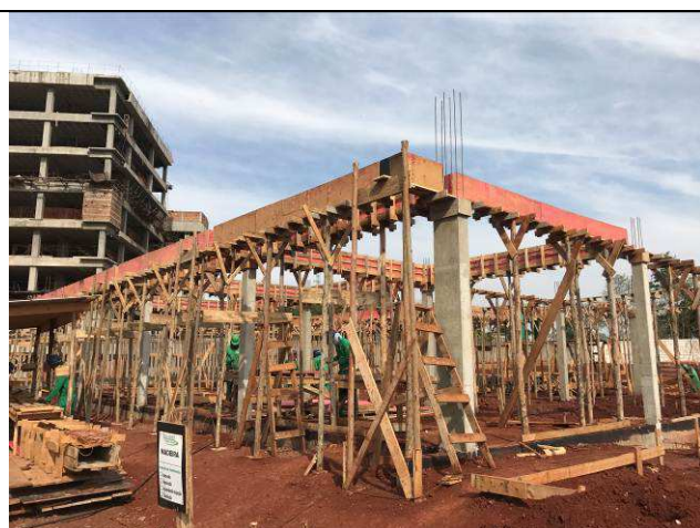
Figura 59C: Pilares do prédio principal concretados.
