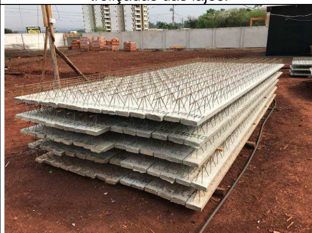
Figura 69C: Vigotas treliçadas das lajes.
