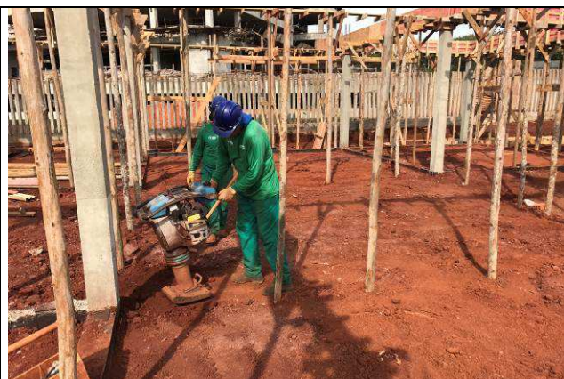
Figura 08C: Reaterro das baldrames do prédio principal.
