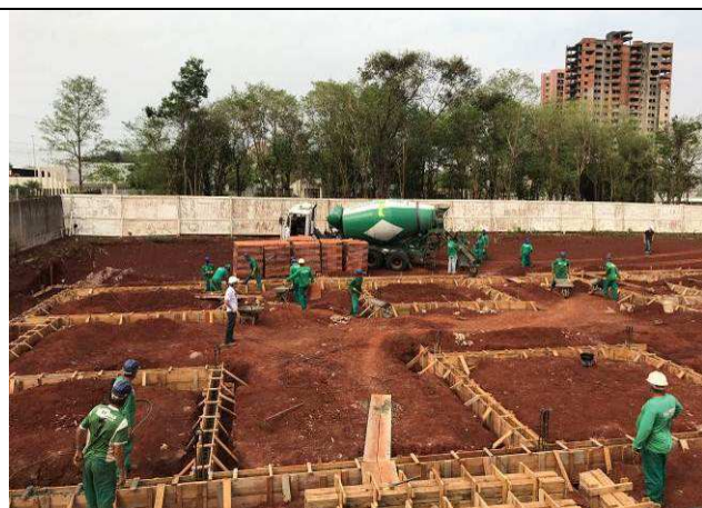
Figura 29C: Concretagem das vigas baldrame do prédio principal.
