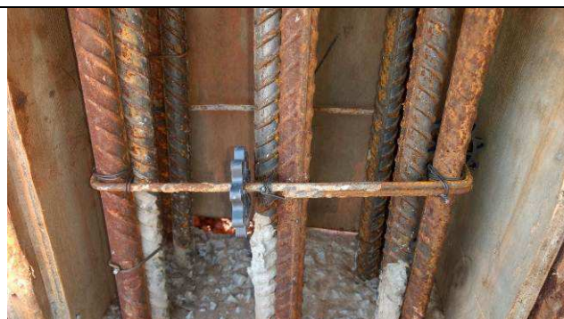
Figura 55C: Formas e armaduras do pilar P37 do prédio principal.
