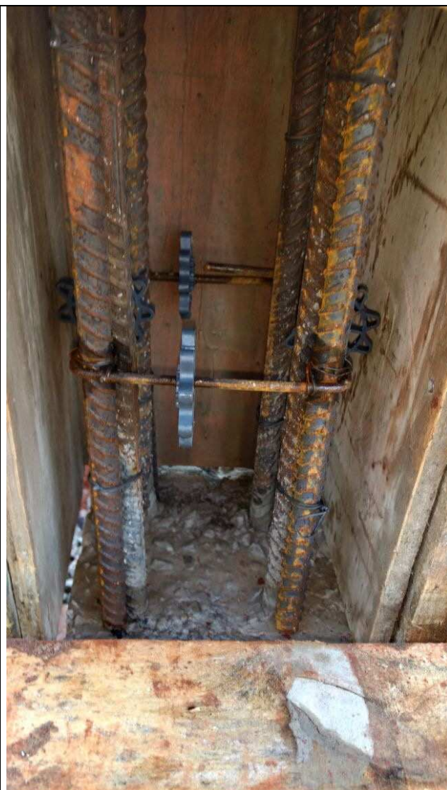
Figura 51C: Formas e armaduras do pilar P13 do prédio principal.
