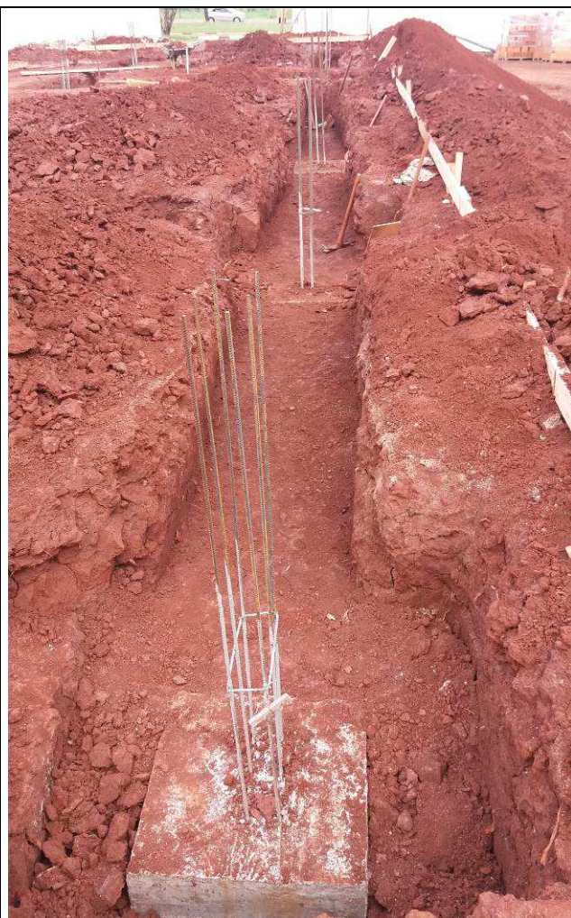
Figura 03C: Escavações para execução das baldrames do prédio principal.
