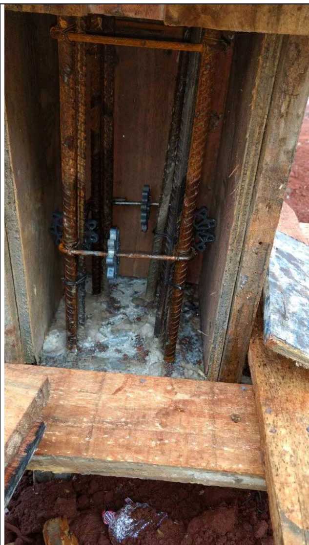
Figura 47C: Formas e armaduras do pilar P04 do prédio principal.
