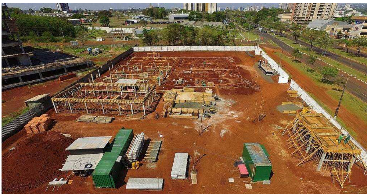
Figura 1 – Vista aérea do canteiro de obras.
