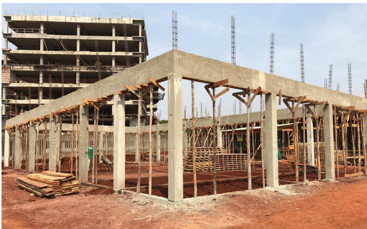
Figura 3 – Prédio do arquivo.
