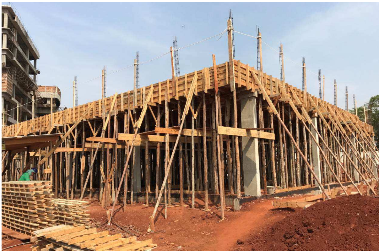
Figura 2 – Vigas de cobertura e laje do prédio principal.
