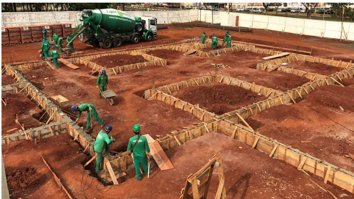
Figura 5 – Concretagem das vigas baldrame do prédio principal.
