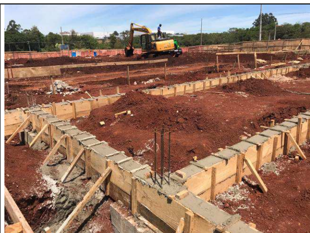
Figura 40C: Concretagem das vigas baldrames.
