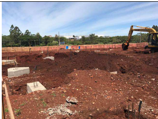
Figura 06C: Escavação das vigas baldrames com escavadeira.
