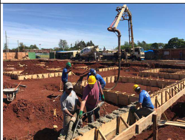
Figura 28C: Concretagem das vigas baldrames.
