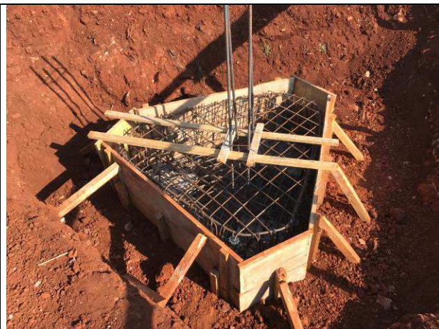
Figura 10C: Formas e armaduras - P65.
