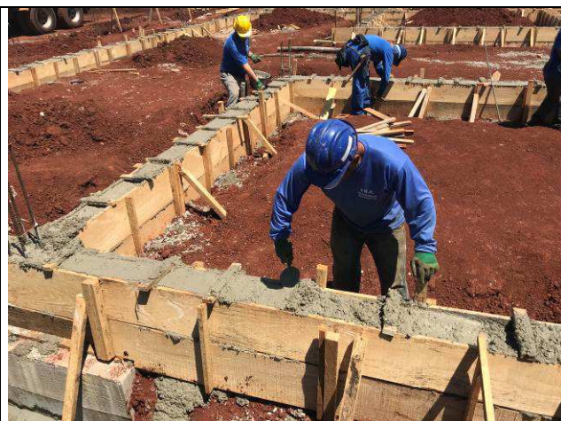
Figura 39C: Concretagem das vigas baldrames.
