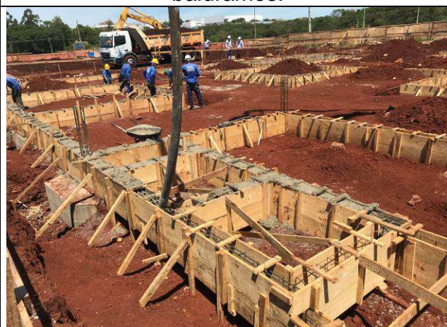
Figura 38C: Concretagem das vigas baldrame.
