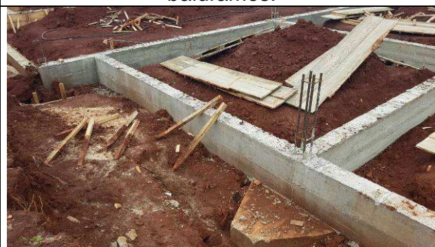
Figura 41C: Vigas baldrames concretadas.
