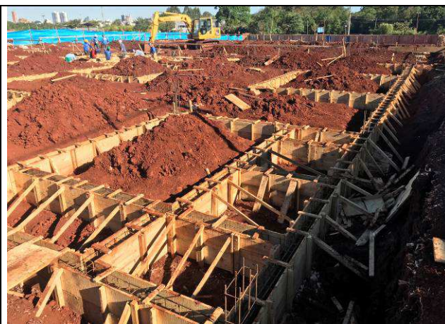
Figura 20C: Formas e armaduras das vigas baldrames.
