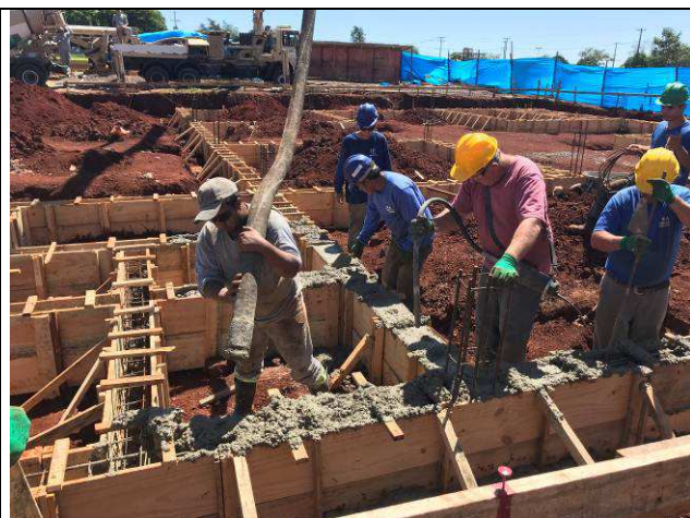
Figura 33C: Concretagem das vigas baldrame.
