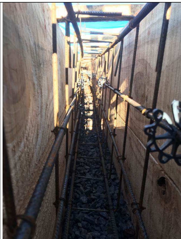
Figura 25C: Formas e armaduras das vigas baldrames.
