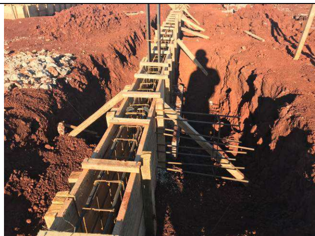
Figura 23C: Formas e armaduras das vigas baldrames - arranque V73.
