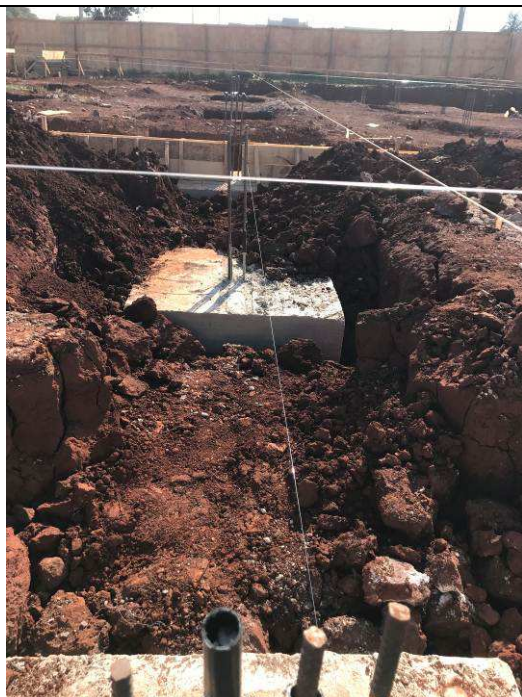
Figura 01C: Escavação das vigas baldrames.
