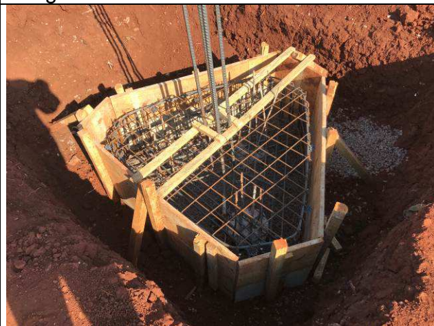
Figura 12C: Formas e armaduras - P73.
