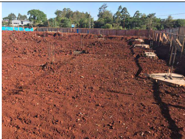
Figura 05C: Escavação das vigas baldrames.
