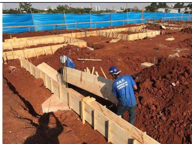
Figura 15C: Montagem das formas das baldrames.
