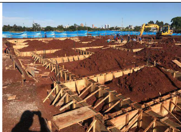
Figura 19C: Formas e armaduras das vigas baldrames.
