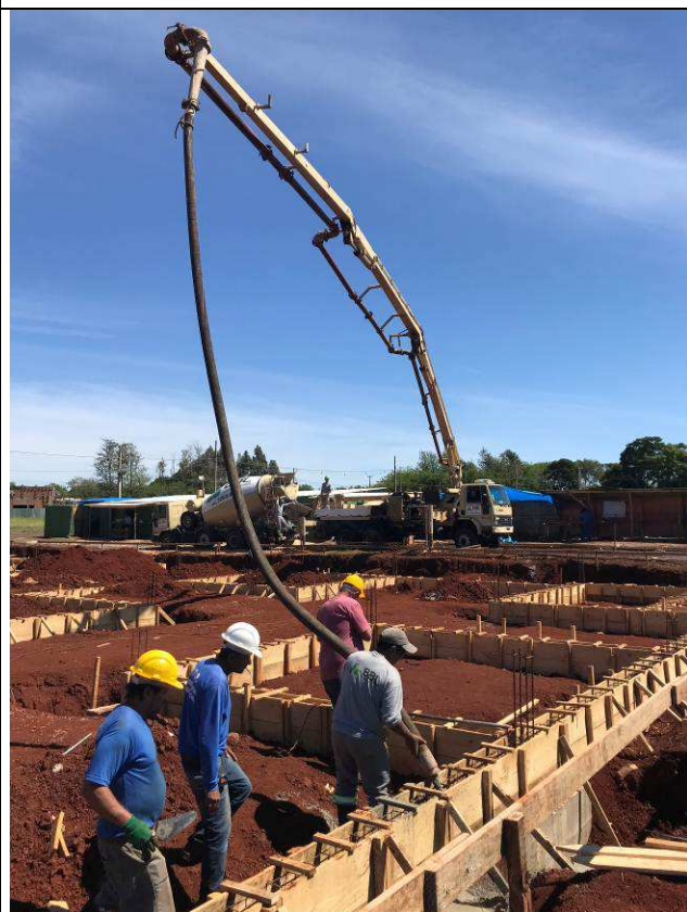
Figura 31C: Concretagem das vigas baldrames.
