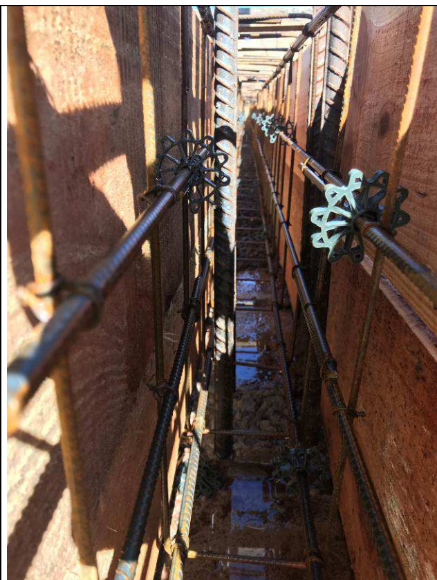
Figura 26C: Formas e armaduras das vigas baldrames.
