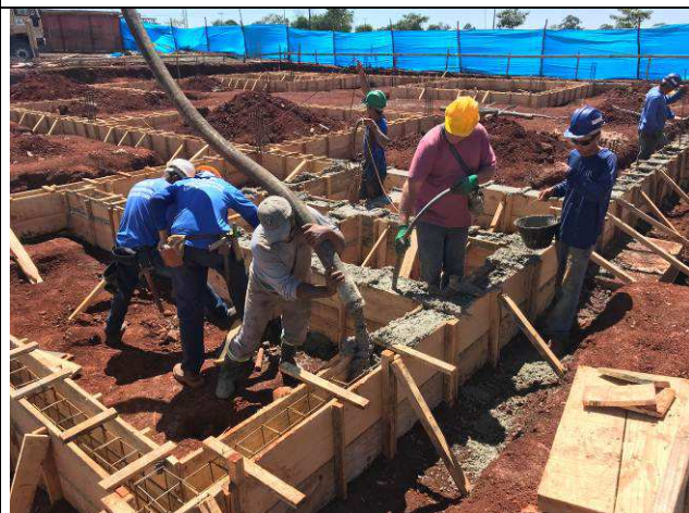
Figura 36C: Concretagem das vigas baldrame.
