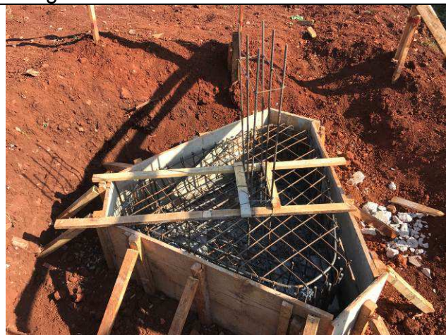
Figura 11C: Formas e armaduras - P75.
