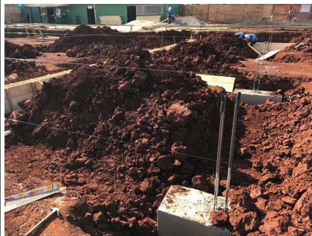
Figura 02C: Escavação das vigas baldrames.
