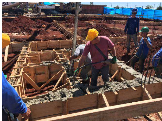
Figura 34C: Concretagem das vigas baldrame.
