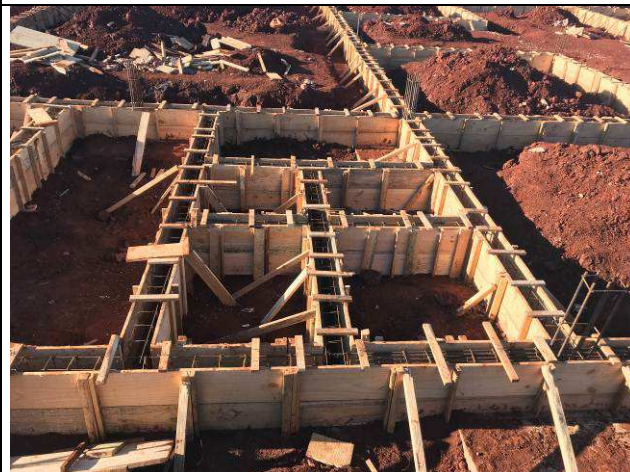
Figura 22C: Formas e armaduras das vigas baldrames.
