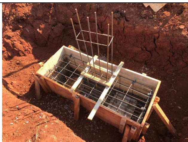
Figura 08C: Formas e armaduras - P41.
