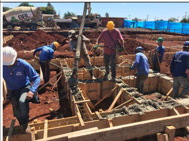
Figura 35C: Concretagem das vigas baldrame.
