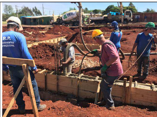
Figura 29C: Concretagem das vigas baldrames.
