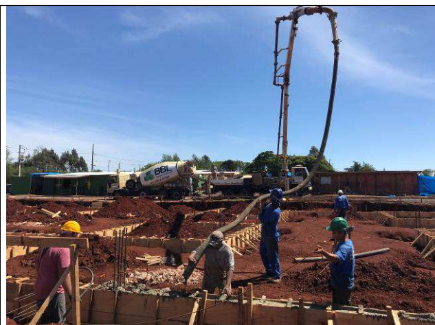
Figura 30C: Concretagem das vigas baldrames.
