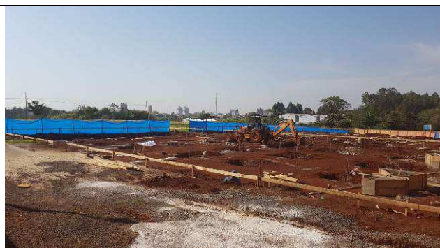
Figura 03C: Escavação das vigas baldrames com retroescavadeira.
