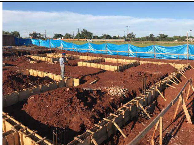
Figura 21C: Formas e armaduras das vigas baldrames.
