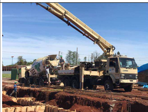
Figura 27C: Concretagem das vigas baldrames.
