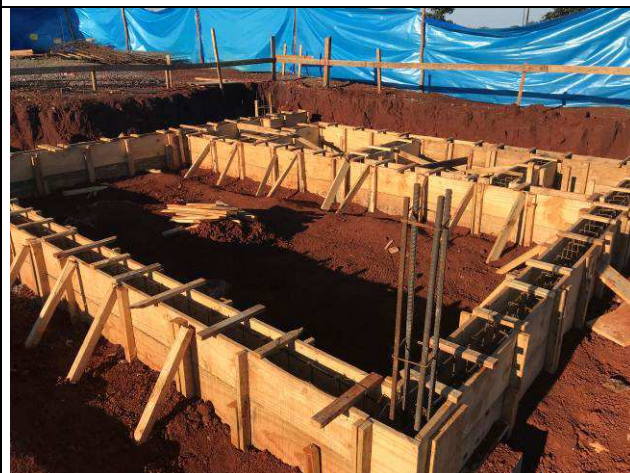
Figura 24C: Formas e armaduras das vigas baldrames.
