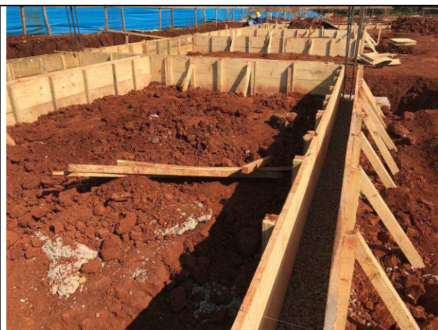
Figura 16C: Montagem das formas das baldrames.
