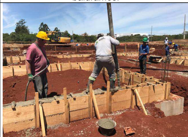
Figura 37C: Concretagem das vigas baldrame.
