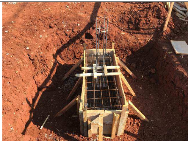
Figura 09C: Formas e armaduras - P57.
