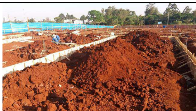
Figura 04C: Escavação das vigas baldrames.
