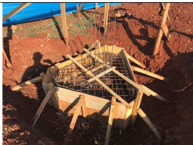
Figura 13C: Formas e armaduras - P80.
