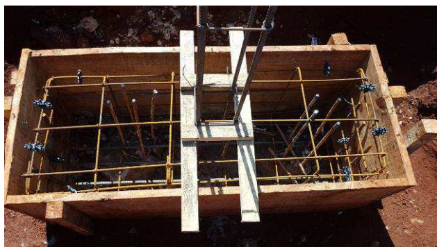
Figura 46C: Montagem das formas e armaduras dos blocos - bloco B2 - P28.
