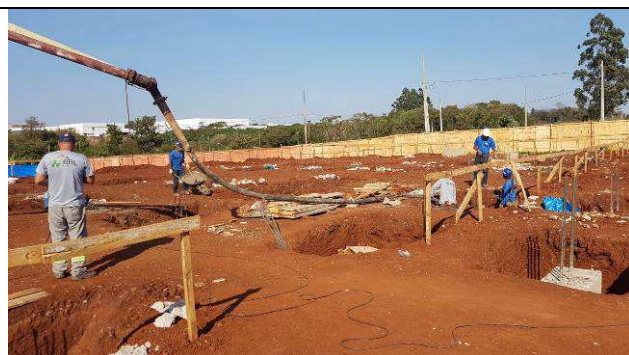
Figura 60C: Concretagem dos blocos com bomba lança de concreto.
