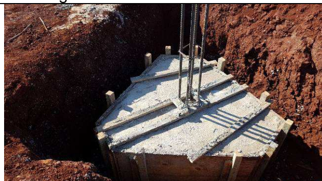
Figura 66C: Blocos concretados.
