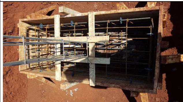
Figura 58C: Montagem das formas e armaduras dos blocos - bloco B3 - P40.
