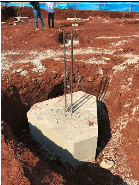
Figura 67C: Blocos concretados.
