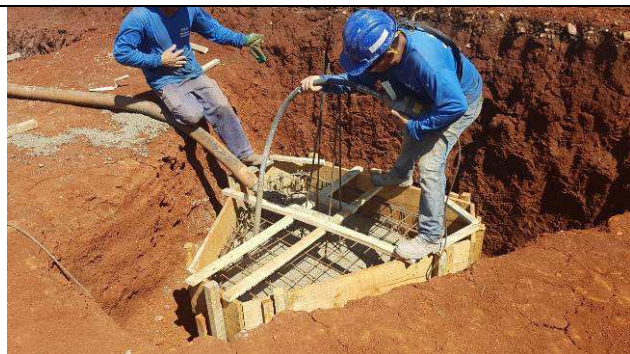
Figura 61C: Concretagem dos blocos.
