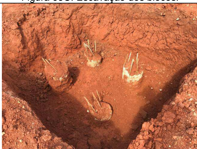
Figura 11C: Escavação dos blocos.
