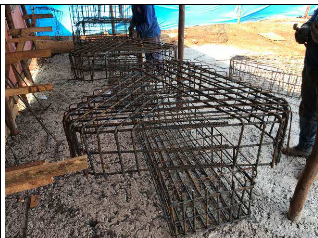
Figura 25C: Montagem das armaduras dos blocos - blocos B5 - 3Ø30cm.
