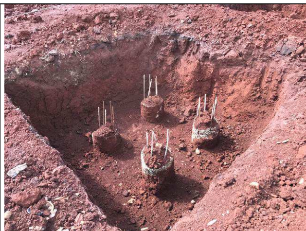
Figura 04C: Escavação dos blocos.
