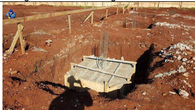
Figura 64C: Blocos concretados.
