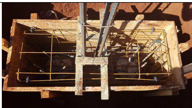
Figura 32C: Montagem das formas e armaduras dos blocos - bloco B2 - P10.
