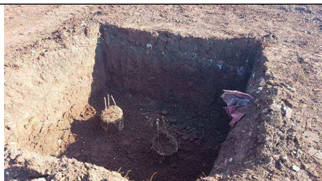
Figura 10C: Escavação dos blocos.
