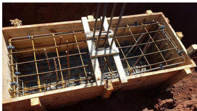
Figura 39C: Montagem das formas e armaduras dos blocos - bloco B3 - P20.
