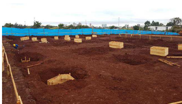
Figura 17C: Montagem de formas dos blocos.
