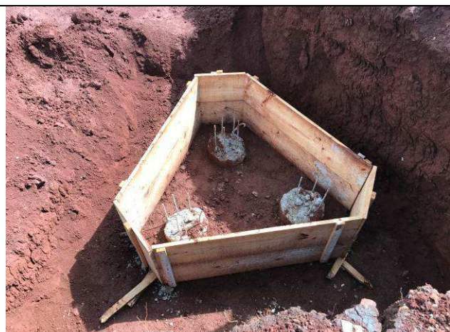
Figura 19C: Montagem de formas dos blocos.
