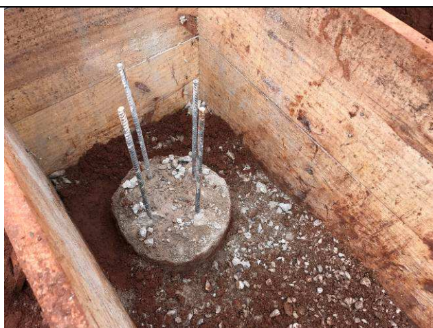
Figura 13C: Corte e arrasamento da cabeça das estacas.
