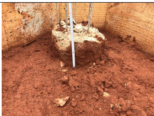
Figura 14C: Corte e arrasamento da cabeça das estacas.
