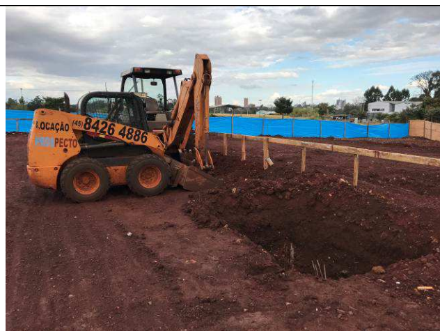
Figura 03C: Escavação dos blocos - mini pá carregadeira e retro escavadeira.
