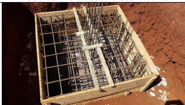
Figura 52C: Montagem das formas e armaduras dos blocos - bloco B6 - P36.
