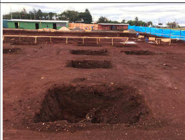
Figura 08C: Escavação dos blocos.
