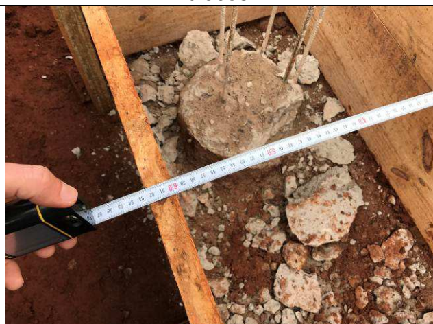
Figura 21C: Montagem de formas dos blocos.
