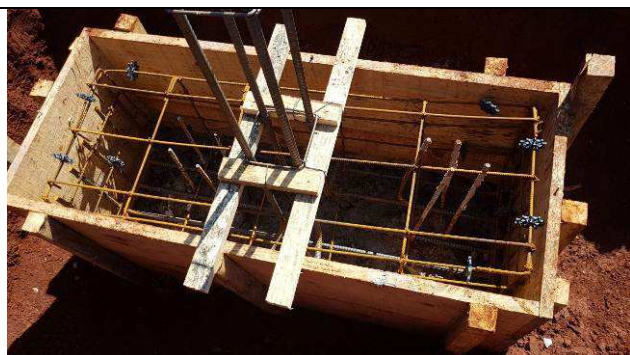
Figura 37C: Montagem das formas e armaduras dos blocos - bloco B2 - P18.
