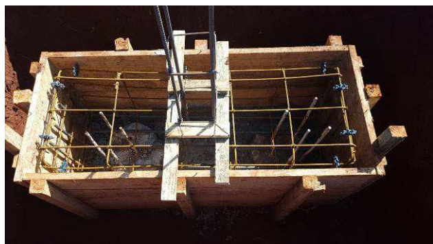
Figura 33C: Montagem das formas e armaduras dos blocos - bloco B2 - P11.
