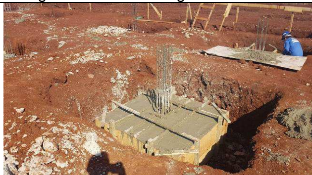
Figura 63C: Blocos concretados.
