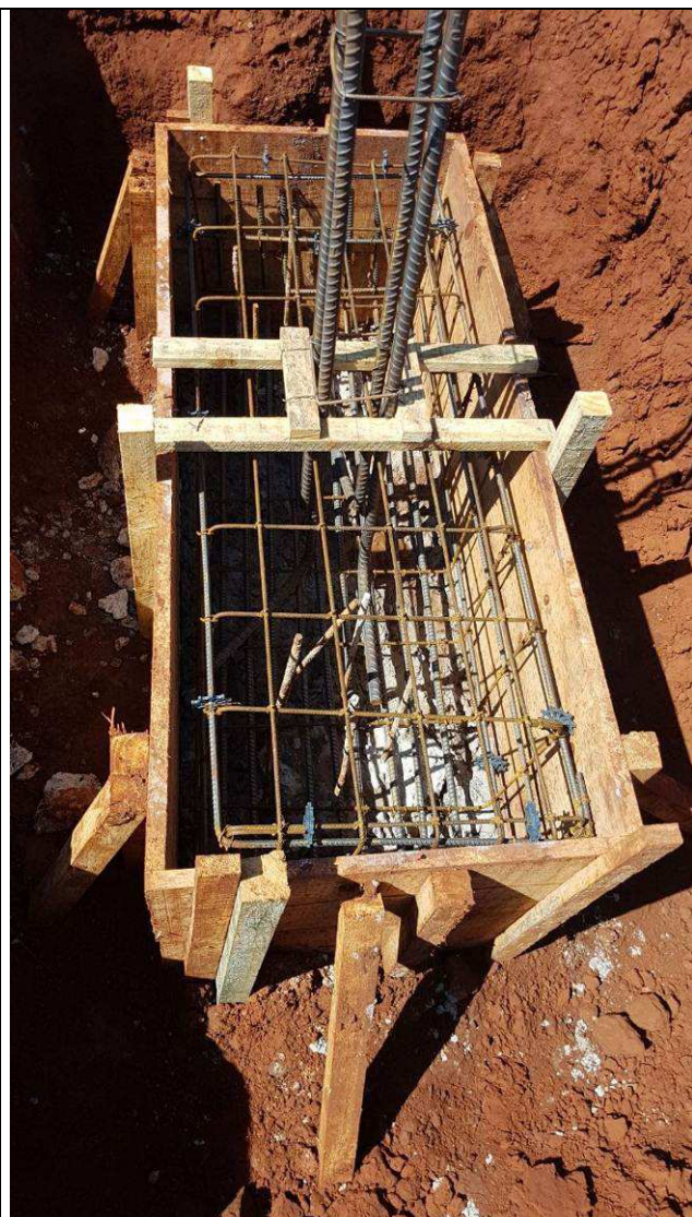
Figura 56C: Montagem das formas e armaduras dos blocos - bloco B3 - P38.
