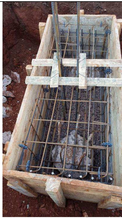
Figura 54C: Conferência das formas e armaduras dos blocos - bloco B3.
