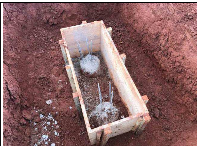
Figura 20C: Montagem de formas dos blocos.
