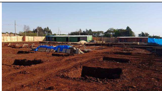
Figura 09C: Escavação dos blocos.
