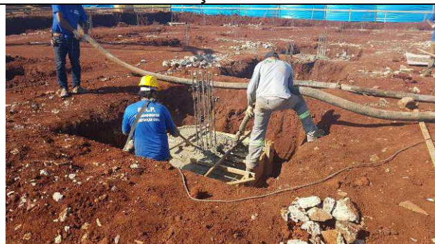
Figura 62C: Concretagem dos blocos.
