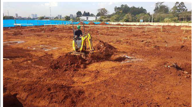
Figura 02C: Escavação dos blocos com utilização de miniescavadeira.
