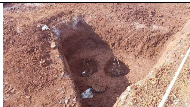
Figura 05C: Escavação dos blocos.
