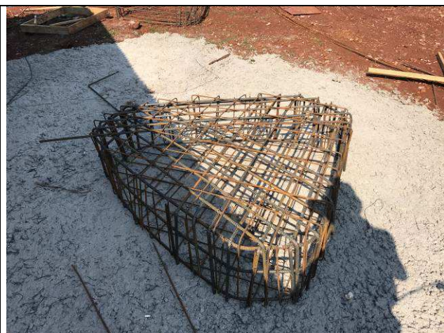
Figura 26C: Montagem das armaduras dos blocos - blocos B5 - 3Ø30cm.
