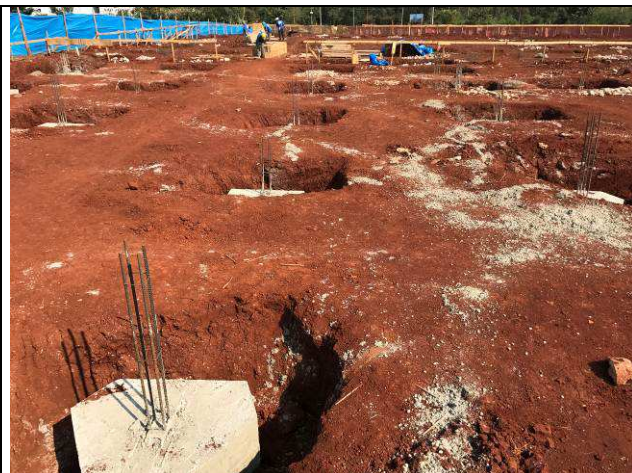
Figura 72C: Blocos concretados.
