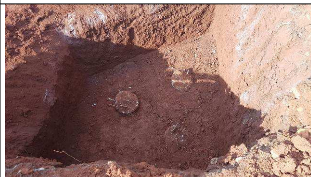
Figura 06C: Escavação dos blocos.
