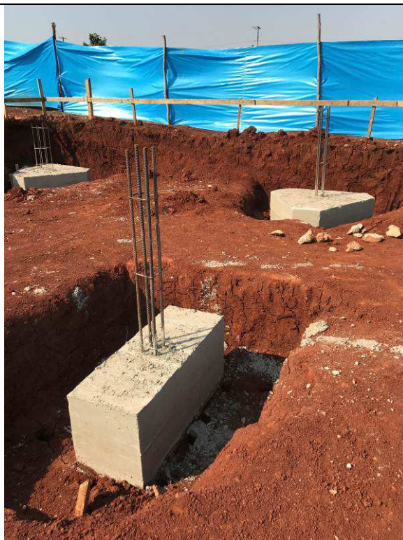
Figura 68C: Blocos concretados.
