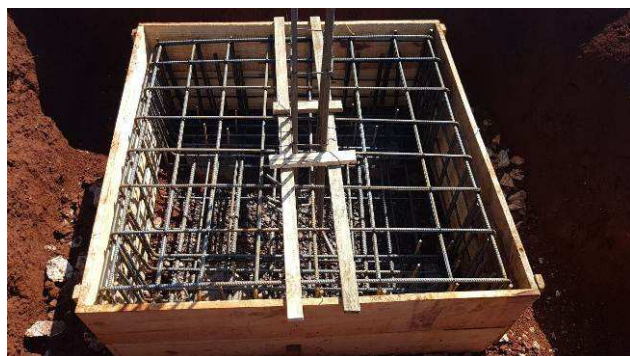
Figura 45C: Montagem das formas e armaduras dos blocos - bloco B6 - P26.
