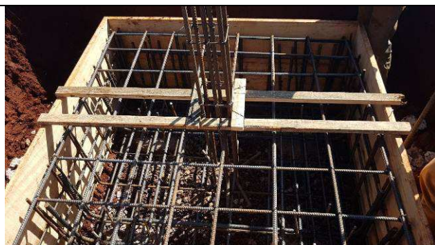
Figura 59C: Montagem das formas e armaduras dos blocos - bloco B6 - P501.
