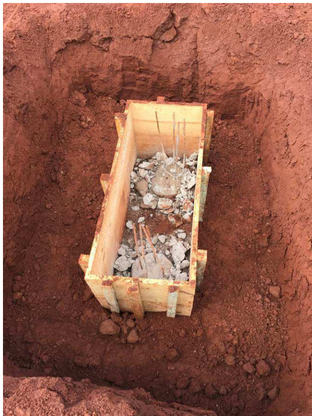
Figura 15C: Corte e arrasamento da cabeça das estacas.
