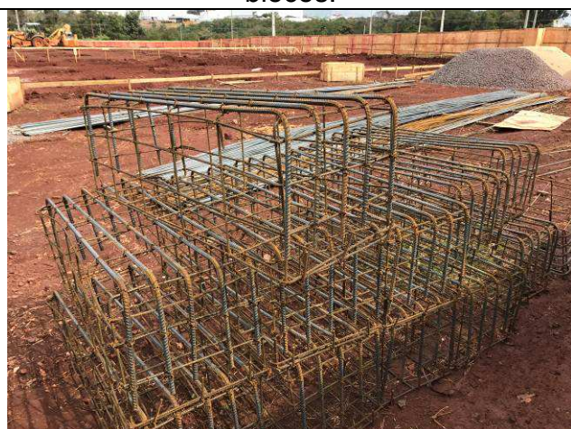
Figura 23C: Montagem das armaduras dos blocos - blocos B2 - 2Ø25cm.
