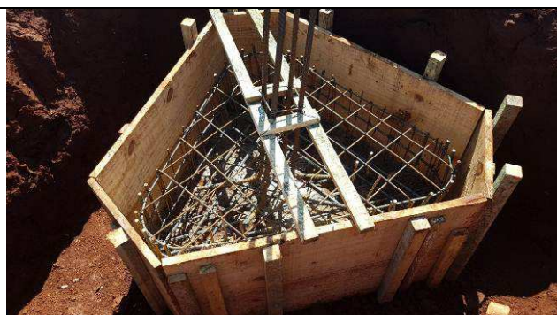
Figura 35C: Montagem das formas e armaduras dos blocos - bloco B4 - P13.
