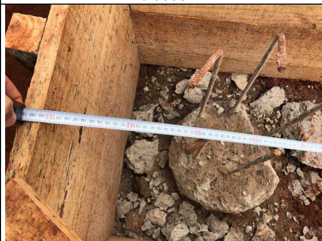
Figura 22C: Montagem de formas dos blocos.
