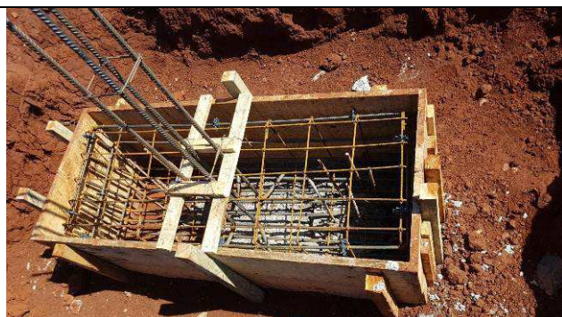
Figura 49C: Montagem das formas e armaduras dos blocos - bloco B3 - P32.
