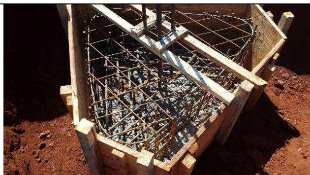
Figura 31C: Montagem das formas e armaduras dos blocos - bloco B4 - P08.
