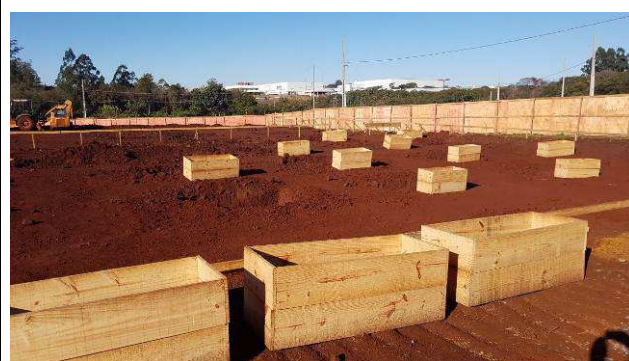
Figura 18C: Montagem de formas dos blocos.
