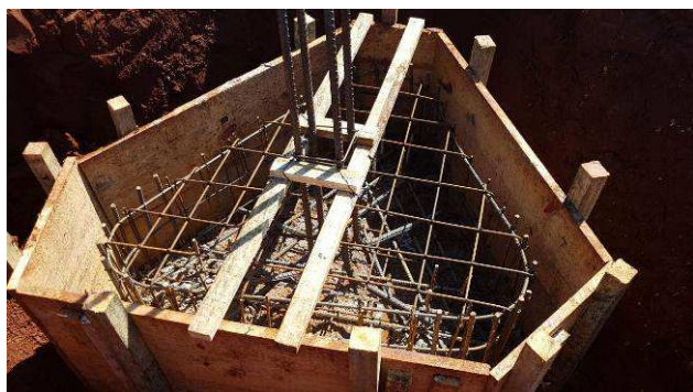
Figura 34C: Montagem das formas e armaduras dos blocos - bloco B4 - P12.
