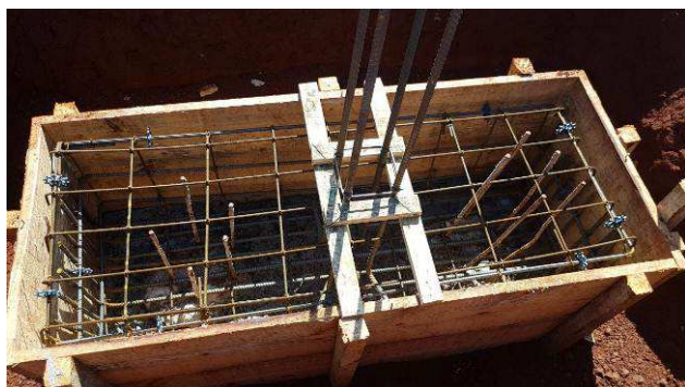
Figura 40C: Montagem das formas e armaduras dos blocos - bloco B3 - P21.
