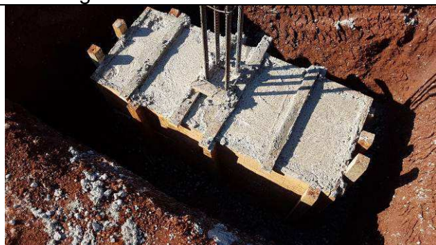
Figura 65C: Blocos concretados.
