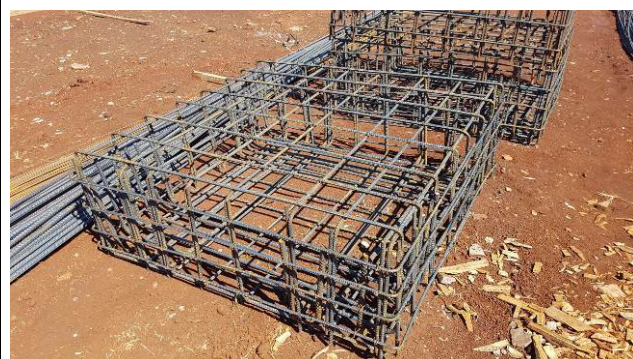
Figura 27C: Montagem das armaduras dos blocos - blocos B6 - 4Ø30cm.
