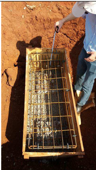
Figura 53C: Conferência das formas e armaduras dos blocos - bloco B3.
