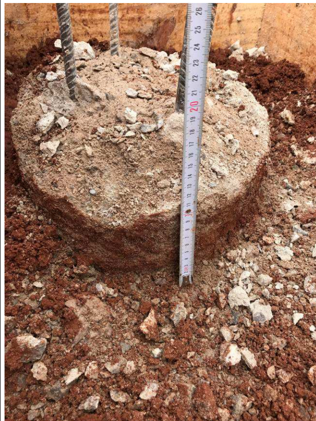
Figura 16C: Corte e arrasamento da cabeça das estacas.
