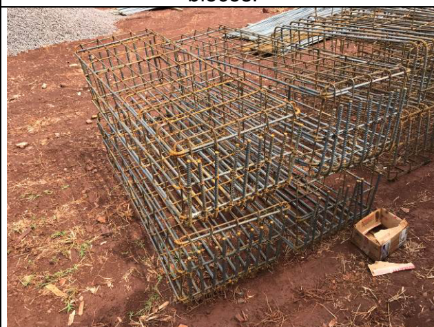
Figura 24C: Montagem das armaduras dos blocos - blocos B3 - 2Ø30cm.
