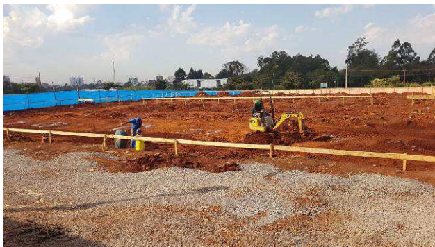
Figura 01C: Escavação dos blocos com utilização de miniescavadeira.
