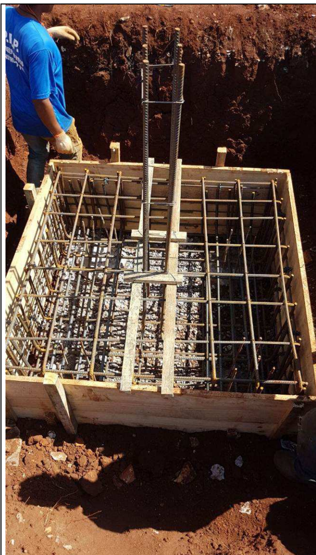
Figura 55C: Montagem das formas e armaduras dos blocos - bloco B6 - P37.
