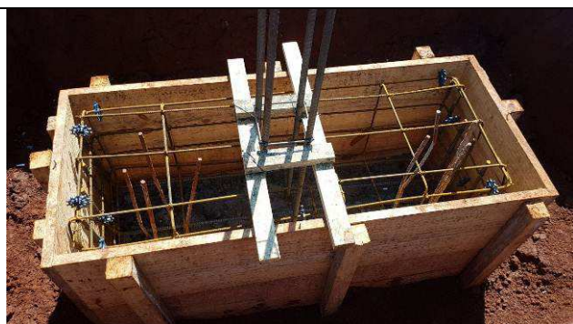
Figura 41C: Montagem das formas e armaduras dos blocos - bloco B2 - P22.
