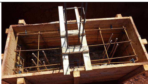
Figura 36C: Montagem das formas e armaduras dos blocos - bloco B2 - P14.
