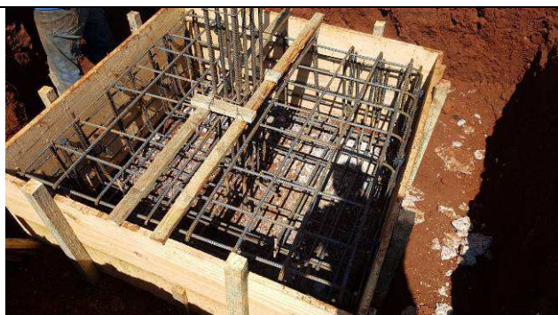
Figura 44C: Montagem das formas e armaduras dos blocos - bloco B6 - P25.
