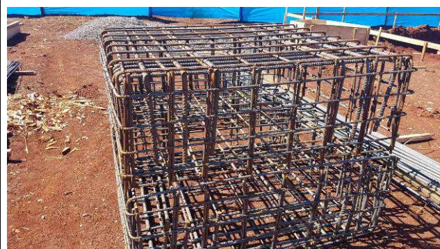
Figura 28C: Montagem das armaduras dos blocos - blocos B6 - 4Ø30cm.
