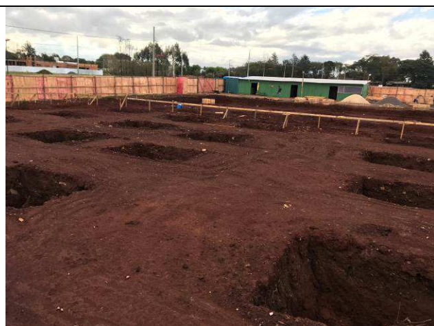
Figura 07C: Escavação dos blocos.
