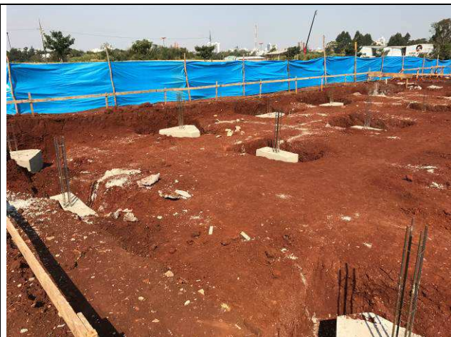
Figura 71C: Blocos concretados.
