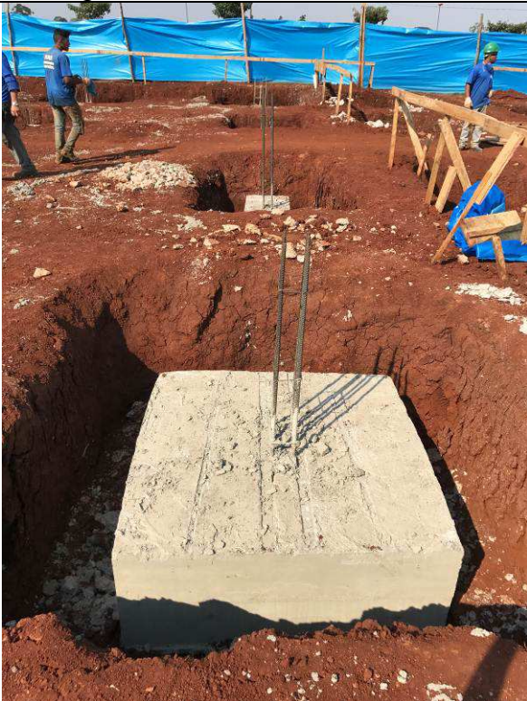
Figura 69C: Blocos concretados.
