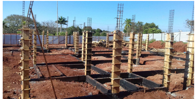
Figura 3: Fôrmas dos pilares, já com concretagem finalizada - região da copa e sanitários
