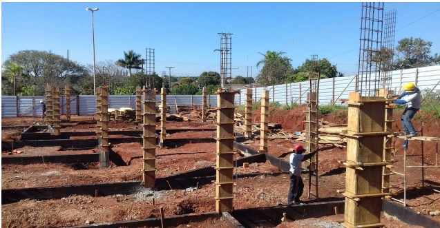
Figura 2: Fôrmas dos pilares, já com concretagem finalizada - região do arquivo e parte da secretaria
