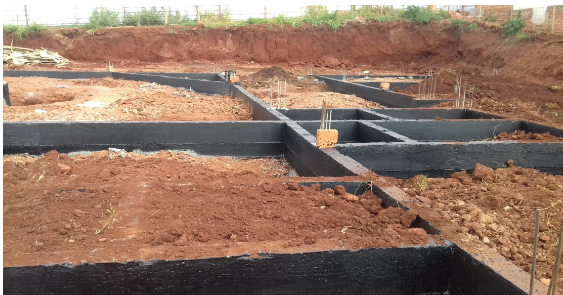
Figura 7: Vigas Bandrames após duas demãos de impermeabilizante - Neutrol
