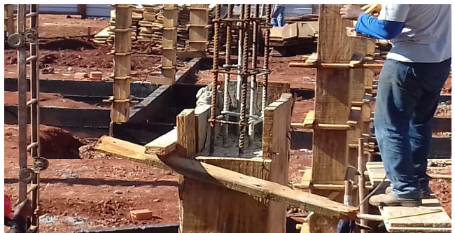
Figura 5: Detalhe de pilar concretado - Fôrma, armadura e concreto
