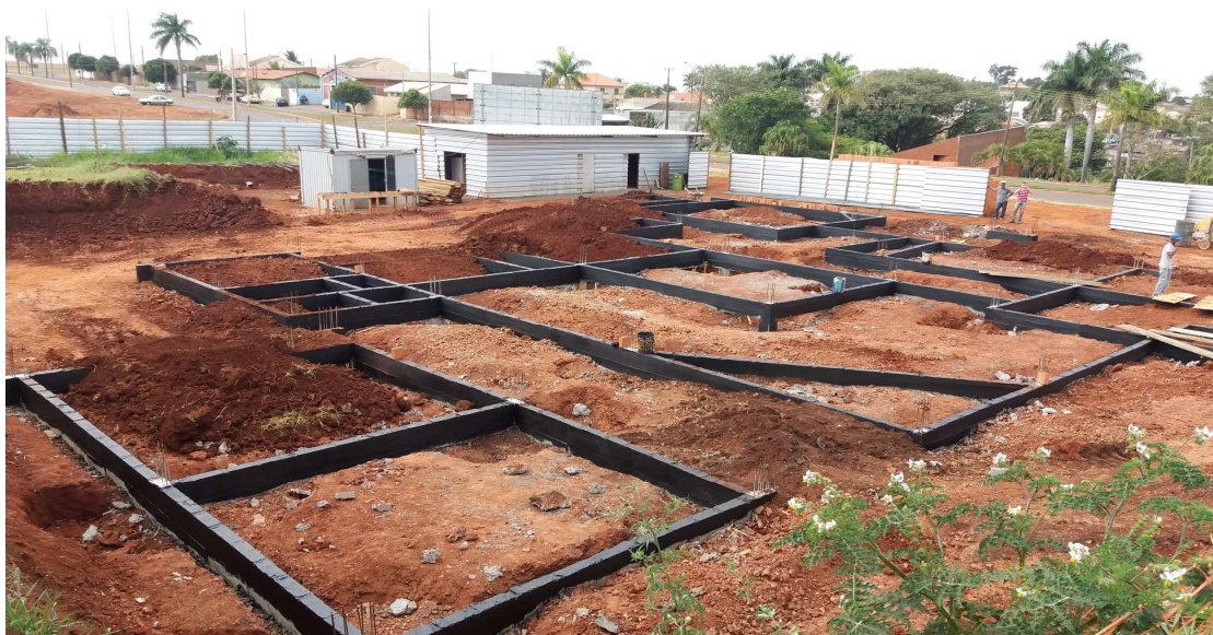
Figura 8: Vigas Bandrames após duas demãos de impermeabilizante - Neutrol
