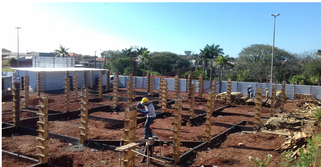
Figura 6: Vista geral da obra - operário iniciando os serviços de preparo do topo da fôrma de pilar, para receber fôrma das vigas
