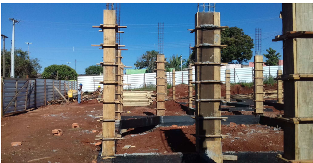
Figura 4: Fôrmas dos pilares, já com concretagem finalizada - região do PAB
