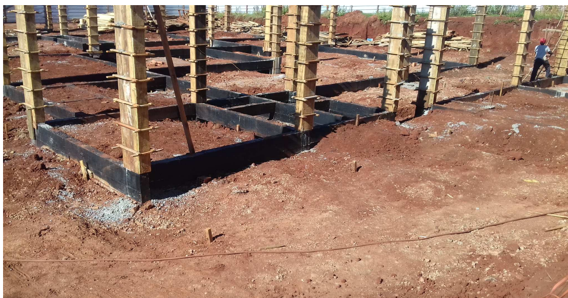
Figura 9: Detalhe do fechamento das valas abertas para execução das sapatas
