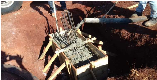
Figura 19: Realização de concretagem de um bloco, mediante uso de bomba
