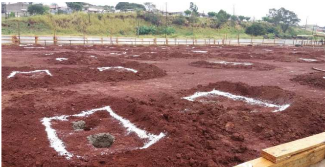
Figura 1: Marcação da geometria dos blocos no terreno, para facilitar a abertura das valas
