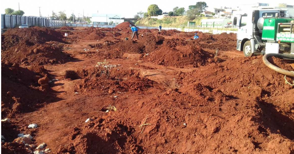
Visão geral da obra do FT de Apucarana.
