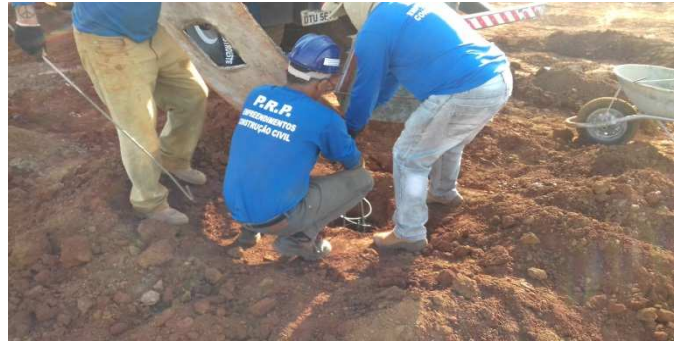
Figura 10: Realização da concretagem de uma estaca, através da bica móvel do caminhão
