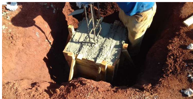
Figura 22: Bloco de fundação, tamanho 55x55x50cm, já concretado
