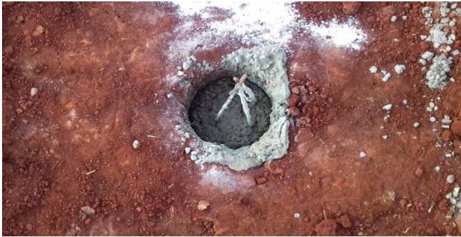
Figura 9: Estaca armada e já concretada
