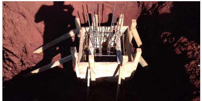
Figura 18: Fôrma de bloco tamanho 55x55x50cm, já com armaduras e arranque instalados
