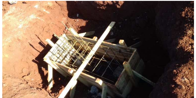
Figura 4: Fôrmas dos blocos sendo montadas nas valas
