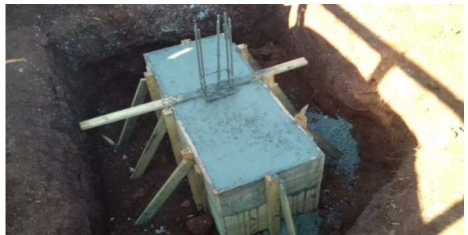
Figura 20: Bloco de fundação, tamanho 135x55x50cm, já concretado
