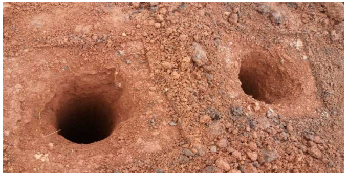
Figura 8: Par de brocas já perfuradas em local destinado a bloco com tamanho de 130x55x50cm
