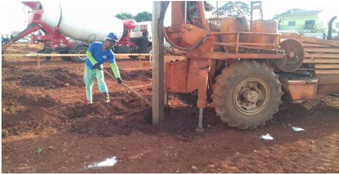
Figura 5: Perfuração de estacas no interior do fórum, com uso de perfuratriz motorizada
