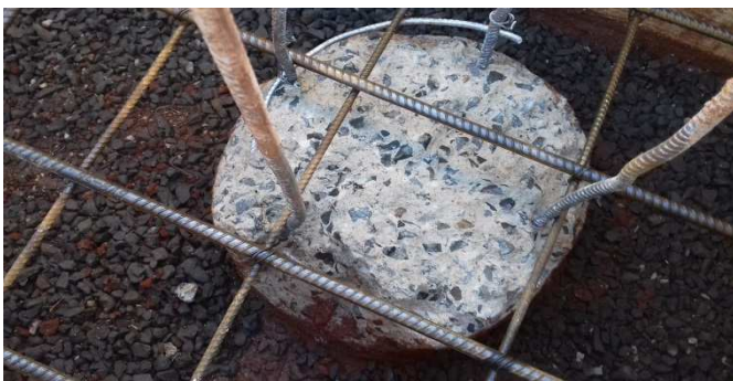
Figura 13: Detalhe do arrasamento da cabeça de uma estaca
