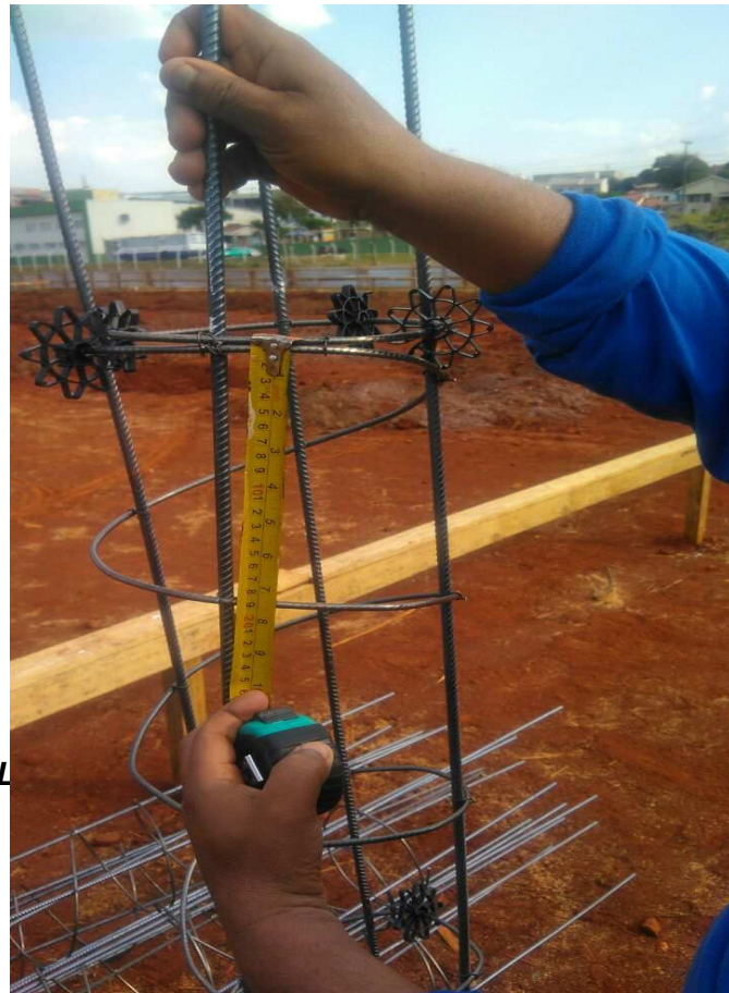
Figura 7: Aferição dos estribos de uma estaca, antes de sua colocação para concretagem
