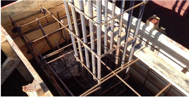
Figura 15: Fôrma de bloco tamanho 130x55x50cm, já com armaduras e arranque instalados
