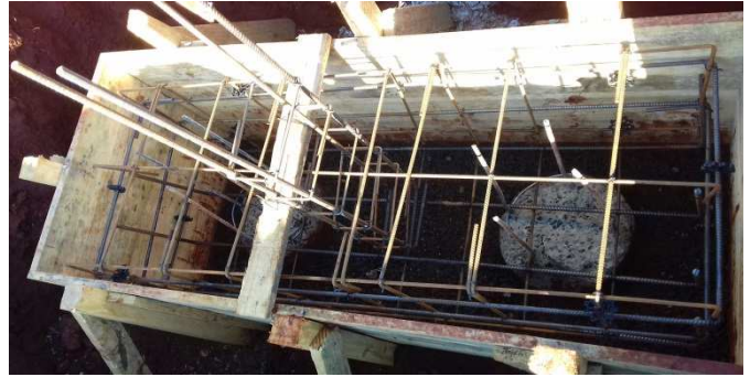
Figura 16: Fôrma de bloco tamanho 130x55x50cm, já com armaduras e arranque instalados
