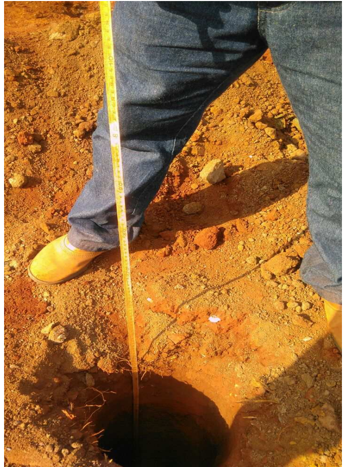
Figura 6: Aferição da profundidade de uma broca, mediante uso de trena com "peso" na ponta
