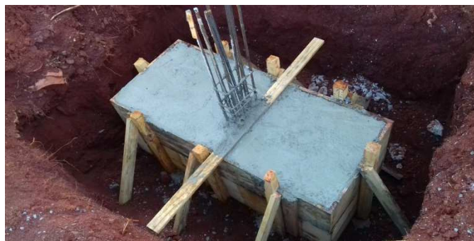
Figura 21: Bloco, tamanho 135x55x50cm, já concretado e com superfície sarrafeada
