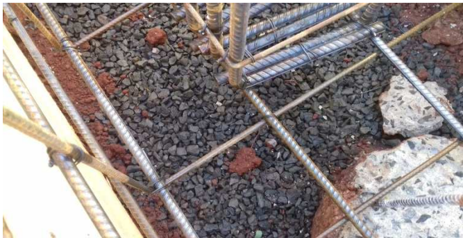
Figura 17: Detalhe do lastro de brita lançado e compactado no fundo de um bloco
