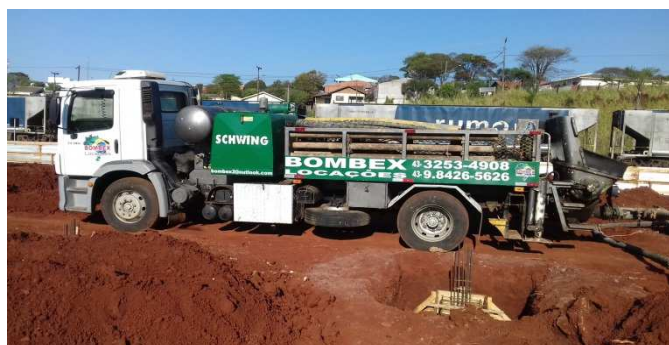
Figura 23: Bomba de concretagem utilizada
