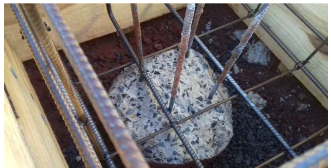
Figura 14: Detalhe do arrasamento da cabeça de uma estaca
