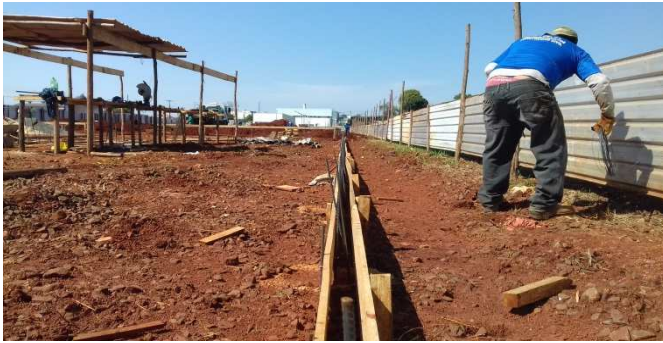
Figura 25: Estacas concretadas nos locais onde serão executados muros de alvenaria Figura 26: Corpos-de-prova
