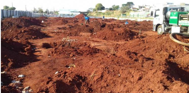
Figura 3: Valas abertas e processo de montagem das fôrmas dos blocos
