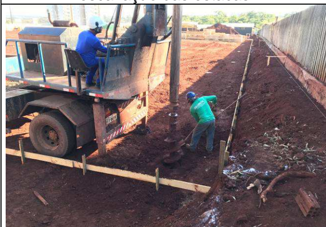
Figura 43C: Perfuração das estacas - prédio principal.
