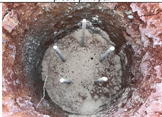
Figura 63C: Estacas concretadas - prédio principal.
