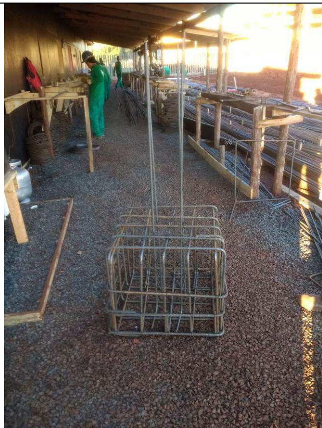
Figura 79C: Blocos - armaduras - arquivo.
