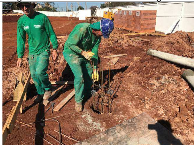
Figura 95C: Montagem das armaduras nas estacas - guarita.
