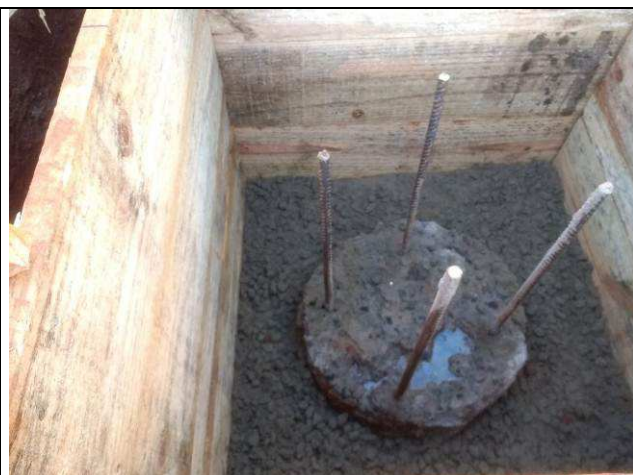
Figura 76C: Preparação das cabeças das estacas - arquivo.
