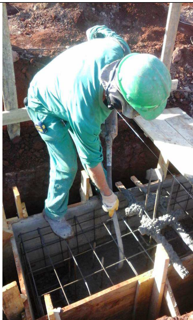
Figura 85C: Blocos - concretagem - arquivo.
