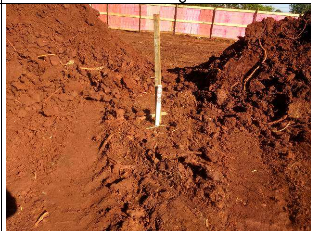
Figura 28C: Estaqueamento para marcação dos níveis dos platôs.
