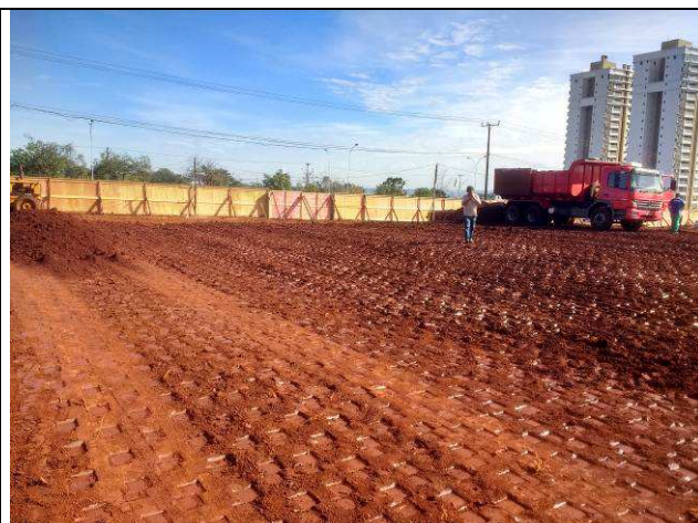
Figura 32C: Execução da terraplenagem do platô do prédio principal.
