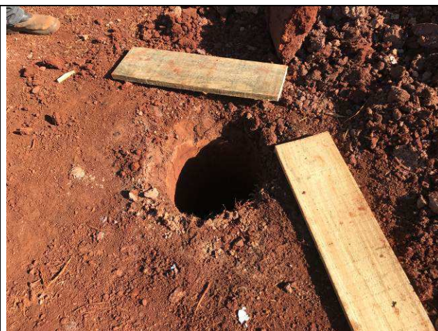
Figura 94C: Estacas escavadas - guarita.
