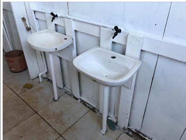
Figura 04C: Barracão de obra - sanitários.
