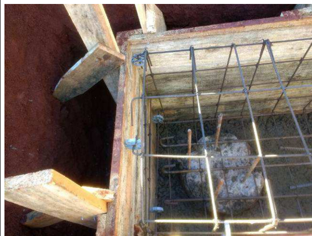
Figura 82C: Blocos - armaduras - arquivo.
