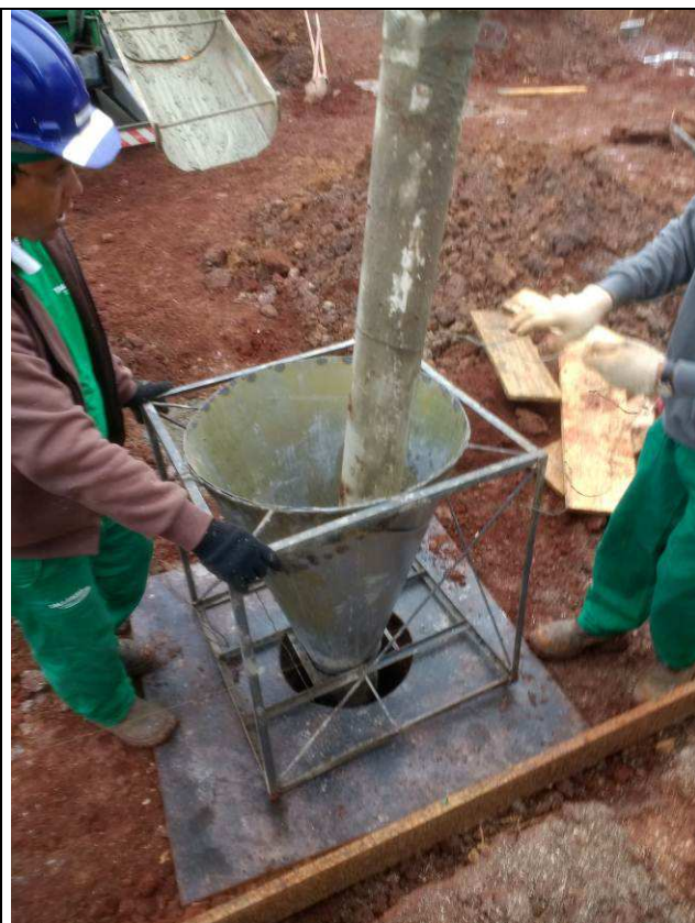
Figura 72C: Concretagem das estacas - arquivo.
