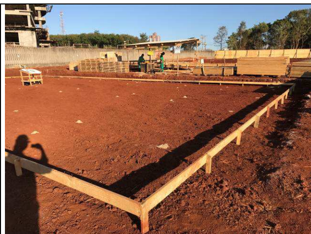
Figura 20C: Gabarito de locação da obra - arquivo.
