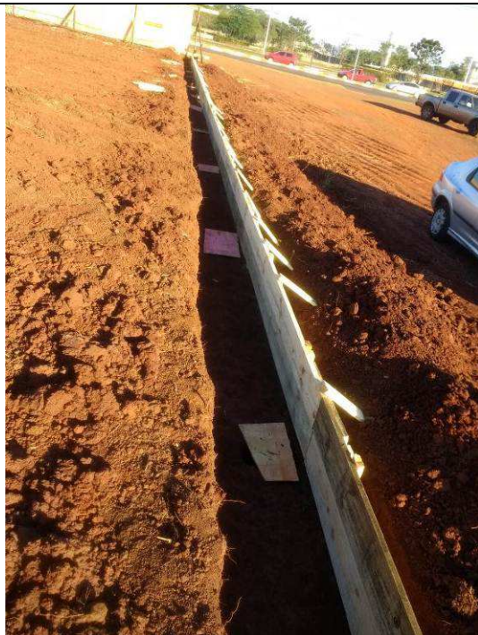
Figura 101C: Viga baldrame - formas - muro de fechamento.
