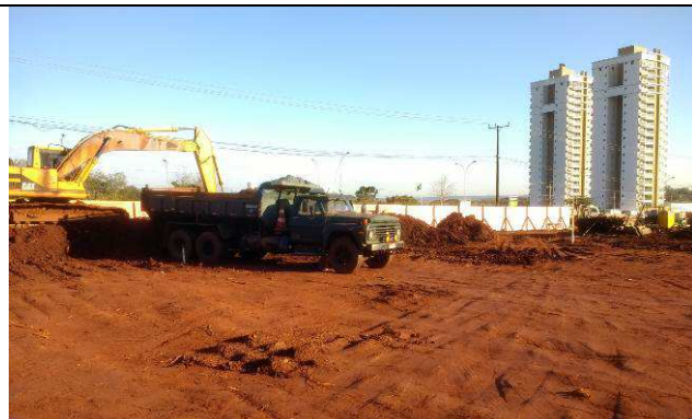
Figura 25C: Término da remoção da camada vegetal.
