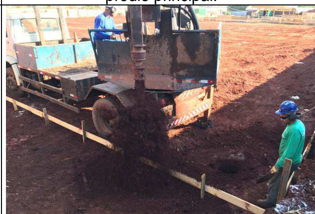
Figura 46C: Perfuração das estacas - prédio principal.
