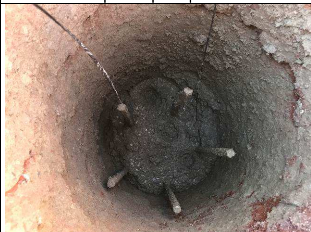
Figura 62C: Estacas concretadas - prédio principal.
