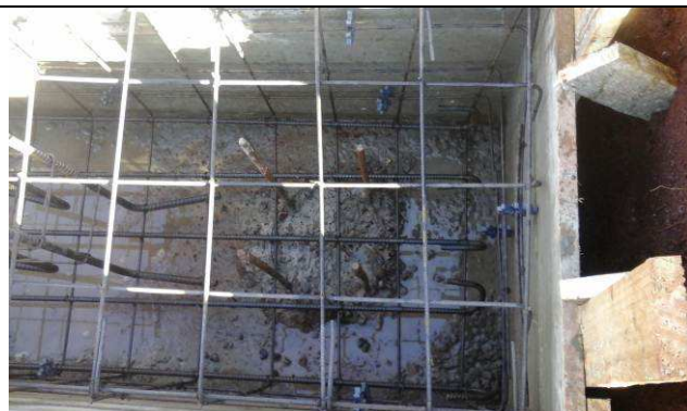
Figura 83C: Blocos - armaduras - arquivo.
