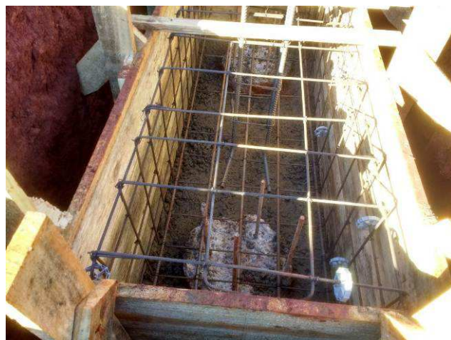
Figura 81C: Blocos - armaduras - arquivo.
