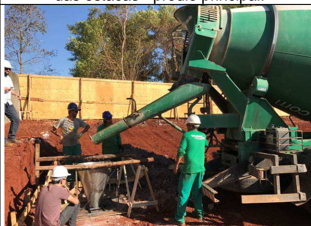
Figura 58C: Concretagem das estacas - prédio principal.
