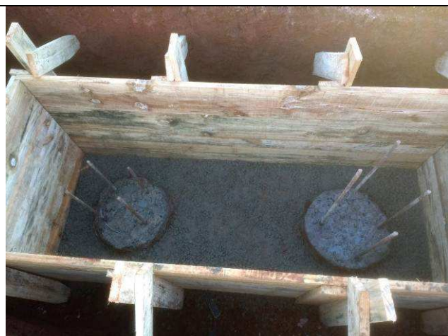
Figura 75C: Preparação das cabeças das estacas - arquivo.
