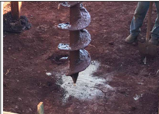
Figura 42C: Posicionamento da broca sobre o piquete de locação da estaca.
