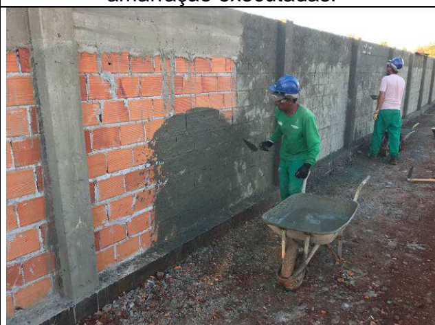
Figura 112C: Execução do chapisco - muro de fechamento.
