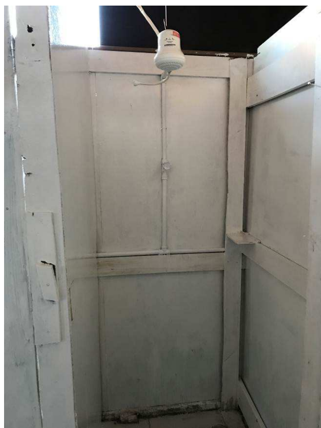
Figura 05C: Barracão de obra - sanitários.
