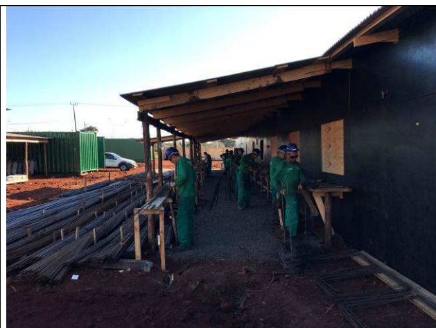
Figura 08C: Barracão de obra - depósito - montagem armaduras.
