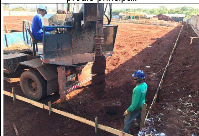
Figura 45C: Perfuração das estacas - prédio principal.
