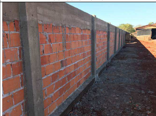
Figura 110C: Alvenaria, pilaretes e viga de amarração executadas.
