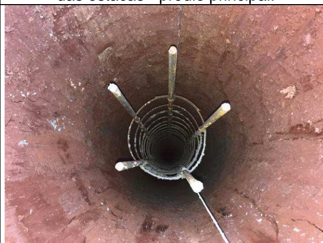
Figura 56C: Posicionamento das armaduras das estacas - prédio principal.
