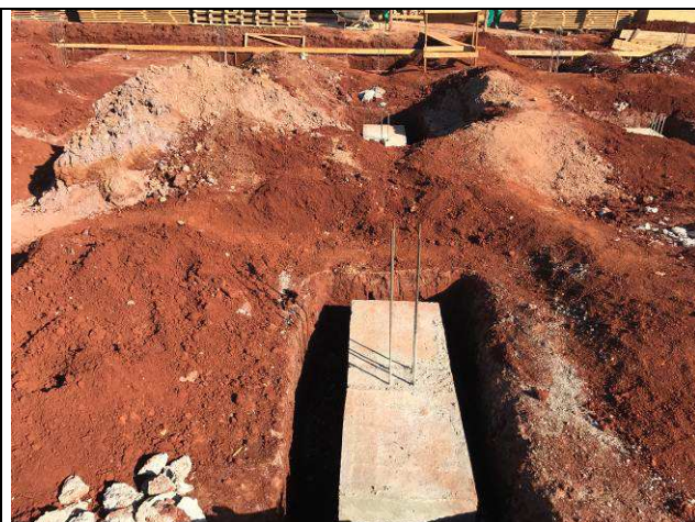
Figura 88C: Blocos - armaduras - arquivo.
