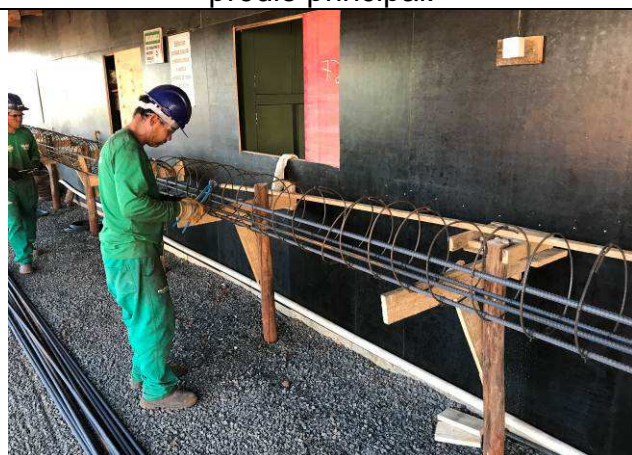
Figura 51C: Montagem das armaduras das estacas - prédio principal.
