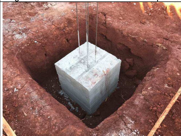
Figura 91C: Blocos concretados - arquivo.
