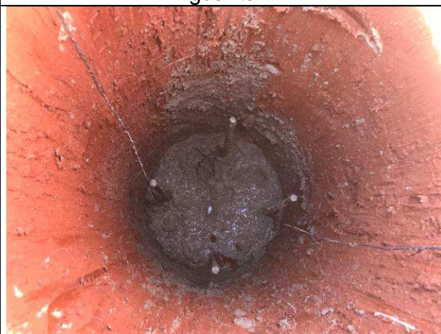
Figura 98C: Estacas concretadas - guarita.
