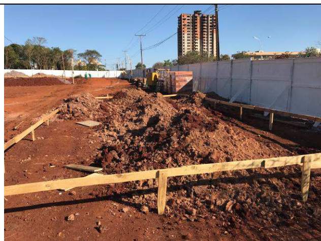
Figura 93C: Estacas escavadas - guarita.
