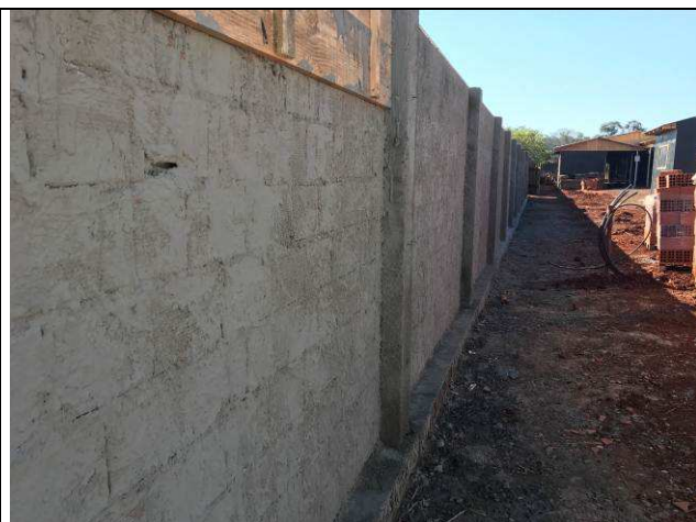
Figura 113C: Chapisco executado - face interna - muro de fechamento.
