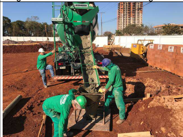
Figura 96C: Concretagem das estacas - guarita.
