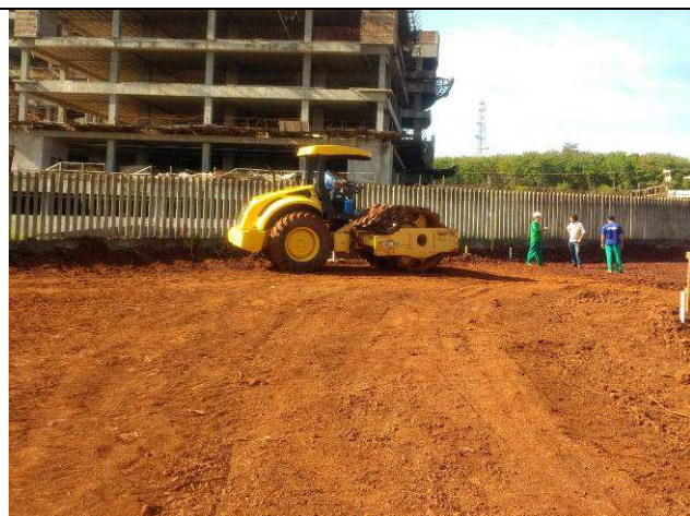
Figura 31C: Execução da terraplenagem do platô do prédio principal.
