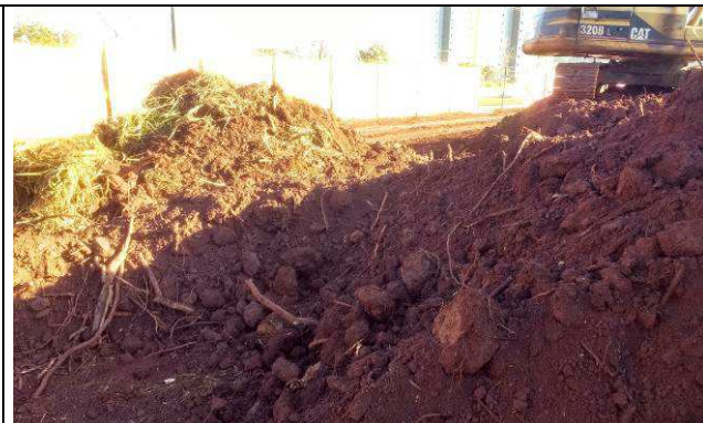
Figura 26C: Término da remoção da camada vegetal.
