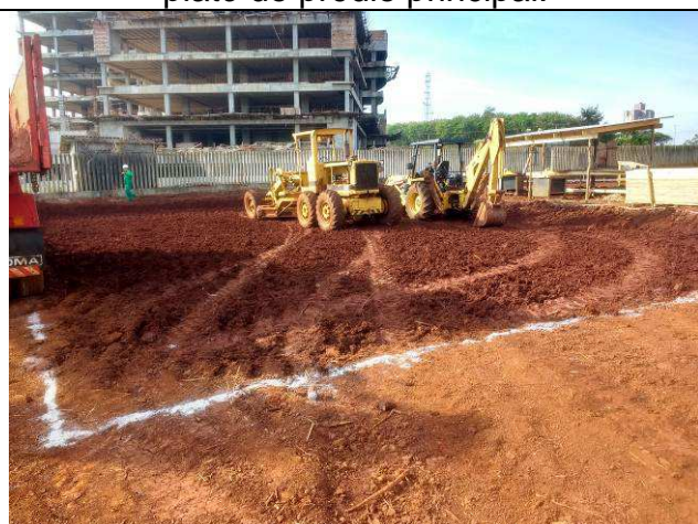
Figura 35C: Execução da terraplenagem do platô do arquivo.
