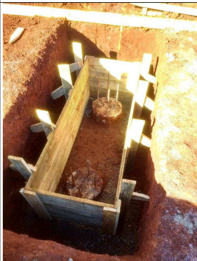
Figura 78C: Blocos - forma de madeira - arquivo.
