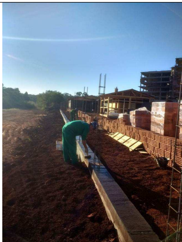
Figura 105C: Viga baldrame - impermeabilização - muro de fechamento.
