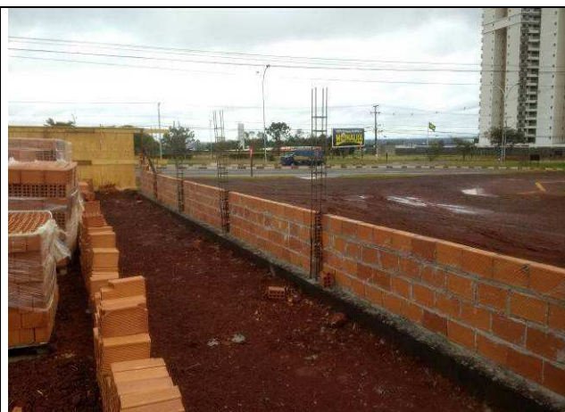
Figura 107C: Execução da alvenaria - muro de fechamento.
