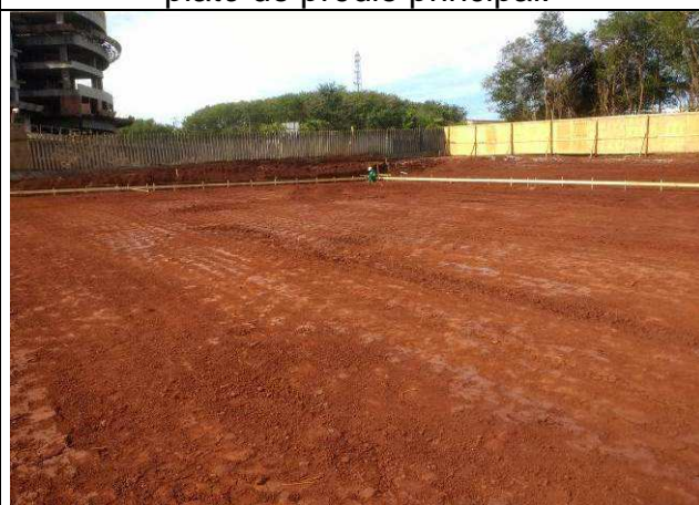
Figura 34C: Terraplenagem do platô do prédio principal executada.
