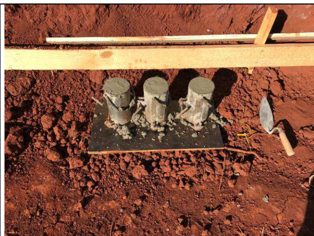
Figura 66C: Controle tecnológico do concreto - prédio principal.
