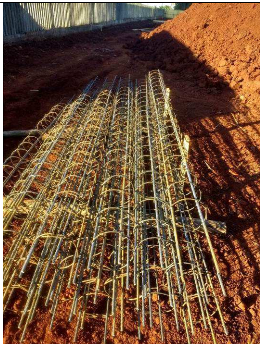
Figura 99C: Estacas - armaduras - muro de fechamento.
