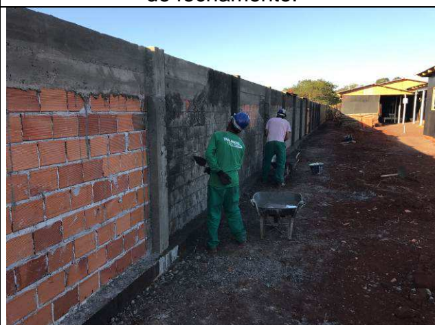
Figura 111C: Execução do chapisco - muro de fechamento.
