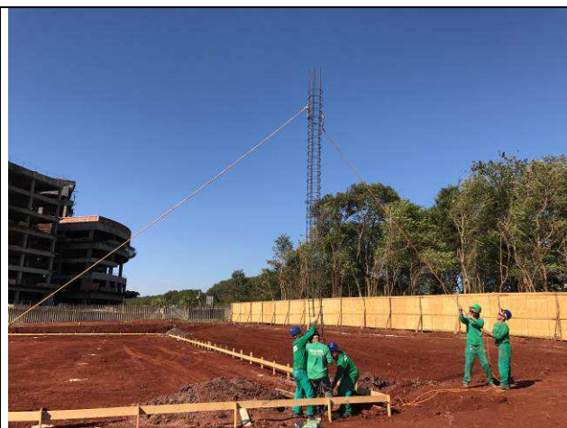
Figura 54C: Posicionamento das armaduras das estacas - prédio principal.
