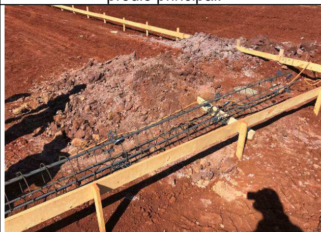
Figura 52C: Armaduras das estacas com espaçadores - prédio principal.
