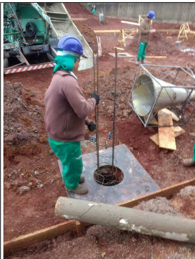
Figura 71C: Montagem da armação das estacas - arquivo.
