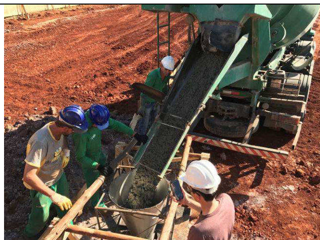
Figura 59C: Concretagem das estacas - prédio principal.
