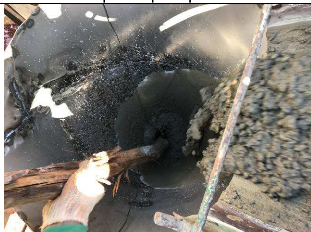
Figura 61C: Concretagem das estacas - prédio principal.
