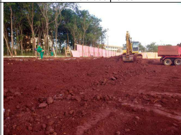
Figura 30C: Execução da terraplenagem do platô do prédio principal.
