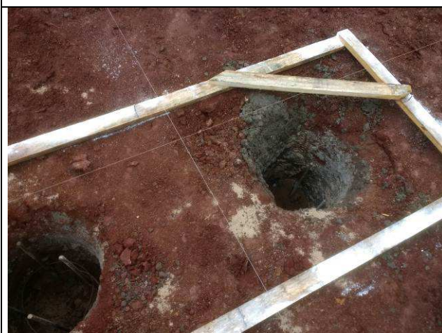
Figura 73C: Estacas concretadas - arquivo.
