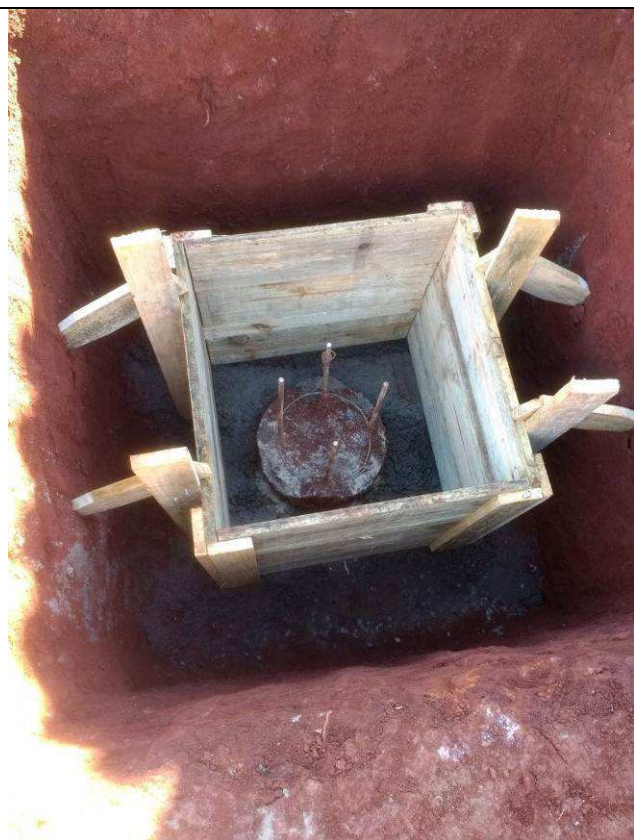
Figura 77C: Blocos - forma de madeira - arquivo.
