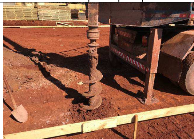
Figura 68C: Perfuração das estacas - arquivo.
