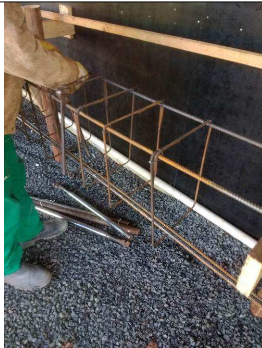
Figura 102C: Viga baldrame - montagem das armaduras - muro de fechamento.
