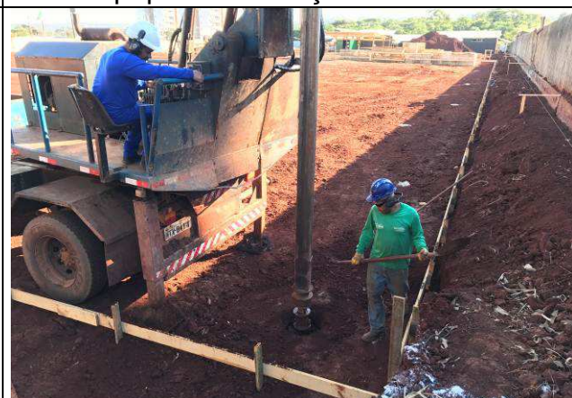
Figura 44C: Perfuração das estacas - prédio principal.
