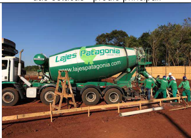
Figura 57C: Concretagem das estacas - prédio principal.
