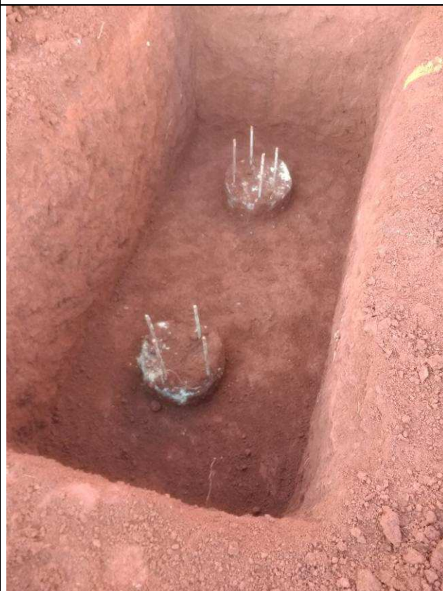
Figura 40C: Escavações para os blocos - arquivo.
