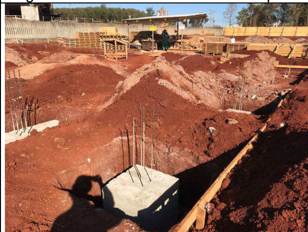
Figura 90C: Blocos concretados - arquivo.
