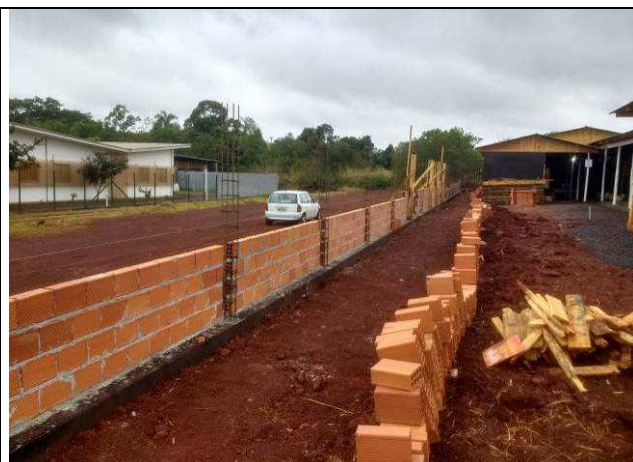
Figura 108C: Execução da alvenaria - muro de fechamento.
