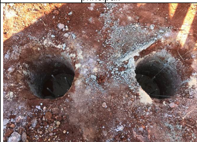
Figura 64C: Estacas concretadas - prédio principal.
