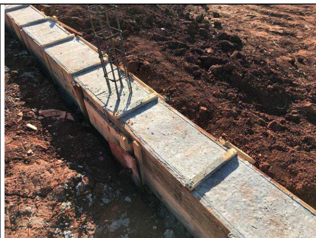
Figura 104C: Viga baldrame - concretada - muro de fechamento.
