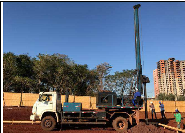
Figura 41C: Equipamento utilizado para escavação das estacas.
