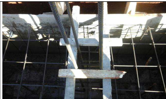
Figura 84C: Blocos - armaduras - arquivo.
