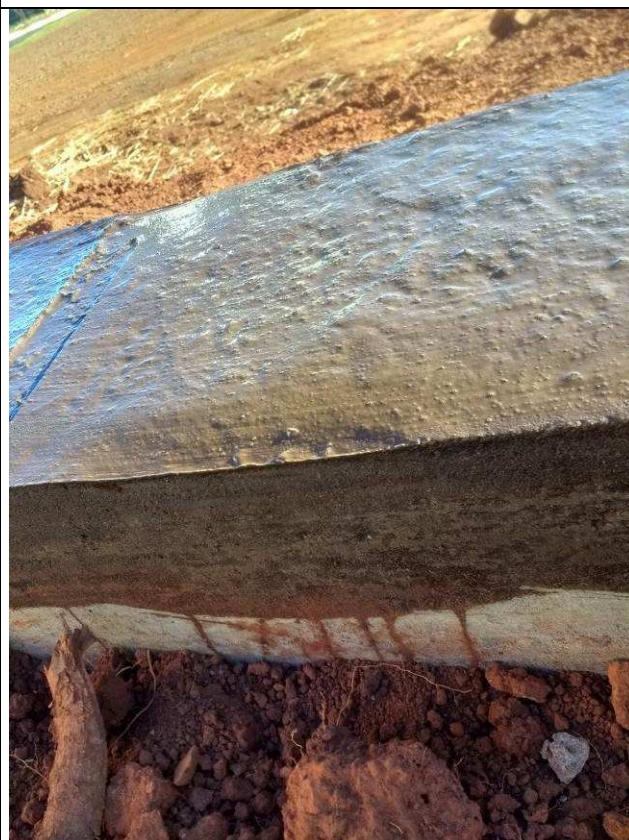
Figura 106C: Viga baldrame - impermeabilização - muro de fechamento.
