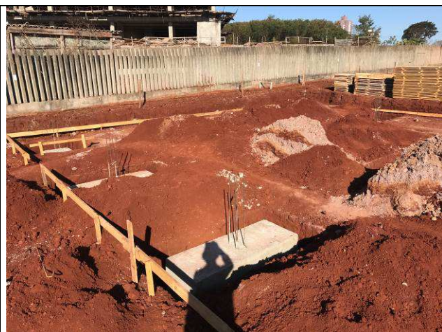
Figura 87C: Blocos concretados - arquivo.
