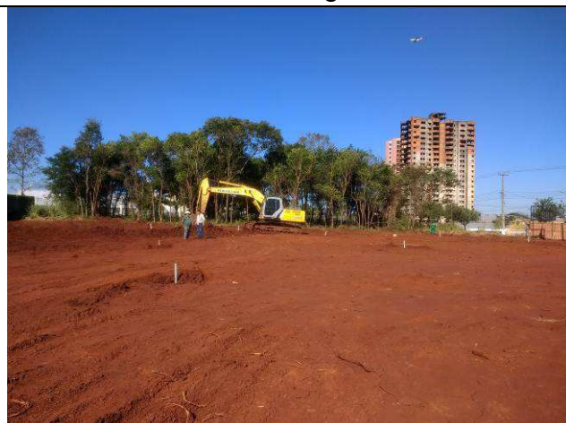
Figura 27C: Estaqueamento para marcação dos níveis dos platôs.
