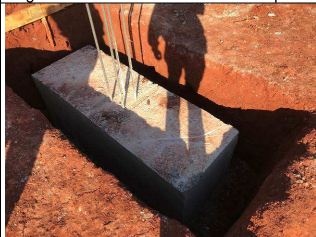
Figura 92C: Blocos concretados - arquivo.
