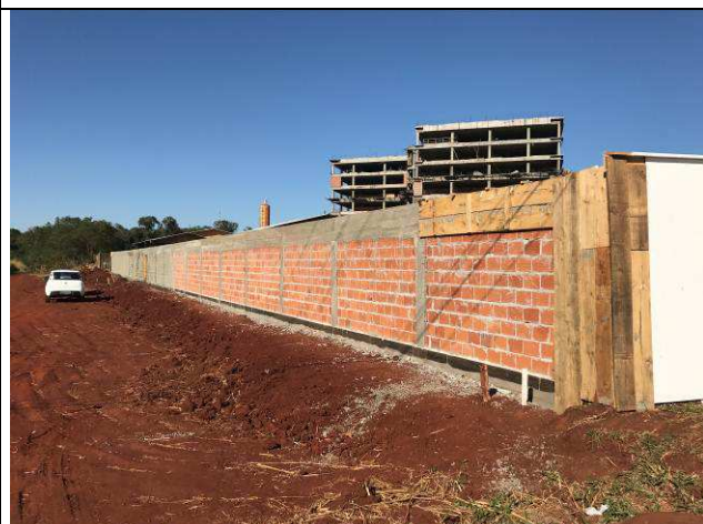
Figura 109C: Alvenaria executada - muro de fechamento.
