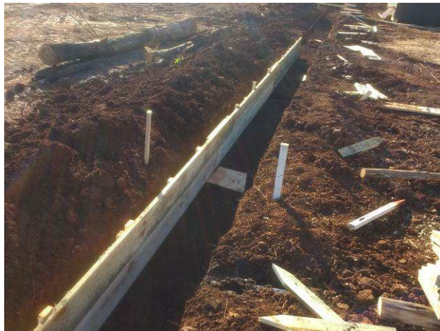
Figura 37C: Escavações para as vigas baldrames dos muros de divisa.
