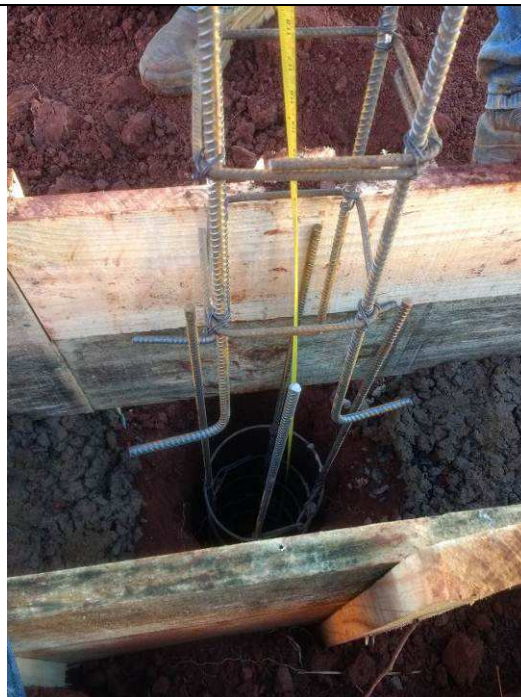
Figura 100C: Estacas - posicionamento das armaduras - muro de fechamento.
