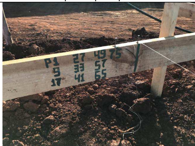
Figura 17C: Gabarito de locação da obra - prédio principal.
