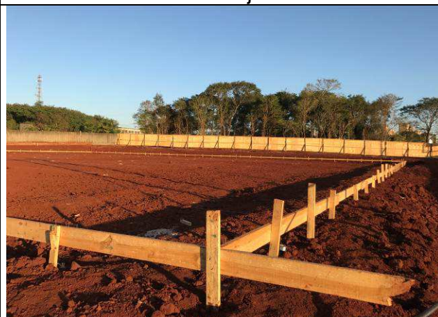
Figura 16C: Gabarito de locação da obra - prédio principal.
