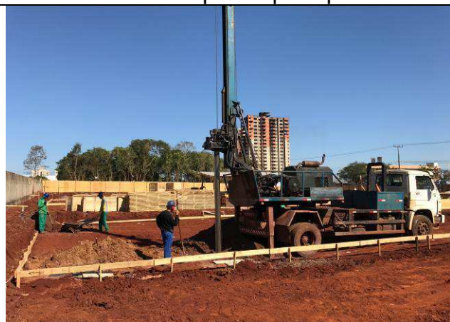
Figura 67C: Perfuração das estacas - arquivo.
