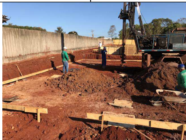
Figura 69C: Perfuração das estacas - arquivo.
