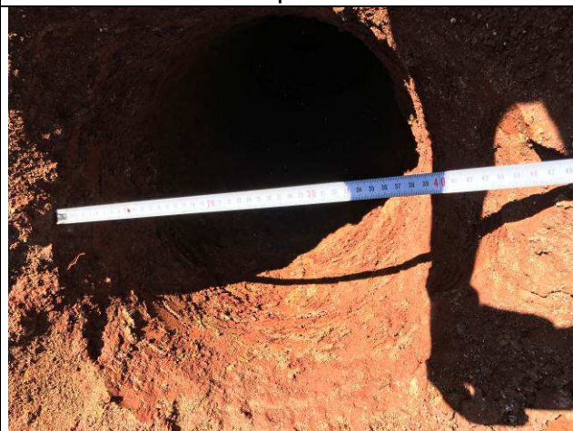
Figura 70C: Perfuração das estacas - arquivo - diâmetro 40 cm.
