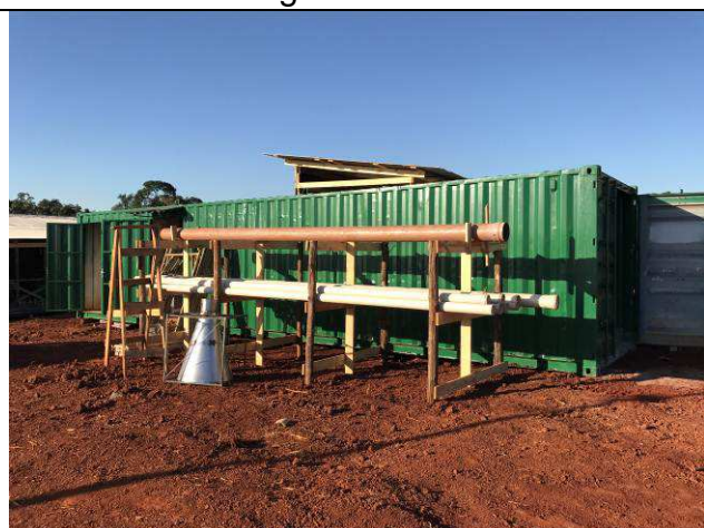
Figura 11C: Barracão de obra - depósito - contêiner para materiais miúdos e cimento.
