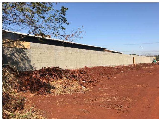
Figura 114C: Chapisco executado - face externa - muro de fechamento.
