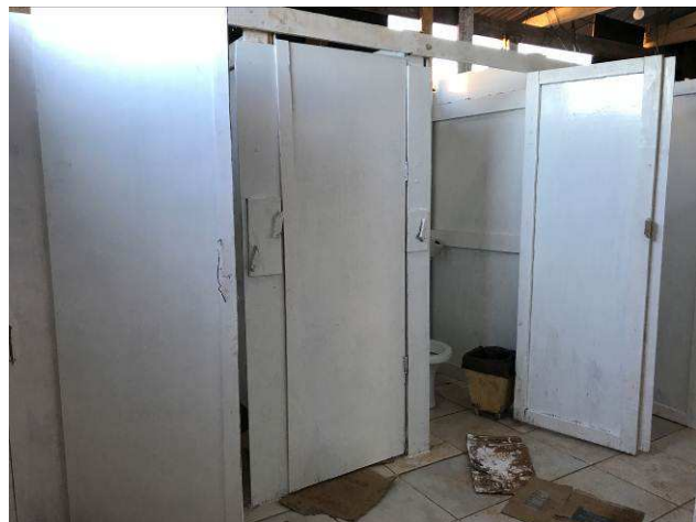
Figura 03C: Barracão de obra - sanitários.
