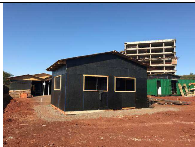
Figura 14C: Barracão de obra - refeitório, banheiro e alojamentos.
