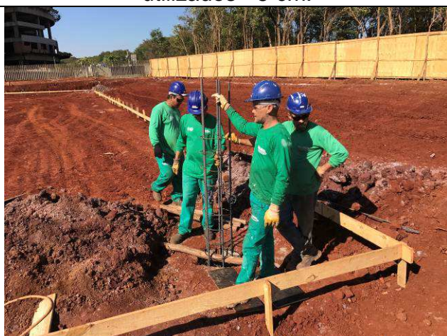
Figura 55C: Posicionamento das armaduras das estacas - prédio principal.
