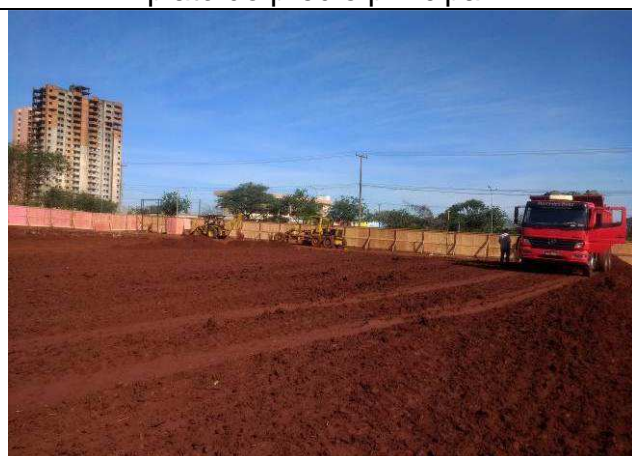
Figura 33C: Execução da terraplenagem do platô do prédio principal.
