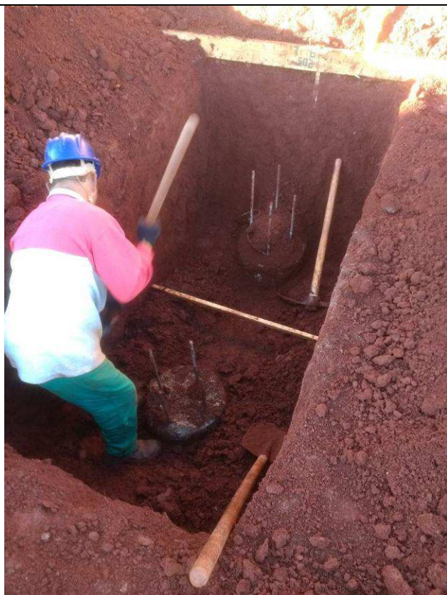
Figura 39C: Escavações para os blocos - arquivo.
