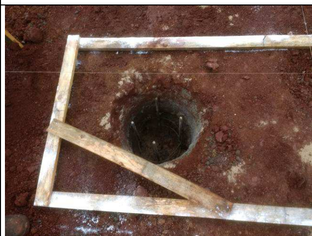
Figura 74C: Estacas concretadas - arquivo.
