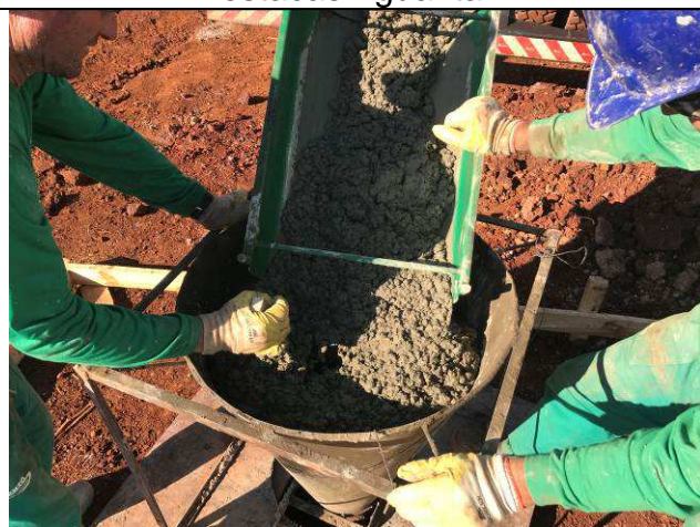
Figura 97C: Concretagem das estacas - guarita.
