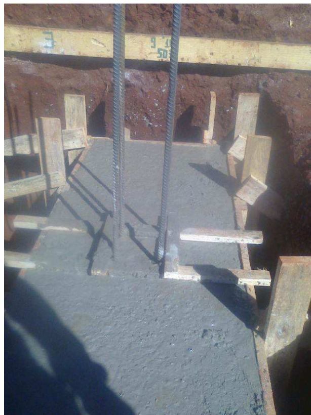
Figura 86C: Blocos - concretagem - arquivo.
