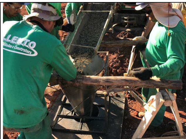
Figura 60C: Concretagem das estacas - prédio principal.
