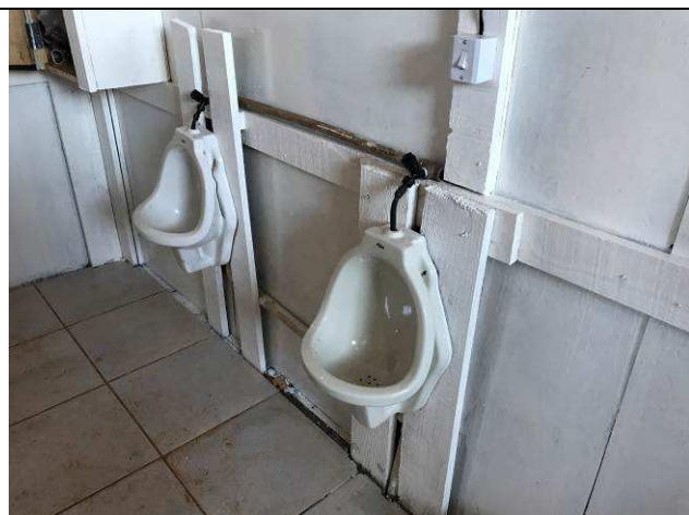
Figura 07C: Barracão de obra - sanitários.
