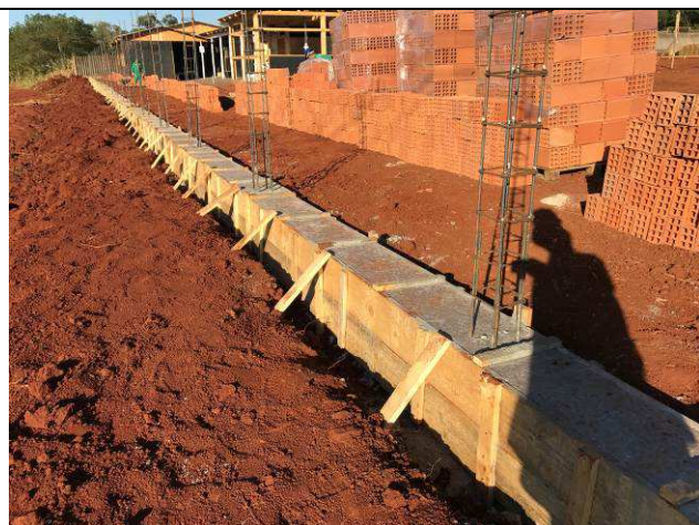
Figura 103C: Viga baldrame - concretada - muro de fechamento.
