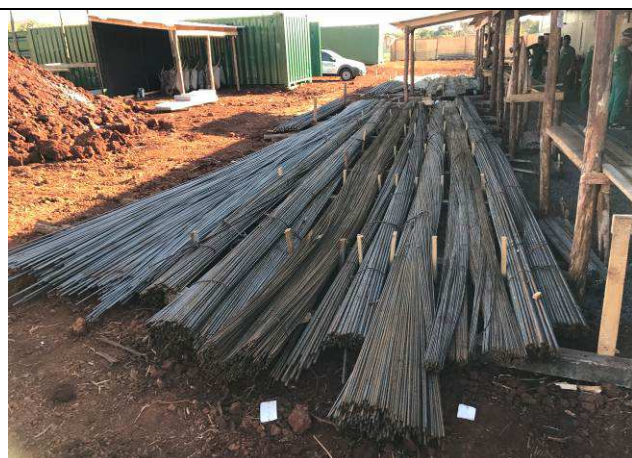
Figura 09C: Barracão de obra - depósito - montagem armaduras.
