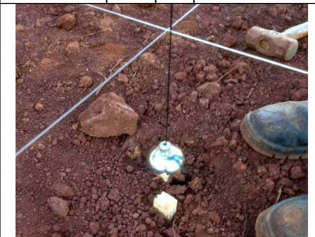
Figura 18C: Gabarito de locação da obra - piqueteamento das estacas.
