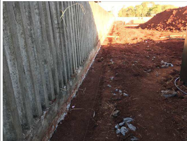
Figura 38C: Escavações para as vigas baldrames dos muros de divisa.
