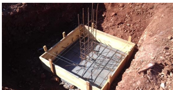
Figura 17: Fôrmas, base e armaduras de sapata isolada
