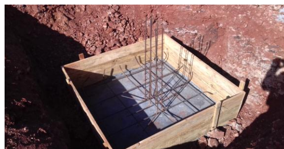
Figura 18: Fôrmas, base e armaduras de sapata isolada
