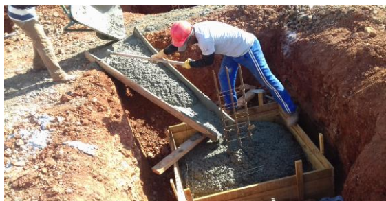
Figura 19: Sapata sendo concretada através de bica artesanal
