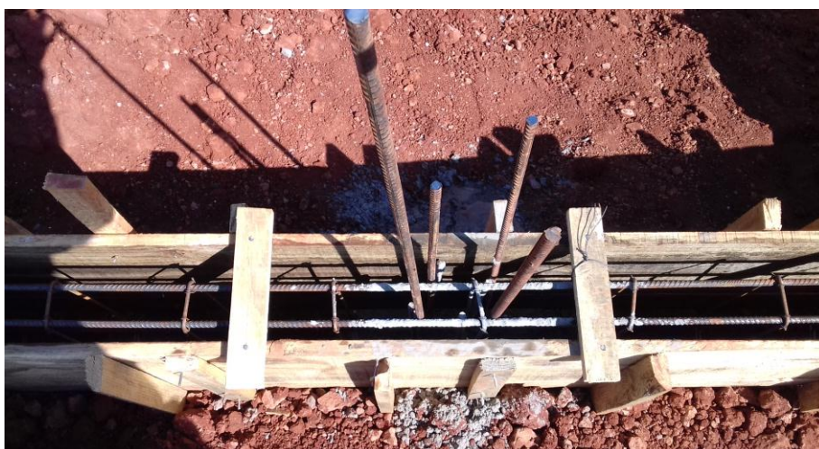
Figura 3: Caixaria de baldrame assentada sobre vala aberta
