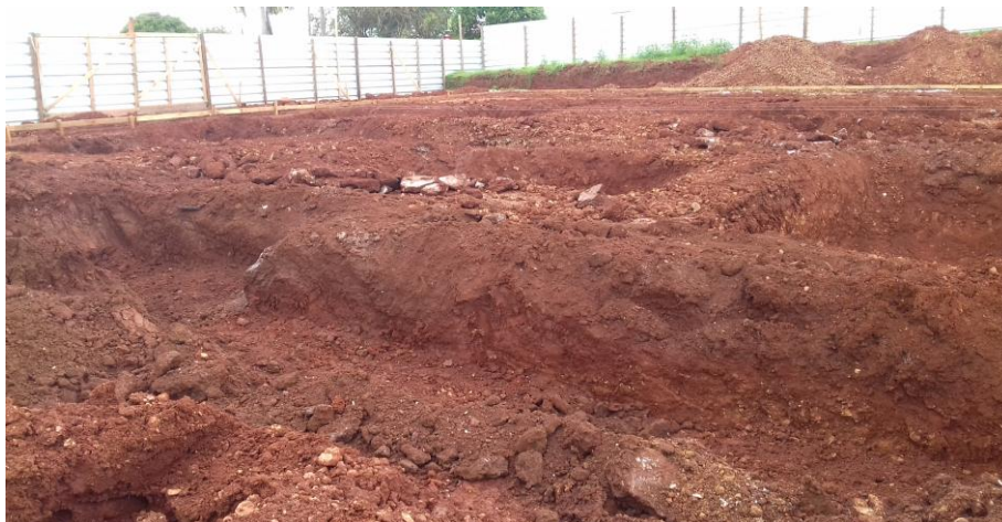
Figura 12: Terreno após abertura das valas para execução das sapatas isoladas
