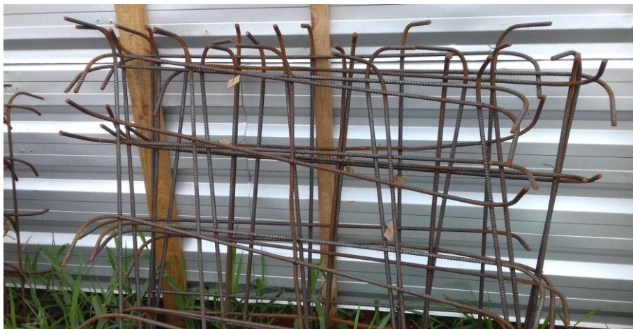
Figura 26: Detalhe de armadura de sapatas, antes de sua colocação na fôrma
