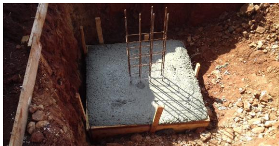
Figura 22: Sapata após concretagem
