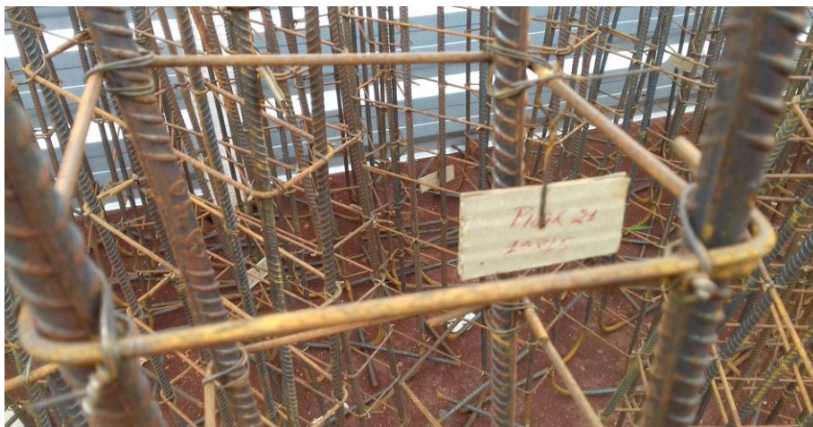
Figura 25: Detalhe de armadura de arranque, antes de sua colocação na fôrma
