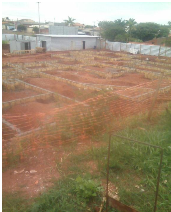
Figura 10: Vigas baldrames após concretagem total
