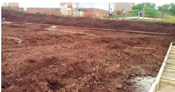
Figura 14: Terra movimentada - abertura das valas (para sapatas)
