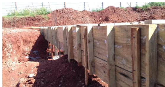
Figura 6: Fôrmas das baldrames
