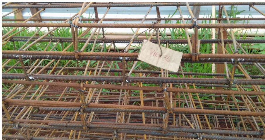
Figura 11: Detalhe da armadura de uma viga, antes de sua colocação na caixaria
