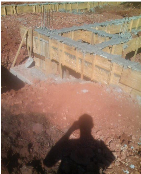
Figura 9: Viga baldrame já concretada
