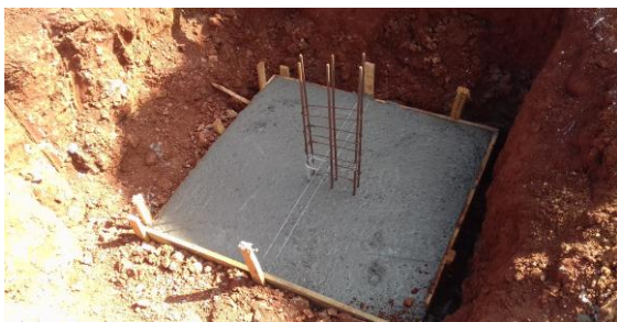
Figura 23: Sapata após concretagem
