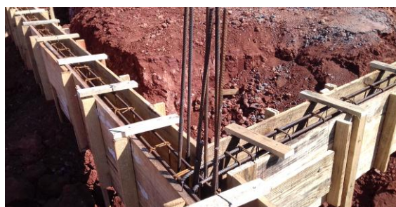
Figura 7: Fôrmas e Armaduras das baldrames
