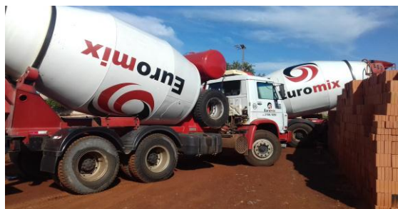
Figura 20: Caminhão-betoneira no fornecimento de concreto usinado
