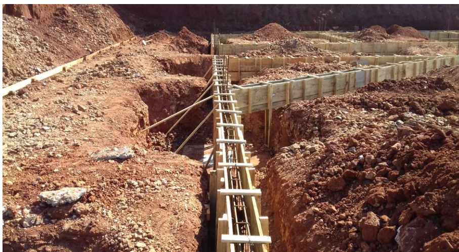
Figura 2: Valas das baldrames abertas
