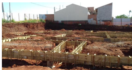
Figura 8: Vista geral das baldrames antes da concretagem
