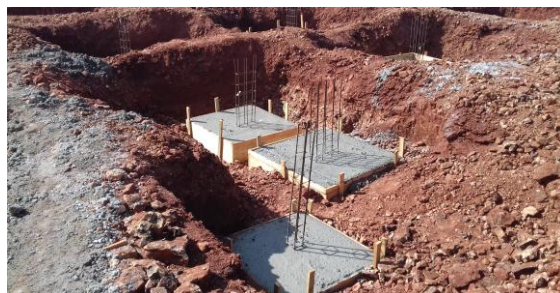
Figura 24: Sapatas após concretagem
