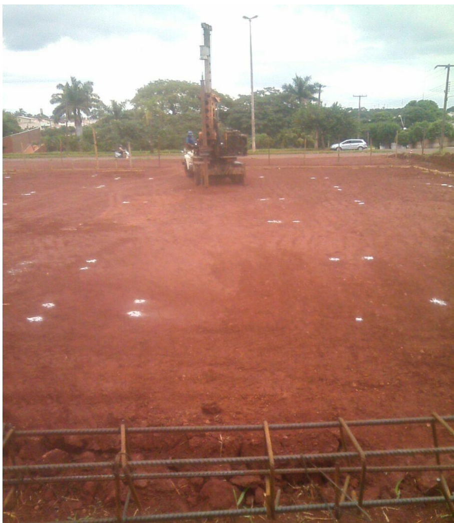
Figura 27: Perfuratriz tentando realizar procedimento de perfuração, sem qualquer sucesso para profundidades maiores que 3m
