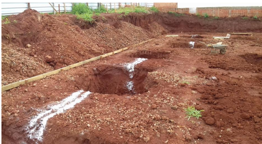
Figura 1: valas das sapatas abertas e demarcação das valas para as baldrames
