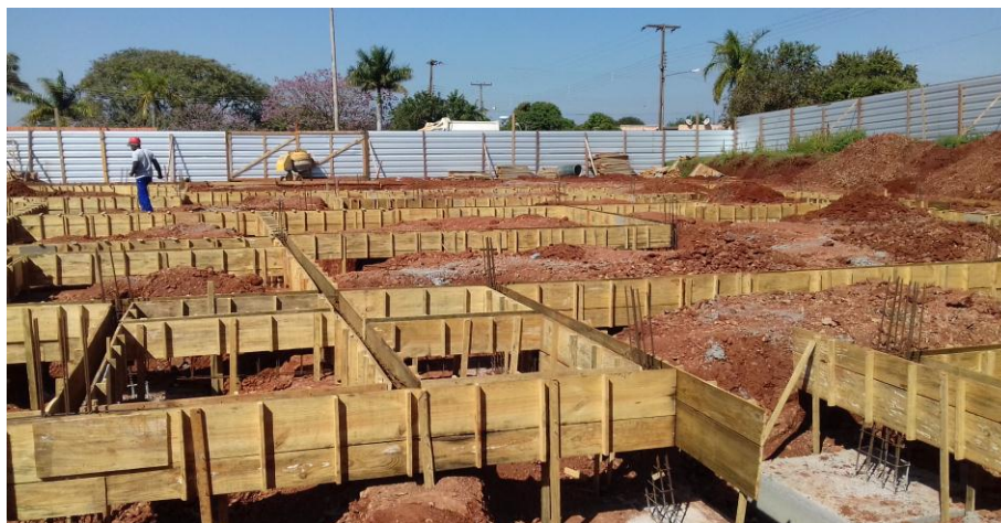
Figura 4: Vista geral das fôrmas das baldrames
