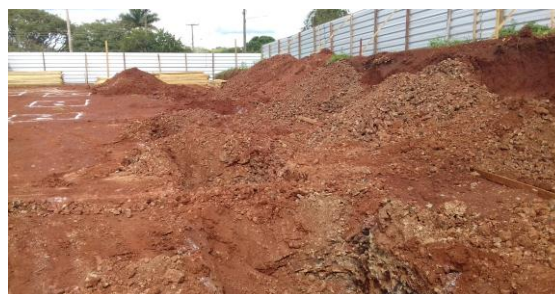
Figura 30: Situação do terreno após escavação de trecho para execução das sapatas - solo provido de rochas
