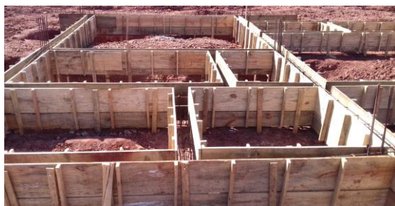
Figura 5: Fôrmas das baldrames
