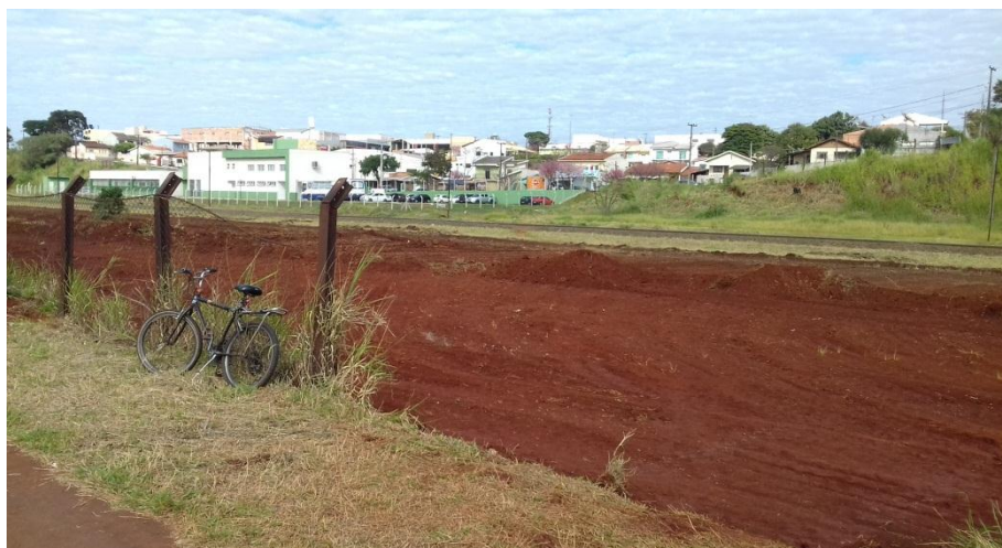
Figura 3.2 - Camada vegetal já totalmente retirada nos limites do terreno
