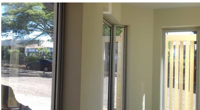
Figura 3: Janelas que receberam vidro temperado ao fundo e janela nova 90x120cm à esquerda na imagem
