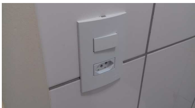
Figura 41: Tomada e interruptor 4x2", instalados no sanitário
