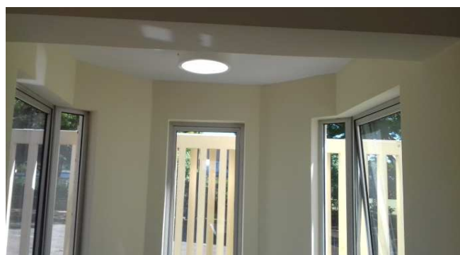
Figura 33: Pintura de parede e teto da guarita
