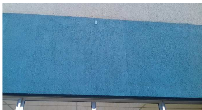
Figura 52: Fechamento das diferenças no requadro, já com textura (grafiato) aplicada
