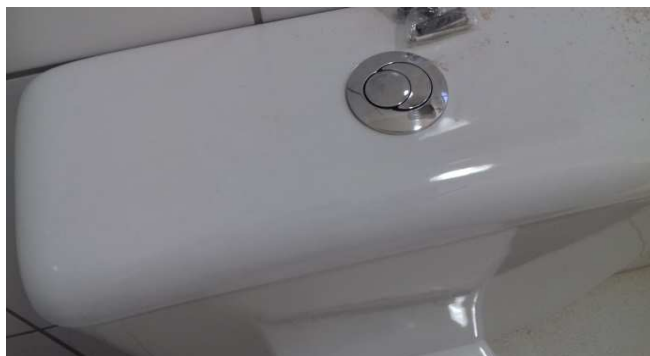
Figura 14: Detalhe da caixa acoplada ao vaso
