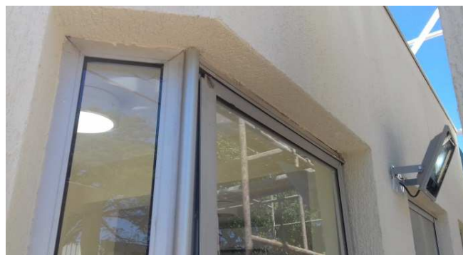
Figura 4: Janelas existentes que receberam vidro temperado
