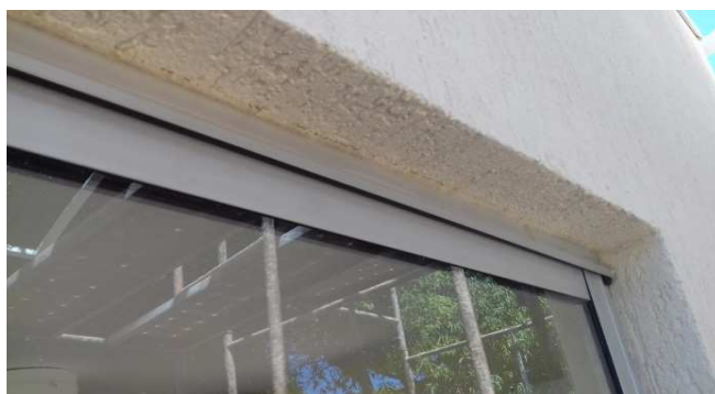
Figura 6: Detalhe de arremate e vedação de janela reinstalada (mudou de local)
