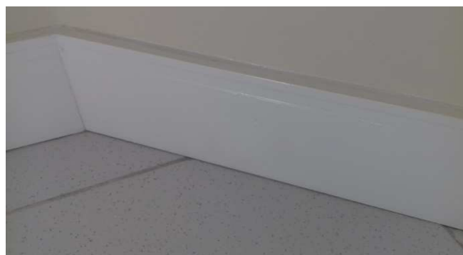
Figura 10: Detalhe dos odapés em poliuretano
