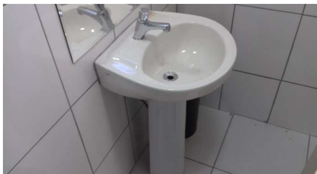
Figura 16: Detalhe do lavatório com coluna e torneira instalada
