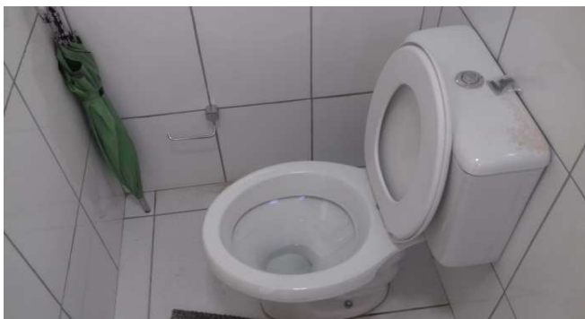
Figura 13: Vaso sanitário, instalado no banheiro da guarita
