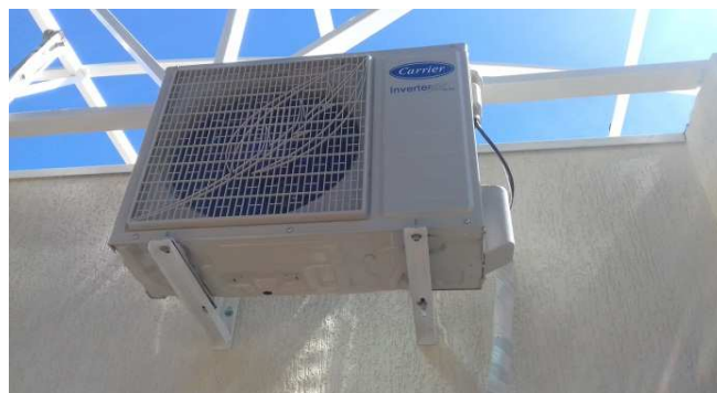
Figura 27: Unidade condensadora
