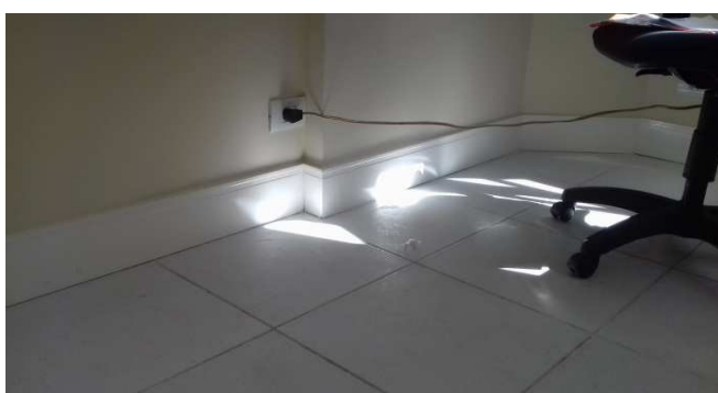
Figura 11: Rodapés em poliuretano, instalados na guarita
