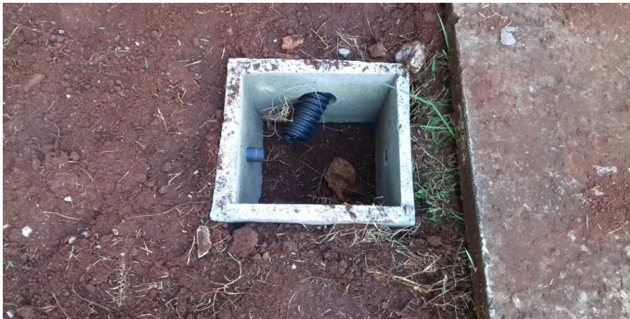
Figura 36 - Caixa 152x152 instalada na parede da guarita
