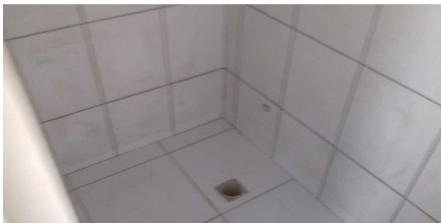
Figura 22 - Ponto de esgoto primário (bacia sanitária)
