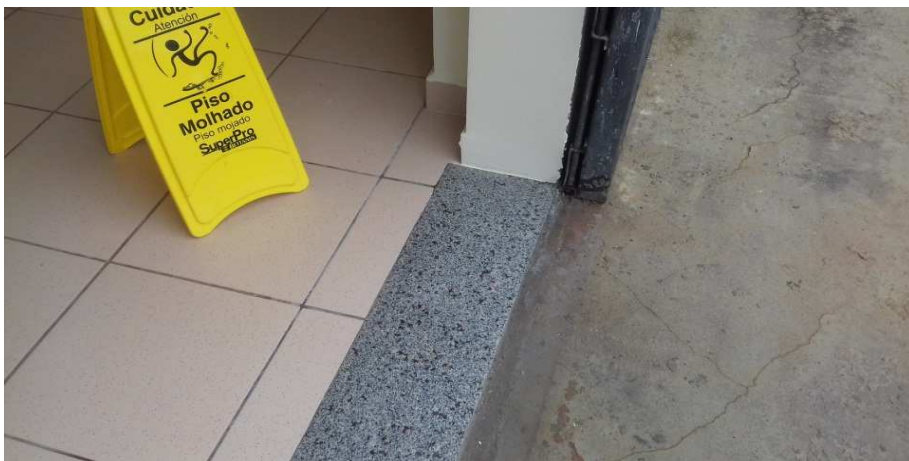
Figura 52 - Piso reconstituído, com peitoril em granito já instalado
