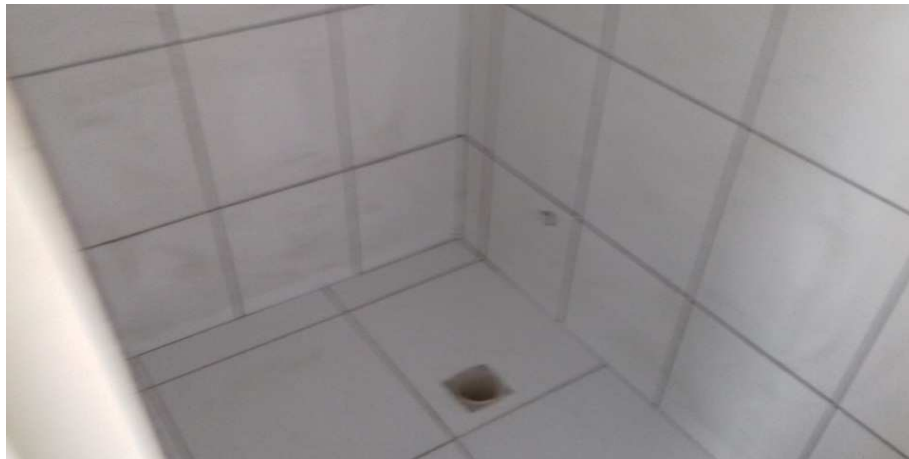
Figura 15 - Aplicação de azulejo no banheiro da guarita
