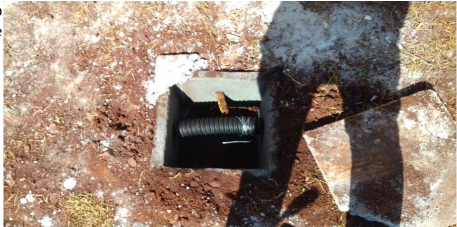
Figura 31 - Caixa estampada 2x4" para instalação de interruptor, na guarita
