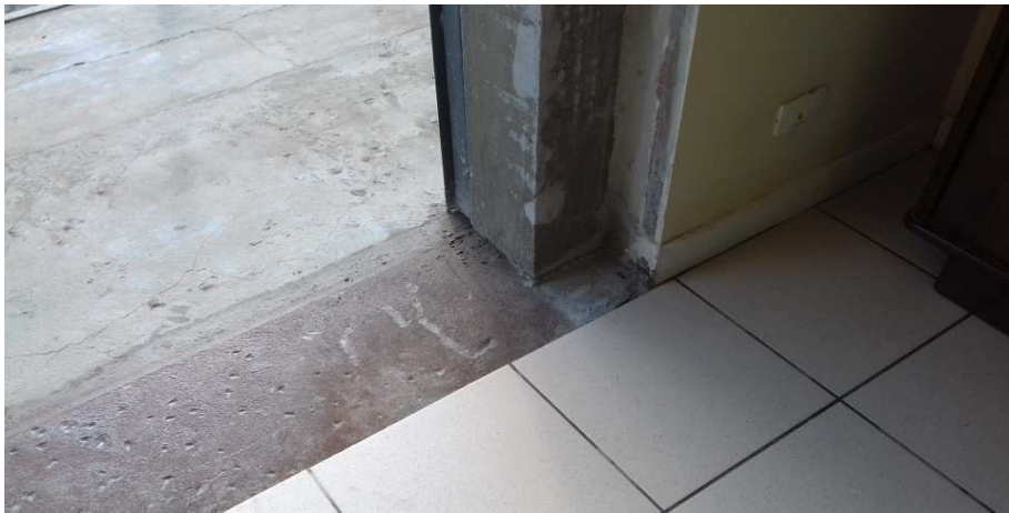
Figura 51 - Pilar executado no vão para a instalação da esquadria
