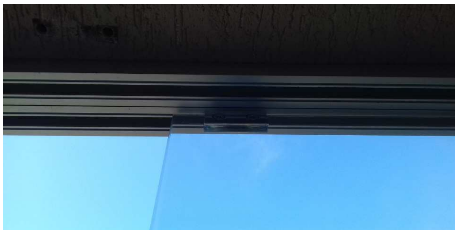
Figura 40 - Detalhe do perfil inferior com 3 divisões (trilhos) onde os vidros correm
