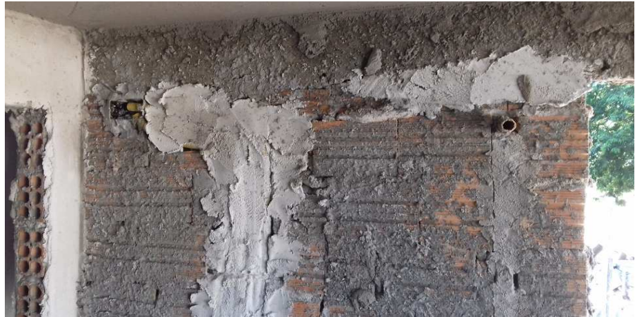
Figura 14 - Chapisco em parede.
