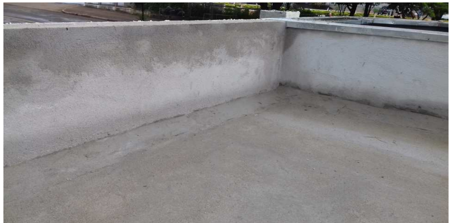
Figura 12 - Laje já impermeabilizada, com proteção mecânica executada.
