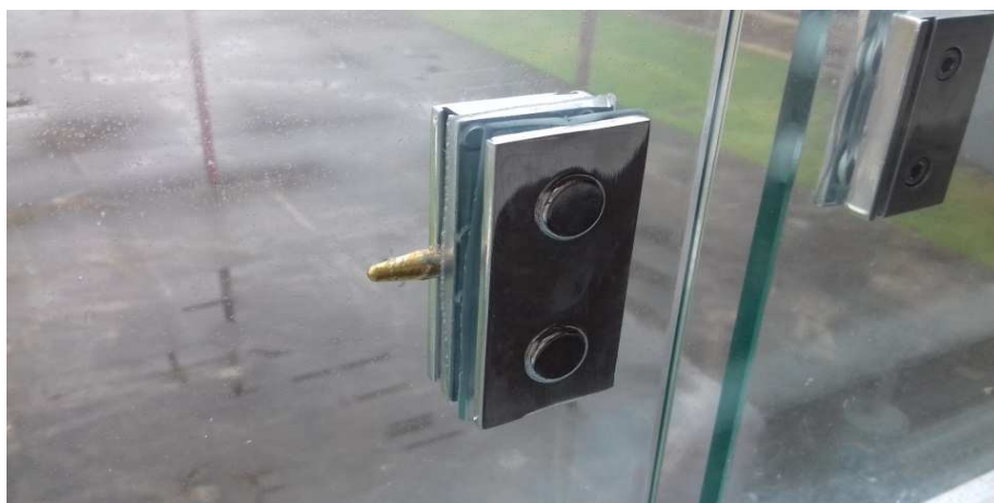
Figura 43 - Detalhe do engate solidário que empurra as folhas de vidro ao fechar as folhas da extremidade
