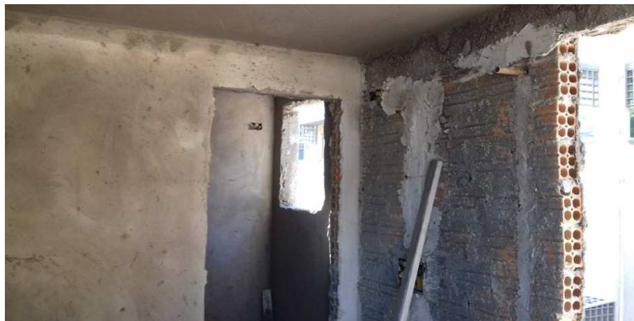
Figura 10 - Alvenaria de fechamento da platibanda.
