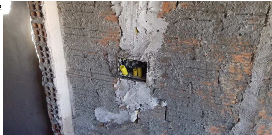
Figura 36 - Caixa 152x152 instalada na parede da guarita
