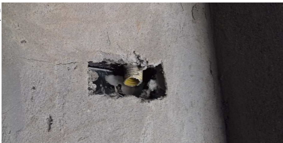
Figura 32 - Caixa estampada 4x2" para ponto elétrico do ar condicionado
