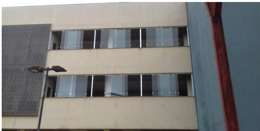
Figura 48 - Detalhe das esquadrias, já com vidros instalados, no bloco oeste, segunda parte
