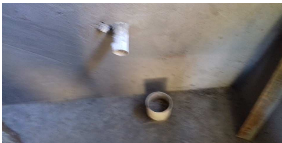
Figura 22 - Ponto de esgoto primário (bacia sanitária)
