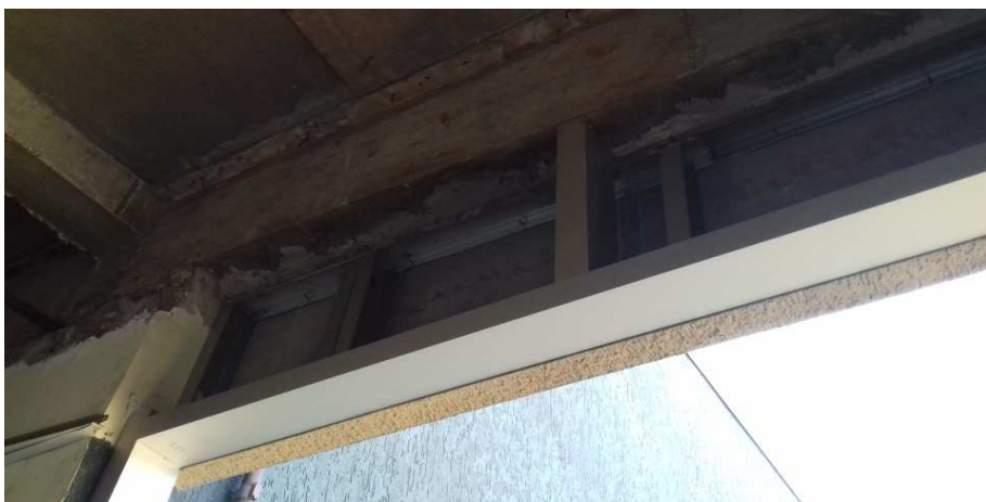
Figura 37 - Detalhe da estrutura de reforço das esquadrias, fixada no fundo da viga de concreto
