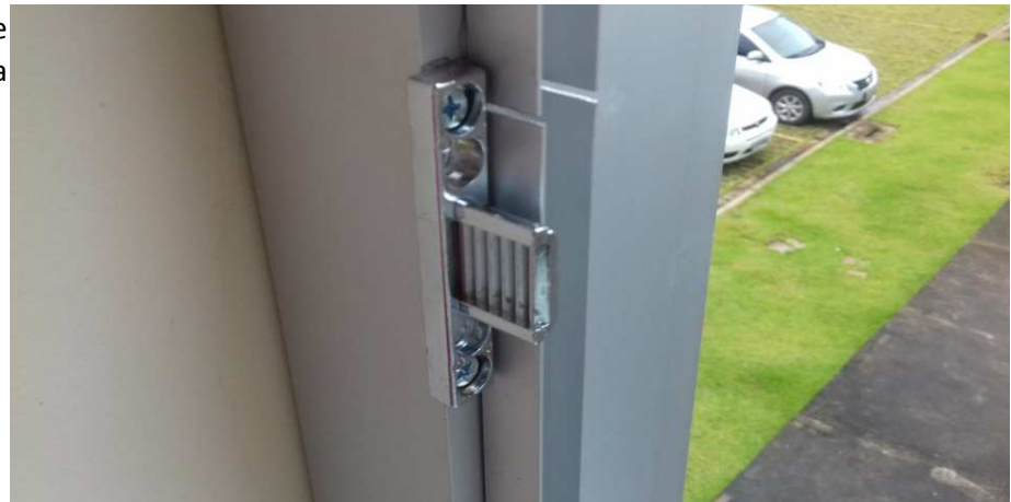
Figura 43 - Detalhe do engate solidário que empurra as folhas de vidro ao fechar as folhas da extremidade
