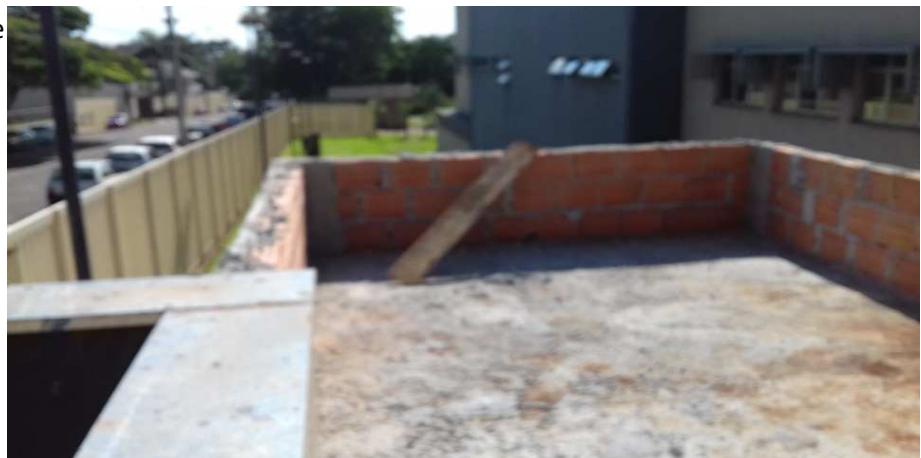
Figura 10 - Alvenaria de fechamento da platibanda.
