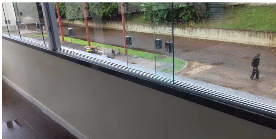
Figura 44 - Vidro temperado 10mm instalado em todas as esquadrias
