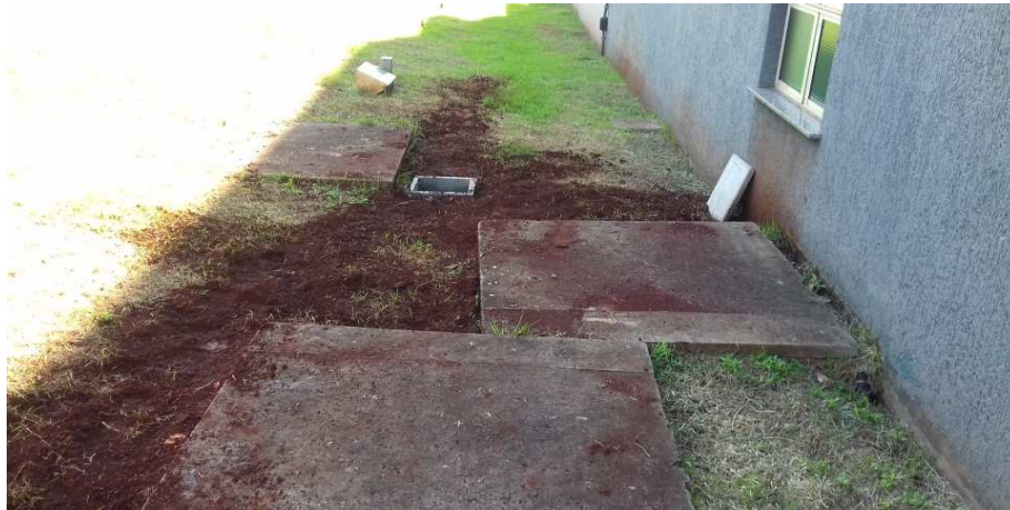
Figura 3 - Valas de elétrica e esgoto, já fechadas.
