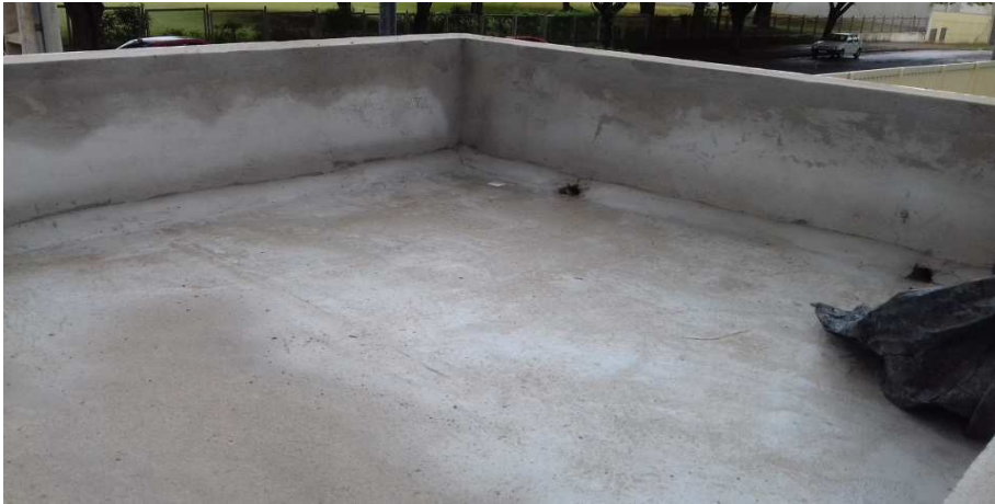
Figura 11 - Buzinotes instalados na fachada oeste da guarita
