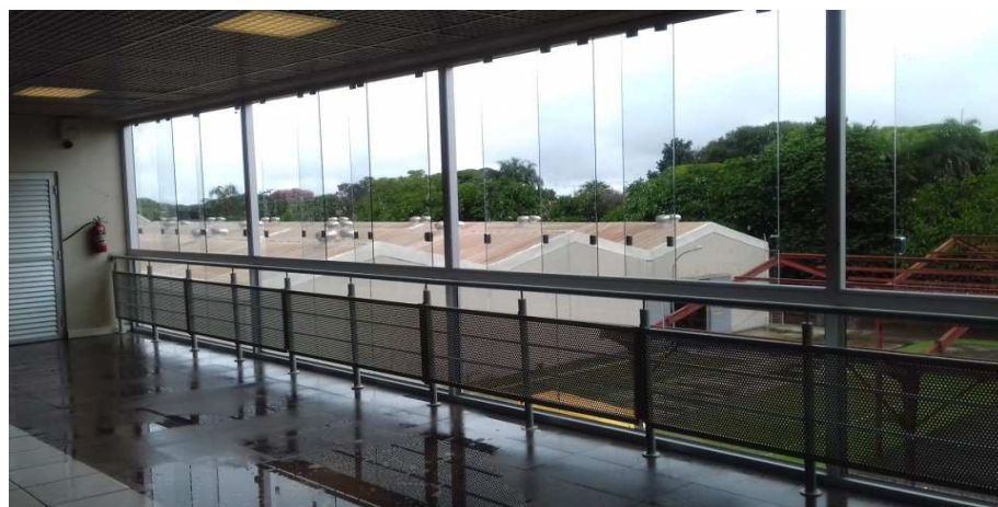
Figura 49 - Vista interna das esquadrias, localizadas no bloco leste, já com os guarda-corpos pintados e reinstalados
