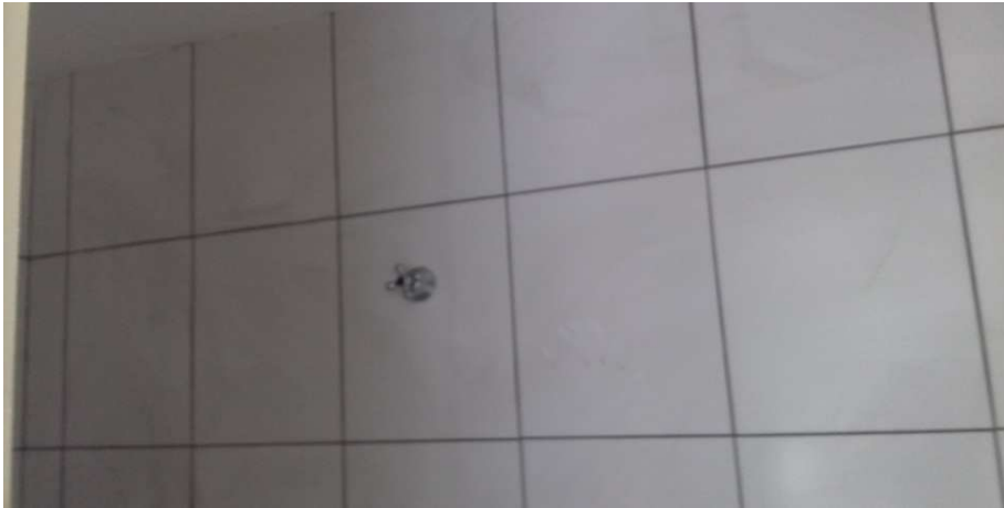
Figura 23 - Registro de gaveta instalado no banheiro da guarita
