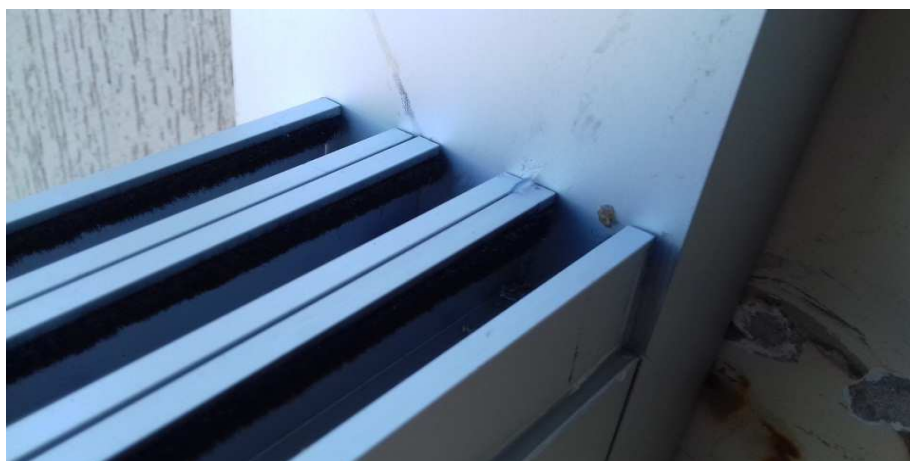
Figura 40 - Detalhe do perfil inferior com 3 divisões (trilhos) onde os vidros correm
