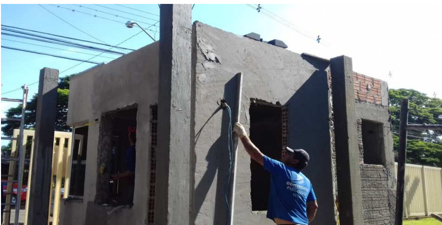
Figura 13 - Rebôco sendo executado em parede externa da guarita
