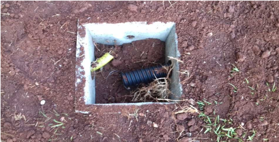
Figura 30 - Eletroduto PEAD 50mm saindo de caixa 30x30 de concreto.
