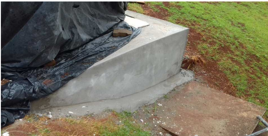
Figura 25 - Calçada ao redor da guarita (ampliação)
