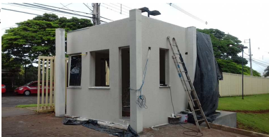
Figura 28 - Aplicação de textura nas faces externas das paredes da guarita
