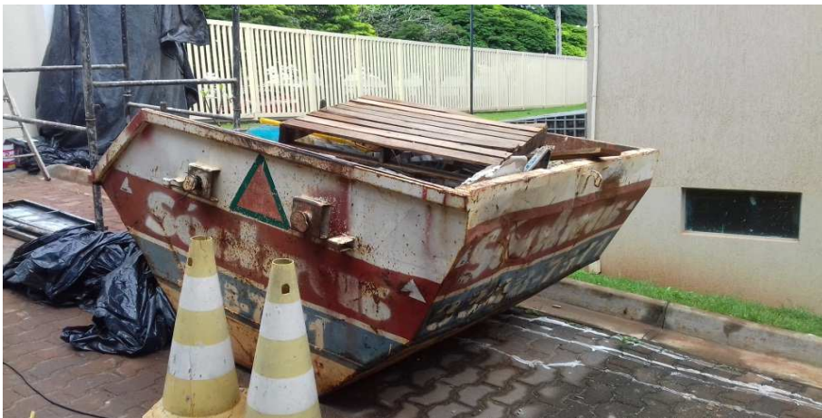
Figura 1 - Uso de caçamba para remoção de entulho.
