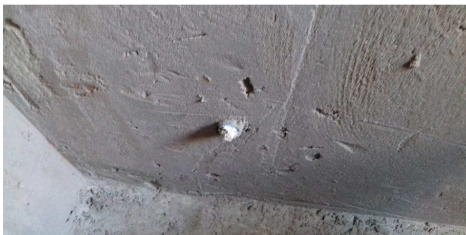
Figura 21 - Ponto de esgoto secundário e ponto de água fria (lavatório)
