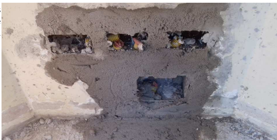
Figura 34 - Caixas estampadas 4x2" para instalação de rede elétrica comum, estabilizada, lógica e telefonia
