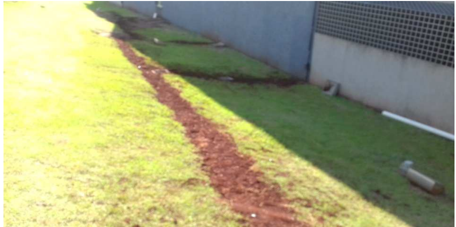
Figura 2 - Abertura e fechamento de vala para passagem de tubulação de elétrica e lógica
