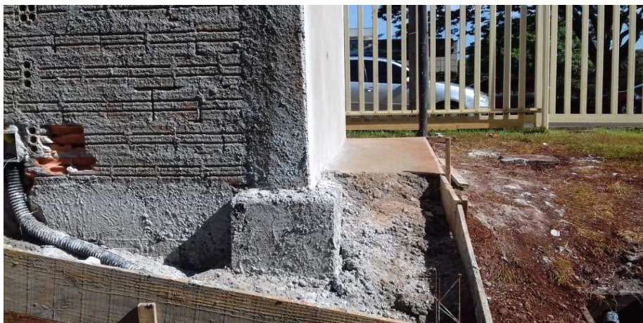
Figura 4 - Bloco de concreto e viga baldrame executados
