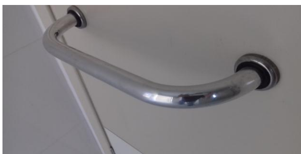
Figura 7.3: Detalhe de uma barra para abertura de porta PNE
