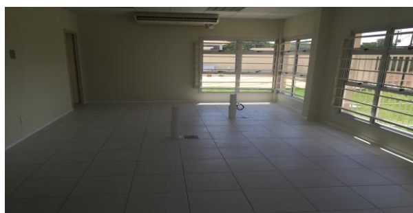
Figura 7.6: Janelas 1,80m x 1,80m com seus gradis instalados
