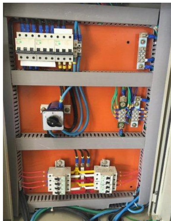
Figura 23 . 16 quadro elétrico QDE - conclusão cabeamento, identificação, conectorização
