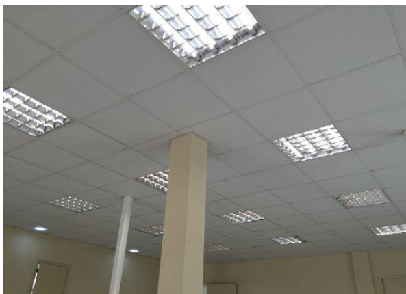
Figura 23 . 35 luminárias 62x62 com aletas antireflexivas, 4 lâmpadas LED
