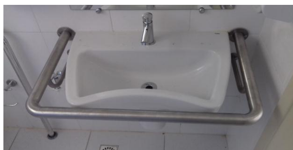
Figura 15.14: lavatório do BWC PNE público, com barra de apóio instalada
