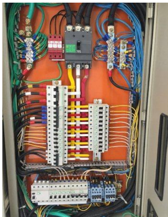
Figura 23 . 14 quadro elétrico QDG - conclusão cabeamento, identificação, conectorização
