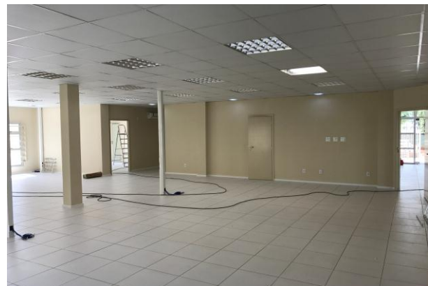
Figura 19.4: Pintura de paredes internas - Secretaria
