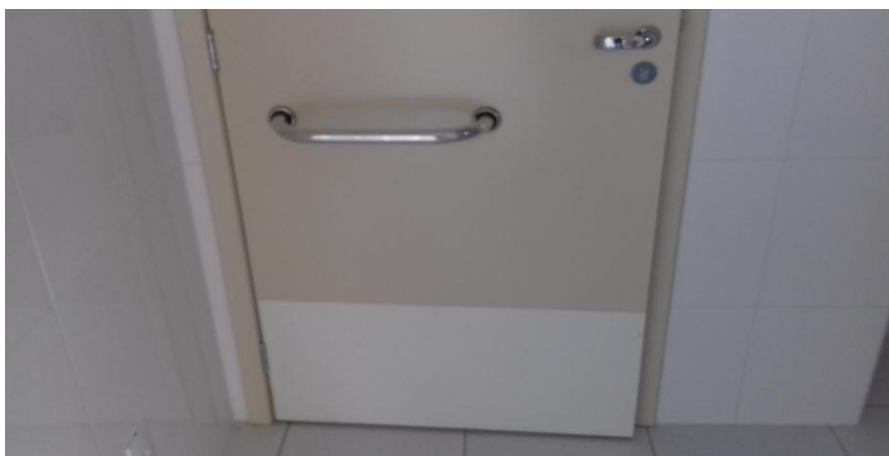
Figura 7.2: Barra de apoio para abertura, instalada em porta do BWC PNE público
