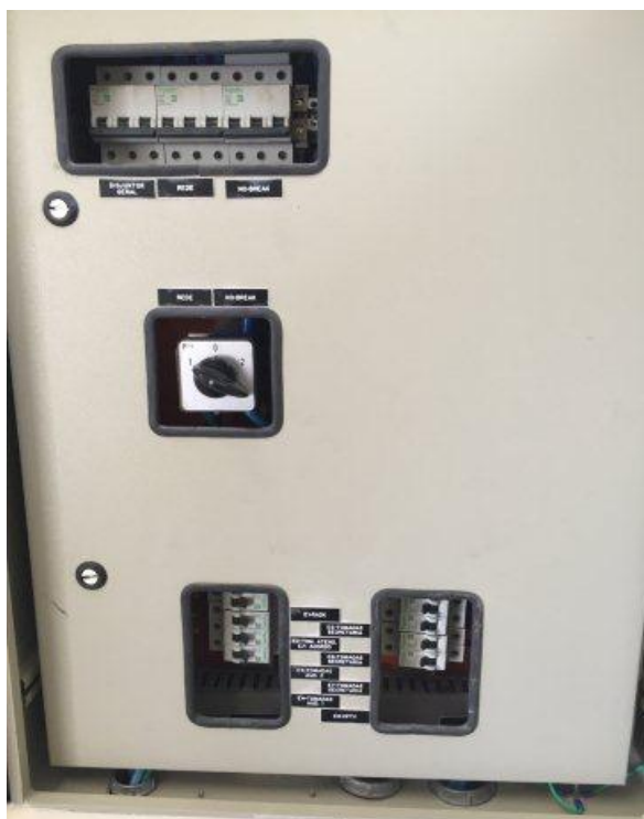
Figura 23 . 15 quadro elétrico QDE - conclusão cabeamento, identificação, conectorização
