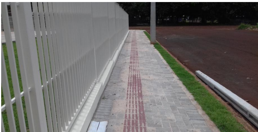
Figura 18.2: piso podotátil externo, em placa cimentícea
