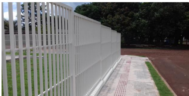
Figura 18.5: Vista do gradil localizada na face leste
