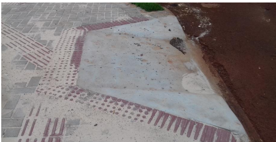
Figura 18.3: piso de alerta externo, em placa cimentícea
