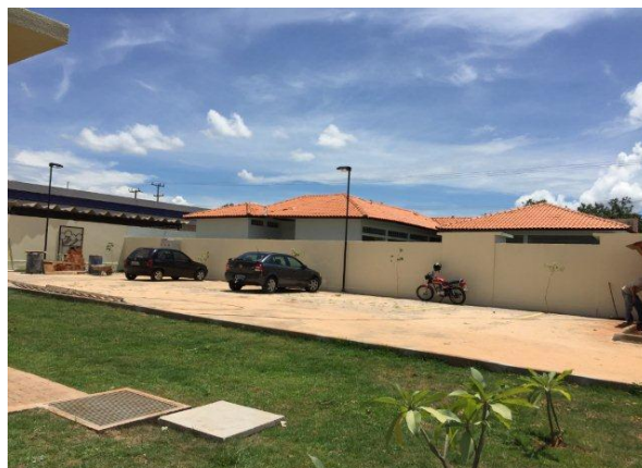
Figura 23 . 44 iluminação externa - luminárias tipo poste de uma pétala, lâmpada VM250W
