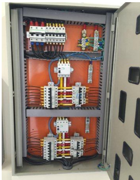
Figura 23 . 12 quadro elétrico QDAR - conclusão cabeamento, identificação, conectorização
