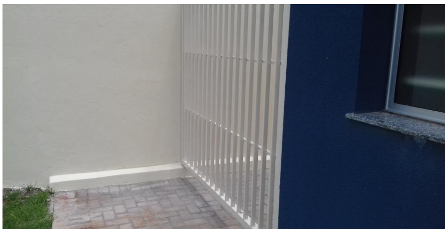
Figura 27.2: Gradil instalado entre a copa e o muro dos fundos
