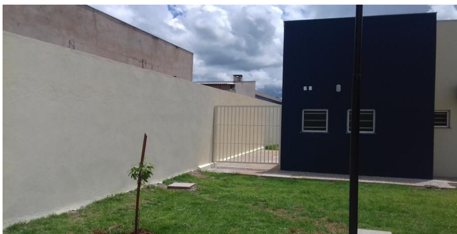
Figura 27.1: Gradil instalado entre a copa e o muro dos fundos
