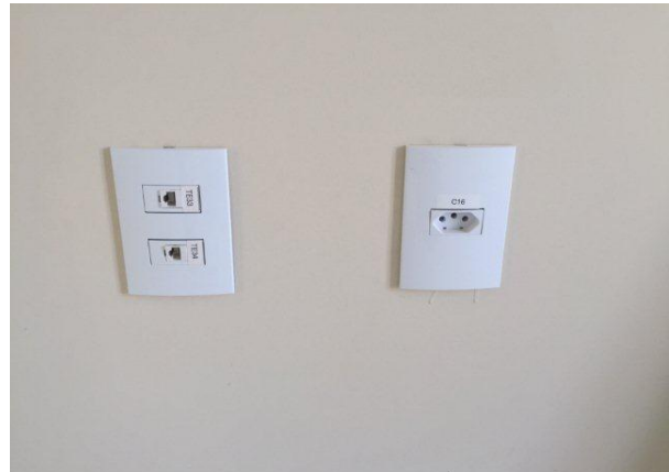
Figura 24 . 8 tomadas lógicas padrão modular MarGirius
