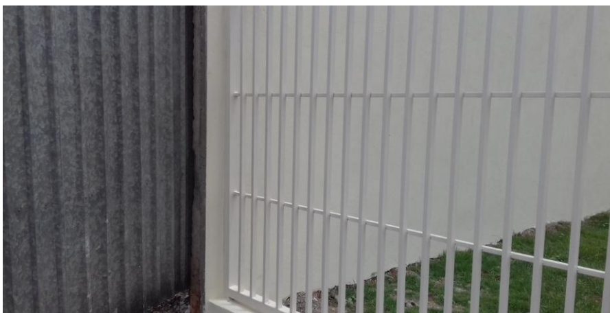
Figura 18.4: ultimo trecho de gradil instalado, na divisa com a loja maçônica
