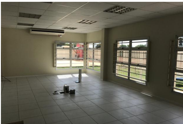
Figura 19.3: Pintura de paredes internas - Sala de audiência principal
