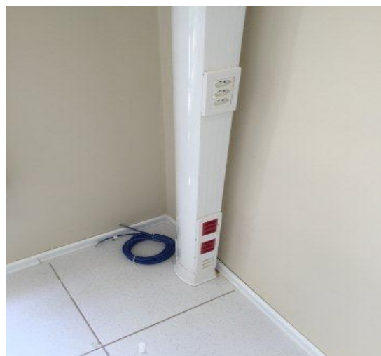
Figura 23 . 30 coluna técnica Dutotec - porta equipamentos, tomadas, blocos cegos
