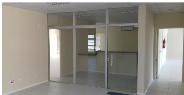
Figura 7.4: Conjunto de vidros fixos e porta de vidro, instalados no balcão de atendimento
