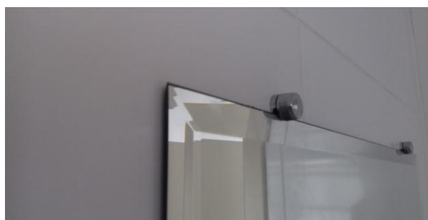
Figura 15.6: Detalhe do bisotê nos espelhos e da fixação na parede
