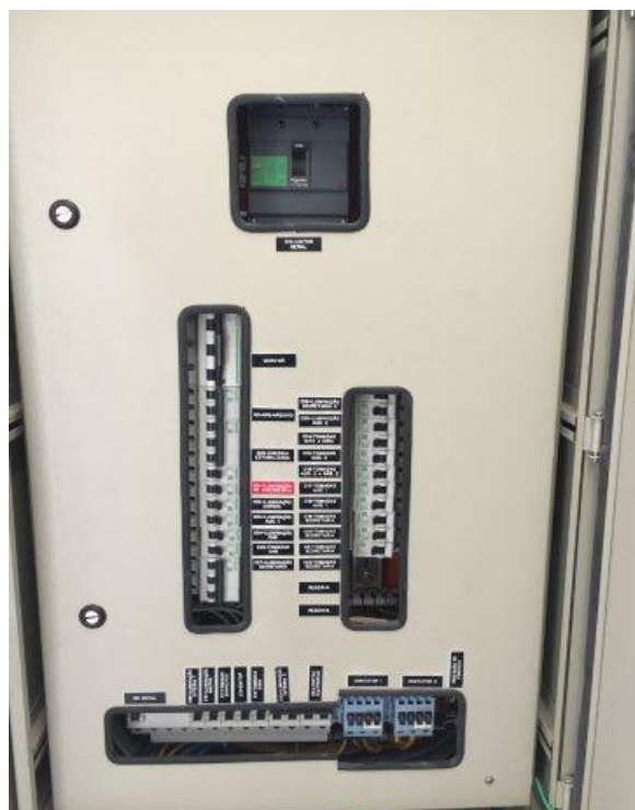
Figura 23 . 13 quadro elétrico QDG - conclusão cabeamento, identificação, conectorização
