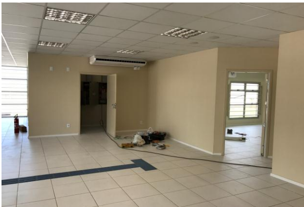
Figura 19.1: pintura de paredes internas - hall público
