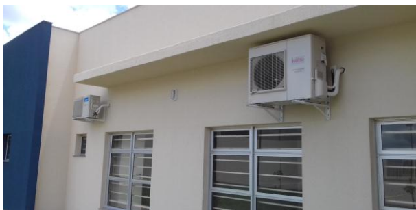
Figura 16.3: Ao fundo, condensador de 12.000 BTU/h, atendendo ao gabinete do juiz auxiliar e à frente, unidade de 30.000 BTU/h atendendo à sala de audiência 2
