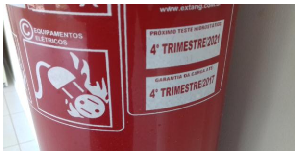
Figura 17.4: Verificação da validade da carga e teste hidrostático
