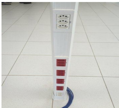
Figura 23 . 28 coluna técnica Dutotec - porta equipamentos, tomadas, blocos cegos
