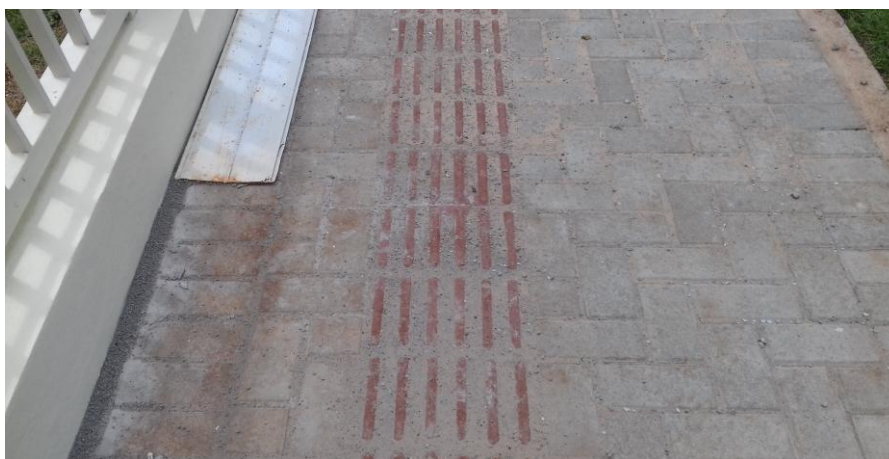
Figura 18.1: piso podotátil externo, em placa cimentícia
