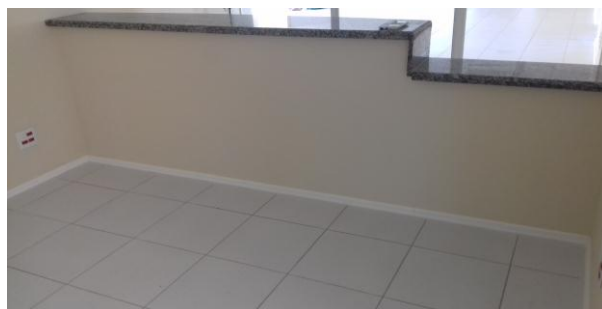
Figura 14.4: Rodapés instalados no balcão de
