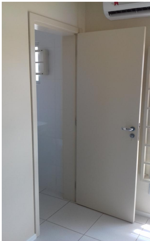
Figura 19.6: Pintura de portas - sanitário público
