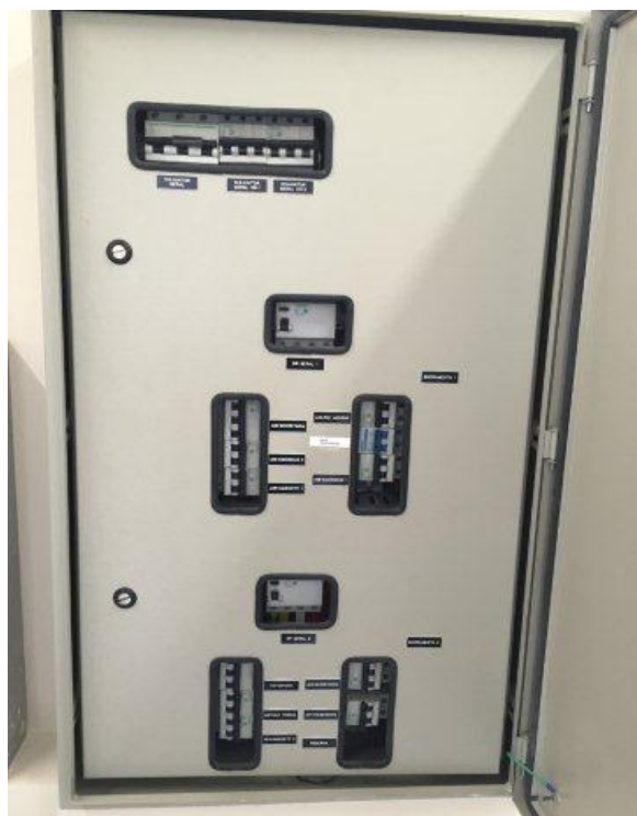
Figura 23 . 11 quadro elétrico QDAR - conclusão cabeamento, identificação, conectorização
