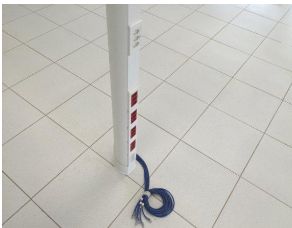
Figura 24 . 21 patch cords de 10m para conexão microcomputadores padrão genérico
