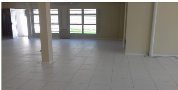
Figura 14.3: Rodapés instalados na secretaria
