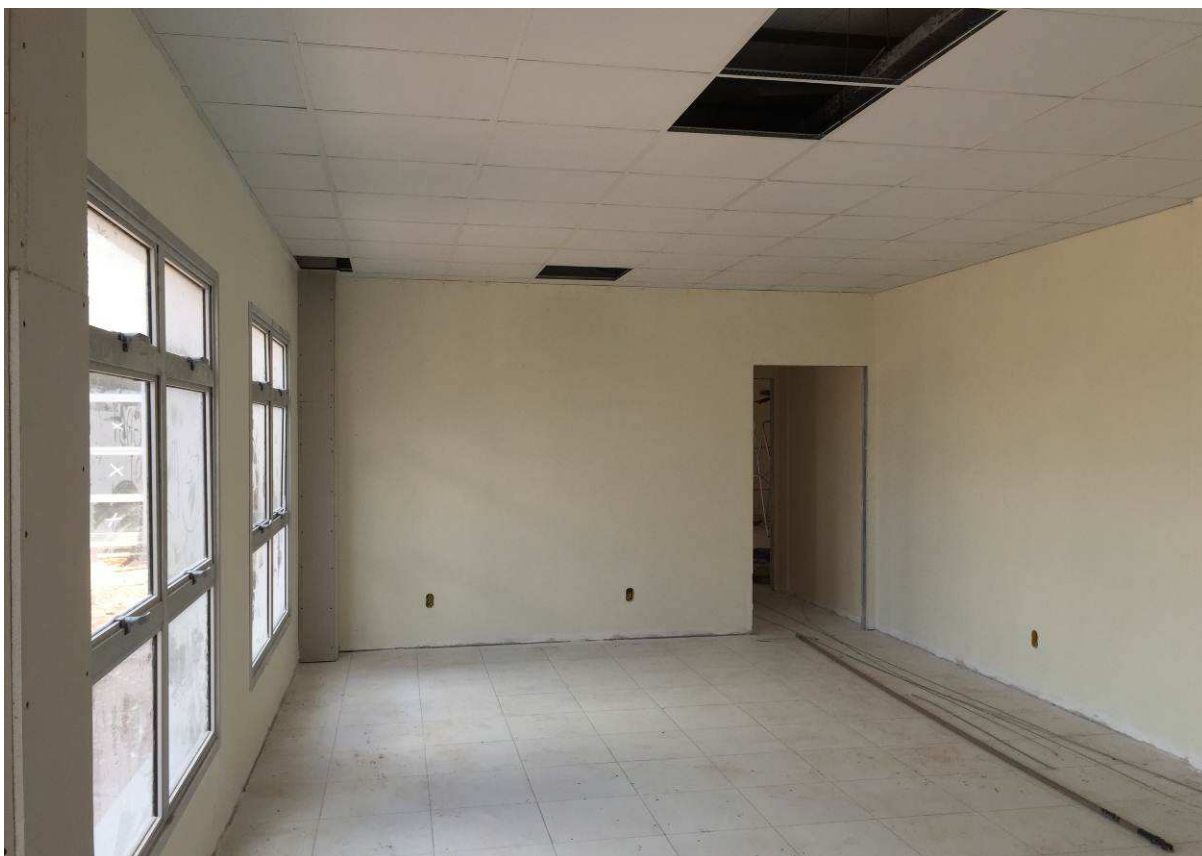
Figura 5 – Vista interna - sala de audiências.
