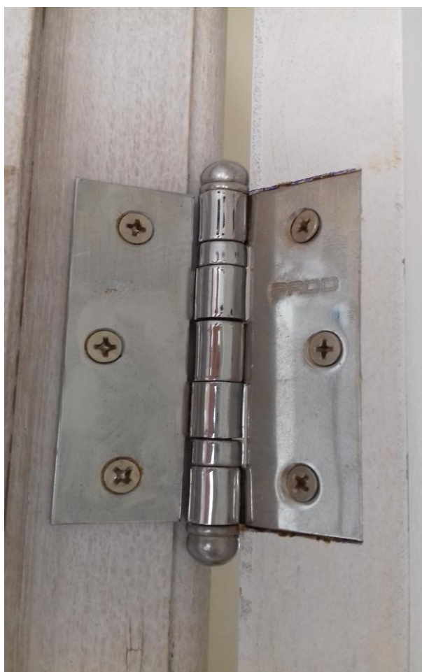
Figura 7.3: Detalhe do modelo de dobradiça instalada nas portas de madeira
