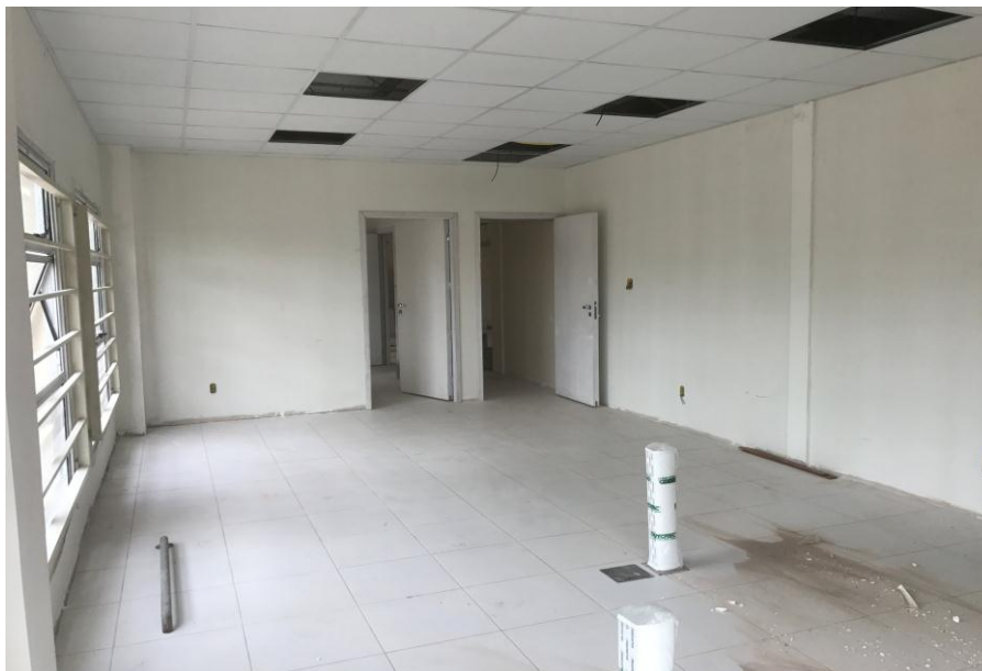
Figura 7.11: Portas de madeira com isolamento acústico, instaladas na sala de audiência 1 (juiz titular).
