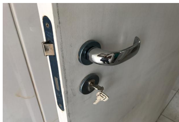
Figura 7.15b: Detalhe do conjunto de fechadura, maçaneta, lingueta e chaves, instalados nas portas de madeira
