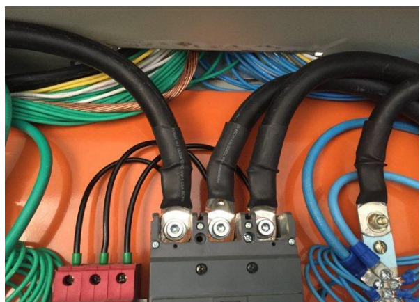
Figura 23 . 29 cabearno elétrico - ramais alimentadores
