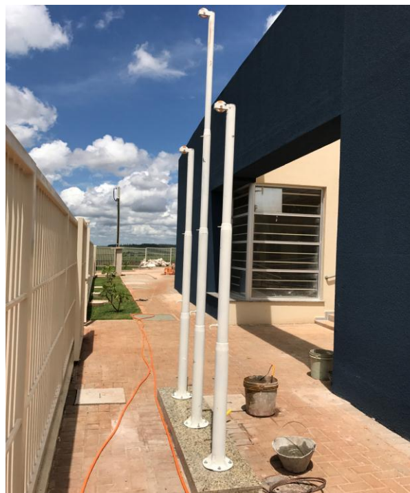
Figura 20.3: Detalhe dos mastros para bandeiras, são dois mastros de 3m e o mastro central com 4m
