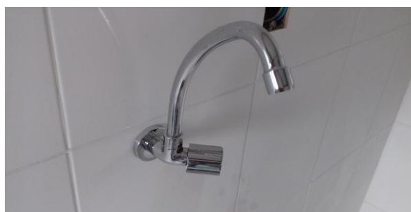
Figuras 15.26 e 15.27: Torneiras em metal cromado, bica alta, instaladas na copa do prédio principal e na área de serviço do arquivo
