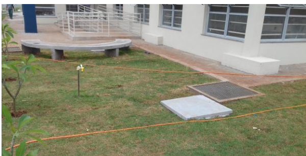
Figuras 15.1, 15.2 e 15.3: Tampas de caixas de esgoto, com tamanhos variando de 60x60cm a 90x90cm. Todas as caixas encontram-se com tampas e com o interior devidamente rebocado
