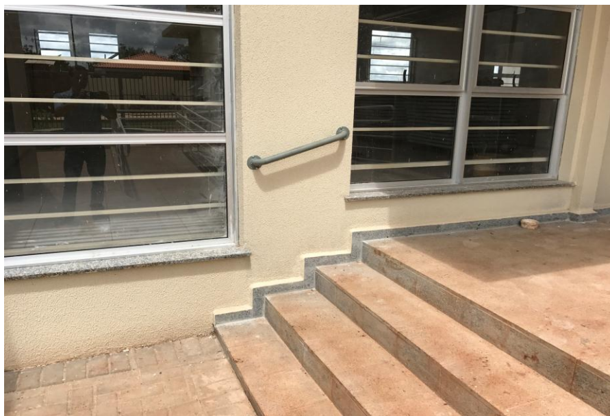
Figura 14.1: Rodapé instalado junto a escada, no hall de entrada do prédio principal
