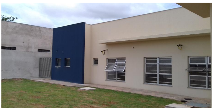
Figura 19.3: Aplicação de textura acrílica nas cores doric white e nocturne blue, nas paredes da fachada lateral esquerda
