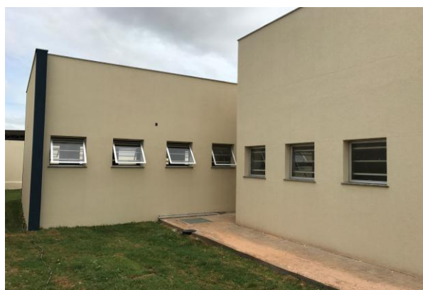
Figura 19.3: Aplicação de textura acrílica nas cores doric white e nocturne blue, nas paredes da fachada lateral esquerda
