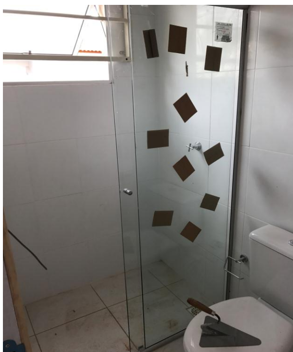
Figura 7.16: Box de vidro temperado 8mm, instalado no sanitário do arquivo
