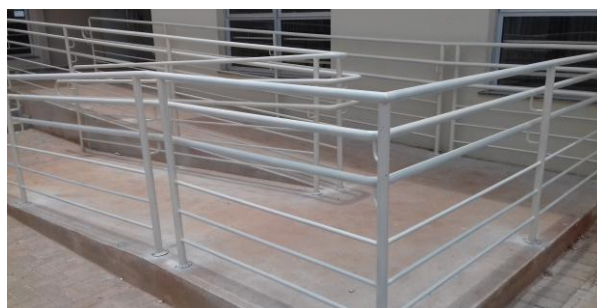
Figuras 18.5 e 18.6: Detalhe dos corrimãos (acima) e guarda-corpos (abaixo), com pintura finalizada, na rampa de acesso PNE
