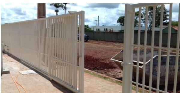
Figuras 18.7 e 18.8: Detalhe dos portões, após correção dos seus fechamentos
