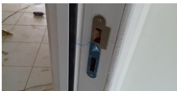
Figuras 7.8, 7.9 e 7.10: Na sequência, detalhes do acionador da barra de vedação do vão entre porta e soleira, borracha de vedação da folha da porta e, por fim, espelho de travamento da lingueta
