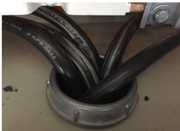
Figura 23 . 32 cabearno elétrico - ramais alimentadores
