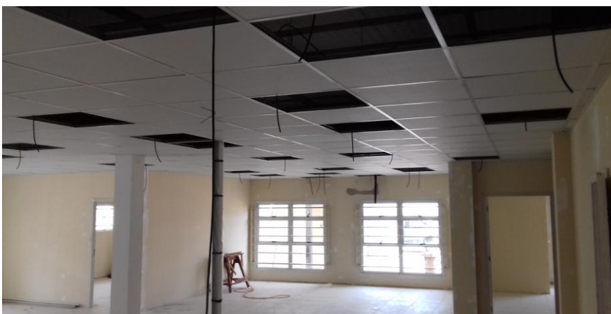
Figura 10.2: Forro em placas modulares de gesso acartonado, tamanho 62,5cm x 62,5cm, na secretaria
