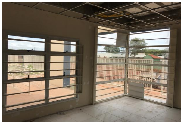
Figura 7.22: Grades de proteção do par de janelas J4, localizadas no PAB
