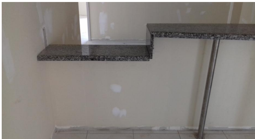
Figura 6.1: balcão de atendimento - rebaixo de acessibilidade PNE
