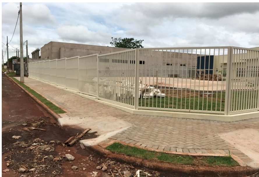
Figura 19.8: Gradis de fechamento com pintura finalizada. Na imagem, divisa esquerda do imóvel
