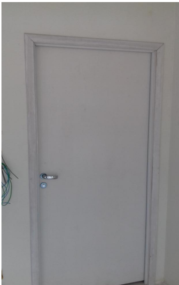
Figura 7.1: porta de madeira tamanho 90x210, instalada na entrada da sala técnica
