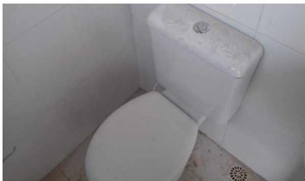
Figuras 15.10 e 15.11: Acima, bacia sanitária para PNE. Abaixo, bacia sanitária com caixa acoplada
