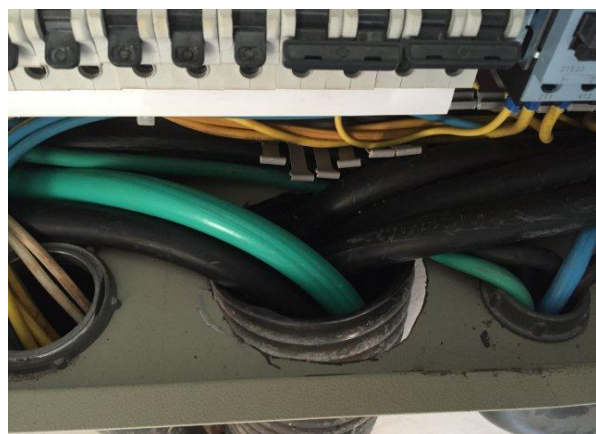
Figura 23 . 30 cabearno elétrico - ramais alimentadores
