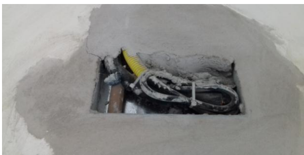
Figuras 16.1 e 16.2: Detalhe de redes frigoríficas com capacidade de 12.000 BTU/h, instaladas no atendimento (acima) e no gabinete do juiz auxiliar (abaixo)
