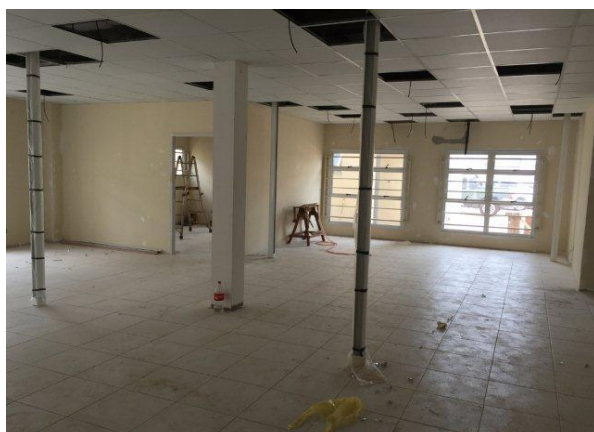
Figura 23 . 33 postes, totens e acessórios - coluna técnica 3m Dutotec
