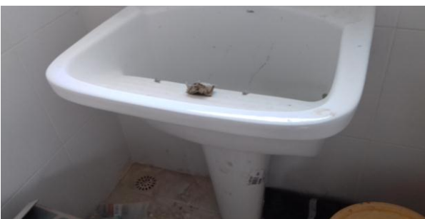
Figuras 15.13, 15.14, 15.15 e 15.16: Lavatório de louça com coluna, instalado nos sanitários não adaptados.
