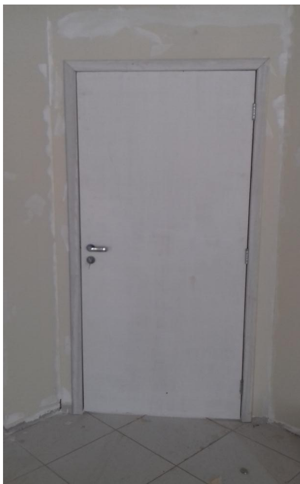
Figura 7.2: porta de madeira tamanho 90x210, instalada na entrada da secretaria
