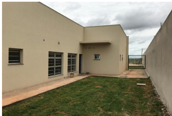
Figuras 19.6 e 19.7: Aplicação de textura na cor doric white, nas fachadas dos fundos do prédio principal e arquivo (lateral)
