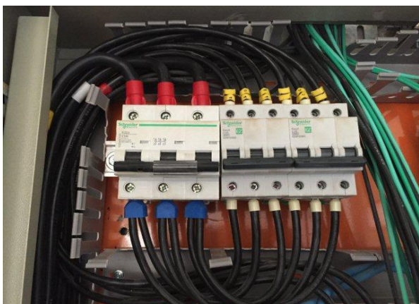
Figura 23 . 31 cabearno elétrico - ramais alimentadores
