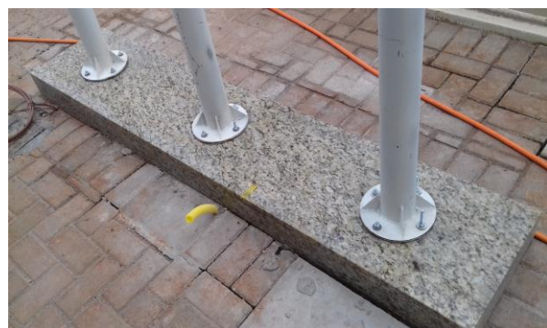
Figuras 20.1 e 20.2: Detalhe dos mastros para bandeiras, fixados sobre base de concreto revestida com granito
