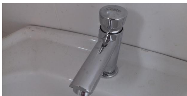
Figuras 15.24 e 15.25: Torneiras de pressão com desligamento automático, instaladas em todos os sanitário
