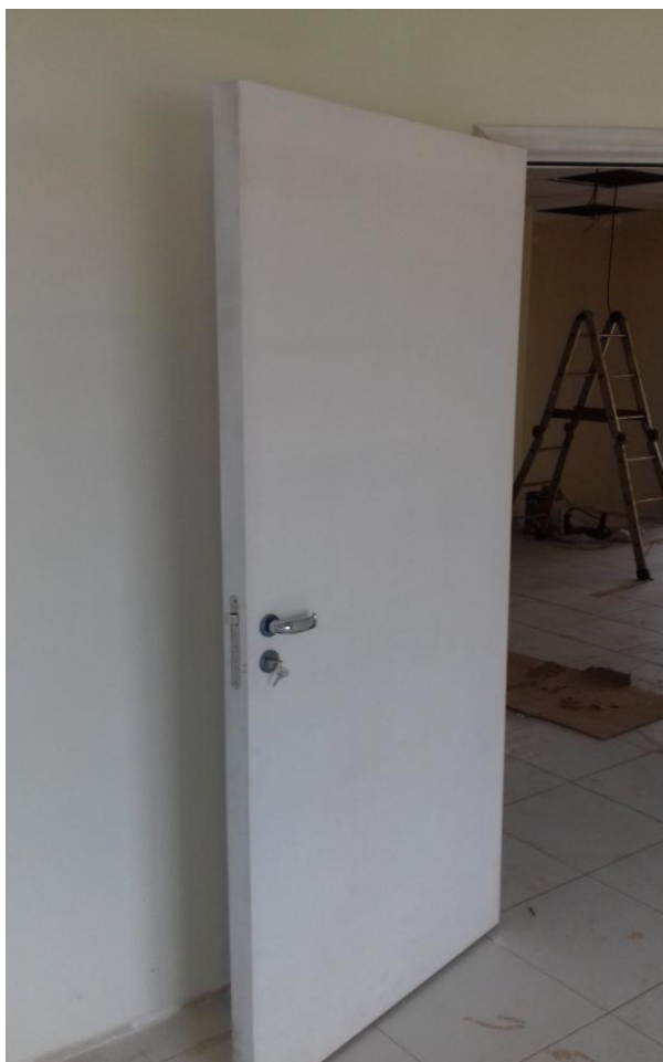
Figura 7.7: Porta de madeira, acústica, tamanho 90x210, instalada na entrada da sala de audiência 2
