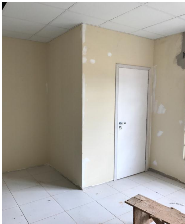
Figura 7.13: Porta 70x210, de madeira, instalada no gabinete do juiz titular
