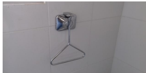
Figuras 15.32 e 15.33: Detalhe de acionador de válvula. Na primeira imagem, sem a barra e na segunda com a barra de acionamento para portadores de necessidades especiais. Banheiro PNE público
