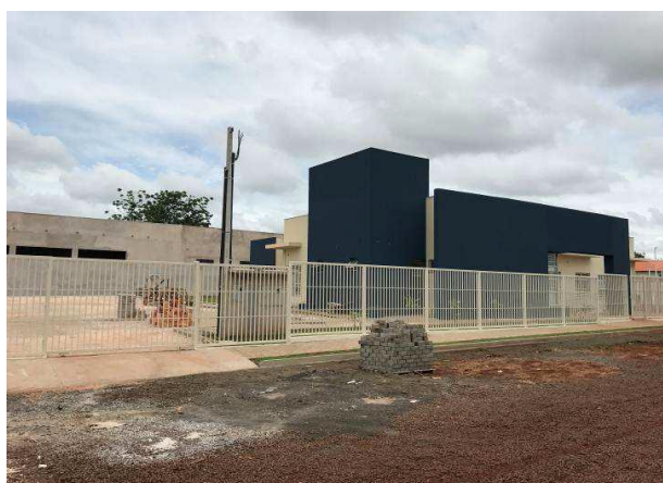
Figura 2 – Vista externa do imóvel - vista 1
