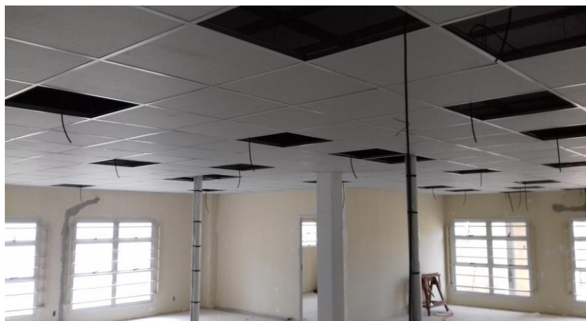
Figura 4 – Vista interna do imóvel
