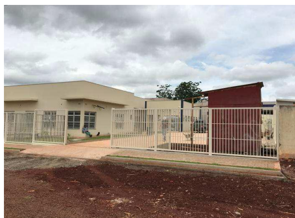
Figura 3 – Vista externa do imóvel - vista 2
