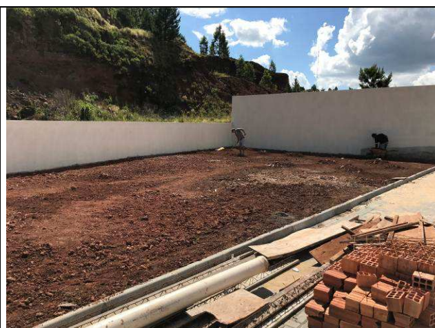
Figura 96C: Pintura em muros.
