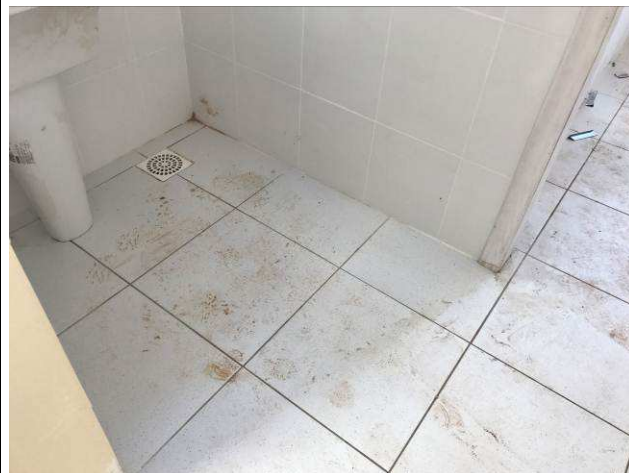
Figura 39C: Piso cerâmico - área de serviço.
