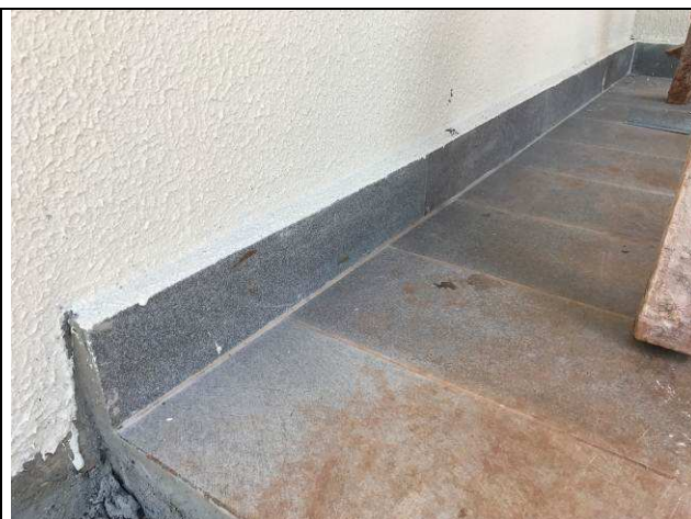
Figura 49C: Rodapé em basalto.
