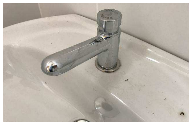
Figura 67C: Torneira de pressão com fechamento automático - lavatórios.
