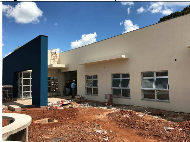
Figura 107C: Pintura das paredes externas.
