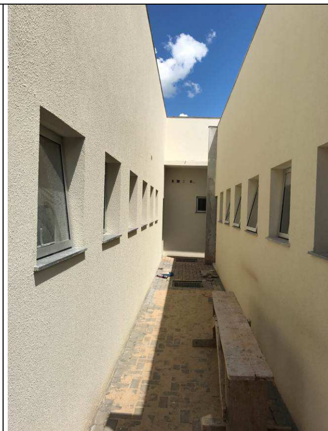
Figura 112C: Pintura das paredes externas.
