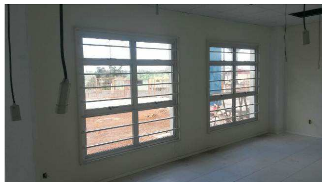
Figura 21C: Grades metálicas - Janelas J01.
