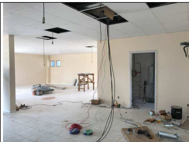
Figura 100C: Pintura das paredes internas.
