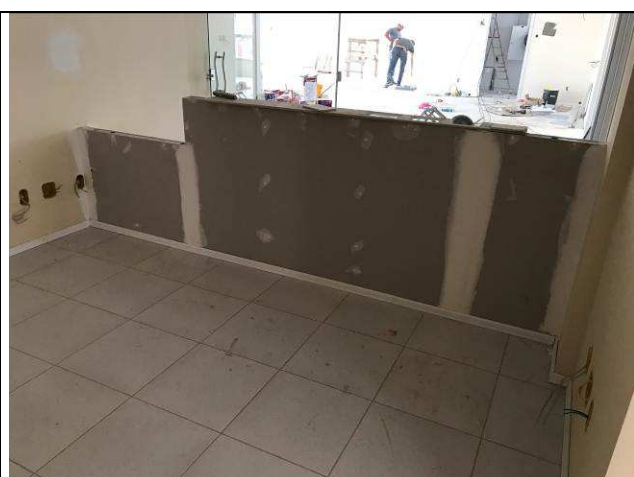
Figura 02C: Divisória em gesso acartonado do balcão de atendimento.
