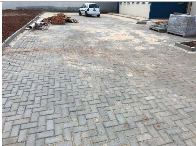
Figura 90C: Pavimentação com blocos de concreto intertravados.
