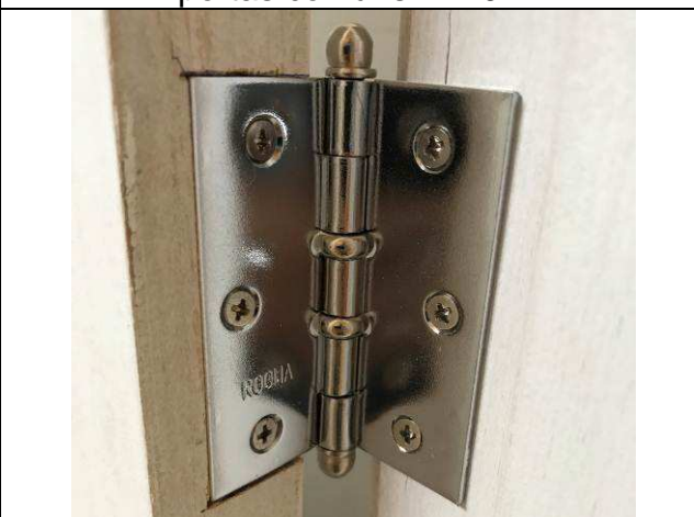
Figura 15C: Dobradiças com rolamento - portas comuns.
