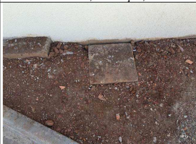
Figura 04E: infraestrutura externa - eletroduto 40mm, escavação, reaterro.
