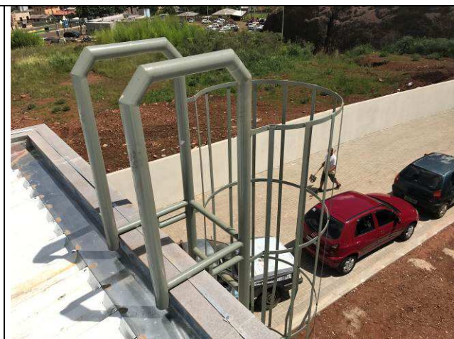
Figura 114C: Escada marinheiro.
