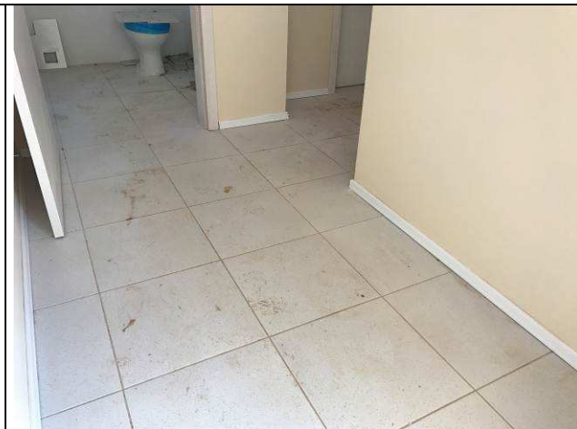
Figura 43C: Rodapé em poliestireno.
