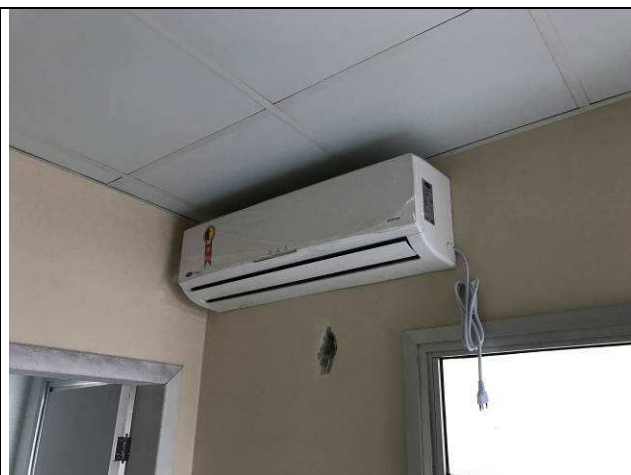
Figura 77C: Evaporadora - 18.000 BTU's - gabinete do juiz titular.
