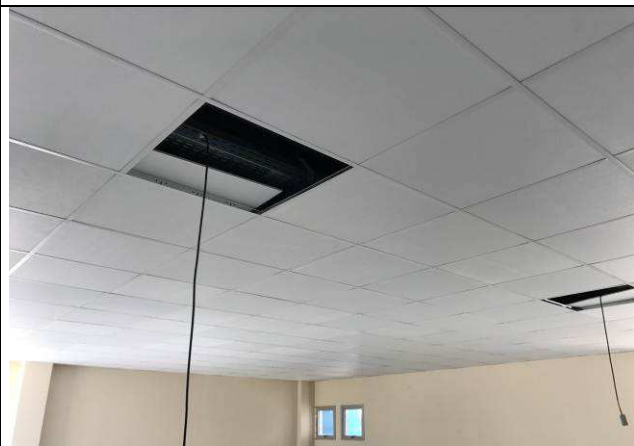
Figura 33C: Forro modular instalado - PAB.
