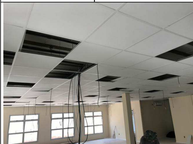
Figura 30C: Forro modular instalado - secretaria.
