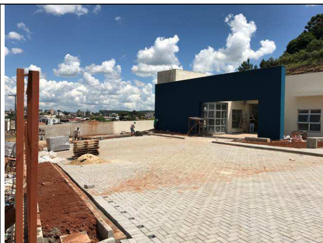
Figura 94C: Pavimentação com blocos de concreto intertravados.
