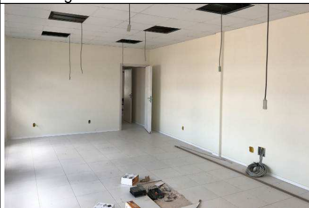
Figura 98C: Pintura das paredes internas.
