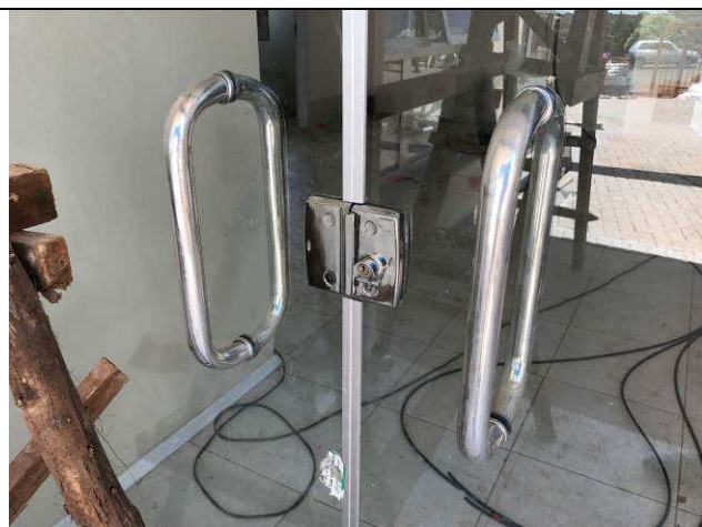
Figura 17C: Esquadria de alumínio - puxadores da porta P04 VT.
