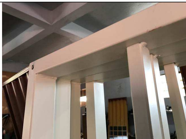
Figura 20C: Grades metálicas - detalhe de canto - Janelas J01.
