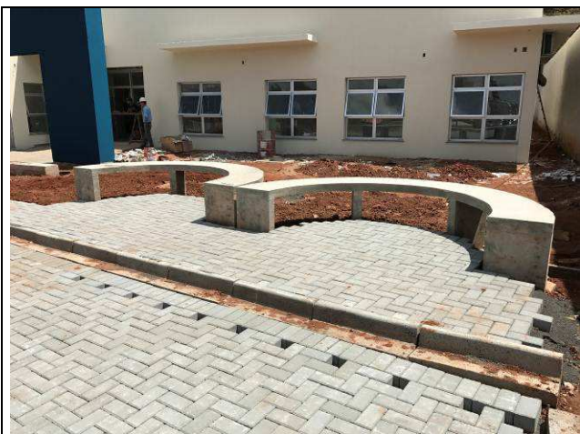
Figura 113C: Bancos em concreto.
