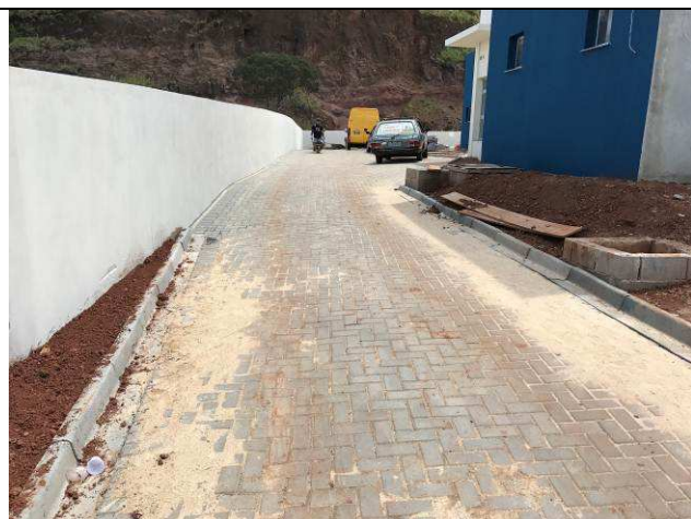
Figura 93C: Pavimentação com blocos de concreto intertravados.
