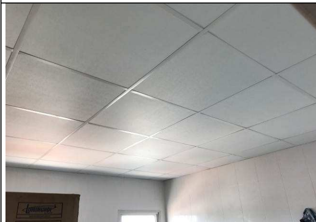
Figura 32C: Forro modular instalado - copa.
