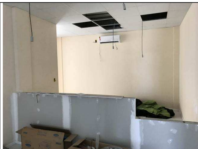
Figura 99C: Pintura das paredes internas.
