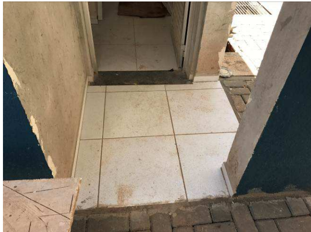
Figura 40C: Piso cerâmico - entrada do arquivo.
