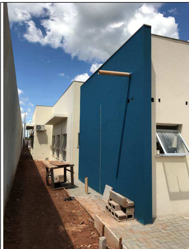
Figura 111C: Pintura das paredes externas.
