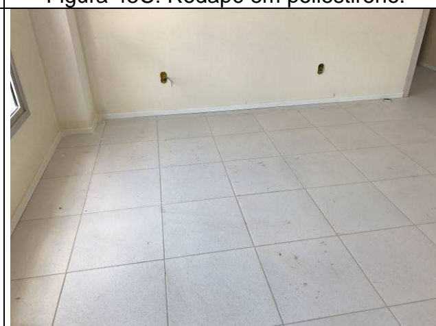
Figura 47C: Rodapé em poliestireno.
