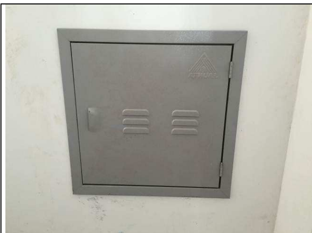
Figura 31E: quadro de equipotencialização de aterramentos
