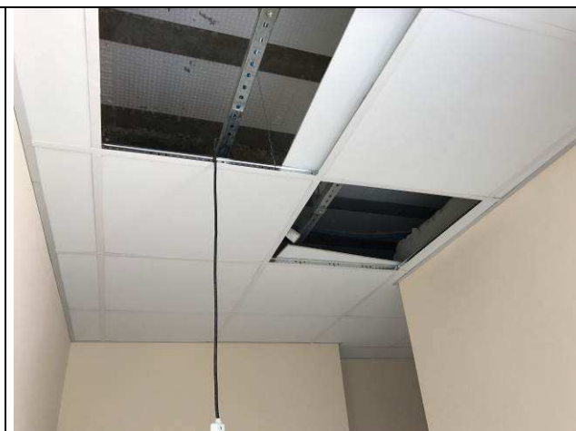
Figura 35C: Forro modular instalado - hall dos banheiros públicos.
