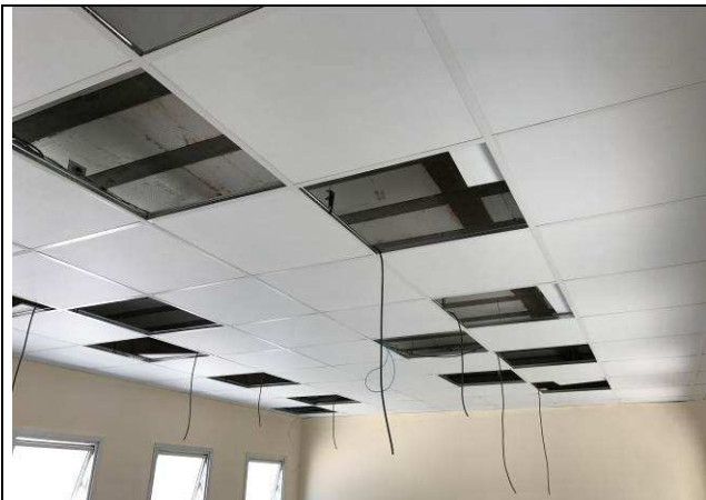
Figura 28C: Forro modular instalado - arquivo.
