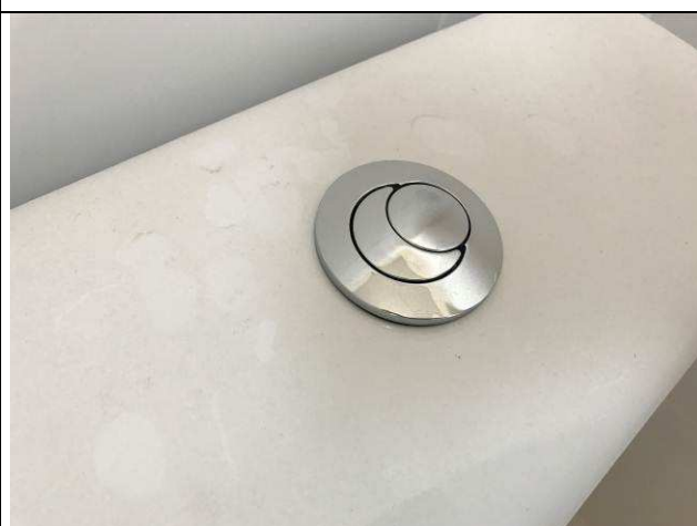
Figura 69C: Caixa acoplada com duplo botão de acionamento.
