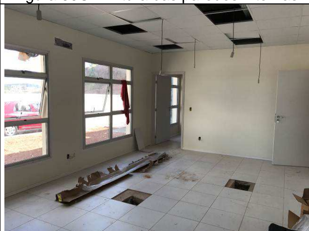
Figura 101C: Pintura das paredes internas.
