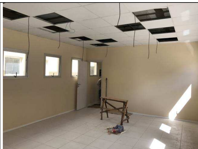
Figura 106C: Pintura das paredes internas.
