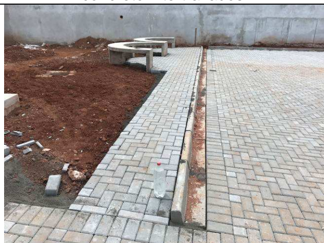
Figura 91C: Pavimentação com blocos de concreto intertravados.
