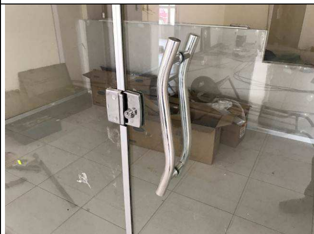
Figura 16C: Esquadria de alumínio - puxadores da porta P03 VT.
