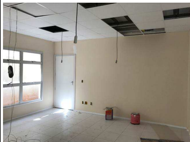
Figura 104C: Pintura das paredes internas.
