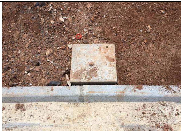
Figura 01E: infraestrutura externa - eletroduto 40mm, escavação, reaterro.
