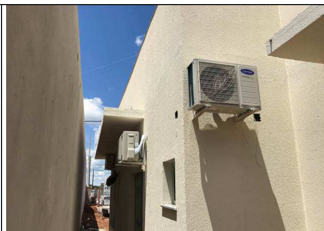
Figura 73C: Condensadoras - balcão, gabinete do juiz titular e sala pré-acordo.
