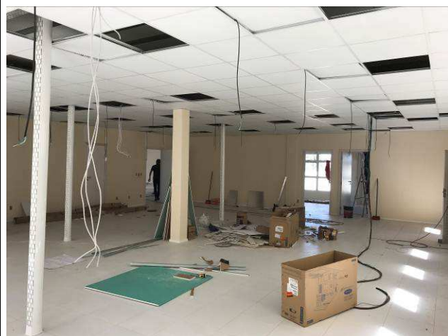
Figura 103C: Pintura das paredes internas.
