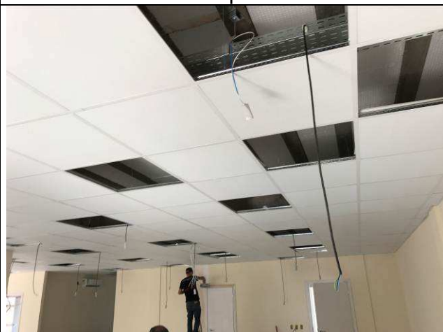
Figura 31C: Forro modular instalado - secretaria.
