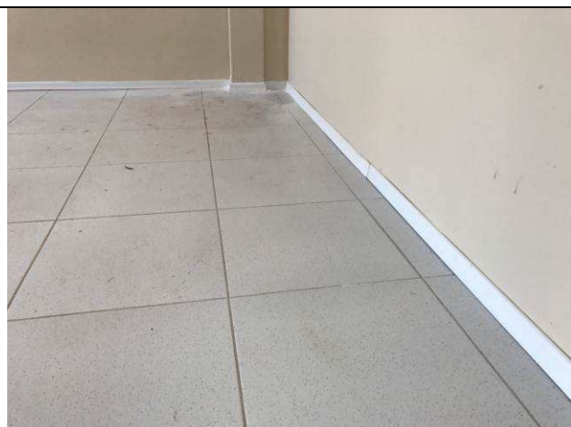
Figura 48C: Rodapé em poliestireno.
