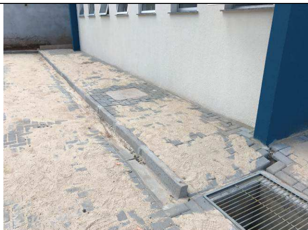
Figura 84C: Pavimentação com blocos de concreto intertravados.
