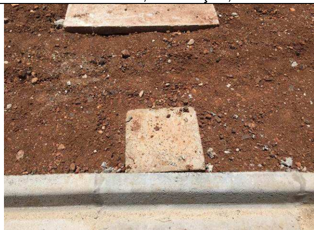
Figura 03E: infraestrutura externa - eletroduto 40mm, escavação, reaterro.
