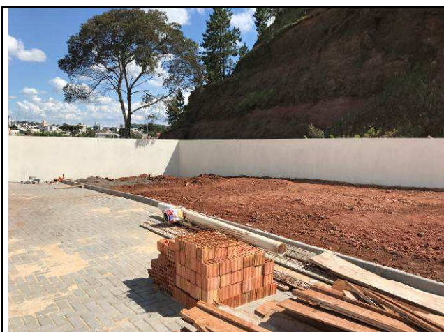
Figura 95C: Pintura em muros.
