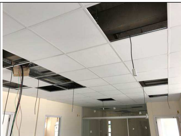
Figura 34C: Forro modular instalado - hall público.
