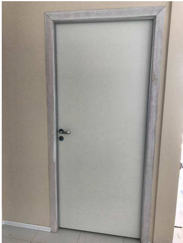
Figura 07C: Esquadria de madeira - portas acústicas PM 01 A.
