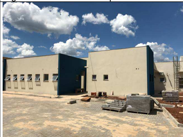
Figura 110C: Pintura das paredes externas.
