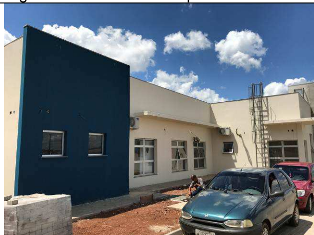
Figura 109C: Pintura das paredes externas.
