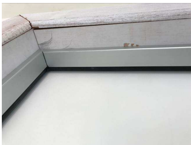
Figura 09C: Vedações de borracha - portas acústicas PM 01 A.
