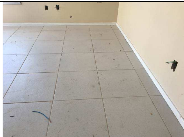
Figura 42C: Rodapé em poliestireno.
