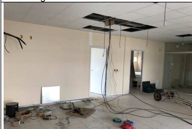
Figura 97C: Pintura das paredes internas.
