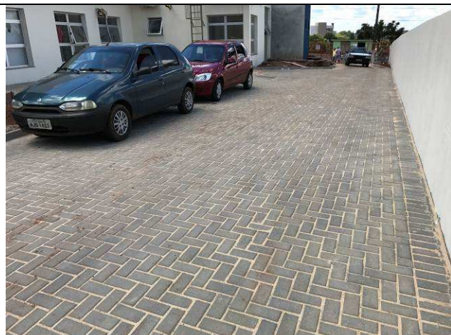
Figura 89C: Pavimentação com blocos de concreto intertravados.
