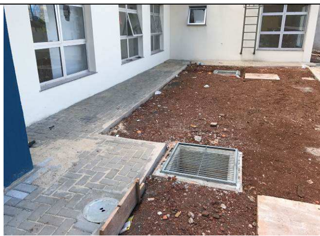
Figura 88C: Pavimentação com blocos de concreto intertravados.
