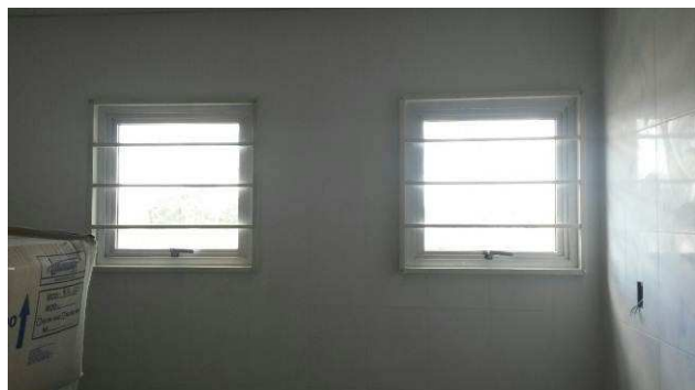
Figura 25C: Grades metálicas - Janelas J02.
