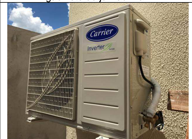
Figura 74C: Condensadora - 12.000 BTU's.
