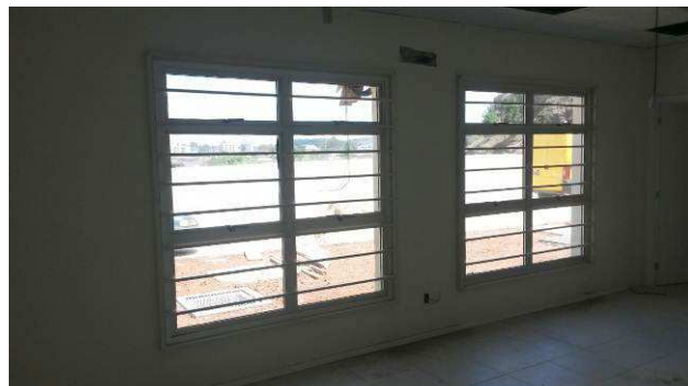
Figura 24C: Grades metálicas - Janelas J01.
