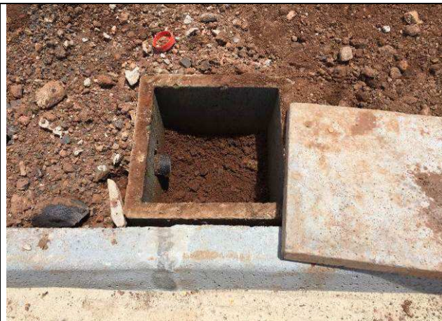
Figura 02E: infraestrutura externa - eletroduto 40mm, escavação, reaterro.
