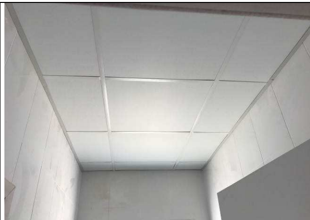
Figura 29C: Forro modular instalado - copa do arquivo.
