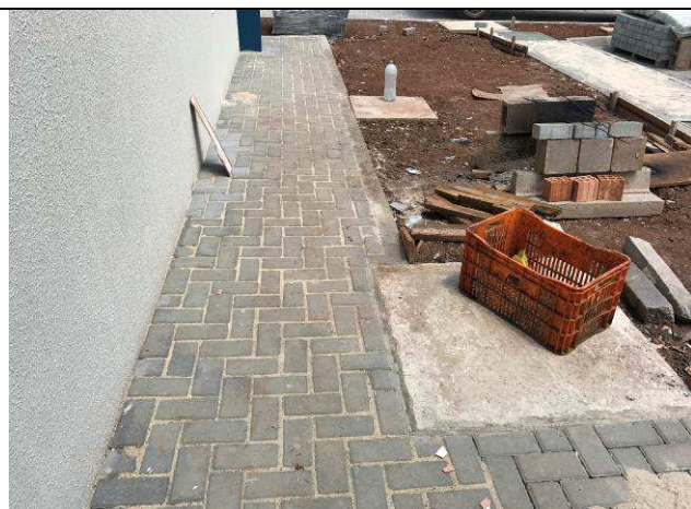
Figura 87C: Pavimentação com blocos de concreto intertravados.
