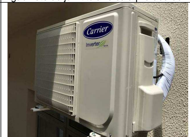
Figura 75C: Condensadora - 18.000 BTU's.
