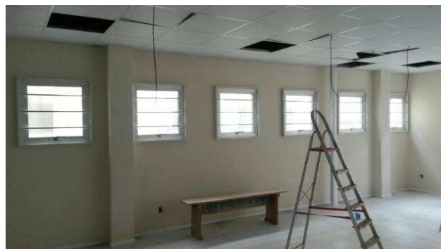
Figura 26C: Grades metálicas - Janelas J02.
