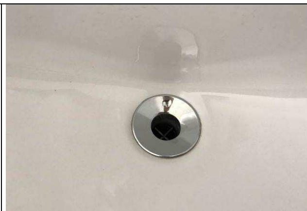
Figura 71C: Válvulas cromadas.
