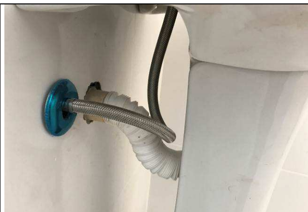
Figura 70C: Engates com malha de aço cromada.
