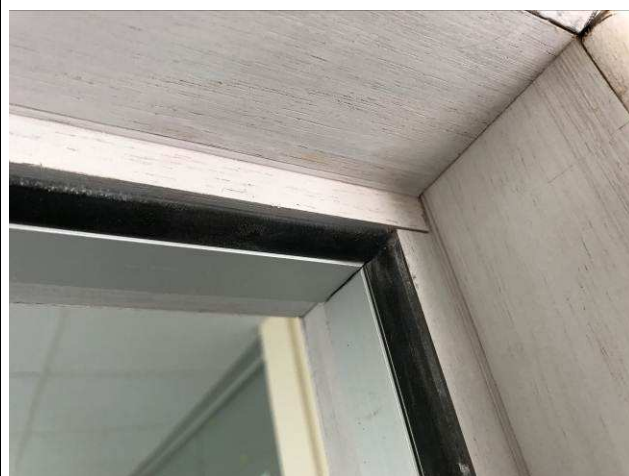
Figura 10C: Vedações de borracha - portas acústicas PM 01 A.
