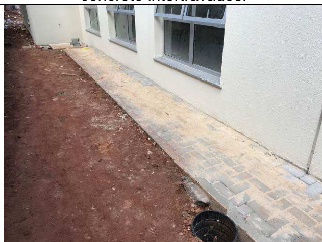
Figura 86C: Pavimentação com blocos de concreto intertravados.
