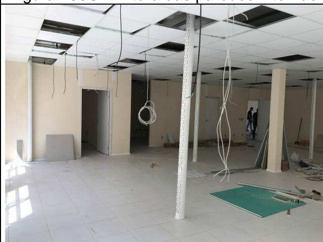
Figura 102C: Pintura das paredes internas.
