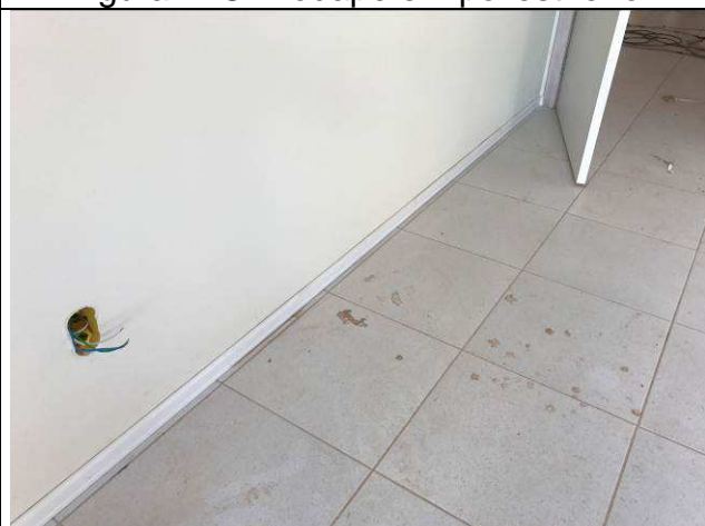
Figura 44C: Rodapé em poliestireno.
