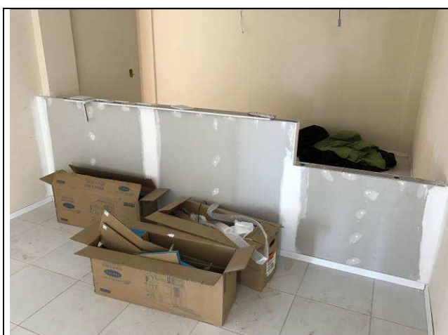
Figura 01C: Divisória em gesso acartonado do balcão de atendimento.
