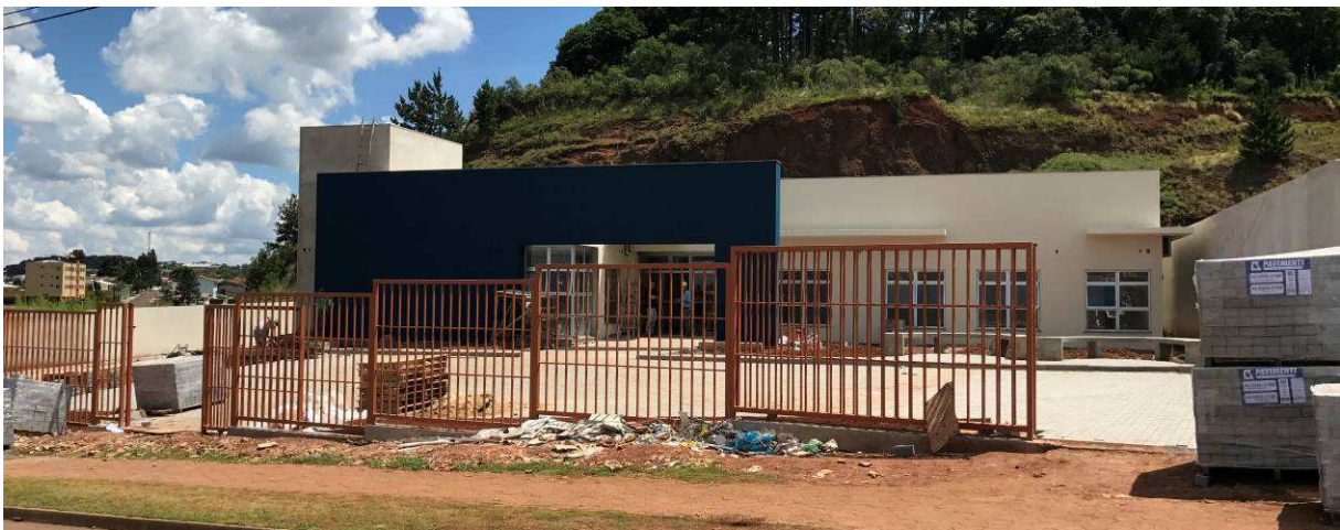
Figura 1 – Vista externa - frente.
