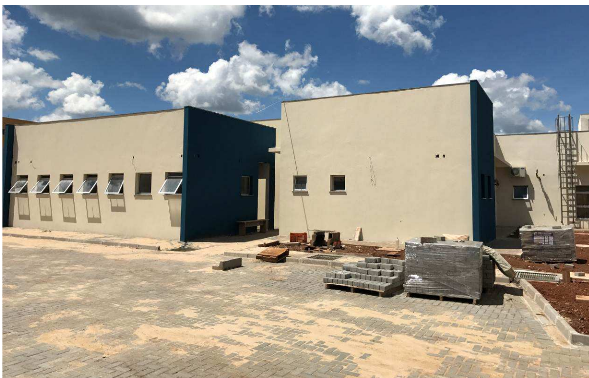
Figura 3 – Vista externa - fundos.
