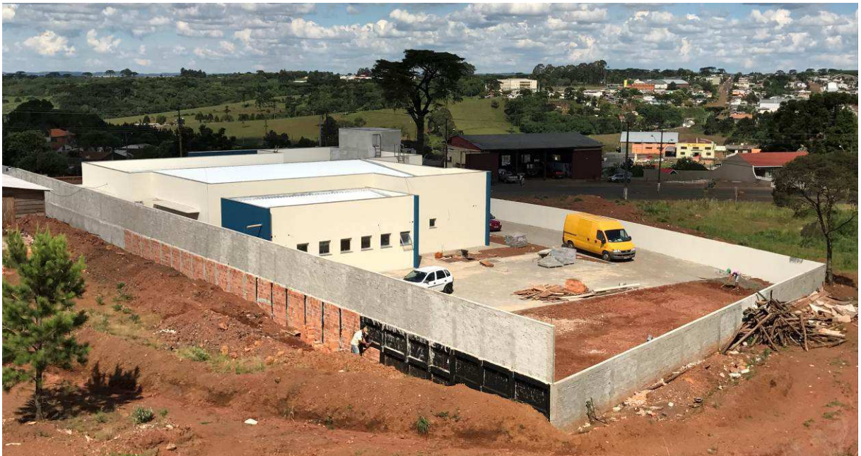
Figura 6 – Vista externa - geral.
