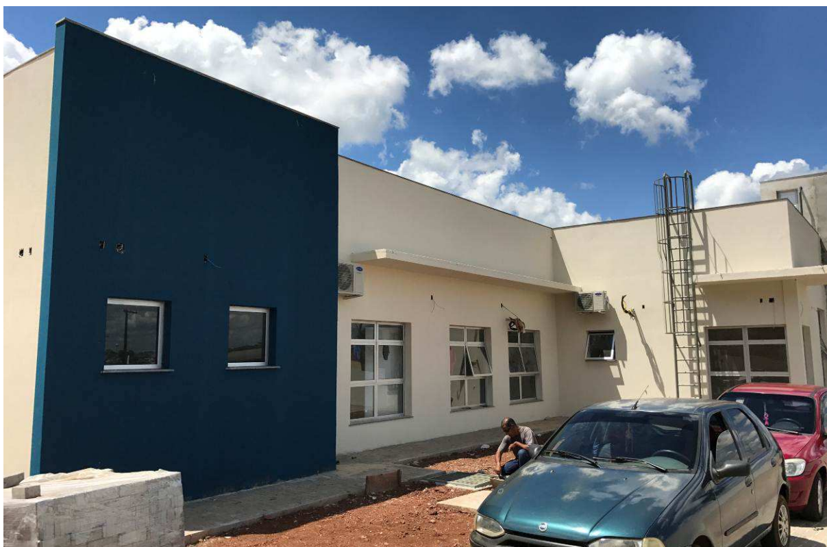
Figura 4 – Vista externa - lateral esquerda.
