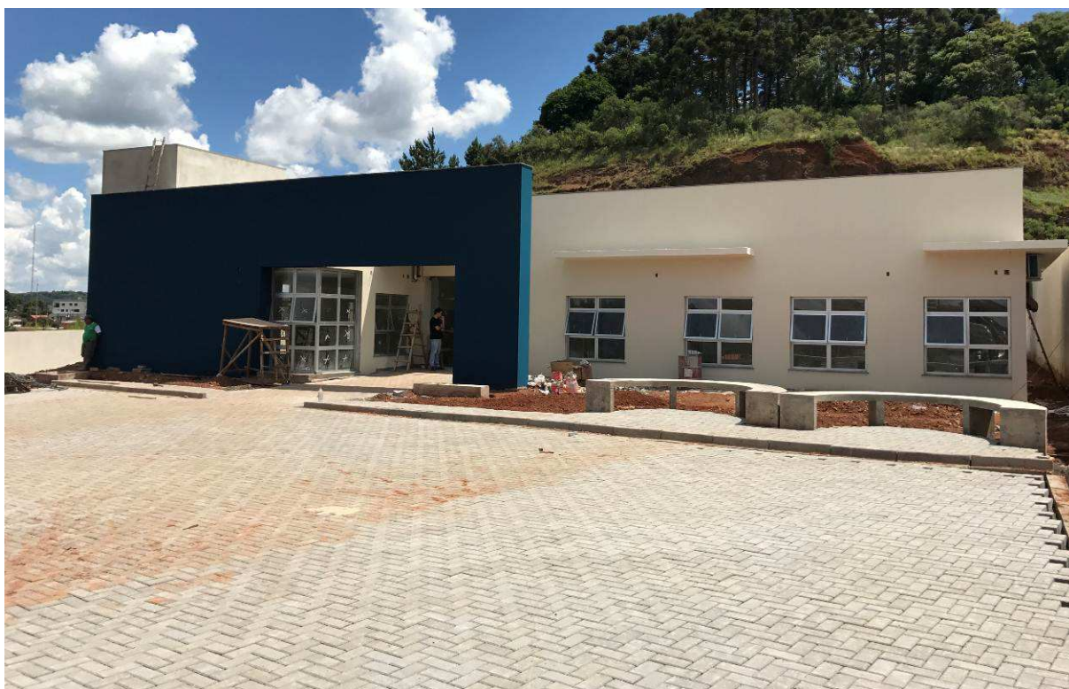
Figura 2 – Vista externa - frente.
