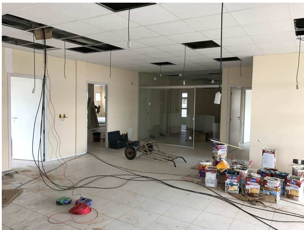
Figura 8 – Vista interna - hall público.
