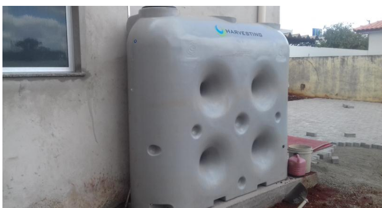
Figura 15.2: O sistema de by-pass/extravasão e alimentação ainda não estão ligados.
