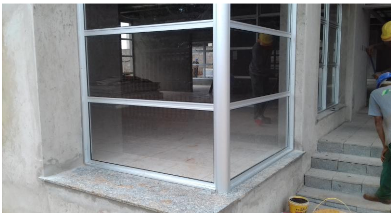
Figura 7.18: Detalhe das janelas de 160x280cm, instaladas no PAB.
