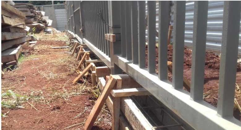
Figura 18.14: Fôrmas e ferragens da baldrame que sustenta o gradil metálico.
