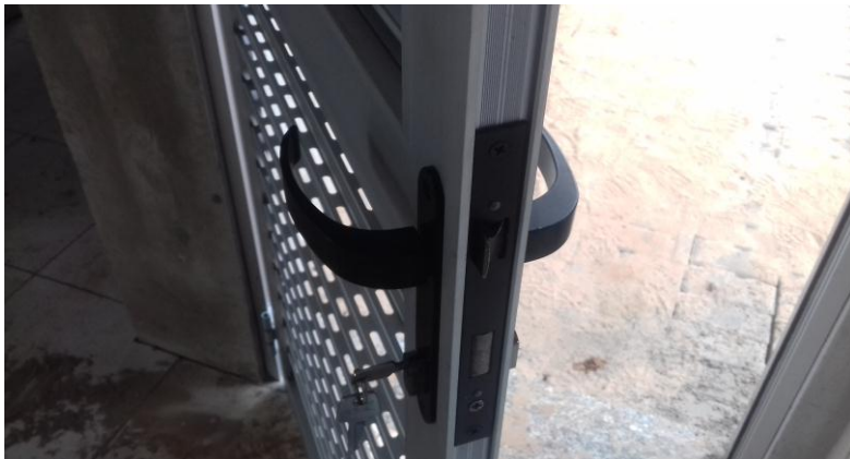
Figura 7.4: Detalhe de guarnição e sistema de dobradiça de encaixe e aperto.
