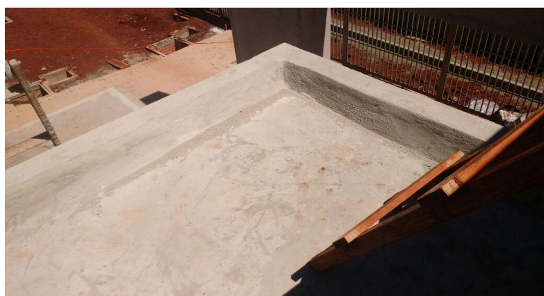
Figura 26.4: Camada de proteção mecânica aplicada sobre manta asfáltica.
