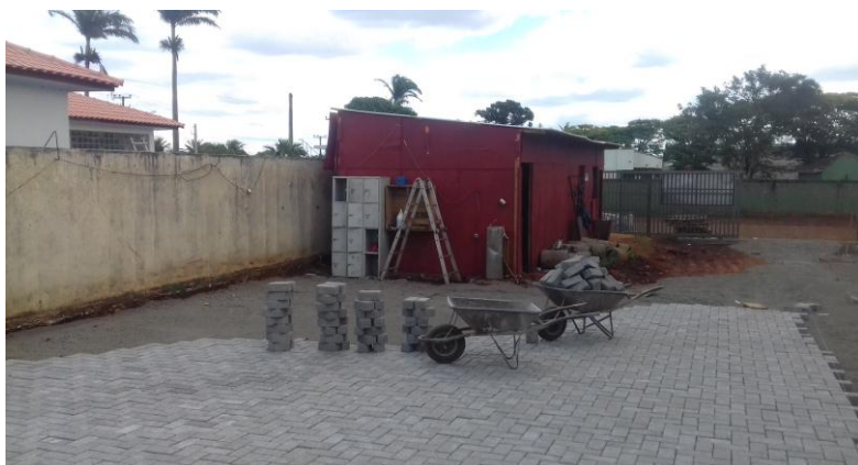
Figura 18.4: Piso intertravado de concreto (paver) sendo instalado no estacionamento privativo.
