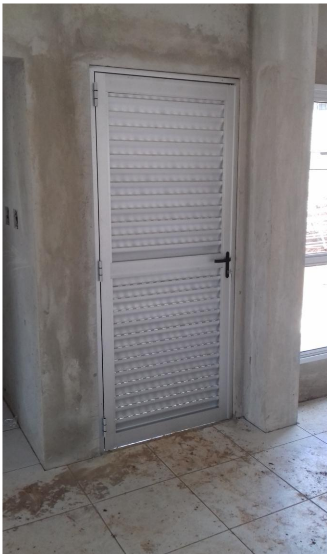
Figura 7.2: Porta de alumínio 90x210cm, tipo veneziana, instalada na entrada do arquivo.
