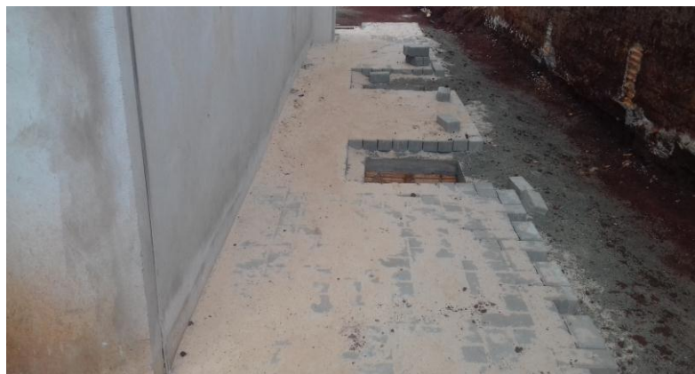
Figura 18.10: Calçamento e, paver, no entorno do prédio principal (próximo à sala da OAB)
