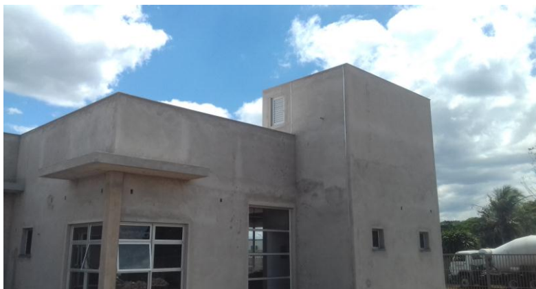
Figura 12.2: Detalhe das marquizes com rebôco finalizado.
