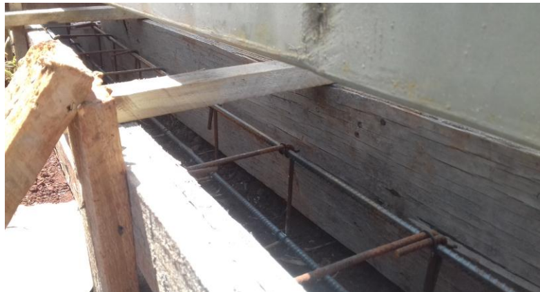
Figura 18.15: Gradil metálico "ancorado" na viga baldrame, após concretagem da mesma.
