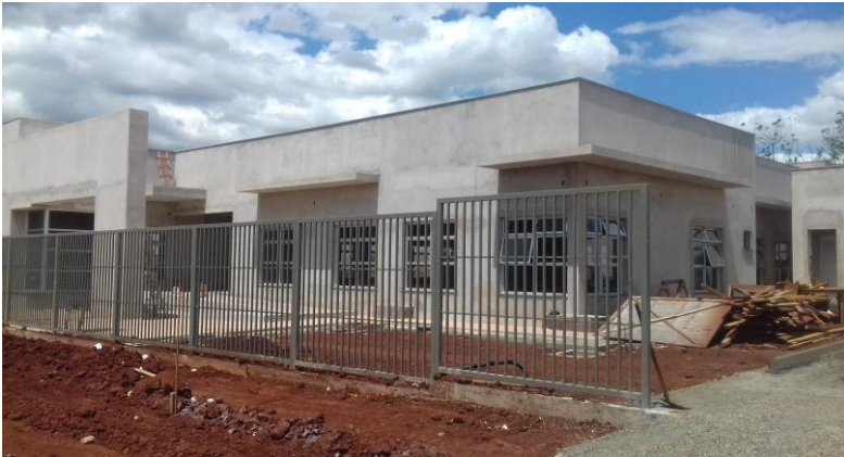
Figura 18.18: Gradil em metalon, visto pelo lado de dentro do imóvel.
