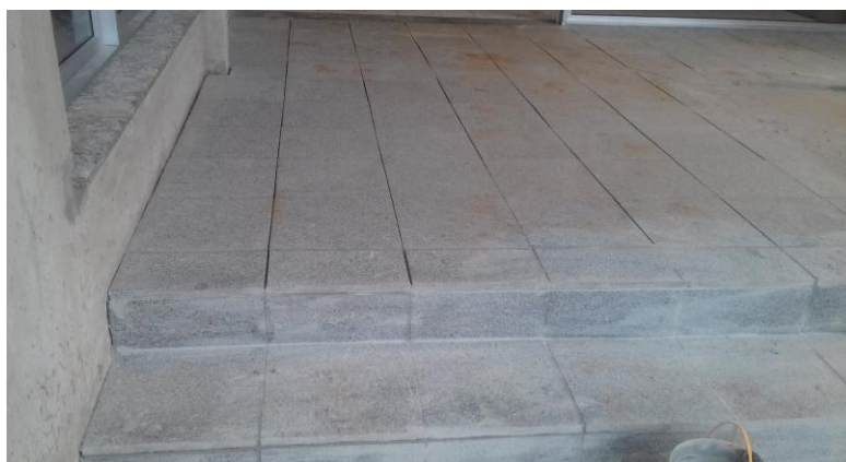
Figura 13.5: detalhe da soleira, dividindo o piso cerâmico da pedra, no patamar do hall de acesso ao imóvel.
