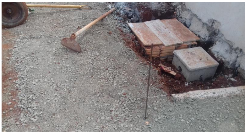
Figura 18.2: Camada de base aplicada e aguardando o assentamento do paver
