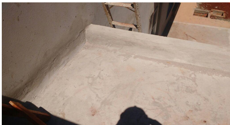
Figura 26.3: Camada de proteção mecânica aplicada sobre manta asfáltica.
