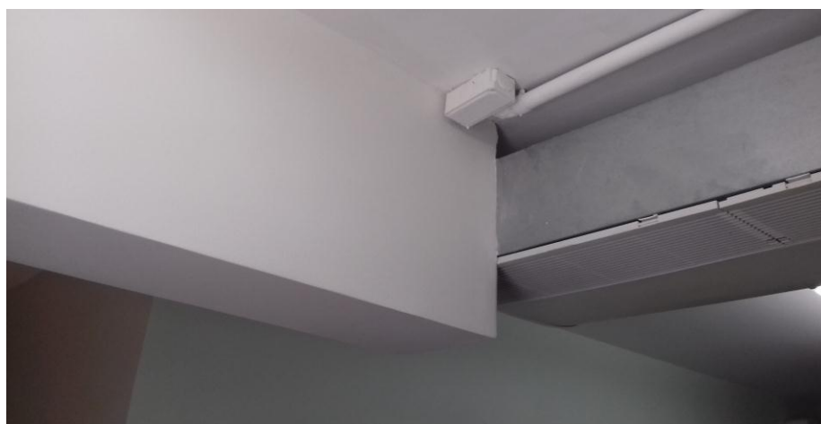
Figura 14.15 - Fechamento dos dutos frigoríficos e de drenagem com uso de gesso acartonado (viga falsa) e aplicação de eletrodutos de PVC para ocultar os cabos de alimentação do ar condicionado.
