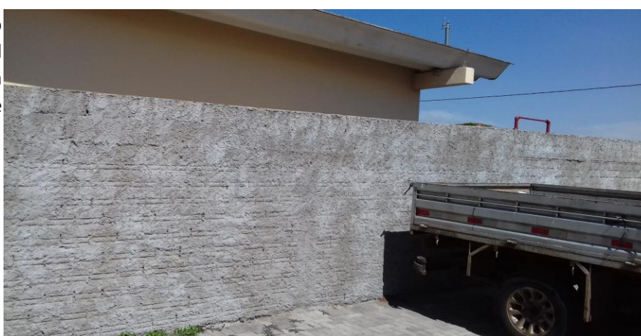
Figura 14.22 - Chapisco executado no muro lateral esquerdo (estacionamento), na divisa com o corpo de bombeiros.
