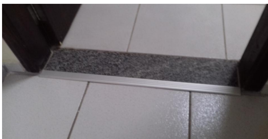
Figura 14.13 - Realização de adequação do encontro do piso com soleira, no final da escada de acesso restrito. A junta de dilatação foi tratada, três peças de piso foram substituídas e foi instalada chapa de alumínio.
