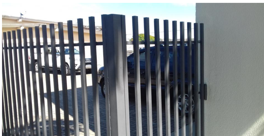
Figura 14.7 - Pintura do gradil frontal, localizado no fechamento do estacionamento privativo. Aplicado esmalte sintético na cor grafite.
