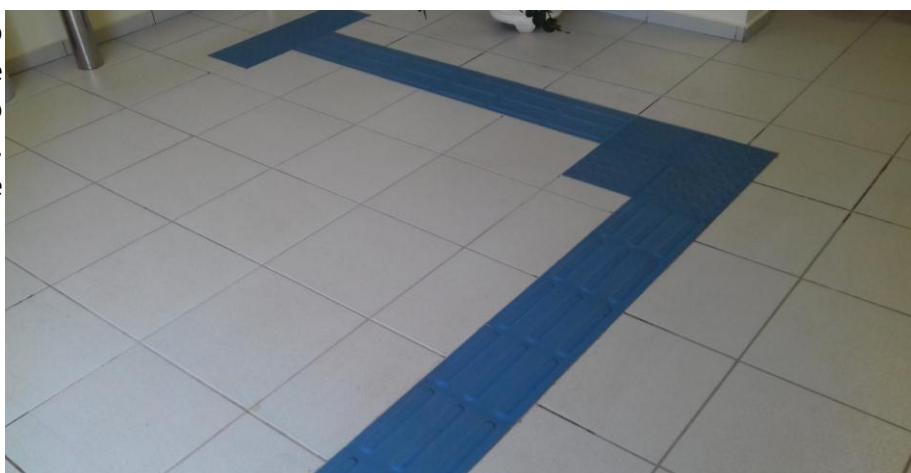
Figura 14.20 - Trecho de piso direcional, saindo da porta de entrada e se dirigindo ao balcão de atendimento. Também, sinalização de alerta na curva e na chegada ao balcão.
