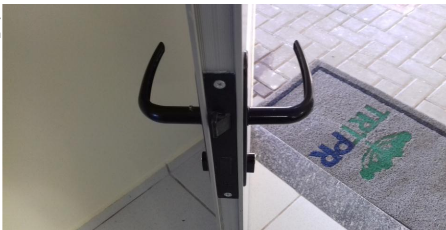
Figura 14.18 - No detalhe, maçaneta e fechadura da porta de alumínio instalada.
