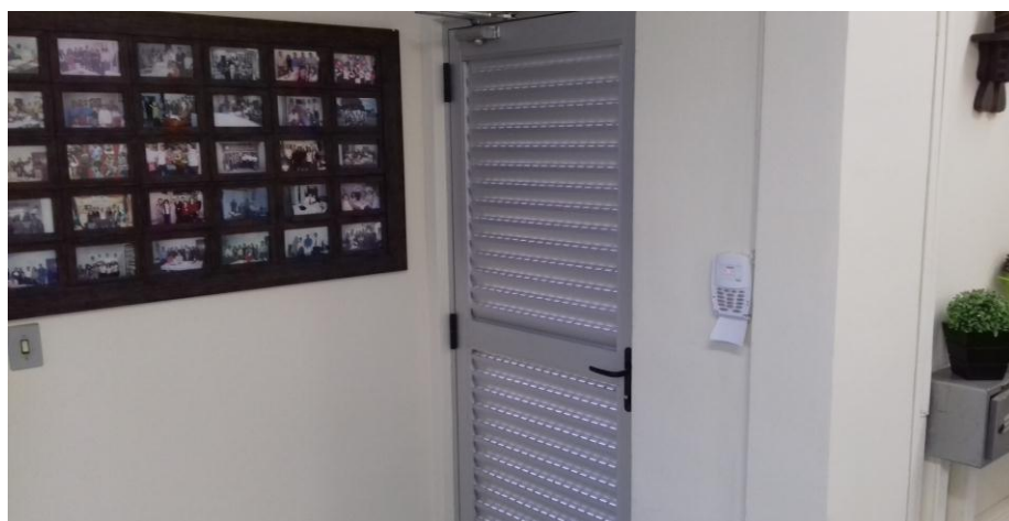
Figura 14.17 - Instalação de porta de alumínio tipo veneziana, entre a secretaria e o estacionamento coberto.
