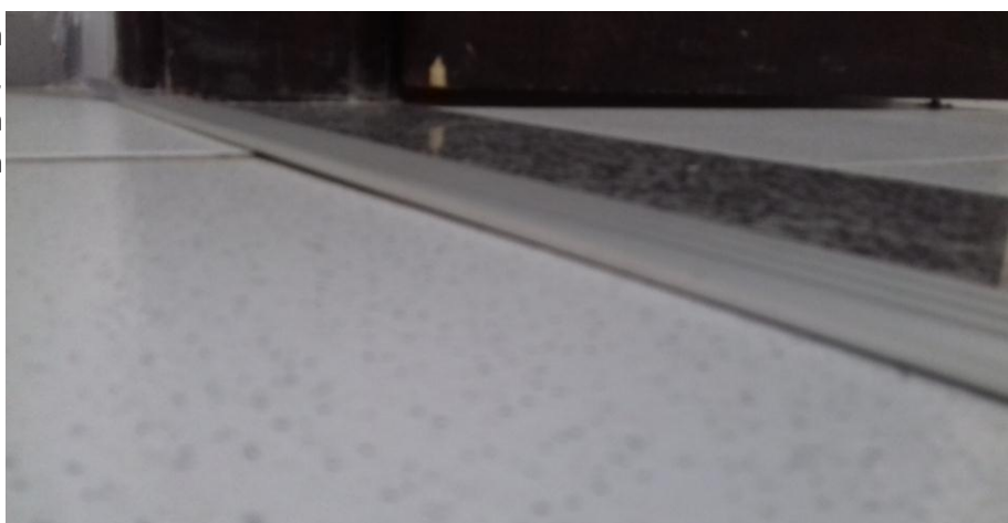
Figura 14.14 - Detalhe da aplicação de chapa de alumínio, para dar acabamento estético à junta de dilatação tratada sem criar obstáculo na passagem.
