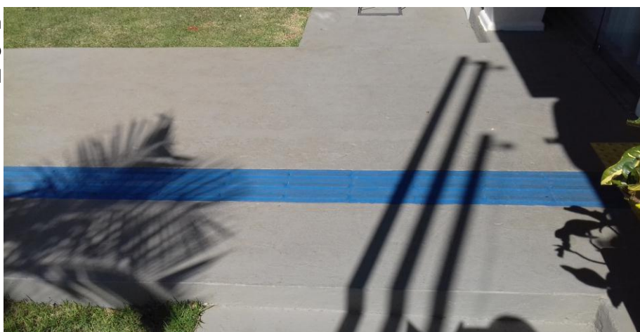
Figura 14.26 - Detalhe da pintura da calçada de acesso ao imóvel e do piso podotátil direcional.
