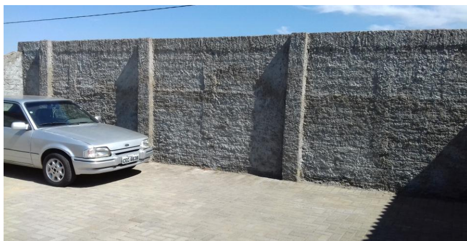
Figura 14.21 - Execução de chapisco no muro localizado nos fundos do imóvel (porção do estacionamento privativo), após a remoção das trepadeiras existentes.
