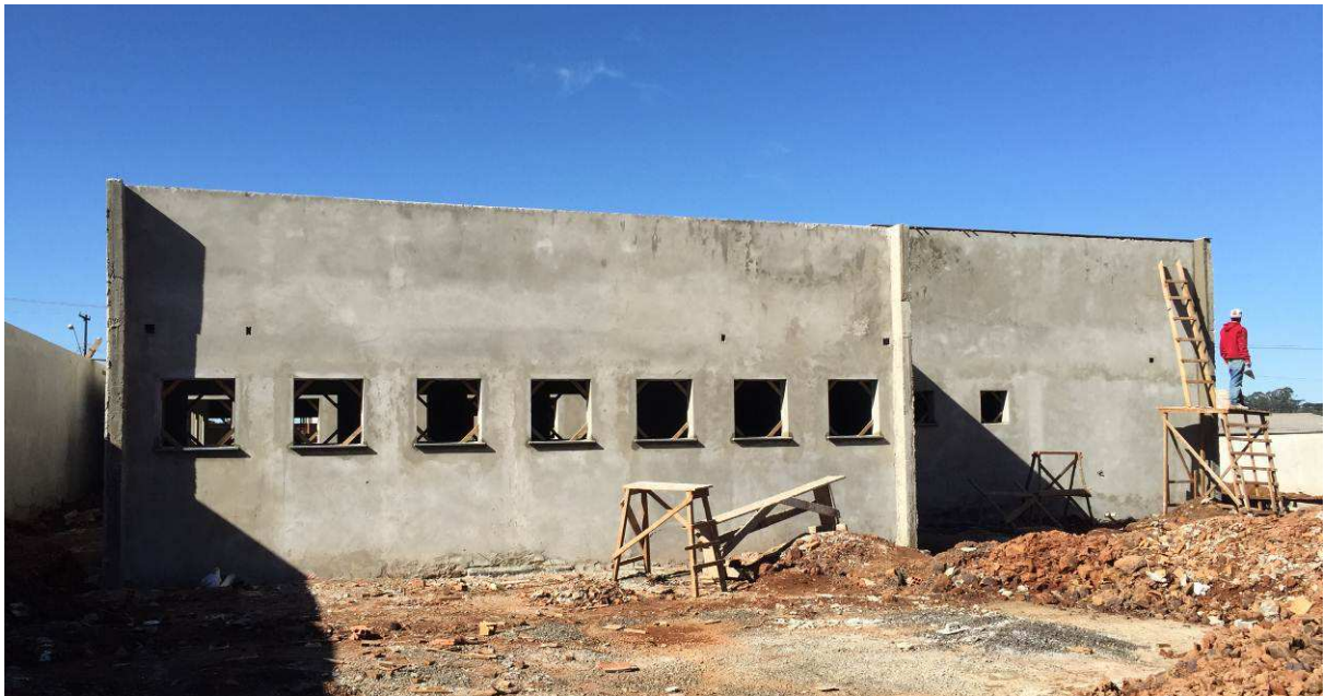
Figura 2 – Vista externa - fundos.
