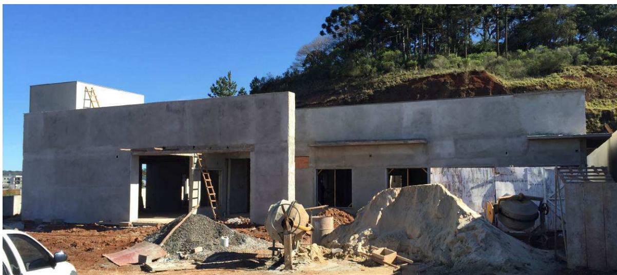
Figura 1 – Vista externa - frente.
