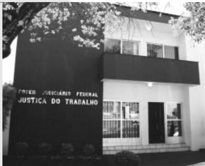
A sede da Vara do Trabalho de Toledo, reformada e ampliada
