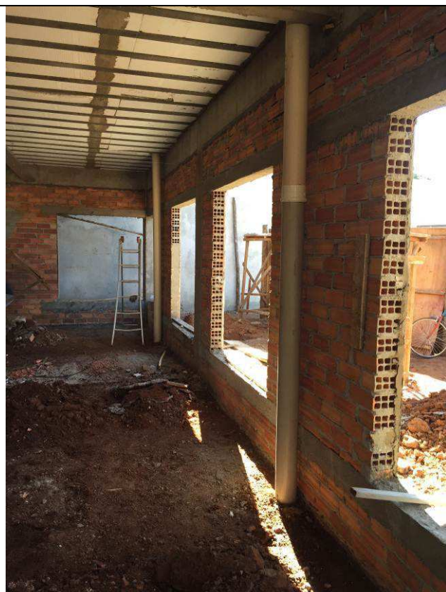
Figura 67C: Tubulação Ø 150 mm - descidas de águas pluviais.
