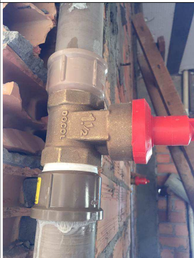
Figura 62C: Registro de gaveta Ø 1.1/2" para válvula de descarga.
