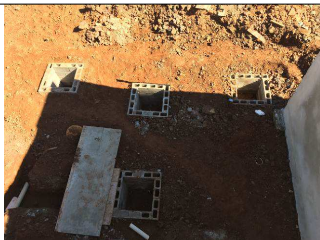
Figura 71C: Caixas de inspeção de esgoto e águas pluviais.
