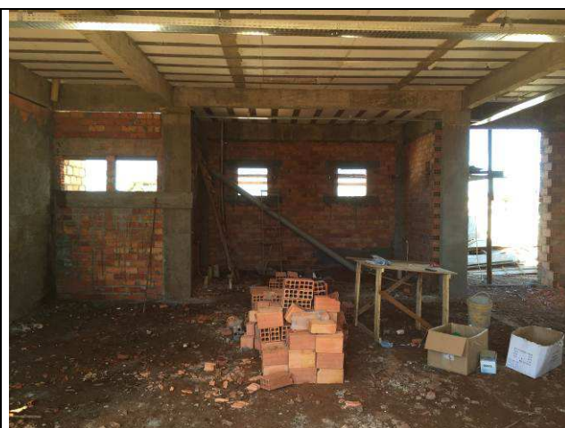
Figura 14C: Alvenarias - prédio principal.
