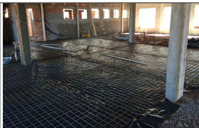
Figura 22C: Impermeabilização com lona plástica sobre a camada de brita.
