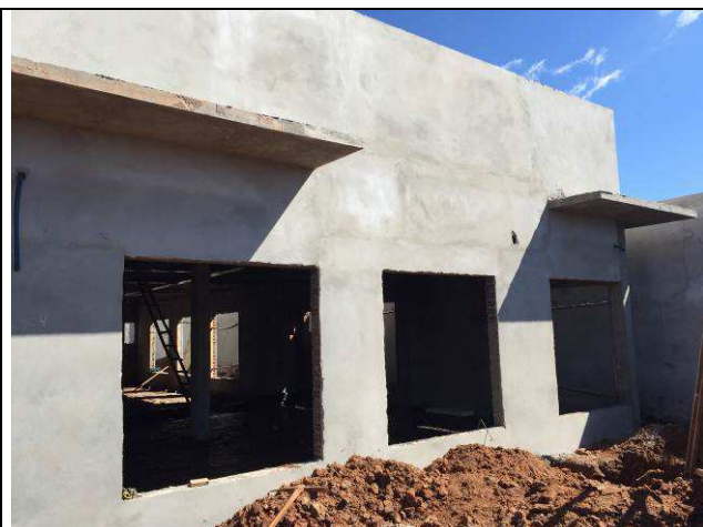
Figura 44C: Chapisco e emboço - face externa das alvenarias.
