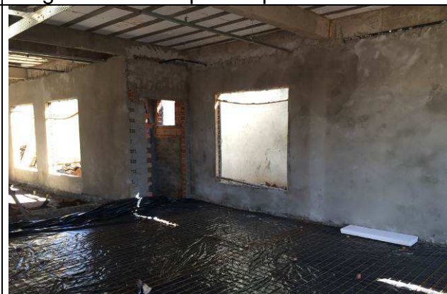
Figura 28C: Chapisco e emboço - paredes internas.
