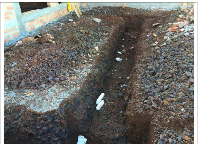
Figura 02C: Escavação de valas - redes de esgoto e águas pluviais.
