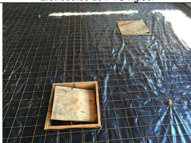
Figura 27E: Infraestrutura interna - Eletrodutos de PVC embutidos no piso.
