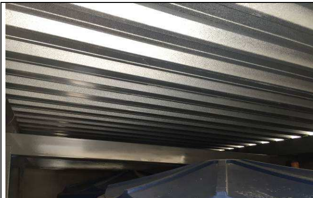
Figura 19C: Cobertura com telhas tipo "sanduíche" - caixas d'água.
