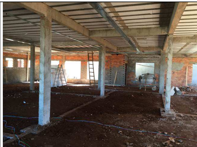
Figura 16C: Alvenarias - prédio principal.
