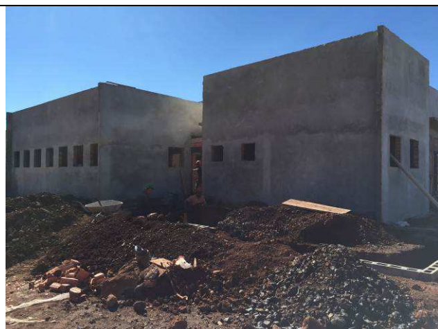
Figura 39C: Chapisco e emboço - face externa das alvenarias.
