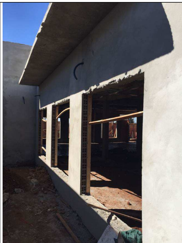
Figura 36C: Chapisco e emboço - face externa das alvenarias.
