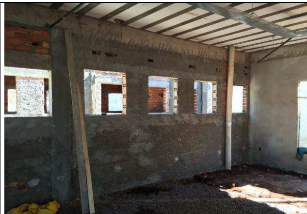
Figura 25C: Chapisco - paredes internas.
