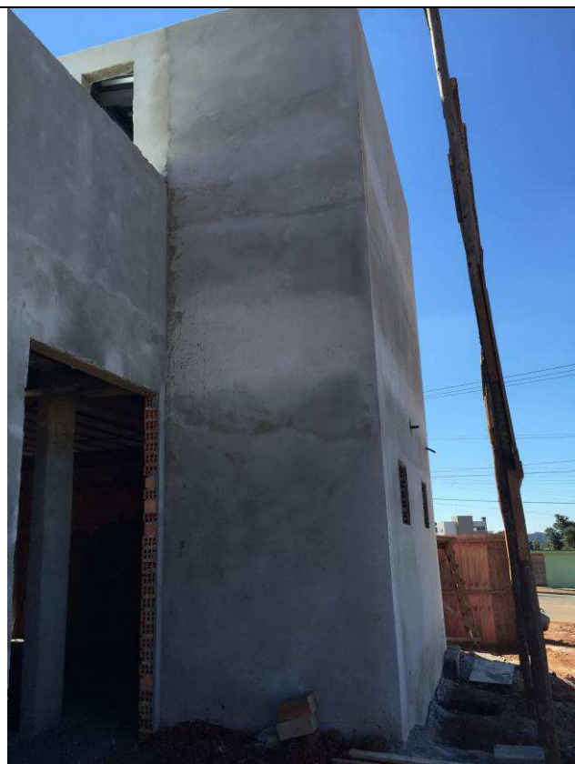
Figura 41C: Chapisco e emboço - face externa das alvenarias.
