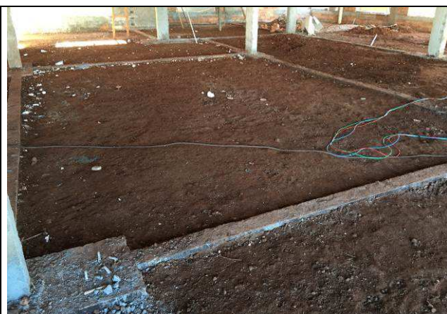
Figura 46C: Chapisco e emboço - face externa das alvenarias.
