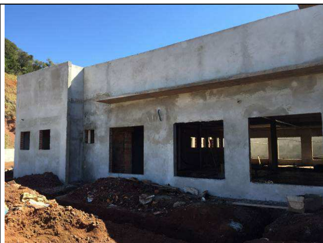
Figura 40C: Chapisco e emboço - face externa das alvenarias.
