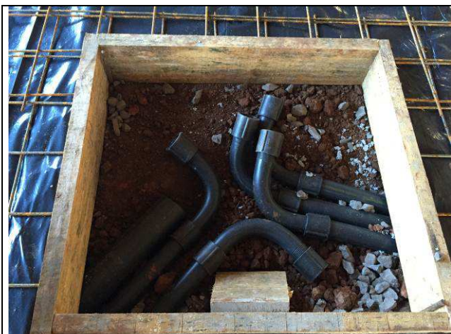
Figura 29E: Infraestrutura interna - Eletrodutos de PVC embutidos no piso.
