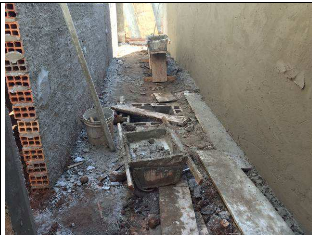
Figura 32C: Chapisco e emboço - execução.
