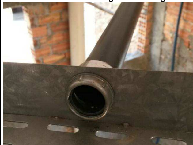
Figura 26E: Conexão dos eletrodutos de PVC rígido nas eletrocalhas.
