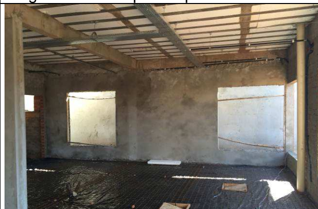
Figura 27C: Chapisco e emboço - paredes internas.
