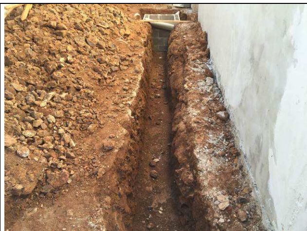
Figura 01C: Escavação de valas - redes de esgoto e águas pluviais.
