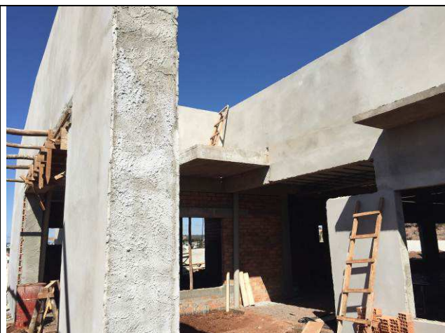
Figura 43C: Chapisco e emboço - face externa das alvenarias.
