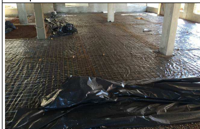
Figura 23C: Impermeabilização com lona plástica sobre a camada de brita.
