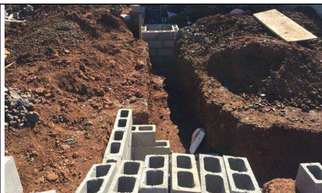
Figura 03C: Escavação de valas - redes de esgoto e águas pluviais.
