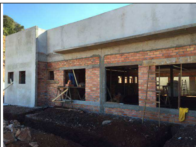
Figura 08C: Vergas e contravergas.
