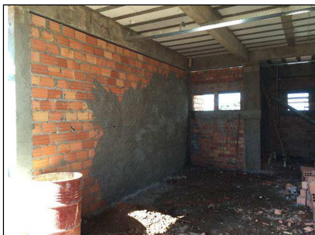
Figura 13C: Alvenarias - prédio principal.
