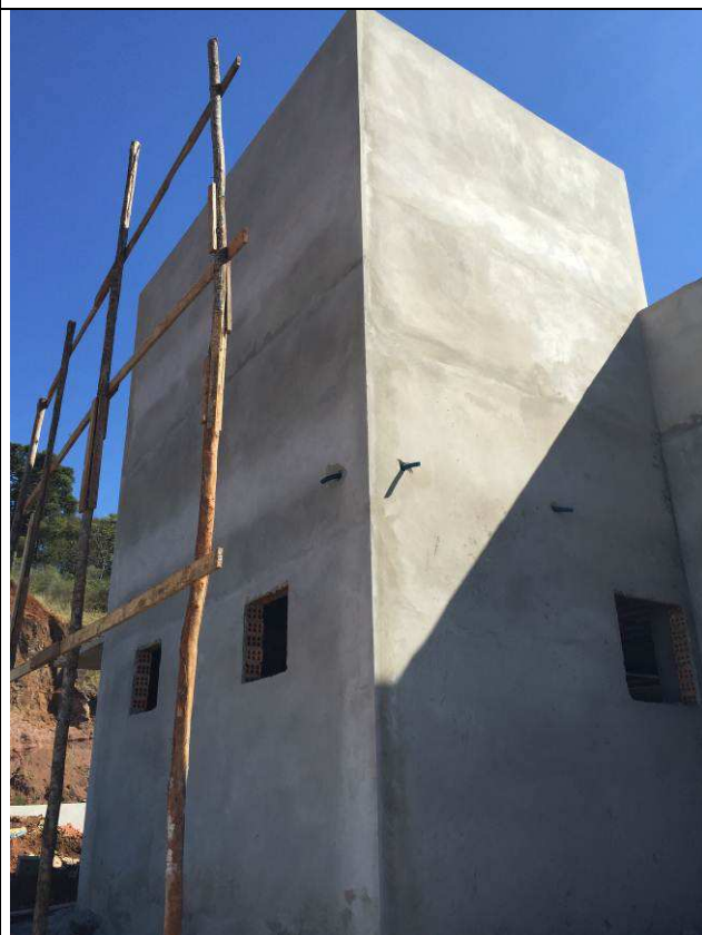
Figura 42C: Chapisco e emboço - face externa das alvenarias.
