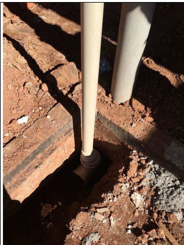
Figura 68C: Tubulação Ø 100 / 150 mm - descidas de águas pluviais.
