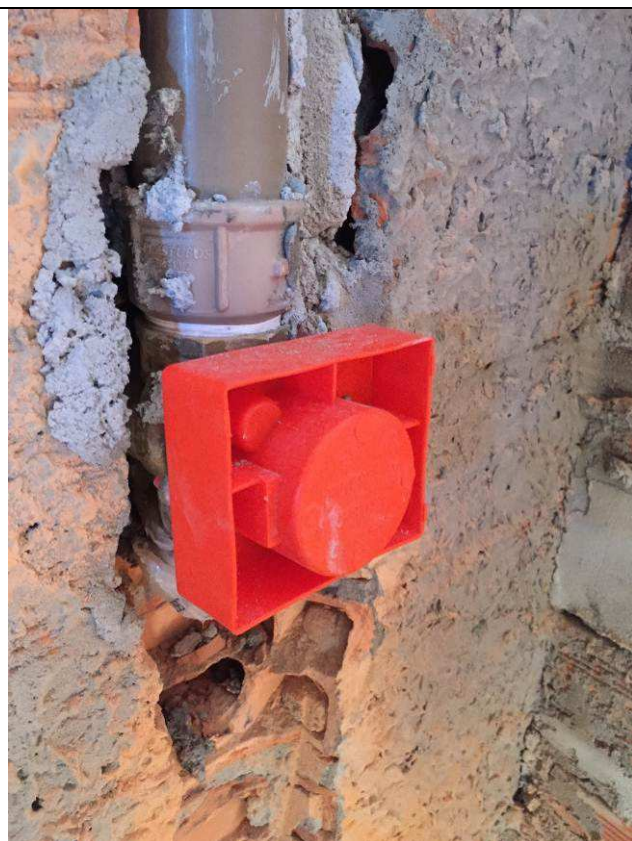
Figura 63C: Base para válvula de descarga - bwc PNE secretaria.
