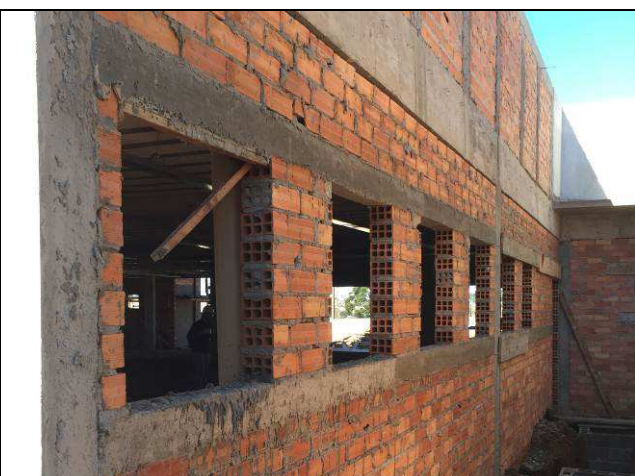
Figura 07C: Vergas e contravergas.
