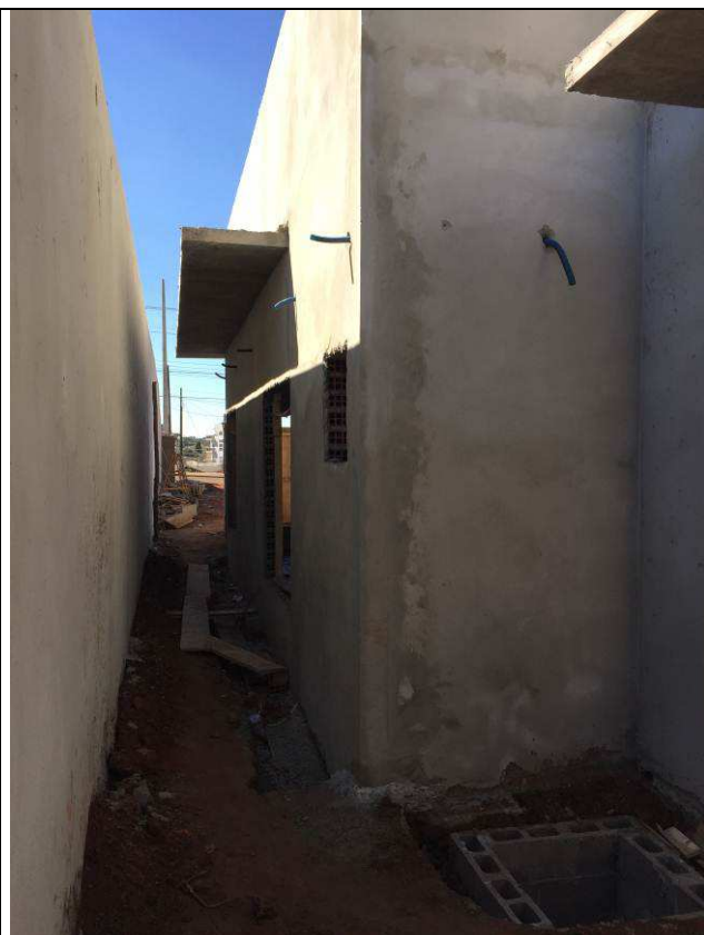
Figura 35C: Chapisco e emboço - face externa das alvenarias.
