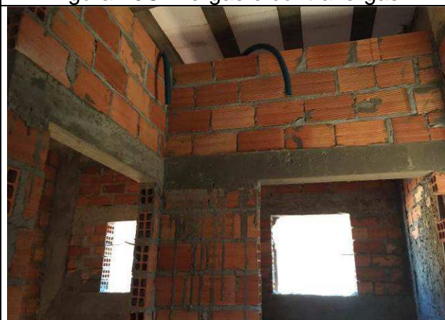
Figura 12C: Vergas e contravergas.
