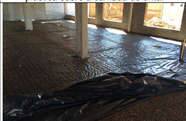
Figura 24C: Impermeabilização com lona plástica sobre a camada de brita.
