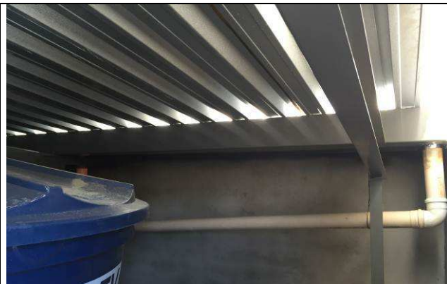
Figura 20C: Calha em chapa de aço galvanizado # 22.
