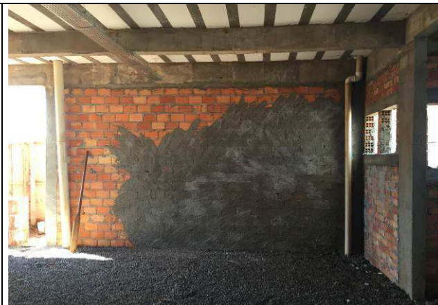
Figura 26C: Chapisco - paredes internas.
