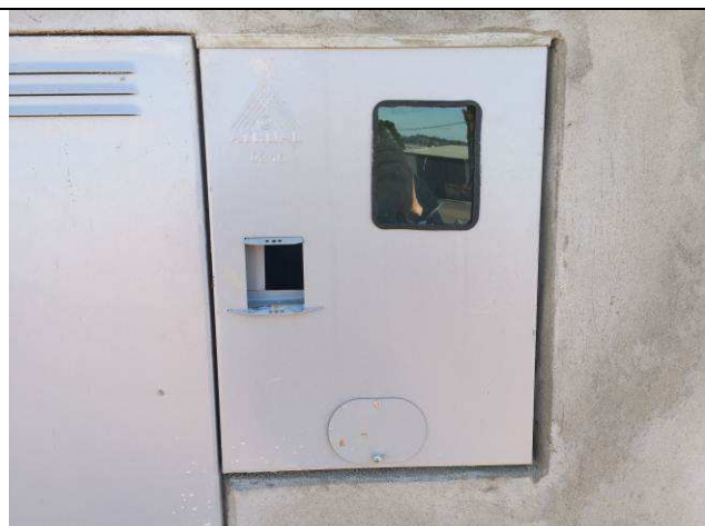
Figura 05E: Caixa CN1 instalada na mureta.
