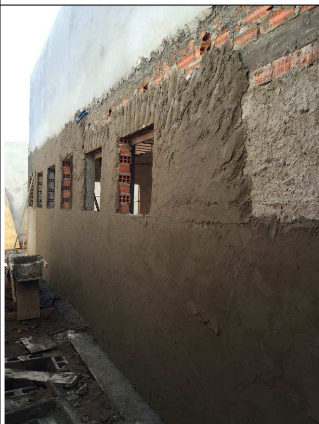
Figura 33C: Chapisco e emboço - face externa das alvenarias.
