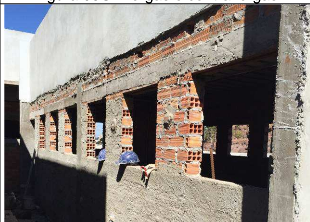
Figura 11C: Vergas e contravergas.
