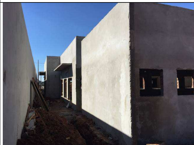
Figura 37C: Chapisco e emboço - face externa das alvenarias.
