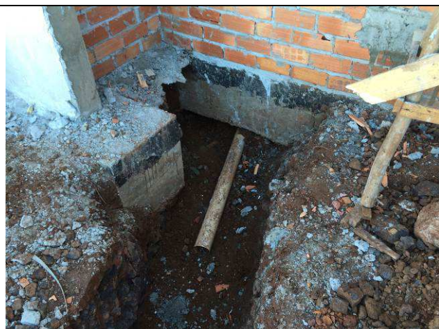
Figura 69C: Tubulação Ø 100 mm - rede esgoto.
