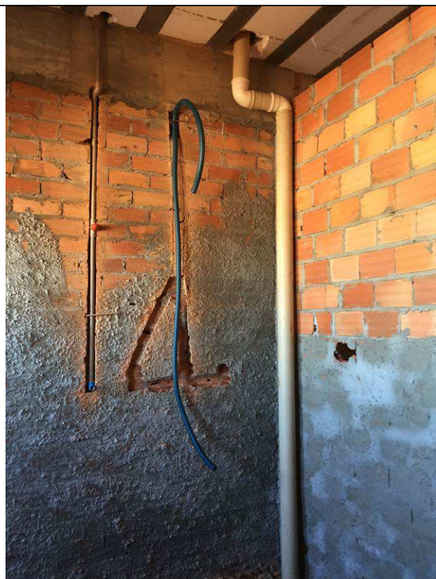
Figura 61C: Ponto de água fria e descida de águas pluviais - copa.
