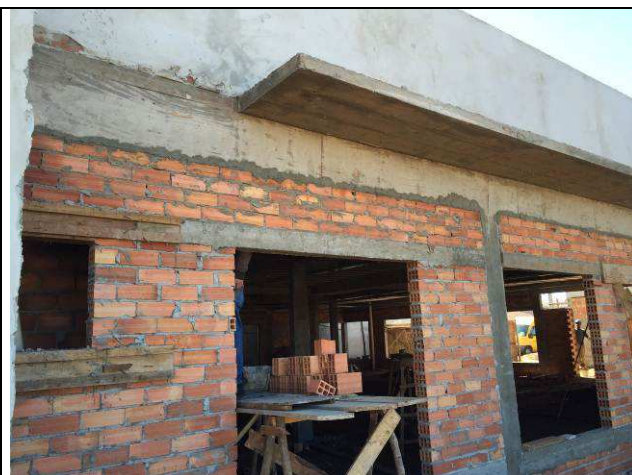
Figura 10C: Vergas e contravergas.
