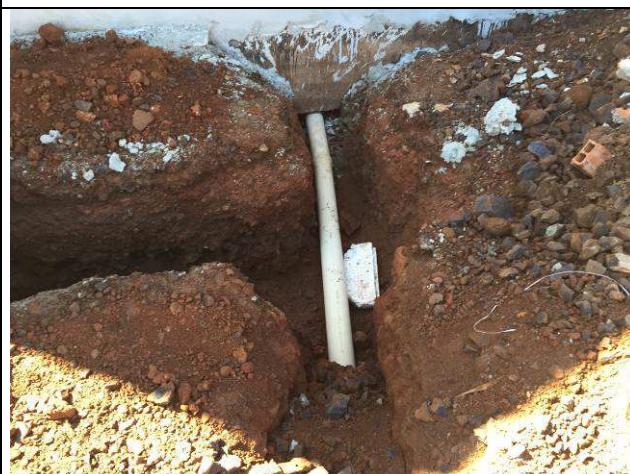
Figura 70C: Tubulação Ø 100 mm - rede de águas pluviais.
