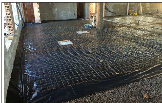
Figura 21C: Impermeabilização com lona plástica sobre a camada de brita.
