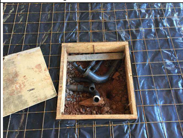
Figura 28E: Infraestrutura interna - Eletrodutos de PVC embutidos no piso.
