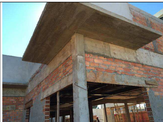
Figura 09C: Vergas e contravergas.
