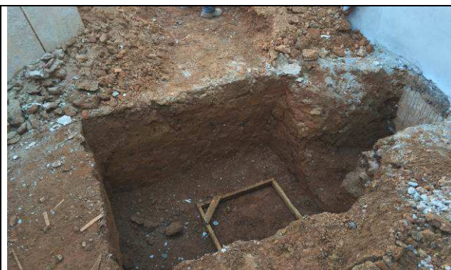
Figura 04C: Escavação de valas - redes de esgoto e águas pluviais.
