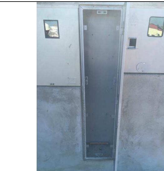
Figura 07E: Módulo de barramento instalado na mureta.
