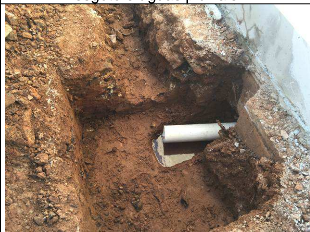
Figura 06C: Escavação de valas - redes de esgoto e águas pluviais.
