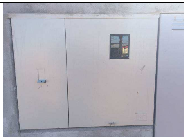
Figura 06E: Caixa GNE instalada na mureta.
