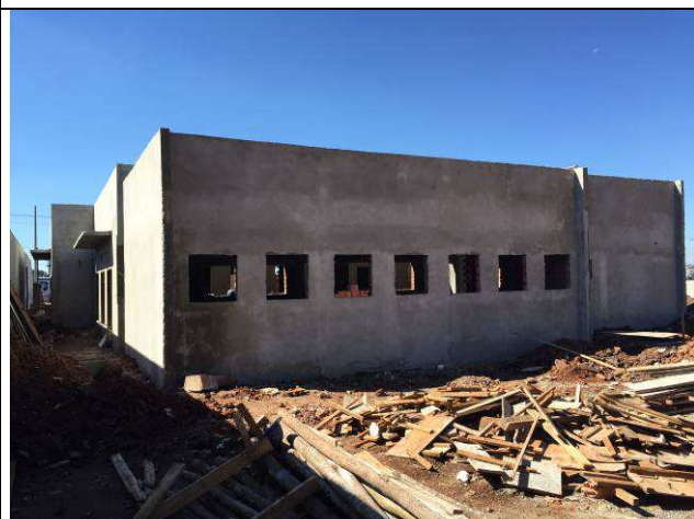
Figura 38C: Chapisco e emboço - face externa das alvenarias.
