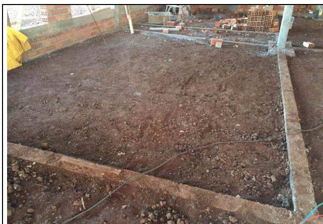
Figura 45C: Preparação do solo para receber a camada de brita.
