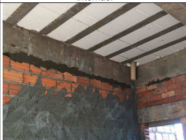
Figura 29C: Encunhamento das alvenarias com argamassa com aditivo expander.
