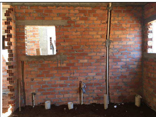
Figura 54C: Pontos de água fria e esgoto - arquivo.
