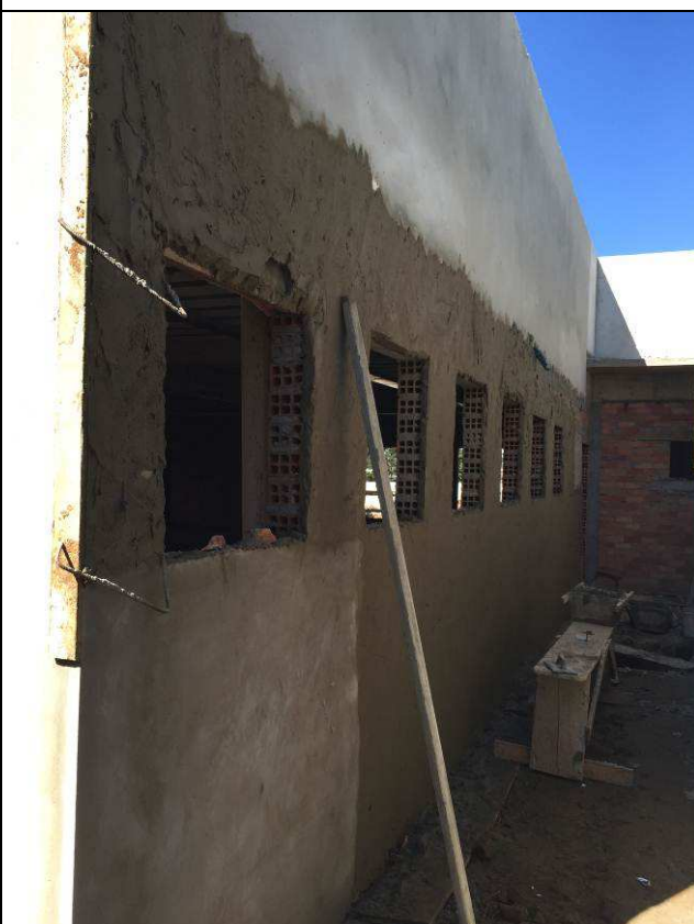
Figura 34C: Chapisco e emboço - face externa das alvenarias.
