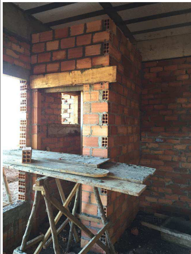
Figura 18C: Alvenarias - prédio principal.
