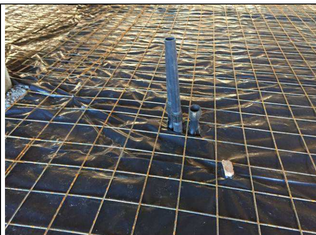
Figura 30E: Infraestrutura interna - Eletrodutos de PVC embutidos no piso.
