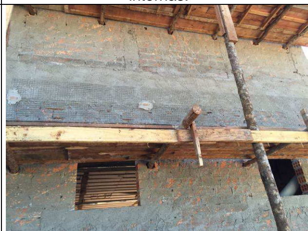
Figura 30C: Aplicação de tela metálica eletrossoldadas na interface alvenaria x face inferior da viga de cobertura.
