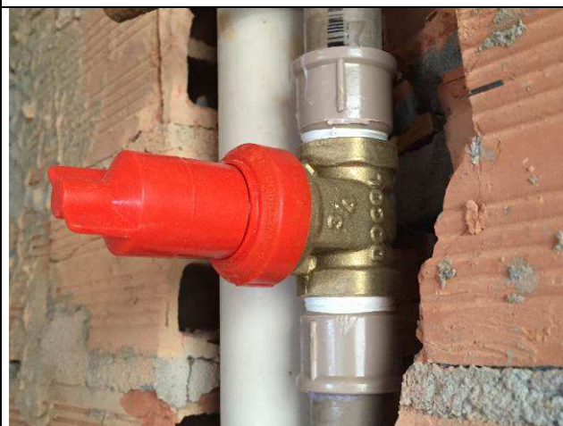
Figura 66C: Registro de gaveta Ø 3/4\".
