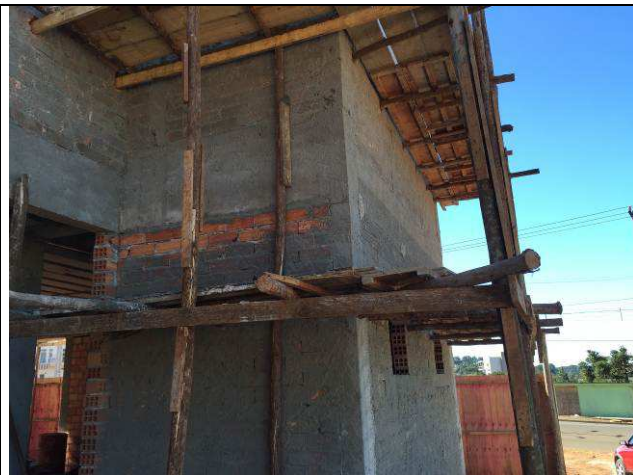
Figura 31C: Chapisco - face externa das alvenarias.
