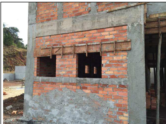
Figura 21C: Vergas e contravergas.
