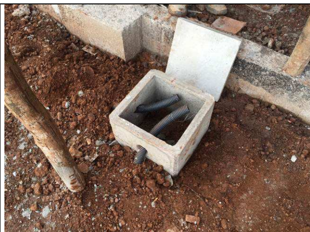
Figura 11E: Caixas 30x30 e eletrodutos 40mm enterrados
