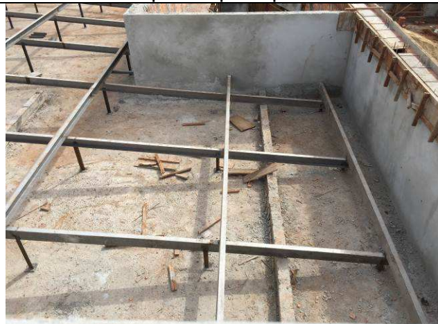
Figura 49C: Estrutura metálica de cobertura - prédio principal.
