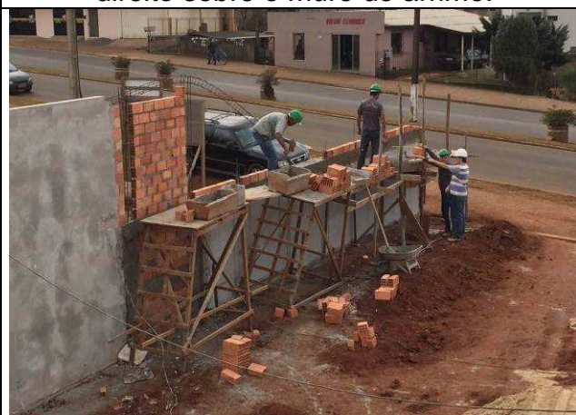
Figura 126C: Muro de fechamento - lado direito sobre o muro de arrimo.
