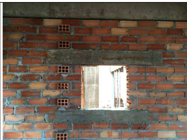
Figura 22C: Vergas e contravergas.
