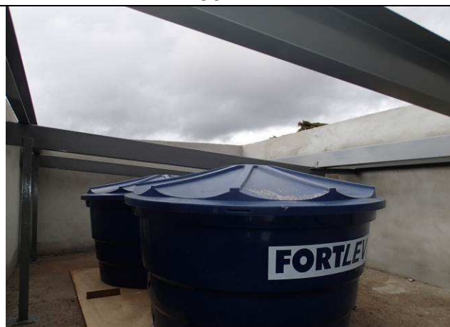
Figura 57C: Estrutura metálica de cobertura - caixas de água.
