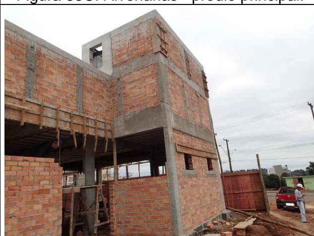
Figura 40C: Alvenarias - prédio principal.
