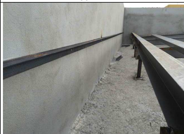
Figura 58C: Berço das calhas.
