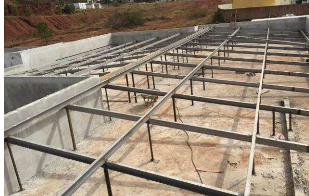
Figura 47C: Estrutura metálica de cobertura - prédio principal.
