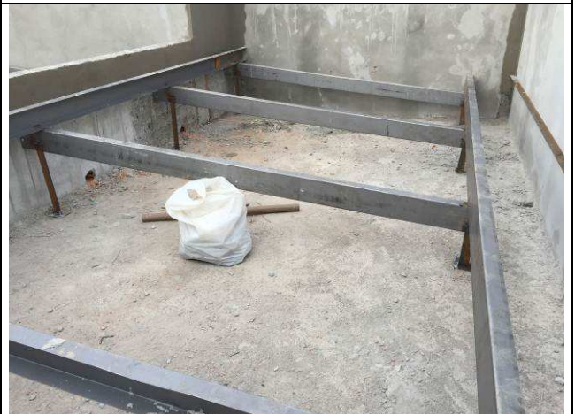
Figura 50C: Estrutura metálica de cobertura - copa e banheiros.
