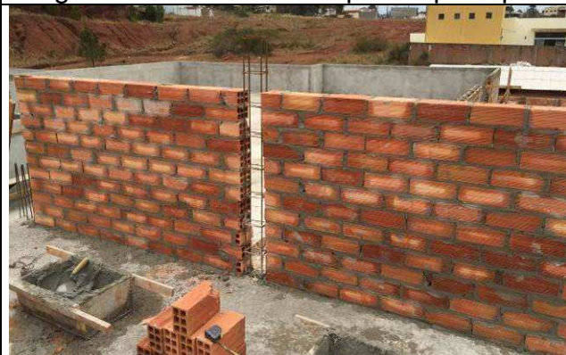
Figura 30C: Alvenarias - caixa d'água.
