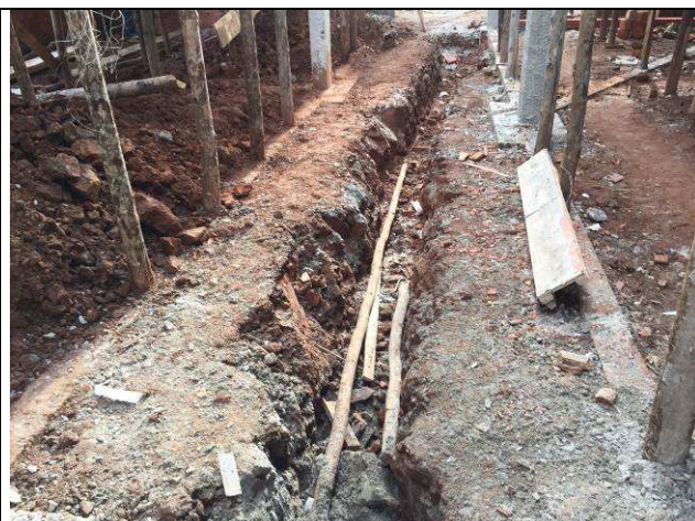
Figura 04C: Escavação de valas - redes de esgoto e águas pluviais.
