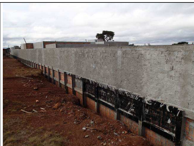
Figura 130C: Muro de arrimo - lado direito.
