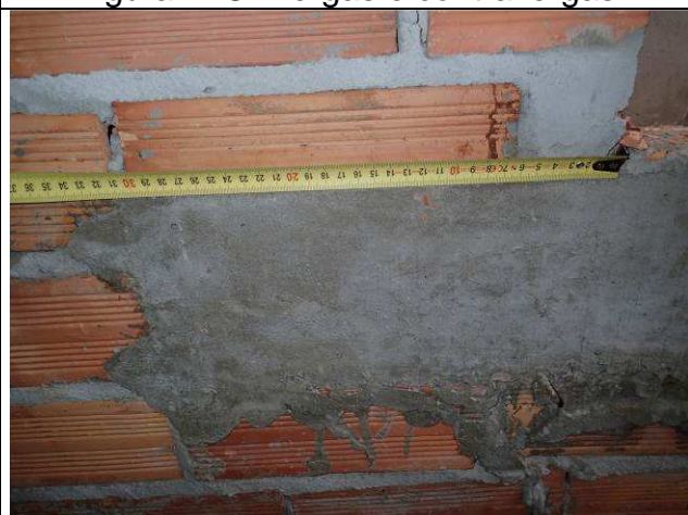
Figura 24C: Vergas e contravergas.
