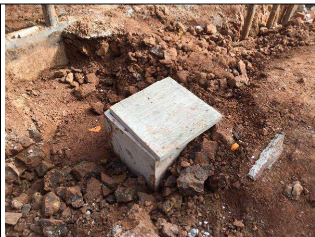
Figura 12E: Caixas 30x30 e eletrodutos 40mm enterrados
