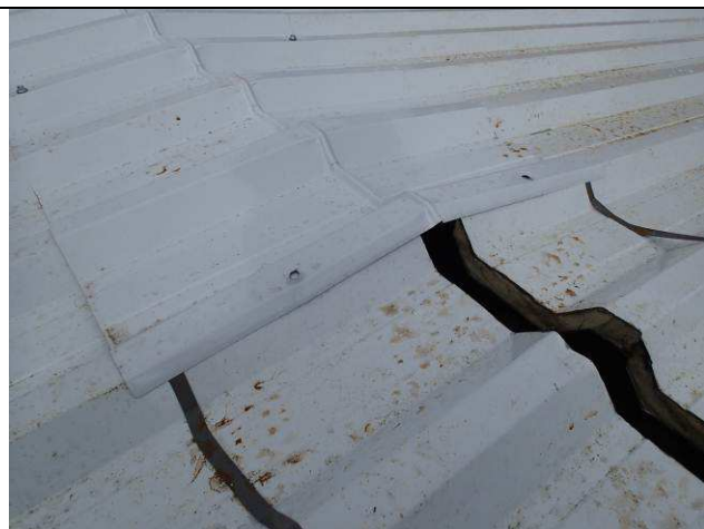
Figura 67C: Telha de cumeeira com fitas de vedação aplicada.
