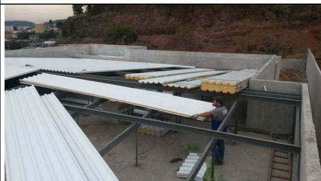
Figura 62C: Montagem das telhas de cobertura.
