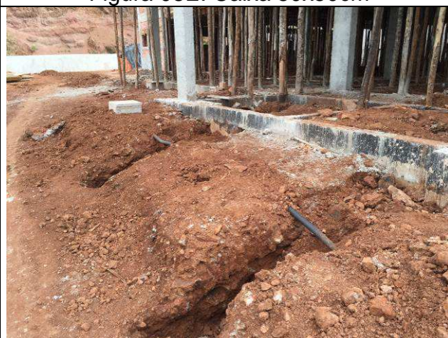
Figura 10E: Caixas 30x30 e eletrodutos 40mm enterrados
