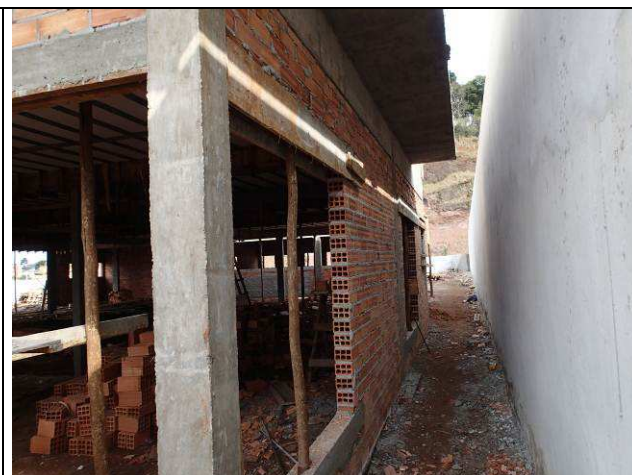
Figura 42C: Alvenarias - prédio principal.
