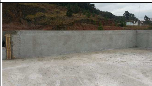
Figura 92C: Chapisco e emboço - face interna das platibandas.
