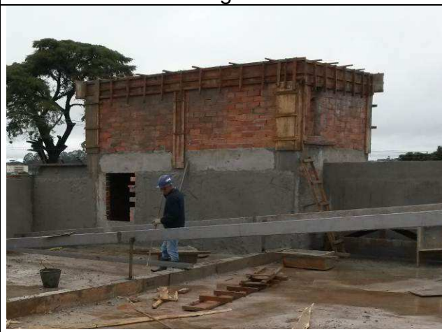
Figura 12C: Pilares, vigas e lajes da caixa d'água.
