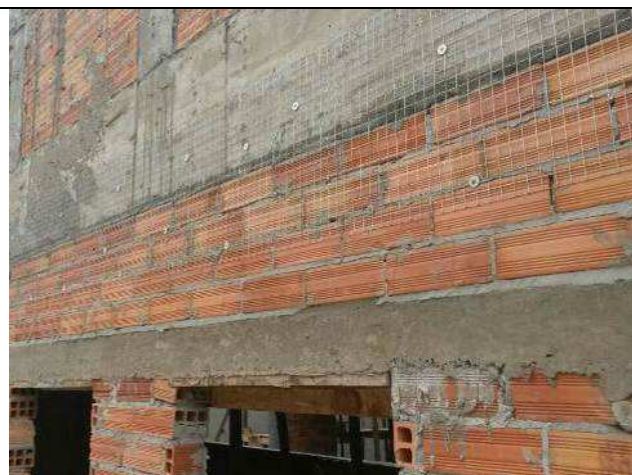
Figura 99C: Aplicação de tela metálica eletrossoldadas na interface alvenaria x face inferior da viga de cobertura.
