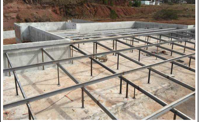
Figura 48C: Estrutura metálica de cobertura - prédio principal.
