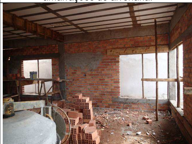
Figura 38C: Alvenarias - prédio principal.
