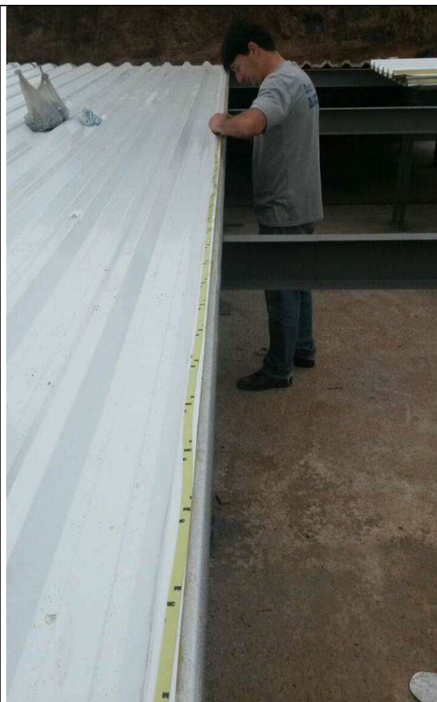
Figura 66C: Fita de vedação utilizada nas emendas entre telha
