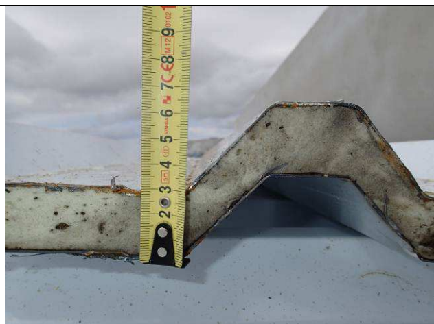
Figura 59C: Telhas de cobertura com injeção de poliuretano (H=70mm).
