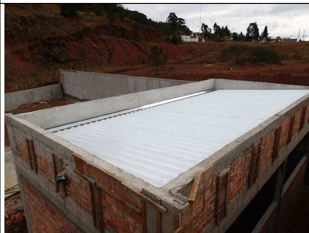
Figura 74C: Cobertura com telhas tipo "sanduíche" instaladas.
