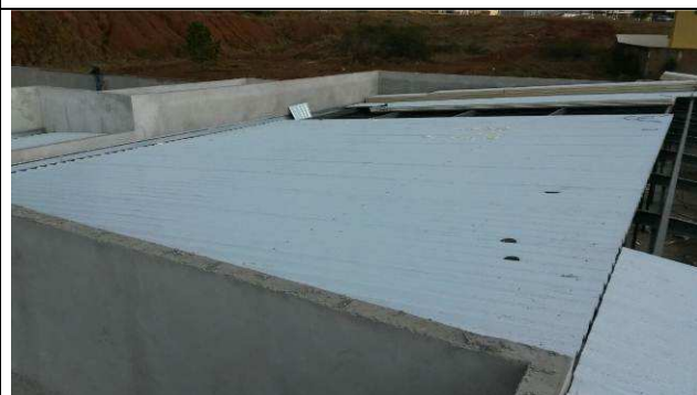
Figura 64C: Montagem das telhas de cobertura.
