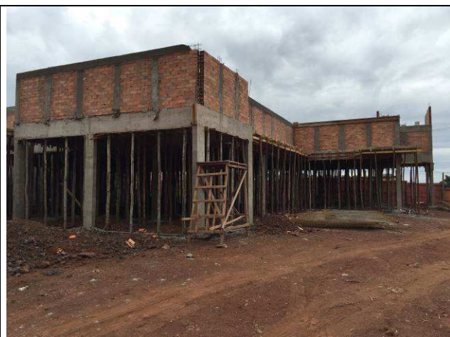
Figura 15C: Pilaretes e cinta da platibanda.
