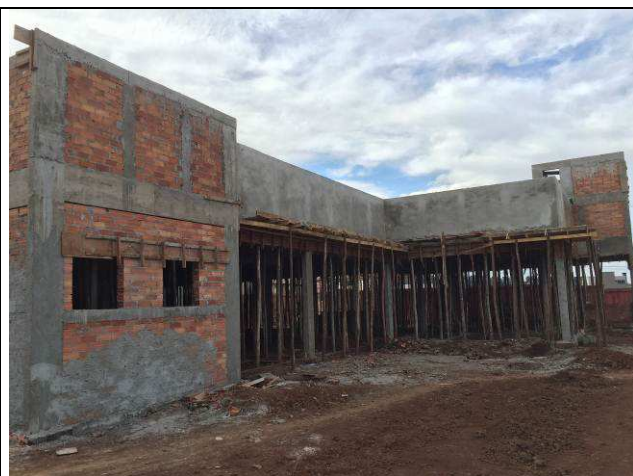
Figura 102C: Chapisco e emboço - face externa das platibandas sobre marquises.
