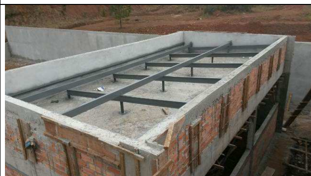
Figura 134C: Estrutura metálica pintada.
