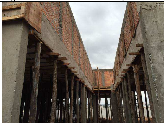
Figura 17C: Pilaretes e cinta da platibanda.
