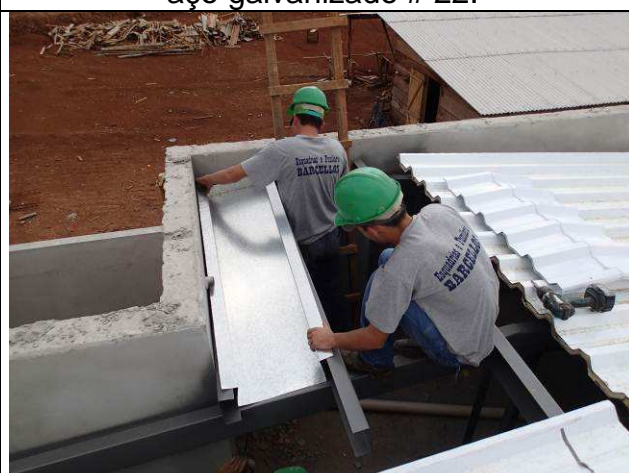
Figura 86C: Montagem de calha.
