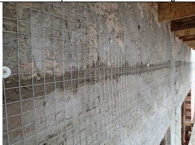
Figura 97C: Aplicação de tela metálica eletrossoldadas na interface alvenaria x face inferior da viga de cobertura.
