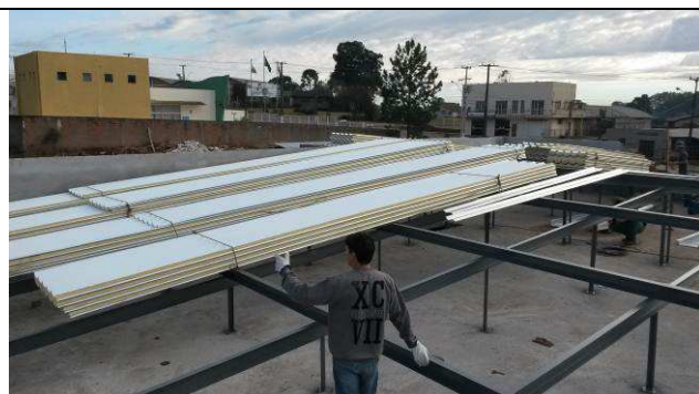
Figura 61C: Montagem das telhas de cobertura.
