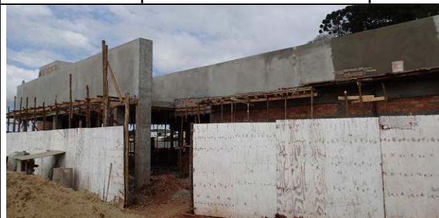
Figura 104C: Chapisco e emboço - face externa frontal e pórtico da entrada.
