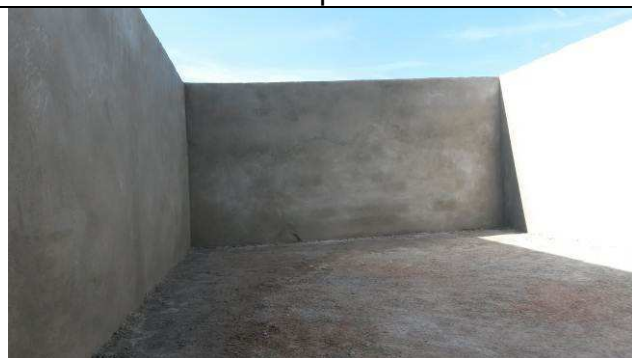
Figura 95C: Chapisco e emboço - face interna das platibandas - caixas de água.
