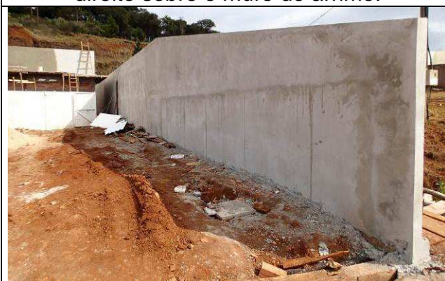
Figura 127C: Muro de fechamento - lado direito sobre o muro de arrimo.
