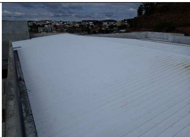
Figura 69C: Cobertura com telhas tipo "sanduíche" instaladas.
