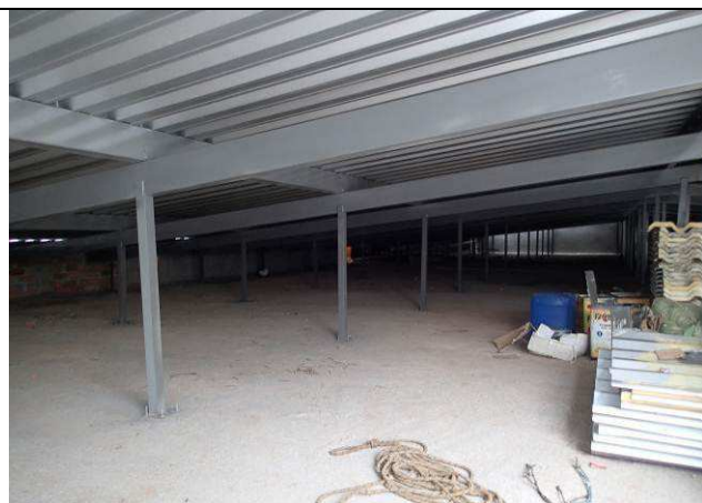
Figura 75C: Cobertura com telhas tipo "sanduíche" instaladas.
