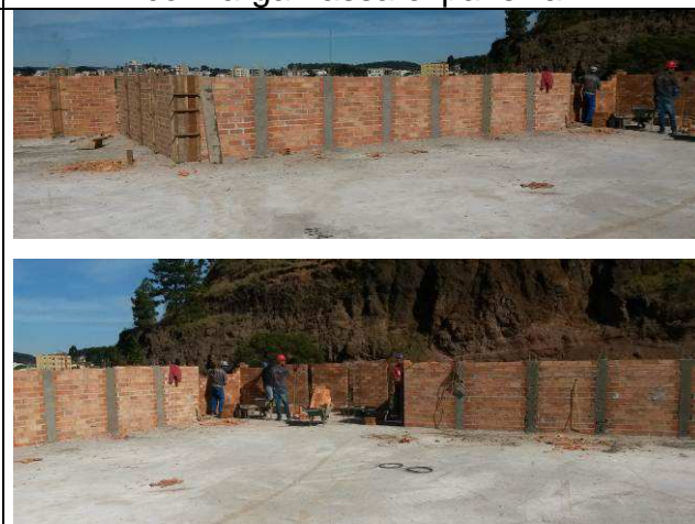
Figura 46C: Execução das alvenarias das platibandas.
