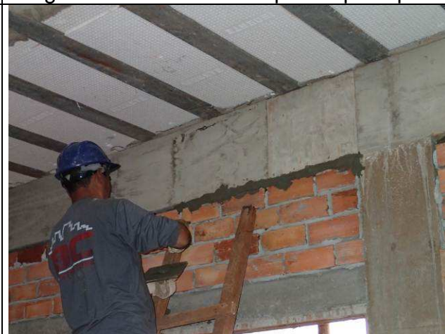
Figura 44C: Encunhamento das alvenarias com argamassa expansiva.
