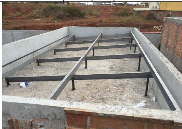
Figura 51C: Estrutura metálica de cobertura - arquivo.
