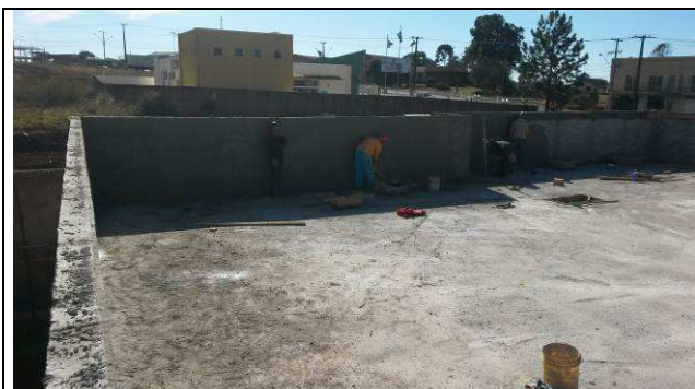
Figura 89C: Chapisco e emboço - face interna das platibandas.
