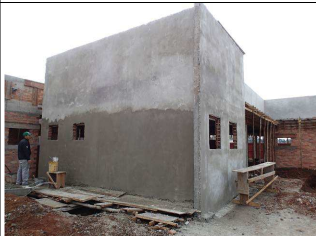
Figura 108C: Chapisco e emboço - banheiros da secretaria e copa.
