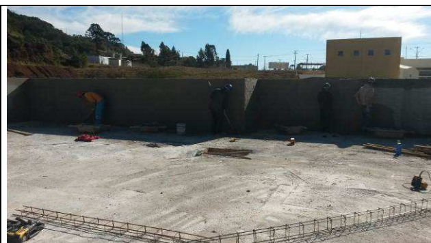
Figura 90C: Chapisco e emboço - face interna das platibandas.
