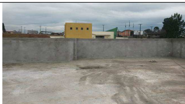
Figura 93C: Chapisco e emboço - face interna das platibandas.
