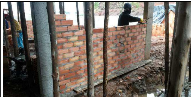
Figura 28C: Alvenarias - prédio principal.
