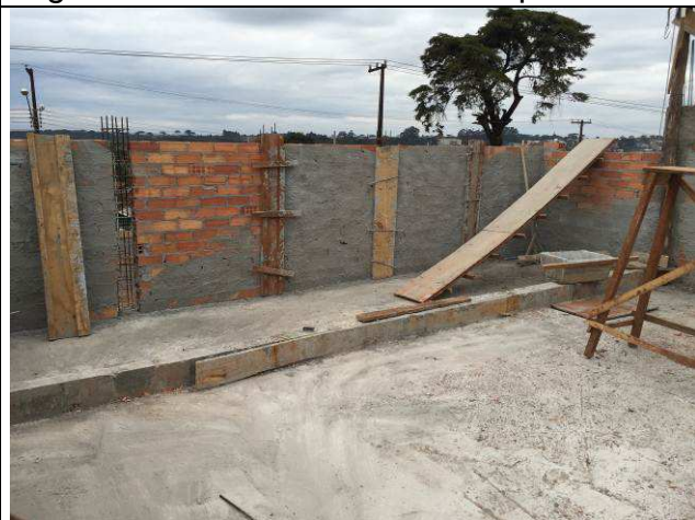
Figura 20C: Pilaretes e cinta da platibanda.
