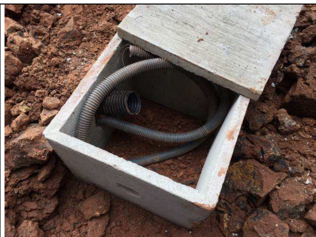
Figura 06E: Entrada de energia TRT (eletroduto 75mm) e PAB (40mm), caixas 50x50.
