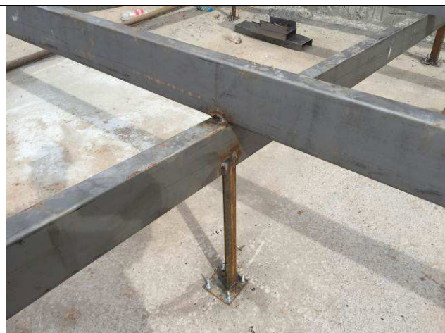
Figura 53C: Estrutura metálica de cobertura - detalhe do apoio.
