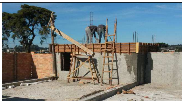
Figura 07C: Pilares, vigas e lajes da caixa d'água.
