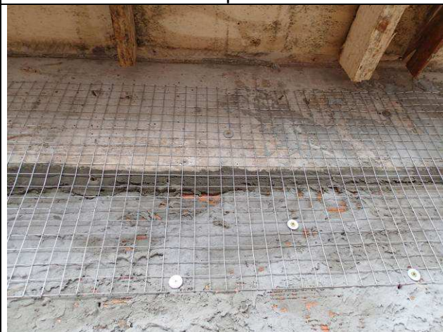
Figura 98C: Aplicação de tela metálica eletrossoldadas na interface alvenaria x face inferior da viga de cobertura.
