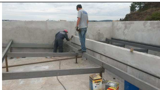
Figura 131C: Pintura da estrutura metálica com pistola de ar comprimido.
