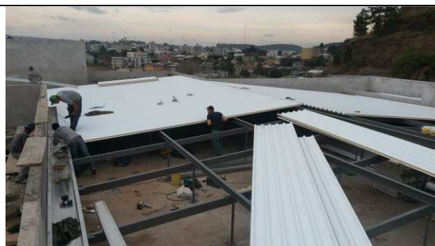
Figura 63C: Montagem das telhas de cobertura.
