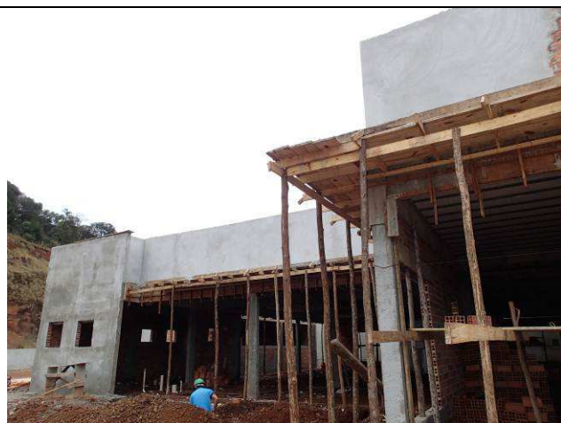
Figura 101C: Chapisco e emboço - face externa das platibandas sobre marquises.
