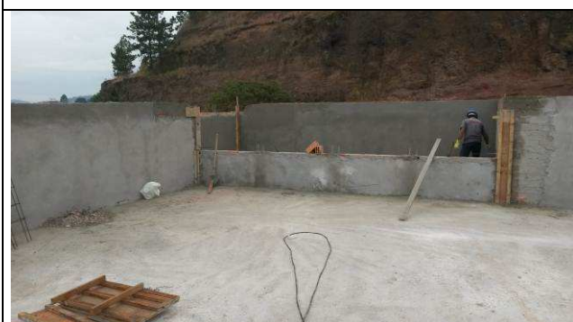
Figura 91C: Chapisco e emboço - face interna das platibandas.
