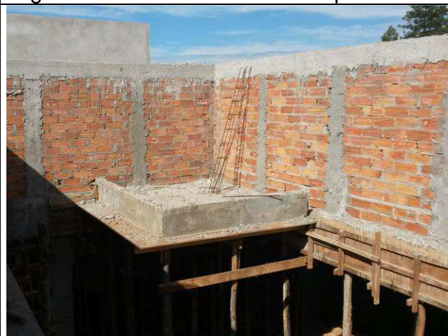
Figura 18C: Pilaretes e cinta da platibanda.
