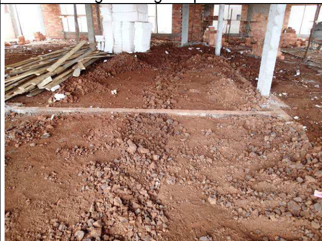
Figura 06C: Reaterro de valas - redes de esgoto e águas pluviais.
