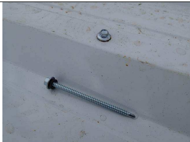
Figura 77C: Parafusos autobrocantes com arruela de borracha utilizado.
