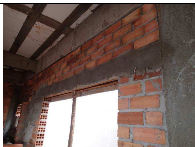
Figura 26C: Vergas e contravergas.
