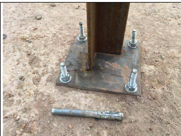
Figura 54C: Estrutura metálica de cobertura - detalhe do apoio.
