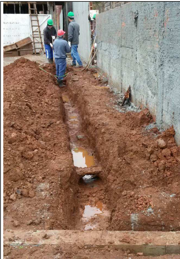
Figura 01E: escavação, reaterro de valas, instalação de caixas e eletrodutos (frente terreno).
