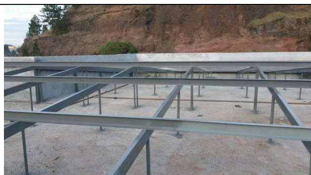
Figura 133C: Estrutura metálica pintada.
