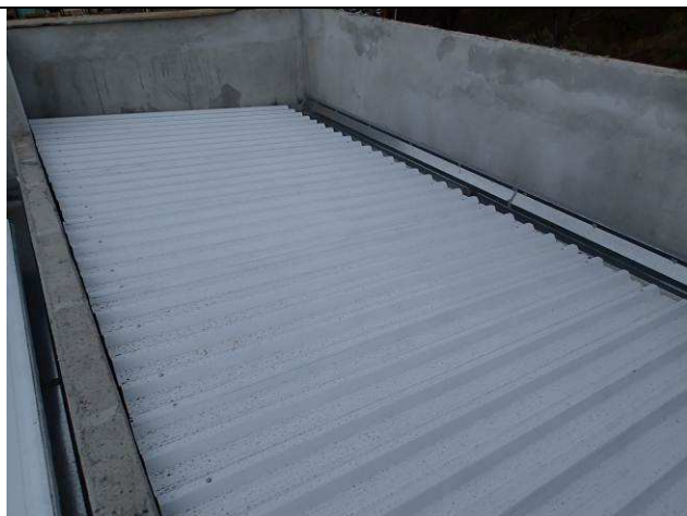
Figura 73C: Cobertura com telhas tipo "sanduíche" instaladas.
