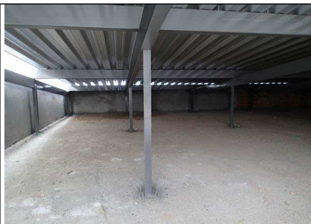
Figura 76C: Cobertura com telhas tipo "sanduíche" instaladas.
