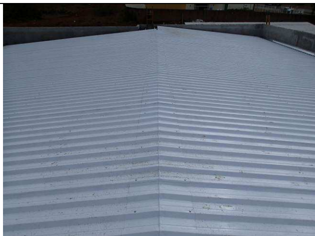
Figura 71C: Cobertura com telhas tipo "sanduíche" instaladas.
