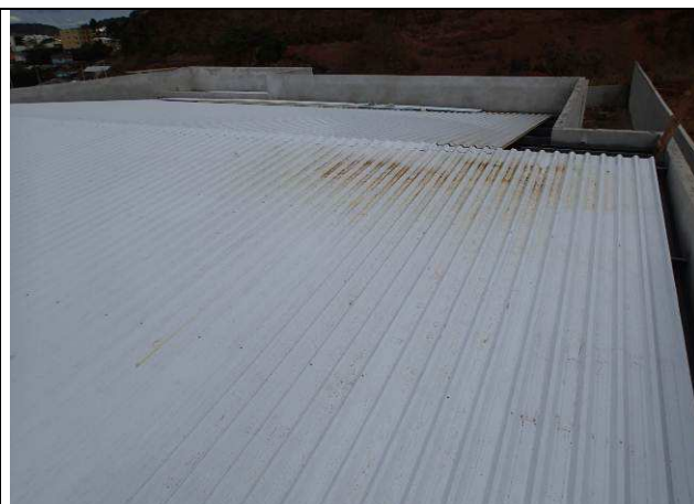
Figura 70C: Cobertura com telhas tipo "sanduíche" instaladas.
