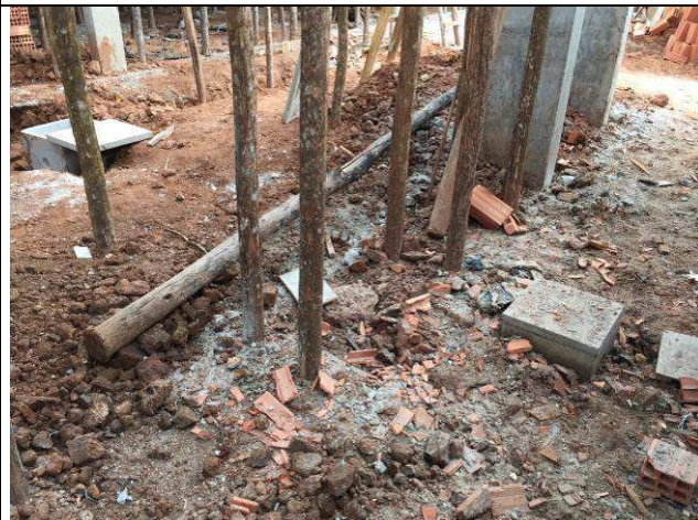
Figura 13E: Caixas 30x30 e eletrodutos 40mm enterrados
