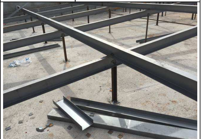
Figura 52C: Estrutura metálica de cobertura - detalhe do apoio.
