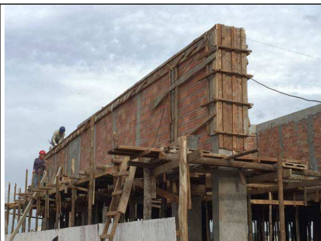
Figura 16C: Pilaretes e cinta da platibanda.
