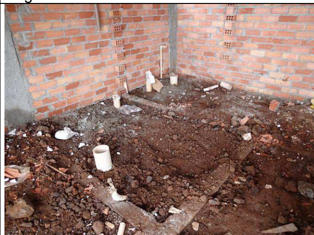
Figura 115C: Pontos de esgoto - banheiros da secretaria.
