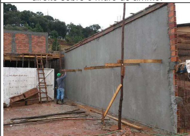
Figura 125C: Muro de fechamento - lado direito sobre o muro de arrimo.
