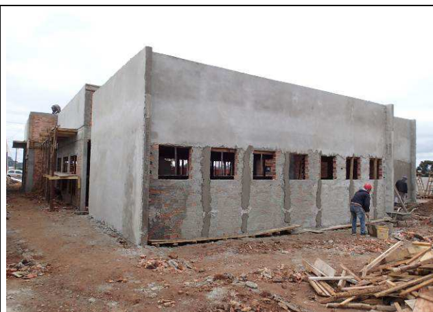
Figura 106C: Chapisco e emboço - arquivo.
