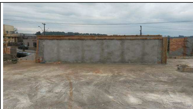
Figura 94C: Chapisco e emboço - face interna das platibandas.
