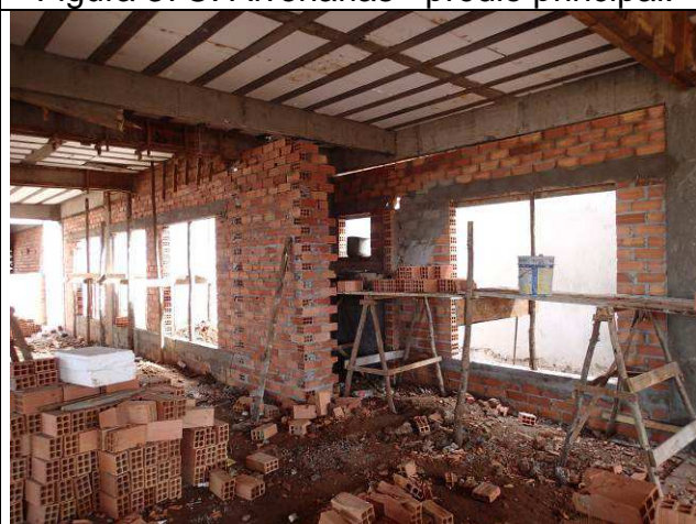
Figura 39C: Alvenarias - prédio principal.
