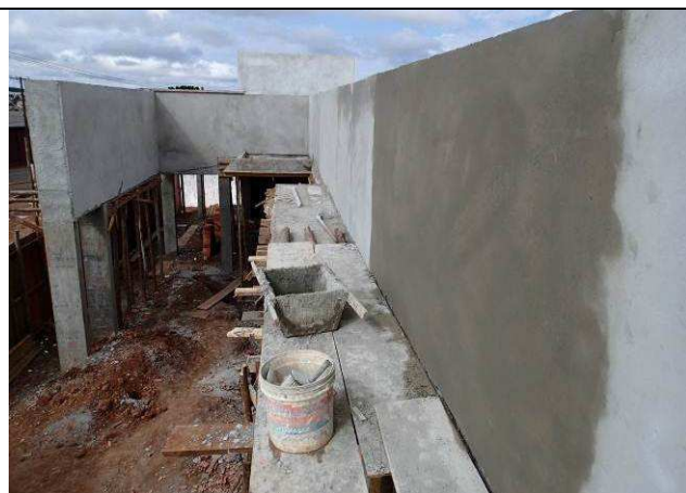
Figura 105C: Chapisco e emboço - face externa frontal e pórtico da entrada.
