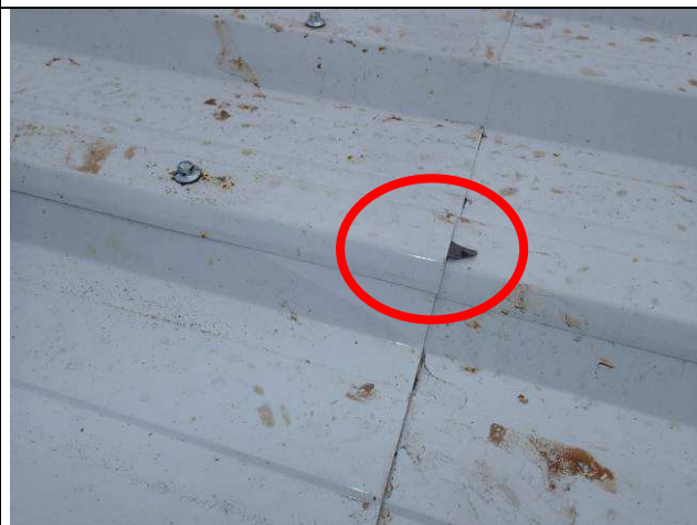
Figura 68C: Telhas com fitas de vedação aplicadas na emendas longitudinais.
