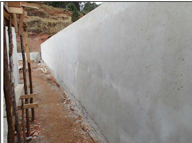
Figura 123C: Muro de fechamento - lado direito sobre o muro de arrimo.
