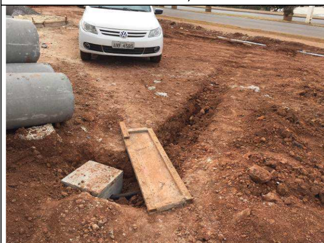
Figura 03E: escavação, reaterro de valas, instalação de caixas e eletrodutos (frente terreno).
