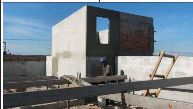
Figura 96C: Chapisco e emboço - face interna das platibandas.
