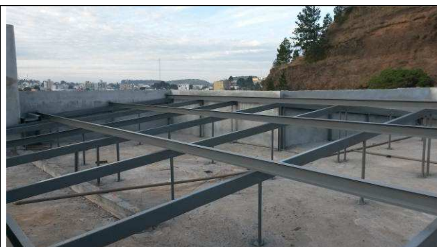
Figura 132C: Estrutura metálica pintada.
