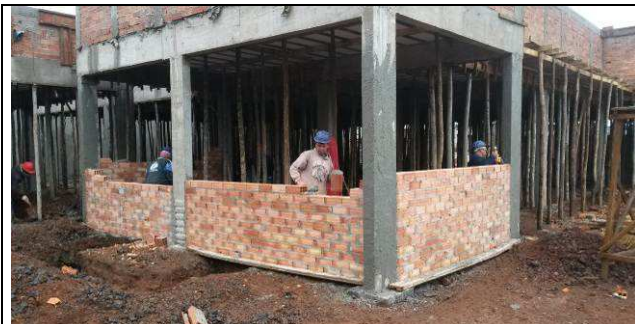
Figura 27C: Alvenarias - prédio principal.
