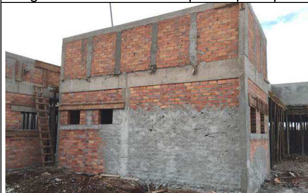
Figura 29C: Alvenarias - prédio principal.
