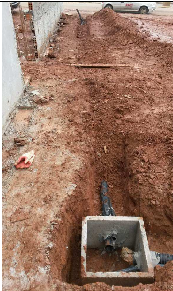
Figura 02E: escavação, reaterro de valas, instalação de caixas e eletrodutos.
