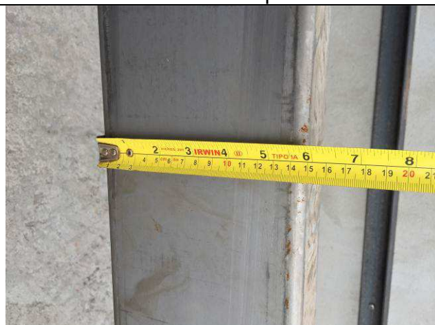
Figura 55C: Terças de cobertura - alma de 150 mm.
