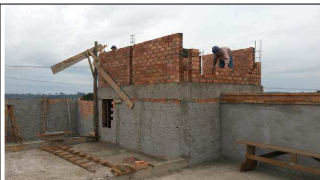
Figura 10C: Pilares, vigas e lajes da caixa d'água.
