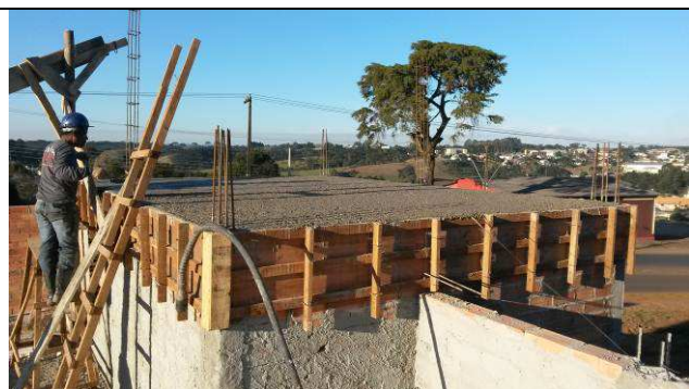
Figura 09C: Laje da caixa d'água concretada.
