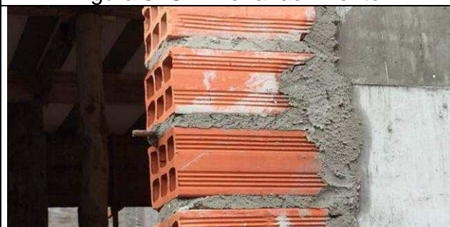
Figura 34C: Detalhe dos "cabelos" de aço na interface alvenaria x pilar.
