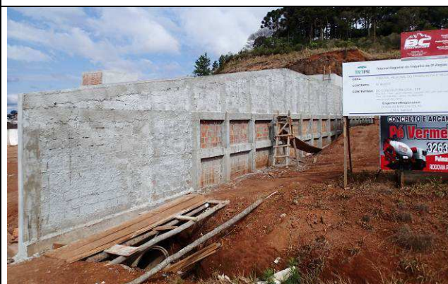
Figura 128C: Muro de arrimo - lado direito.
