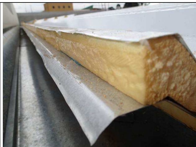
Figura 60C: Telhas de cobertura com injeção de poliuretano (H=70mm).
