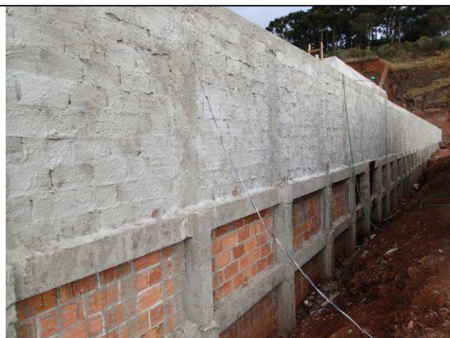
Figura 129C: Muro de arrimo - lado direito.
