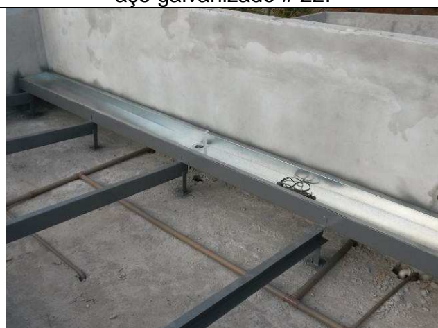
Figura 85C: Montagem de calha.
