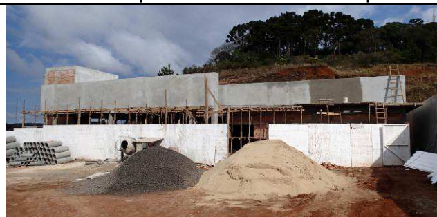
Figura 103C: Chapisco e emboço - face externa frontal e pórtico da entrada.
