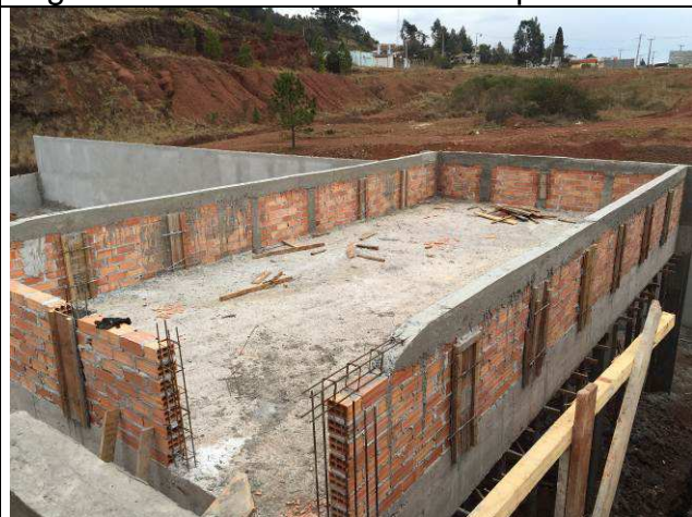
Figura 19C: Pilaretes e cinta da platibanda.
