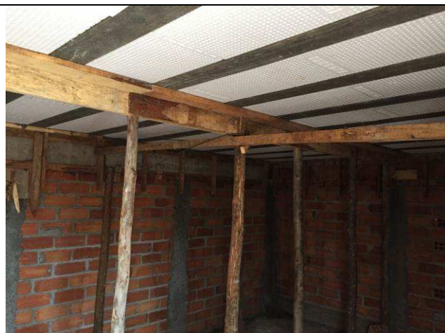
Figura 11C: Pilares, vigas e lajes da caixa d'água.
