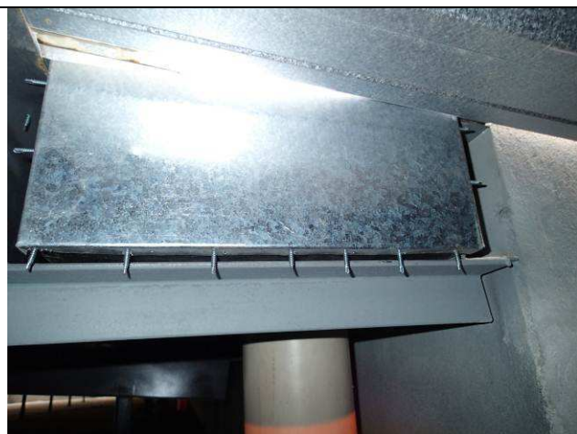
Figura 87C: Calha e condutor - vista inferior da cobertura.
