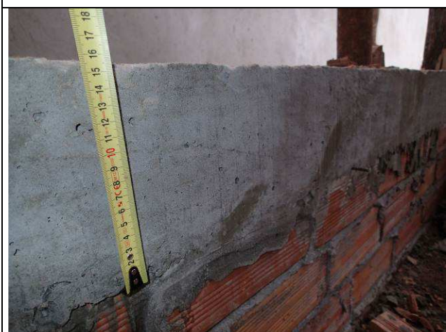
Figura 25C: Vergas e contravergas.
