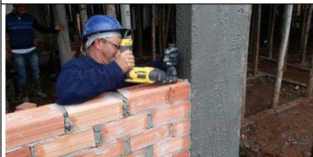
Figura 33C: Detalhe da fixação dos "cabelos" de aço.
