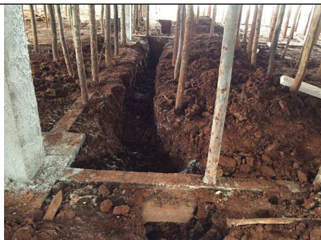
Figura 03C: Escavação de valas - redes de esgoto e águas pluviais.
