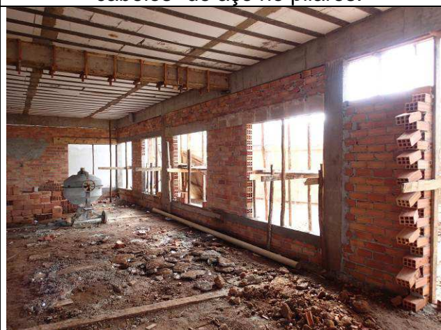
Figura 37C: Alvenarias - prédio principal.
