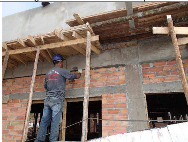
Figura 43C: Encunhamento das alvenarias com argamassa expansiva.
