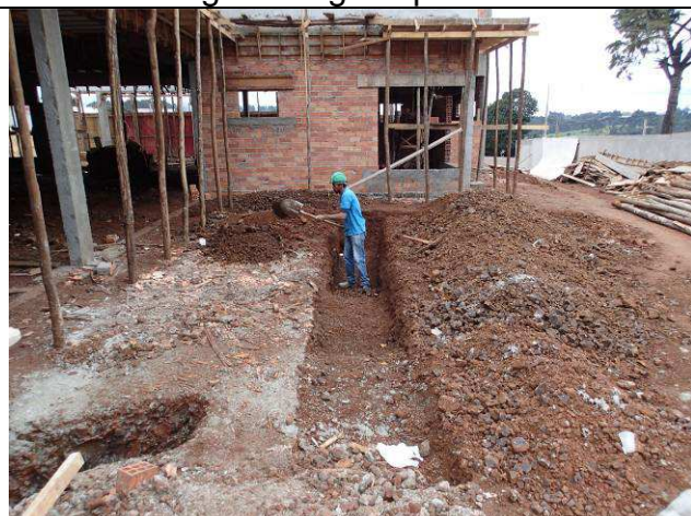
Figura 05C: Escavação de valas - redes de esgoto e águas pluviais.
