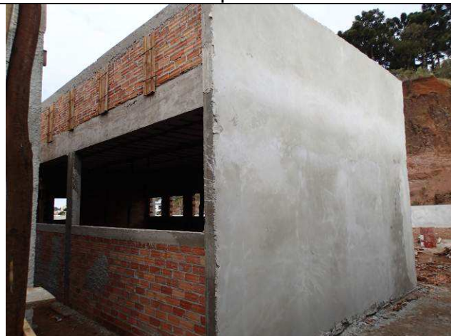
Figura 107C: Chapisco e emboço - arquivo.
