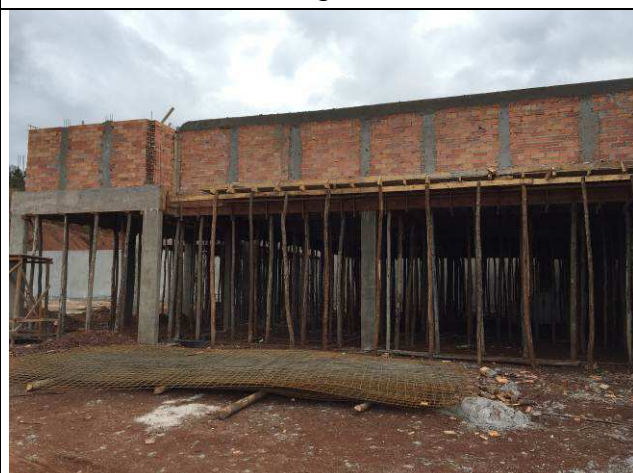
Figura 14C: Pilaretes e cinta da platibanda.
