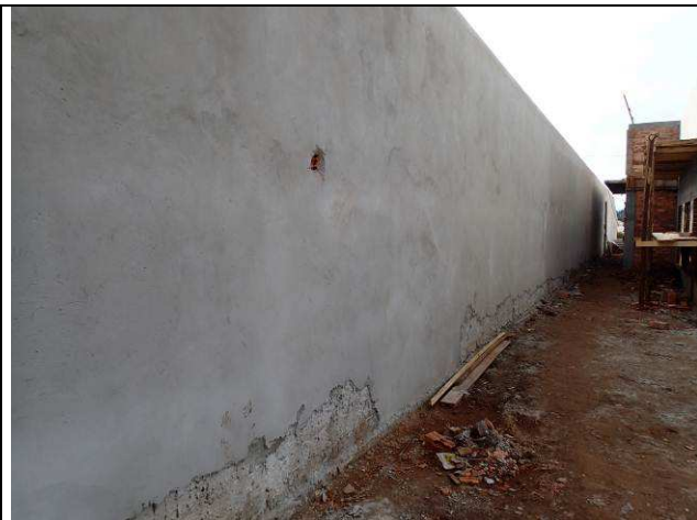
Figura 124C: Muro de fechamento - lado direito sobre o muro de arrimo.
