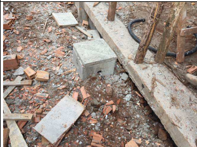
Figura 14E: Caixas 30x30 e eletrodutos 40mm enterrados
