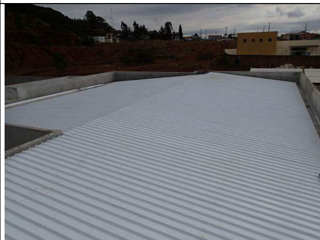
Figura 72C: Cobertura com telhas tipo "sanduíche" instaladas.
