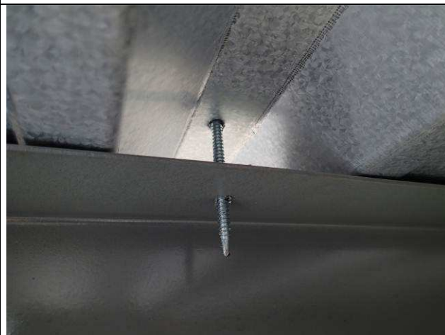
Figura 78C: Fixação das telhas com parafusos autobrocantes.
