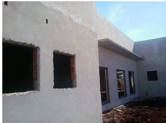
Figura 39C: Reboco executado na fachada sul (fundos)
