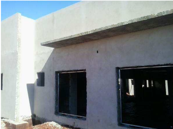
Figura 36C: Reboco finalizado em trecho da fachada leste
