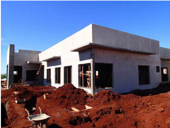
Figura 05A1: Com a finalização da execução do elemento de drenagem, a vala é fechada
