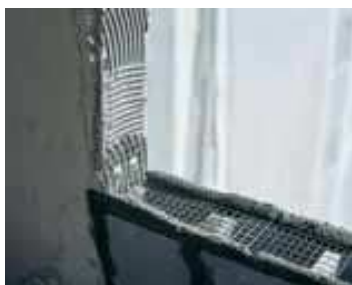
Ligação da Estrutura com a Alvenaria
