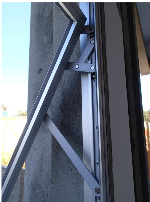
Sistema progressivo – Fermax ou similar
