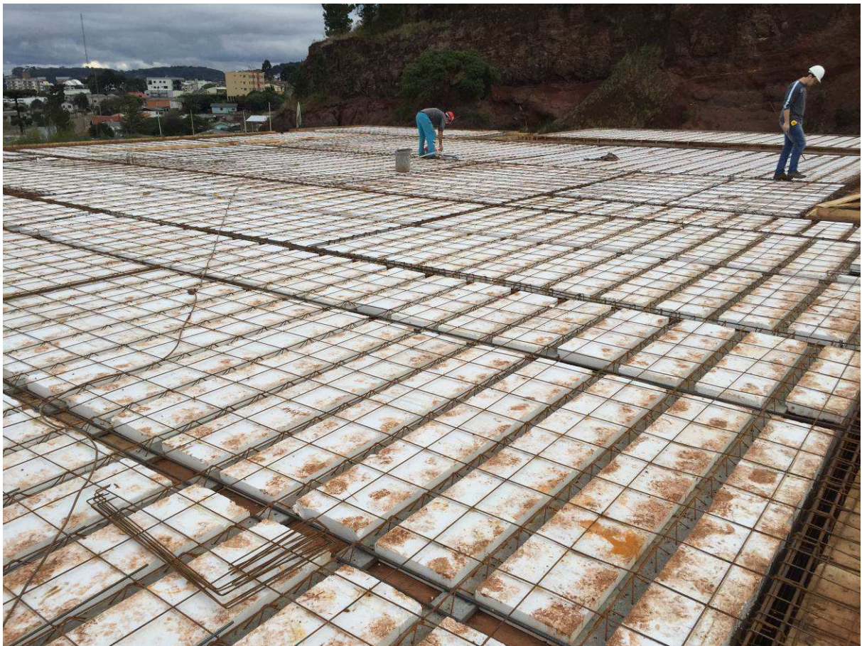
Figura 2 – Vista externa - formas da laje de cobertura.
