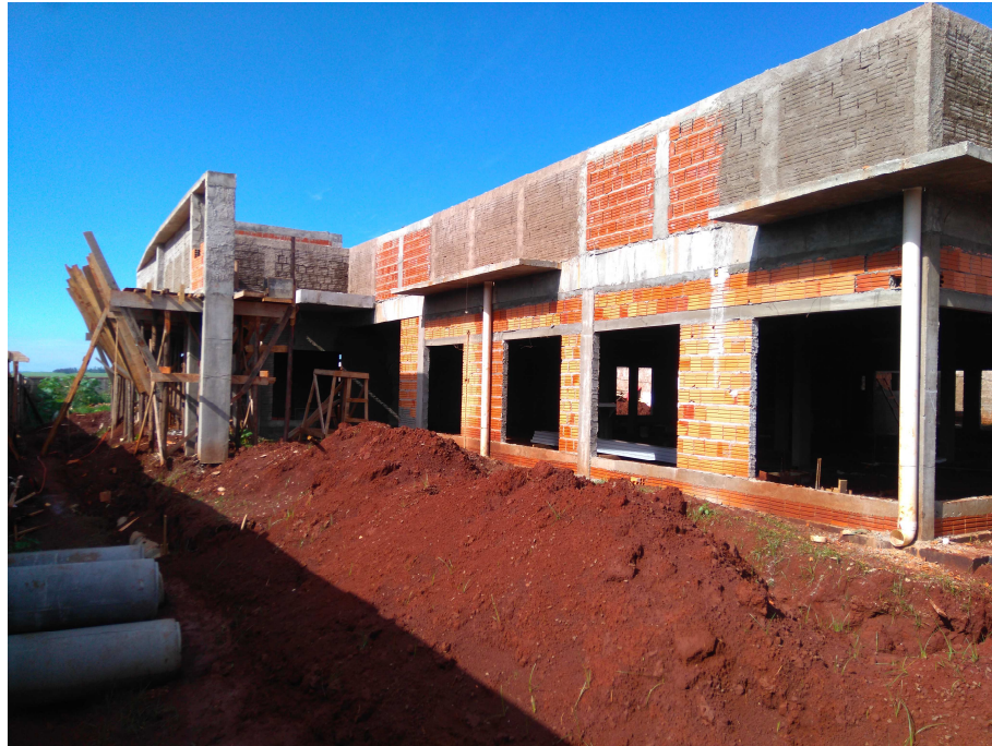
Figura 1 – Vista do canteiro de obras
