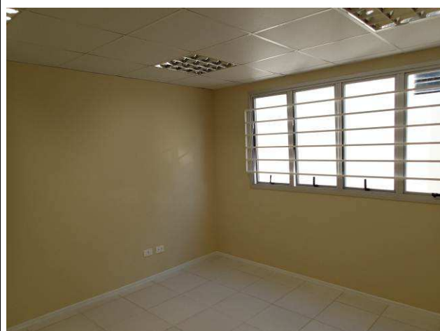
Figura 103C: Pintura acrílica interna - OAB.
