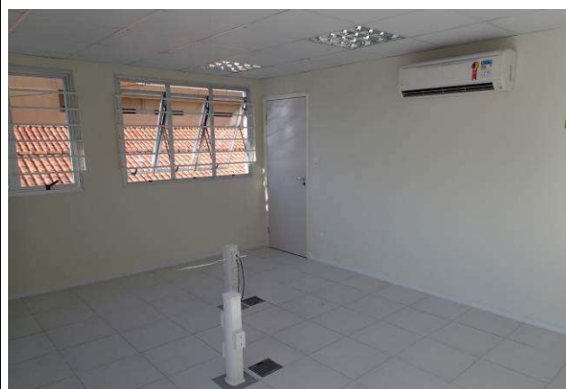
Figura 101C: Pintura acrílica interna - Sala de Audiências 2.
