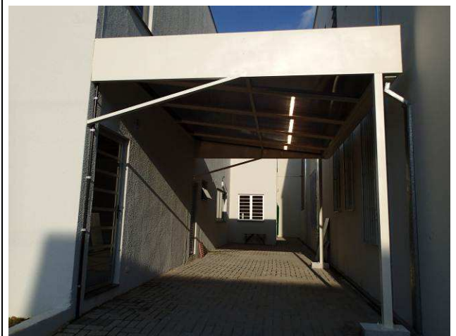
Figura 119C: Pintura esmalte na testeira do estacionamento - Lado direito.
