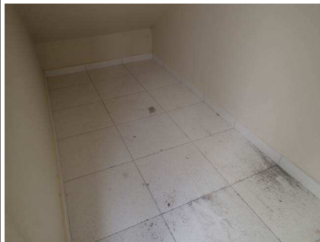
Figura 26C: Piso cerâmico Eliane (linha Cargo Plus) instalado no depósito embaixo da escada.
