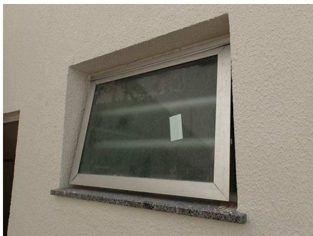
Figura 45C: Peitoril em granito cinza andorinha instalado no vão da janela do banheiro PNE.
