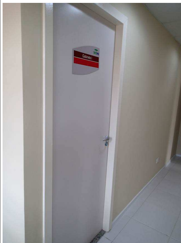
Figura 109C: Pintura esmalte em esquadrias de madeira.
