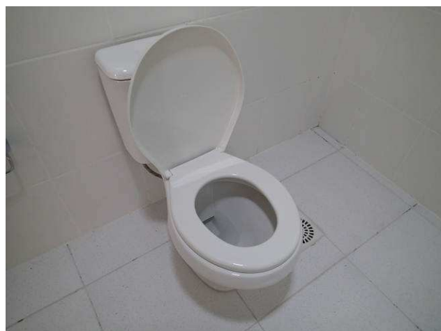
Figura 57C: Assento sanitário instalado no banheiro de uso público, no pavimento superior.
