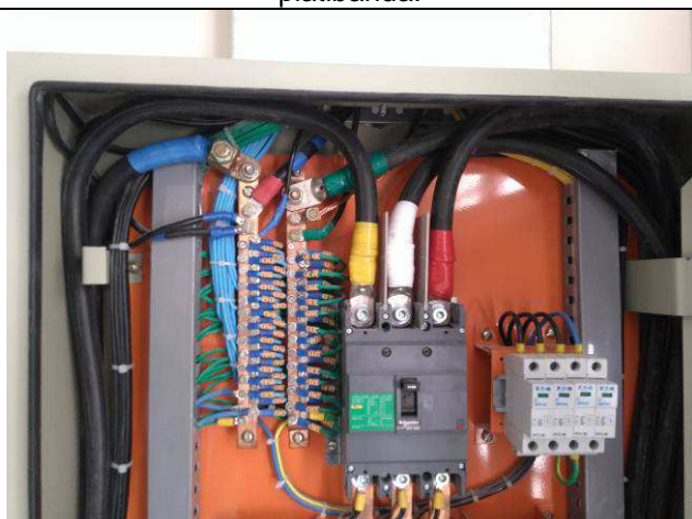
Figura 76E: equipotencialização - quadros elétricos.
