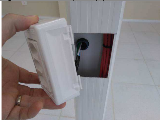
Figura 12E: tomadas e porta equipamentos Dutotec.
