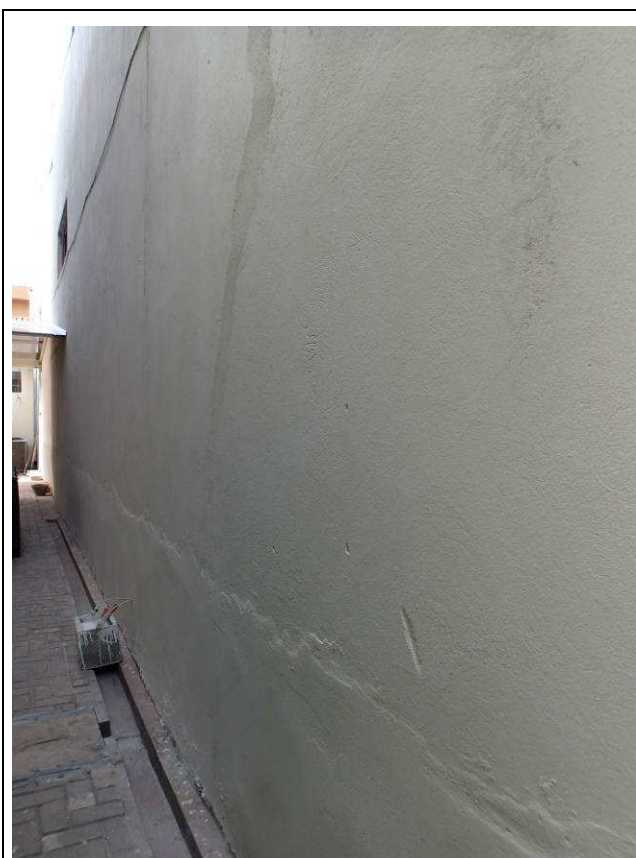
Figura 86C: Pintura acrílica executada nas paredes do imóvel vizinho (fundos).
