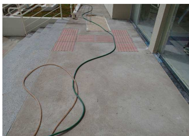
Figura 41C: Piso cimentado executado na área de entrada e da rampa PNE.
