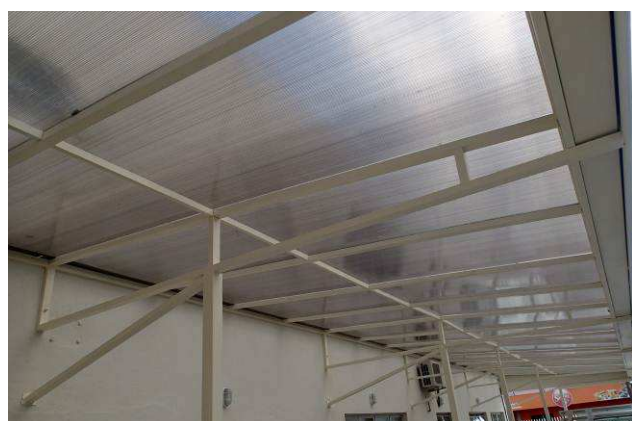
Figura 17C: Telhas em polycarbonato bronze - cobertura do estacionamento - lateral esquerda.
