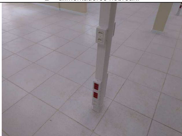
Figura 10E: tomadas e porta equipamentos Dutotec.
