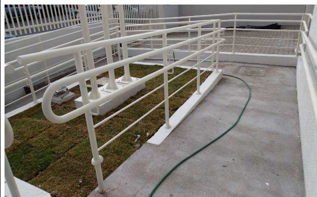
Figura 81C: Guarda corpo e corrimão da rampa PNE.
