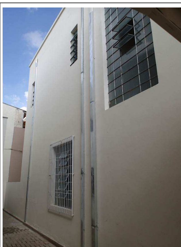
Figura 87C: Pintura acrílica executada nas paredes do imóvel vizinho (lateral direita).
