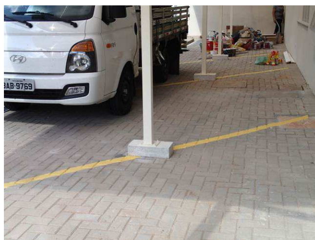
Figura 124C: Pintura acrílica - demarcação de vagas.
