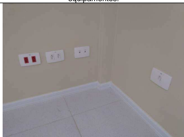
Figura 59E: Conectores RJ45 cat6, tomadas modulares de parede.
