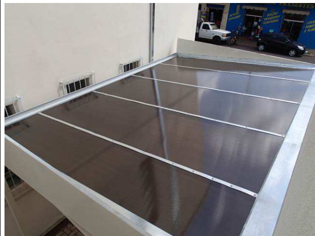
Figura 22C: Telhas em policarbonato bronze - cobertura do estacionamento - lateral direita.
