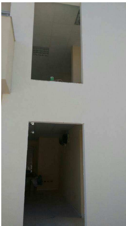
Figura 04C: Abertura de vãos para acesso à plataforma elevatória.
