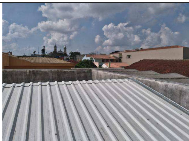
Figura 72E: Gaiola de Faraday - fitas ao redor da platibanda.
