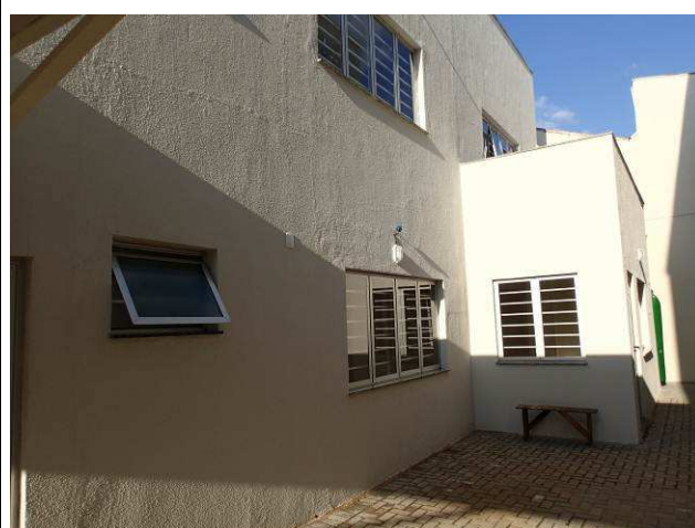
Figura 105C: Textura acrílica externa - Lateral direita.
