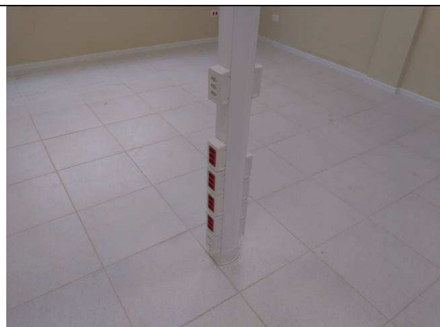
Figura 9E: tomadas e porta equipamentos Dutotec.
