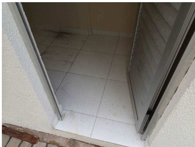
Figura 25C: Piso cerâmico Eliane (linha Cargo Plus) instalado no depósito embaixo da escada.
