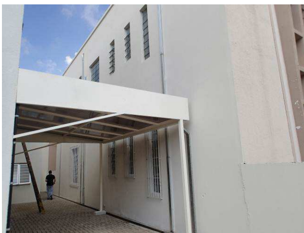
Figura 89C: Pintura acrílica executada nas paredes do imóvel vizinho (lateral direita).
