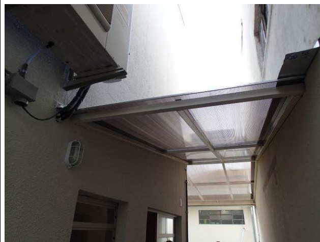
Figura 24C: Telhas em policarbonato bronze - cobertura do estacionamento - área serviço fundos.
