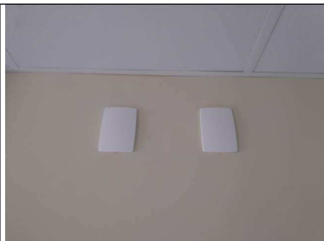
Figura 43E: tampas cegas para CFTV e alarme.
