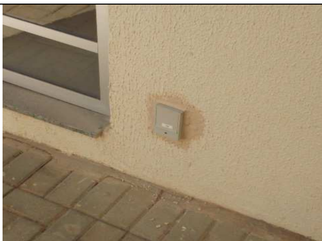
Figura 22E: tomadas externas linha aquatic.
