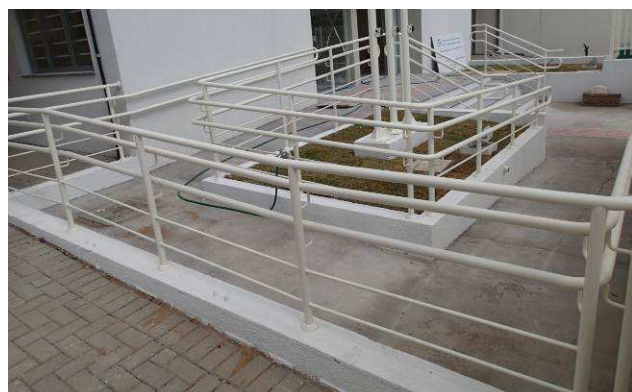
Figura 80C: Guarda corpo e corrimão da rampa PNE.
