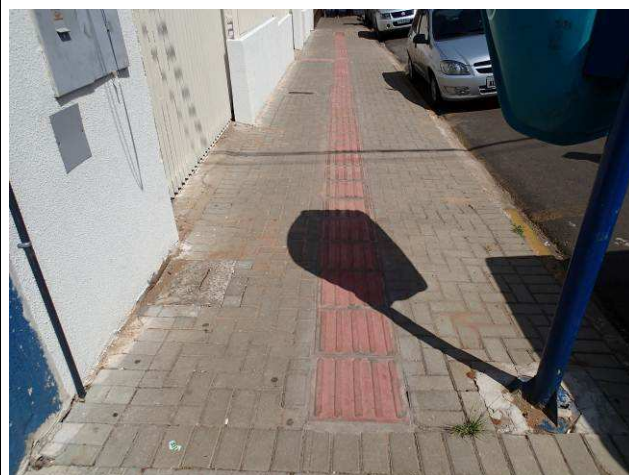
Figura 05C: Trecho de paver removido, para instalação do piso podotátil no passeio.
