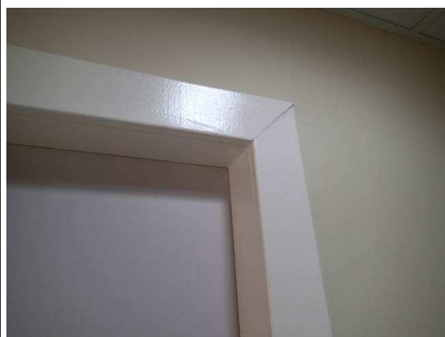
Figura 111C: Pintura esmalte em esquadrias de madeira.
