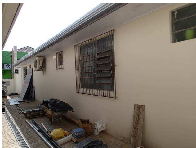
Figura 88C: Pintura acrílica executada nas paredes do imóvel vizinho (lateral esquerda).
