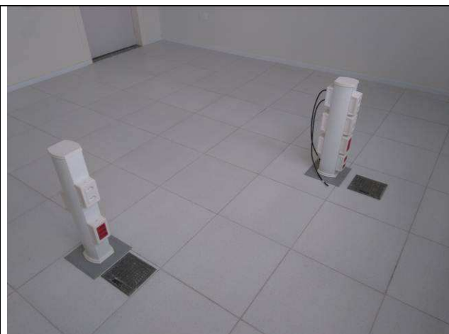
Figura 13E: tomadas e porta equipamentos Dutotec.
