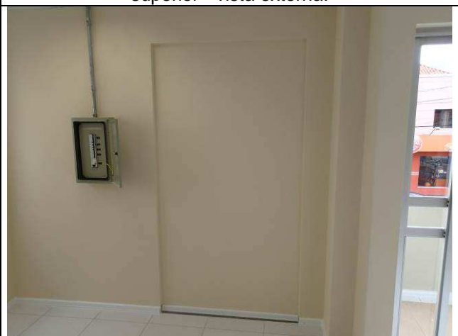
Figura 134C: Fechamento da abertura superior - pintura - vista interna.
