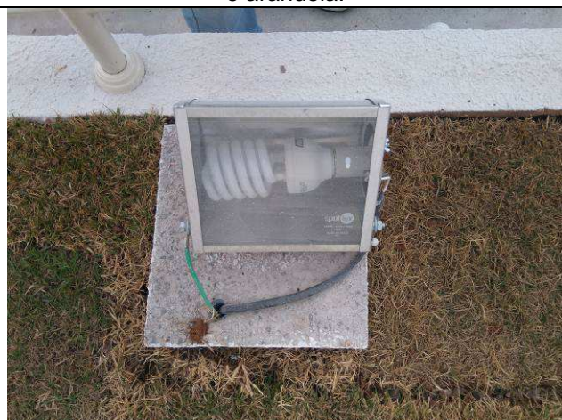
Figura 34E: projetor iluminação externa.
