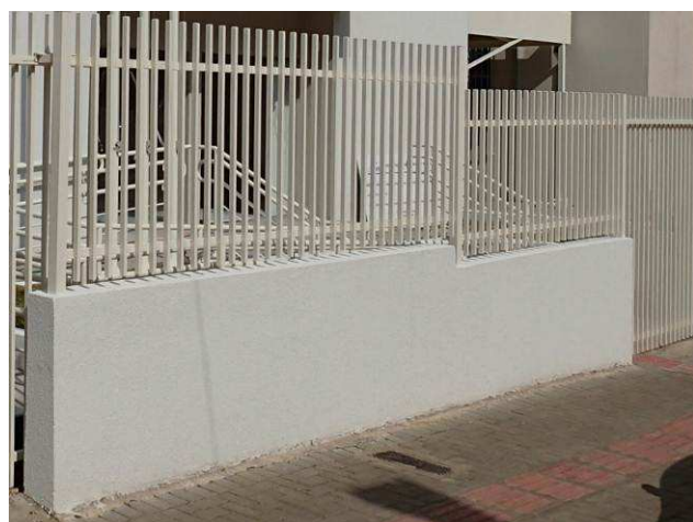
Figura 90C: Pintura acrílica na mureta abaixo do gradil.
