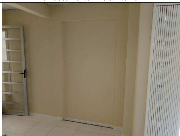
Figura 133C: Fechamento da abertura inferior - pintura - vista interna.
