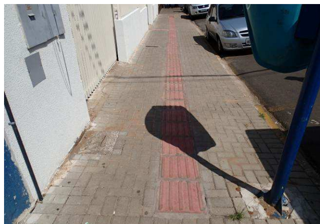
Figura 33C: Placas cimentícias de piso podotátil instaladas no passeio e área externa.
