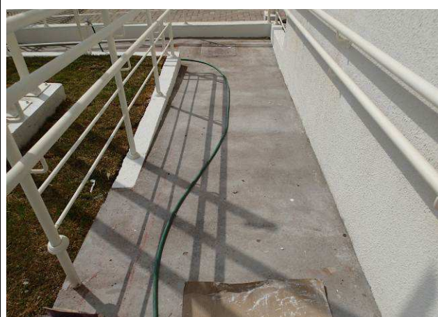
Figura 42C: Piso cimentado executado na área de entrada e da rampa PNE.
