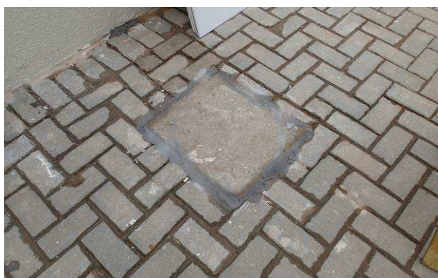
Figura 27C: Pavimentação recomposta ao redor de tampas de caixas de passagem.
