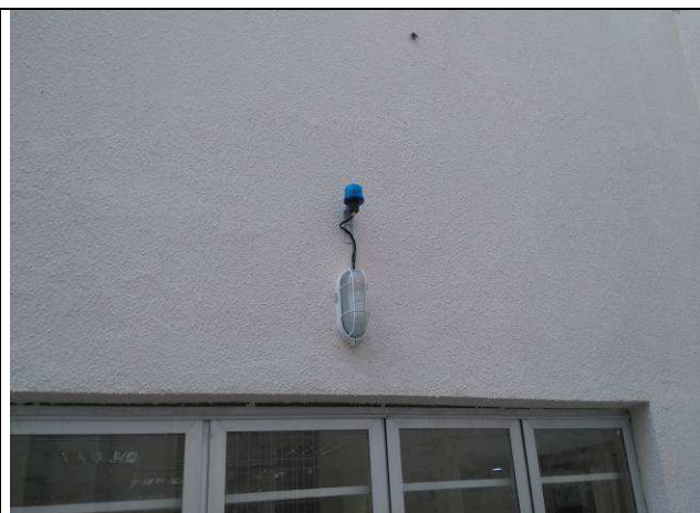
Figura 26E: relé fotoelétrico e luminária externa.
