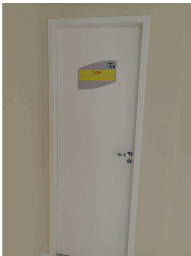
Figura 108C: Pintura esmalte em esquadrias de madeira.
