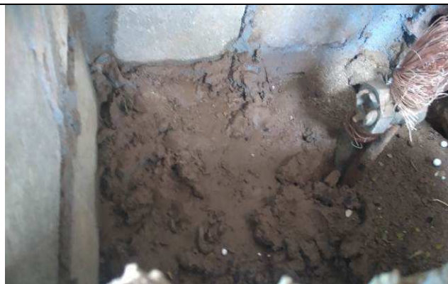
Figura 68E: caixa de piso para inspeção de aterramento - cabo cobre nu e haste.
