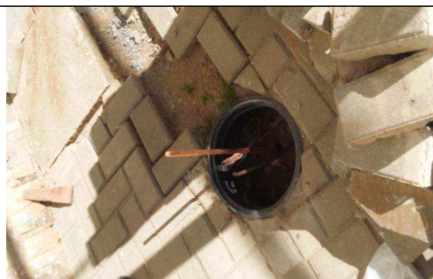
Figura 65E: caixa de piso para inspeção de aterramento - cabo cobre nu e haste.
