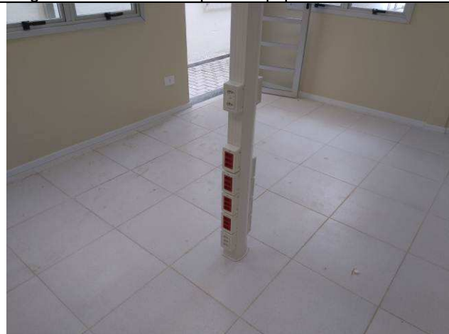
Figura 11E: tomadas e porta equipamentos Dutotec.
