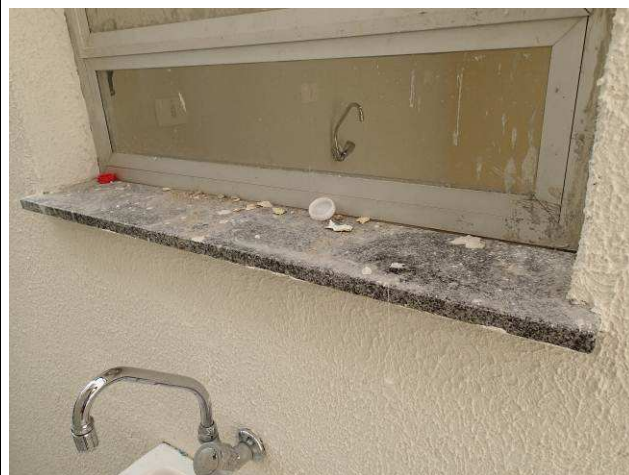
Figura 46C: Peitoril em granito cinza andorinha instalado no vão da janela da copa.
