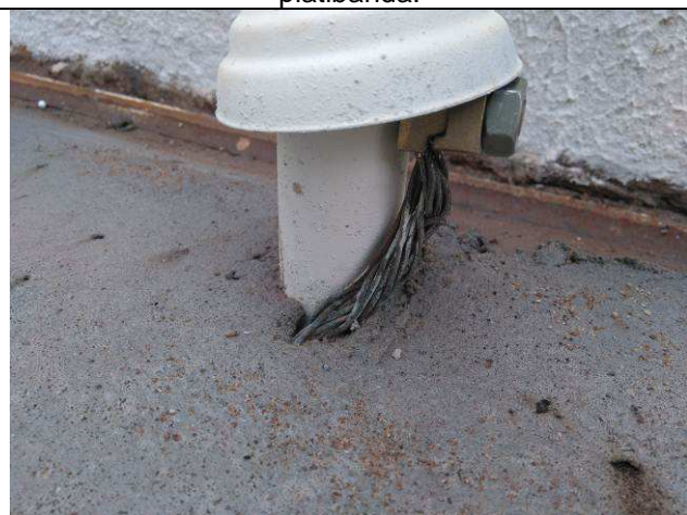
Figura 77E: equipotencialização das partes metálicas.
