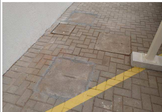
Figura 30C: Pavimentação recomposta ao redor de tampas de caixas de passagem.
