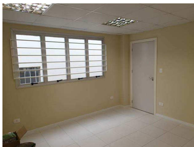
Figura 98C: Pintura acrílica interna - Gabinete de Juiz 1.
