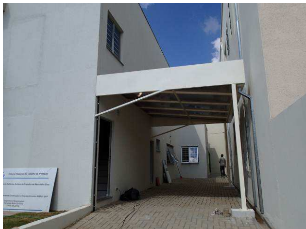
Figura 21C: Telhas em policarbonato bronze - cobertura do estacionamento - lateral direita.
