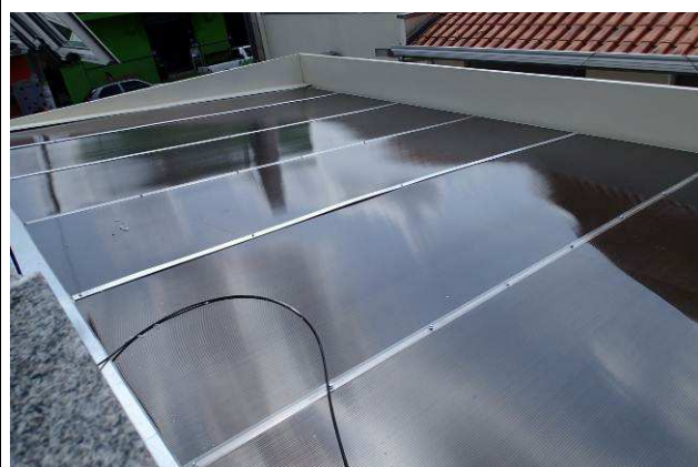
Figura 18C: Telhas em polycarbonato bronze - cobertura do estacionamento - lateral esquerda.
