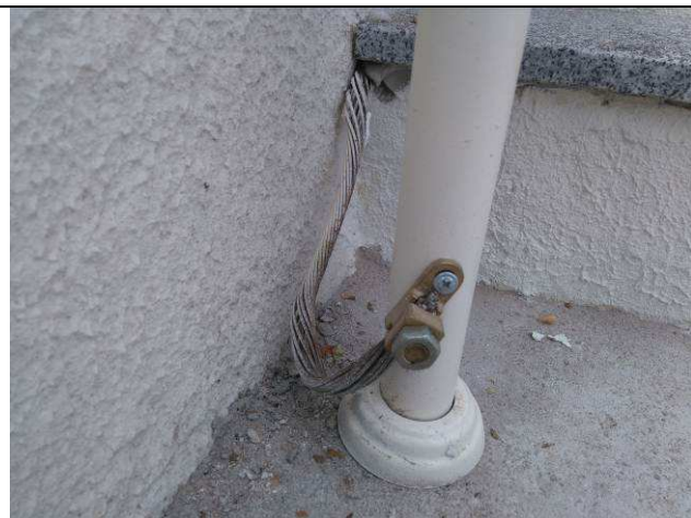
Figura 79E: equipotencialização das partes metálicas.
