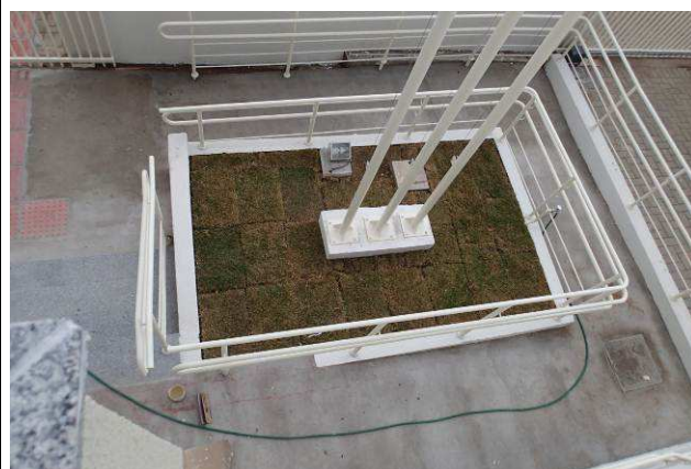
Figura 40C: Piso cimentado executado na área de entrada e da rampa PNE.
