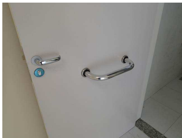
Figura 71C: Barras de apoio para porta - banheiro PNE do pavimento térreo.
