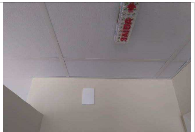
Figura 42E: tampas cegas para CFTV e alarme.
