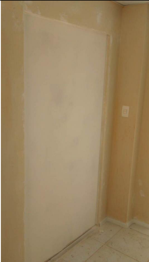
Figura 133C: Fechamento da abertura inferior - emassamento - vista interna.
