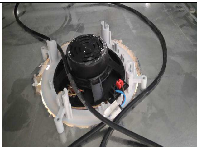
Figura 62E: Sonorização - caixa de som arandela.
