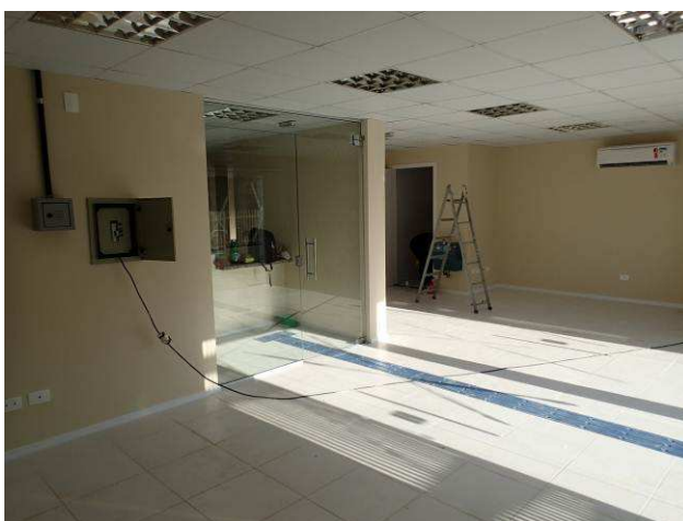
Figura 91C: Pintura acrílica interna - Hall público.
