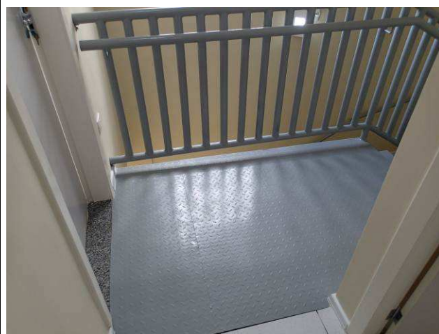
Figura 115C: Pintura esmalte na escada metálica.
