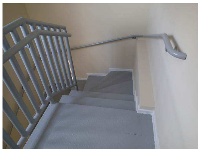
Figura 114C: Pintura esmalte na escada metálica.
