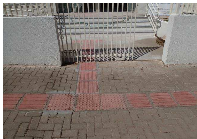
Figura 34C: Placas cimentícias de piso podotátil instaladas no passeio e área externa.
