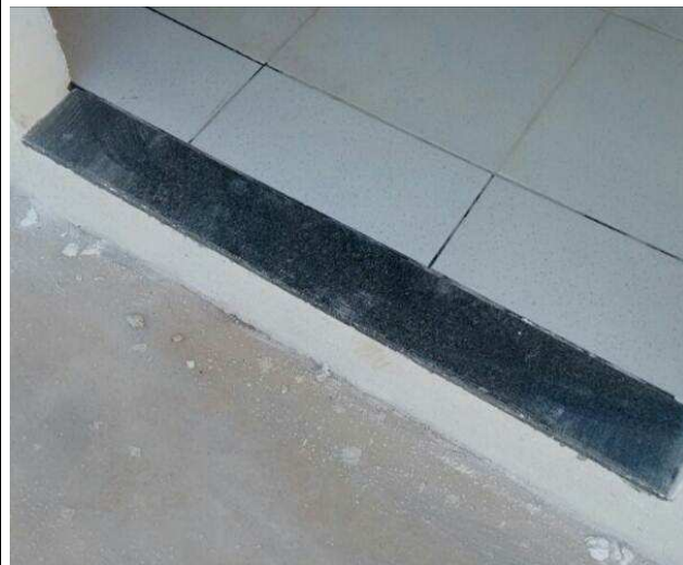
Figura 44C: Soleira em granito cinza andorinha instalado no vão de acesso à plataforma elevatória.
