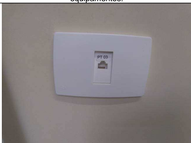
Figura 60E: Conectores RJ45 cat6, tomadas modulares de parede.
