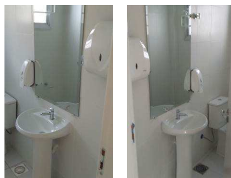
Figura 68C: Dispensers de sabonete líquido e papel toalha - banheiros secretaria pavimento inferior.
