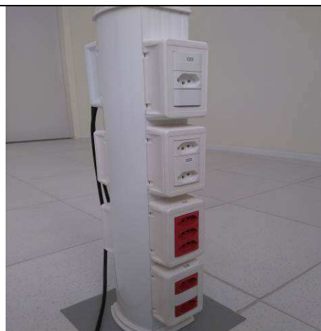
Figura 14E: tomadas e porta equipamentos Dutotec.
