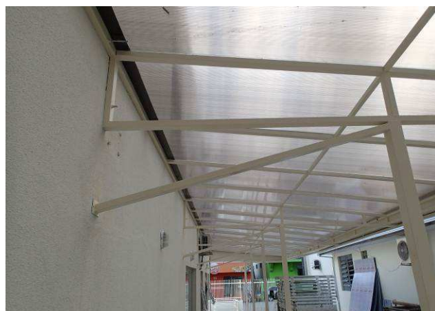
Figura 15C: Mãos francesas instaladas sob a cobertura do estacionamento - lateral esquerda.
