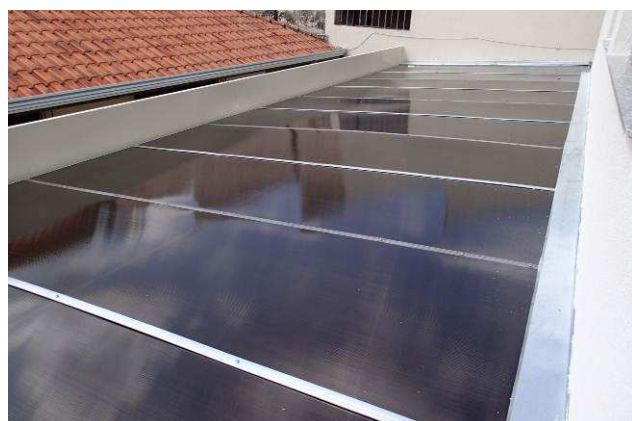
Figura 19C: Telhas em polycarbonato bronze - cobertura do estacionamento - lateral esquerda.
