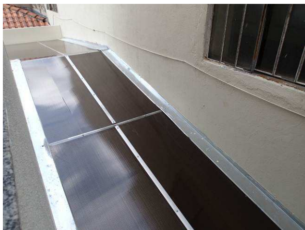
Figura 23C: Telhas em policarbonato bronze - cobertura do estacionamento - área serviço fundos.
