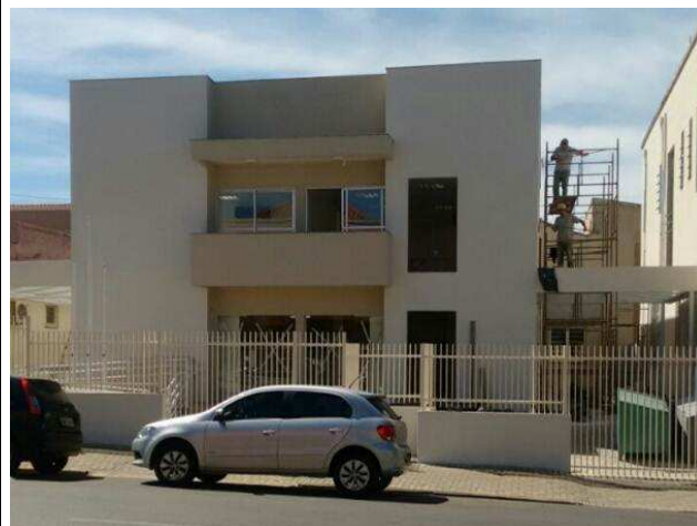
Figura 03C: Abertura de vãos para acesso à plataforma elevatória.
