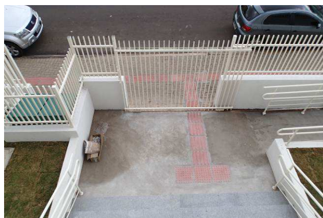
Figura 39C: Piso cimentado executado na área de entrada e da rampa PNE.
