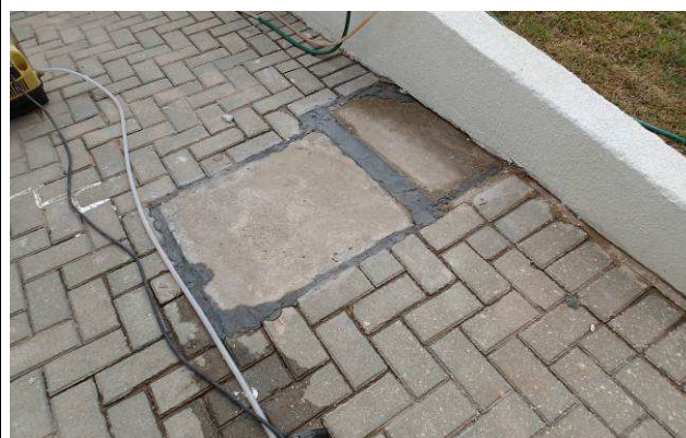
Figura 28C: Pavimentação recomposta ao redor de tampas de caixas de passagem.
