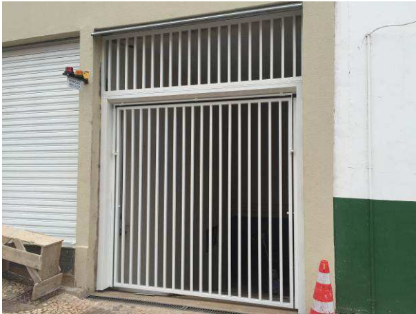
Figura 82C: Pintura do portão de acesso ao subsolo
