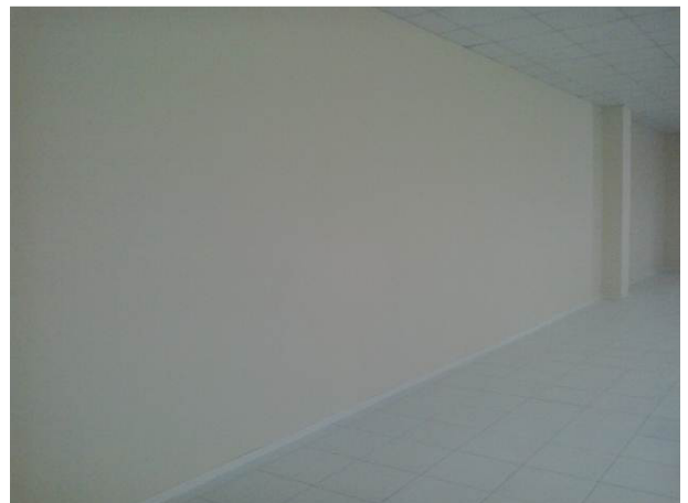
Figura 81C: Detalhe da instalação de rodapés e pintura da parede do PAB 2, no térreo
