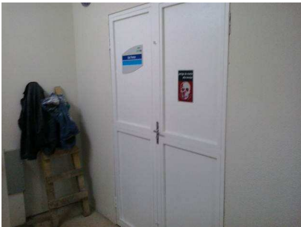
Figura 54C: Pintura de portas no subsolo
