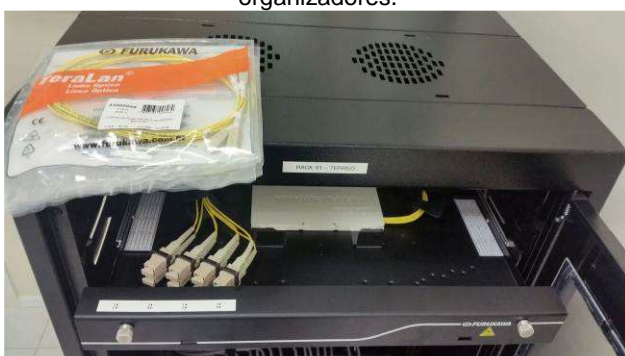
Figura 73E: DIO, fusão fibras
