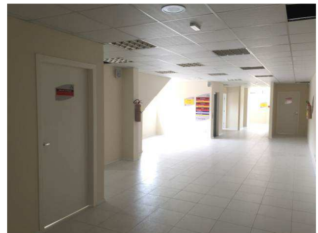
Figura 63C: Segunda demão de pintura no primeiro pavimento
