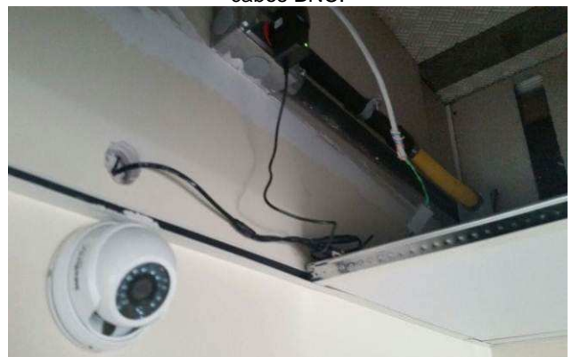
Figura 88E: CFTV - câmeras, ballon, fonte
