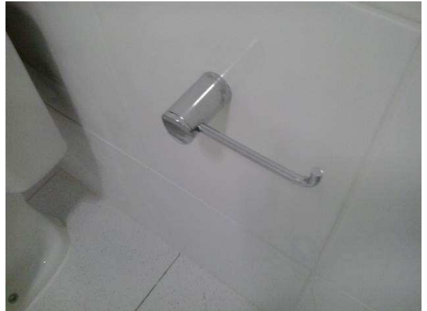
Figura 30C: Papeleiro metálico instalado em diversos sanitários do imóvel, nesta etapa
