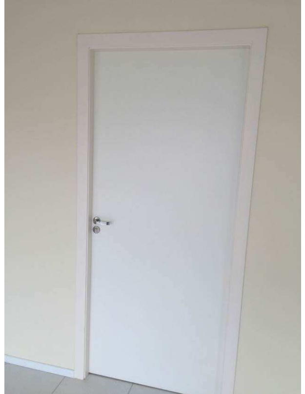
Figura 55C: Pintura de portas no térreo
