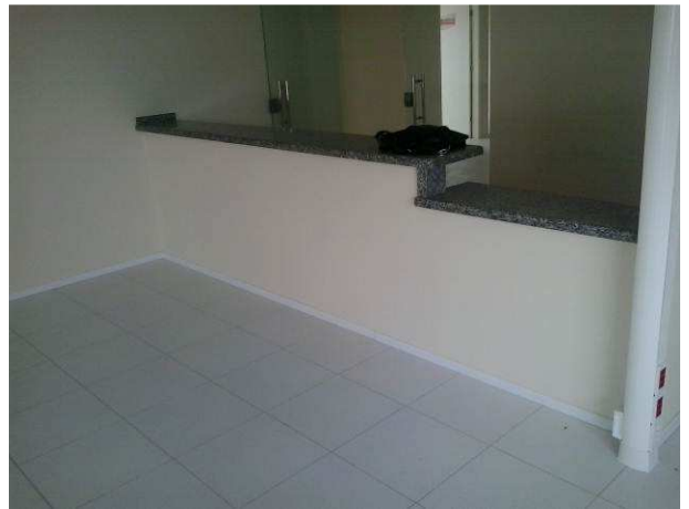
Figura 18C: Rodapés instalados no imóvel - pavimento térreo
