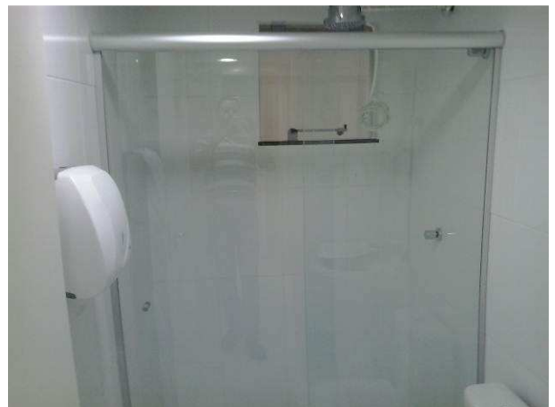
Figura 05C: Um dos boxes instalados - banheiros dos vestiários
