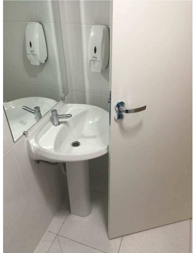
Figura 10C: Azulejos instalados em BWC da distribuição
