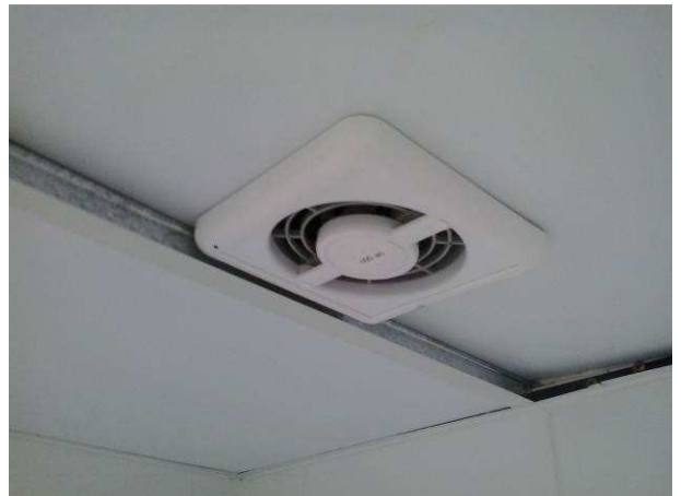
Figura 44C: Modelo de Ventokit, que está conectado aos dutos, para exaustão dos sanitários
