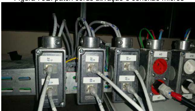
Figura 81E: patch cords padrão genérico
