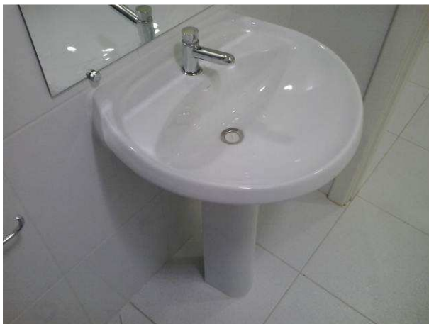
Figura 25C: Modelo de lavatório de louça com coluna - Deca Ravena - instalados nos banheiros comuns
