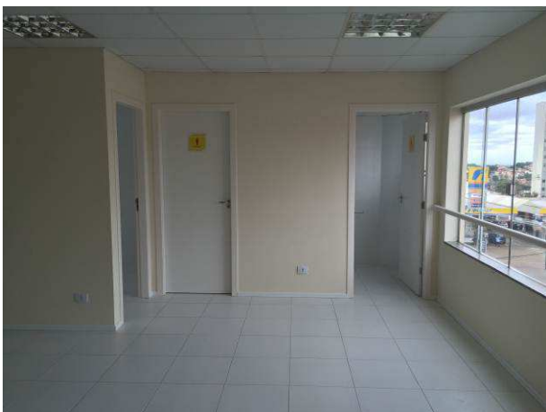
Figura 21C: Rodapés instalados no imóvel - segundo pavimento
