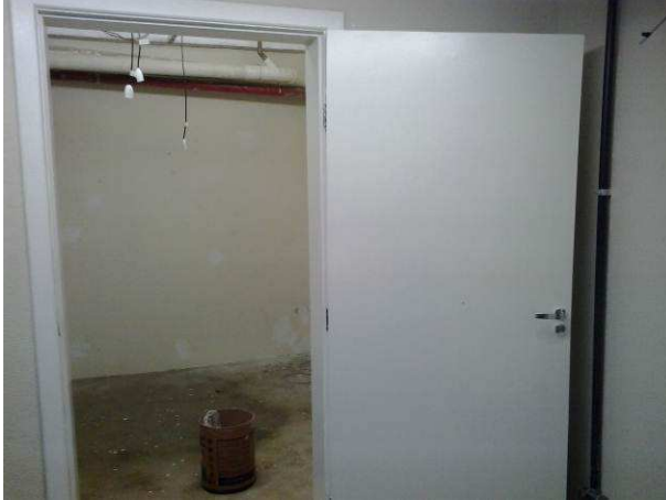
Figura 53C: Pintura de portas no subsolo
