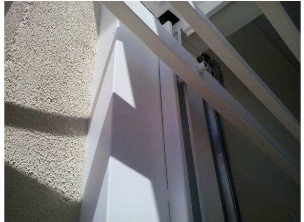
Figura 83C: Pintura do portão de acesso ao subsolo
