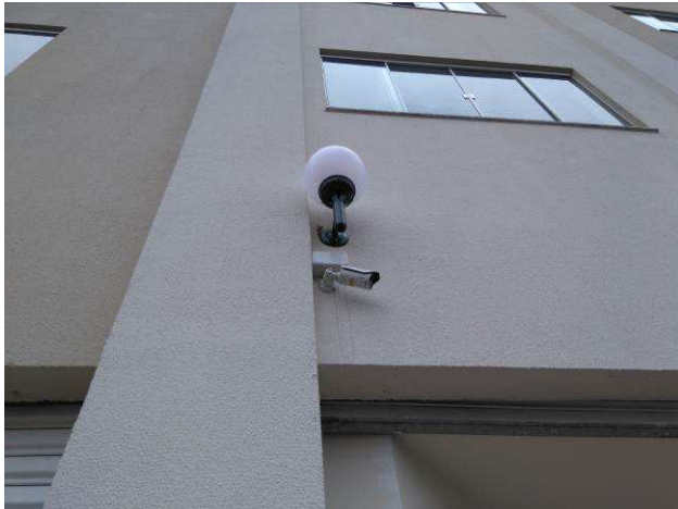
Figura 95E: CFTV - câmeras, ballon, fonte
