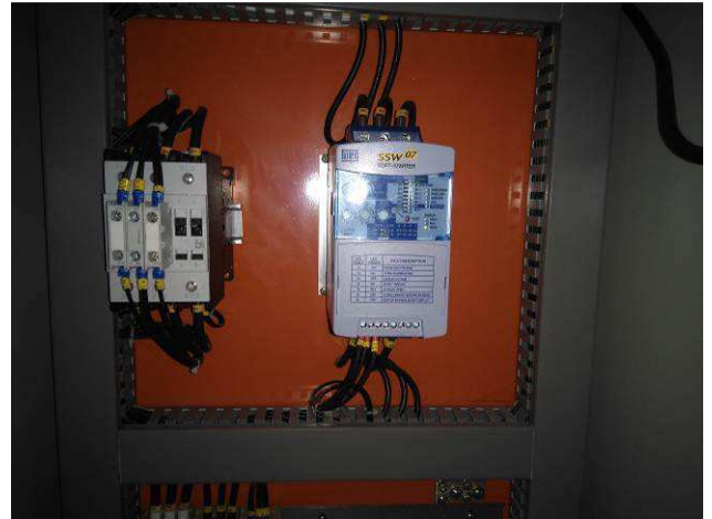
Figura 8E: ramal alimentador Bomba de Incêndios
