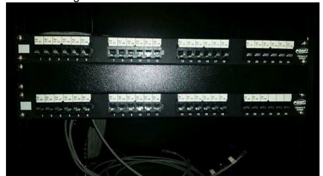
Figura 70E: racks e acessórios - patch panel, organizadores.
