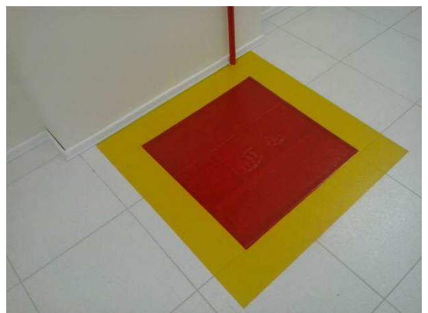
Figura 52C: Detalhe da sinalização de piso
