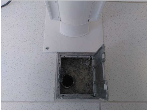
Figura 25E: caixas de piso com tampa antiderrapante
