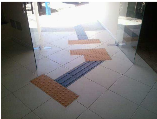
Figura 15C: Piso tátil instalado na entrada do imóvel
