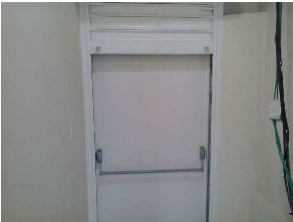
Figura 60C: Pintura de portas corta-fogo
