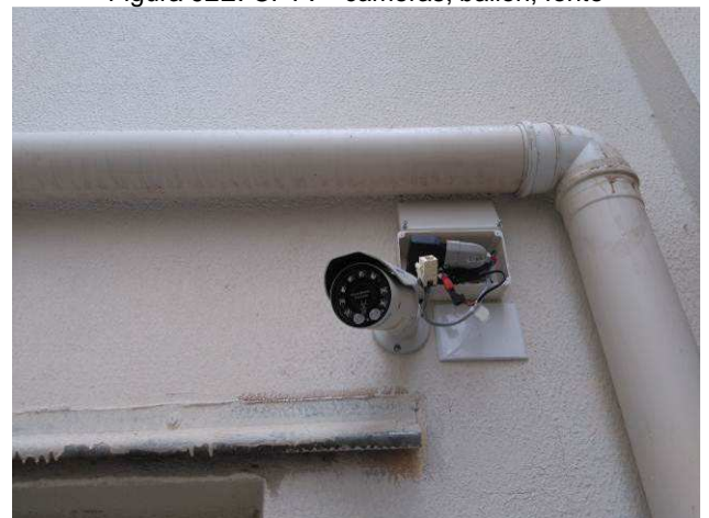
Figura 94E: CFTV - câmeras, ballon, fonte
