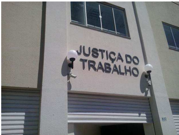
Figura 77C: Letreiro instalado na fachada frontal do imóvel
