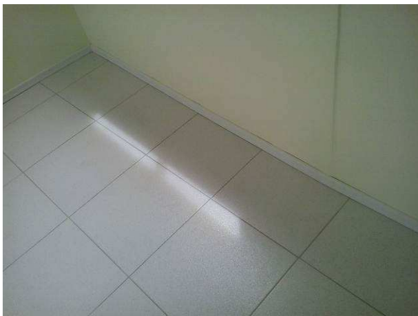
Figura 19C: Rodapés instalados no imóvel - primeiro pavimento
