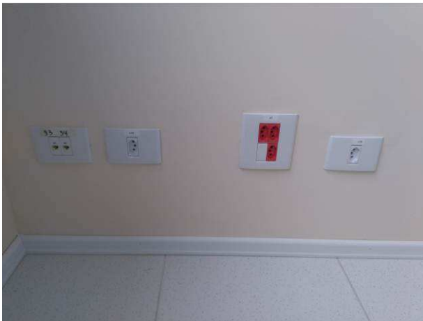
Figura 17C: Rodapés instalados no imóvel - pavimento térreo
