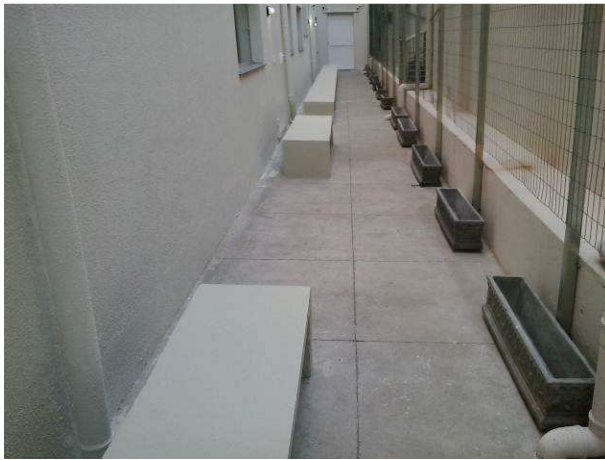
Figura 69C: Jardineiras em concreto, instaladas no corredor lateral esquerdo do pavimento térreo
