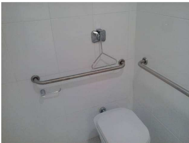
Figura 39C: Barras de apoio para PNE, instaladas junto ao vaso sanitário
