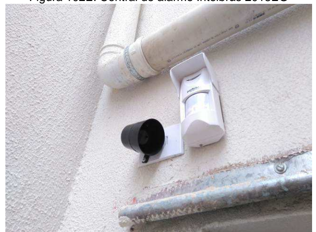
Figura 104E: sensores externos e sirene
