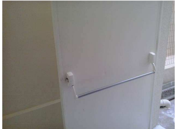
Figura 59C: Pintura de portas corta-fogo
