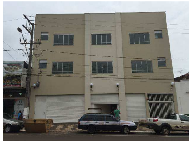
Figura 61C: Pintura das portas de enrolar da fachada frontal
