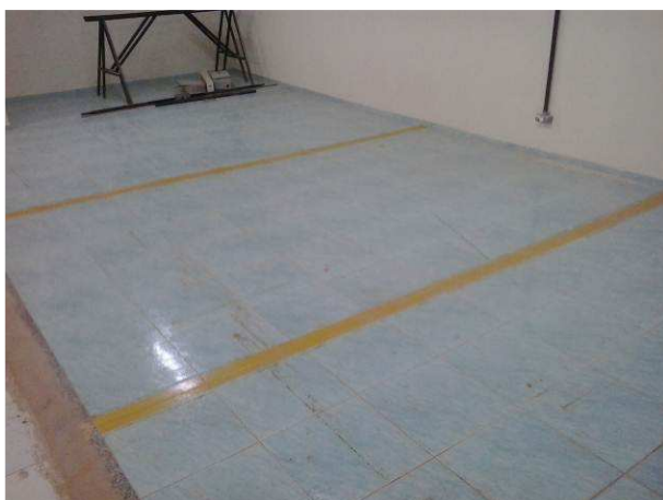
Figura 68C: Demarcação de vagas do estacionamento, no subsolo
