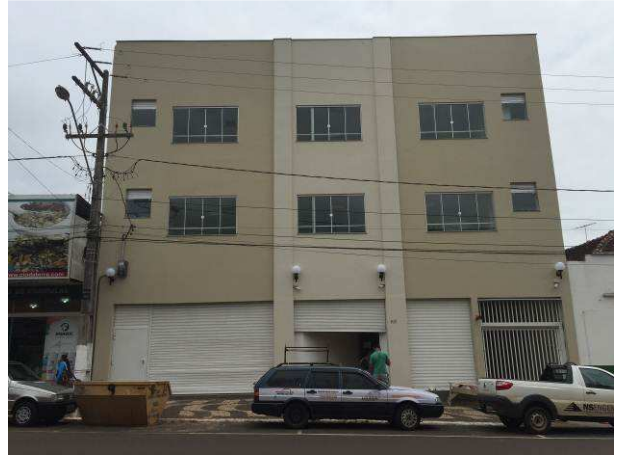
Figura 87C: Rufo instalado sobre a platibanda frontal do imóvel
