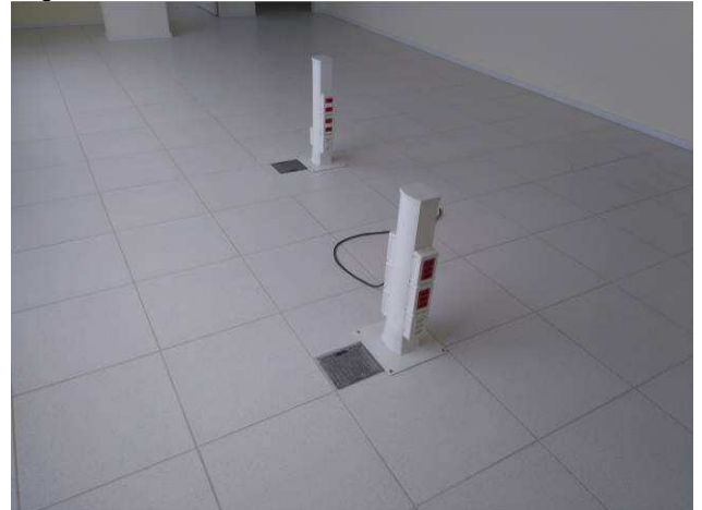
Figura 22E: totens e tomadas elétricas Dutotec
