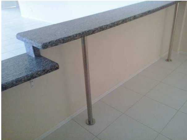
Figura 03C: Balcão de atendimento instalado no segundo pavimento
