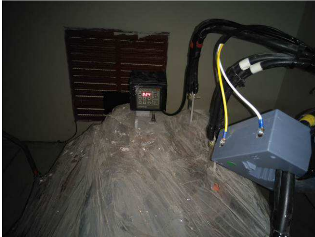
Figura 3E: cabine de transformação
