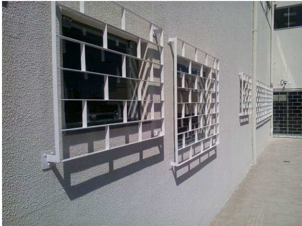
Figura 64C: Pintura nas grades das janelas do primeiro pavimento
