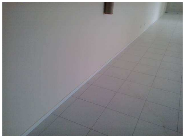
Figura 22C: Rodapés instalados no imóvel - segundo pavimento
