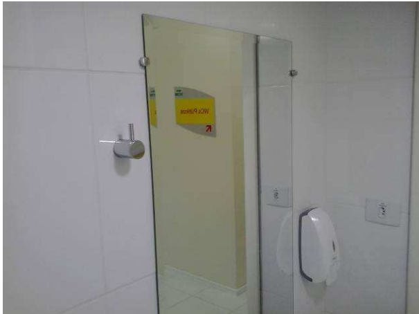
Figura 35C: Espelho cristal, instalado na posição vertical, nos sanitários comuns
