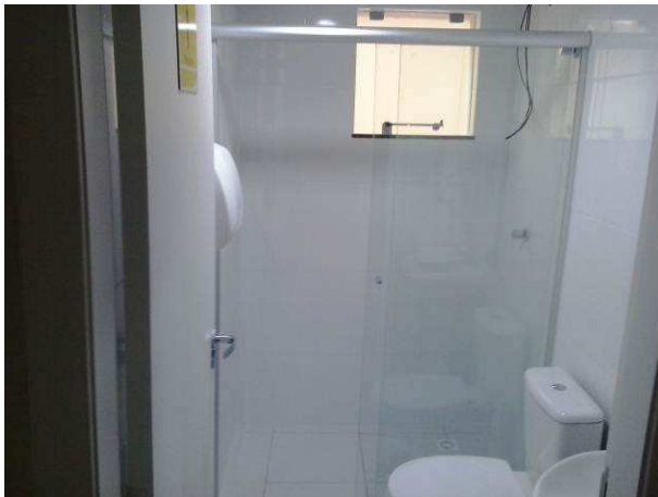
Figura 09C: Azulejos instalados em sanitário de vestiário
