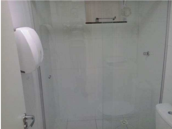
Figura 08C: Azulejos instalados em sanitário de vestiário
