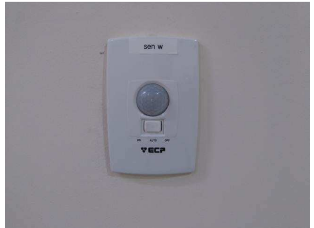
Figura 46E: sensor de presença.
