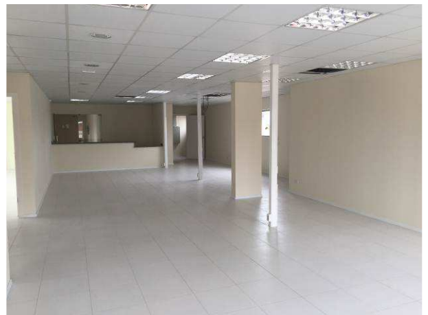
Figura 20C: Rodapés instalados no imóvel - primeiro pavimento
