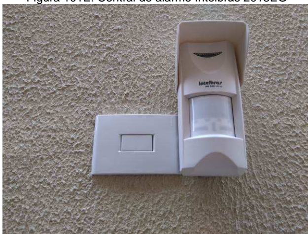
Figura 103E: sensores externos
