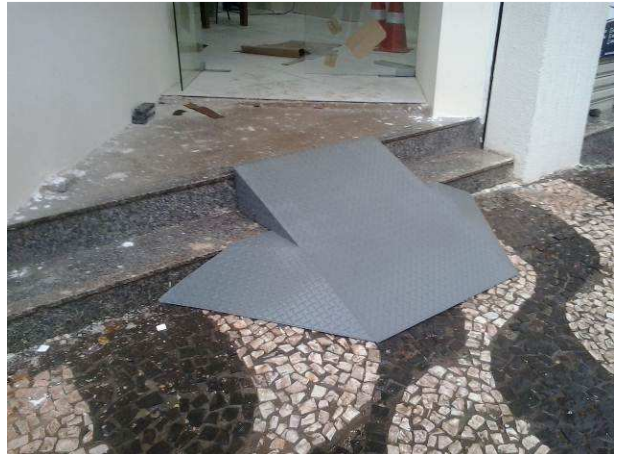
Figura 93C: Rampa metálica móvel
