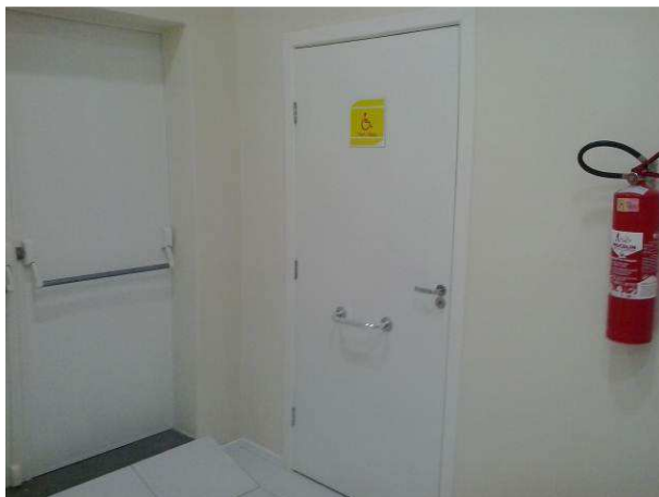
Figura 04C: Porta de madeira instalada no BWC PNE do pavimento térreo
