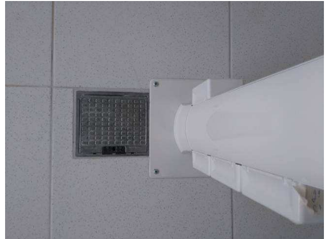
Figura 26E: caixas de piso com tampa antiderrapante
