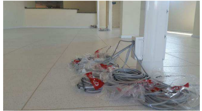
Figura 76E: patch cords para padrão genérico
