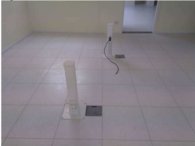
Figura 23E: totens e tomadas elétricas Dutotec
