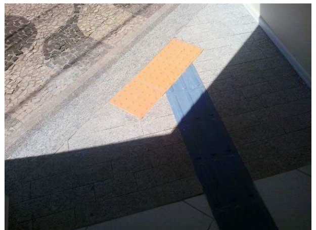
Figura 16C: Piso tátil instalado na entrada do imóvel. Também na imagem, granito bruto
