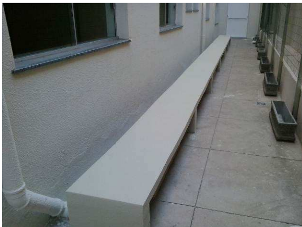
Figura 80C: Pintura dos bancos de concreto, no corredor lateral esquerdo do pavimento térreo
