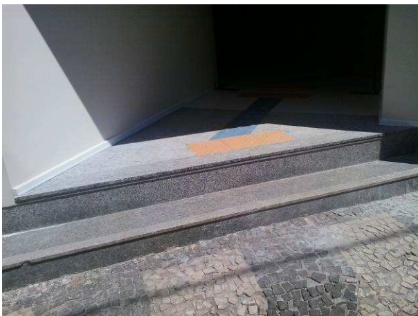
Figura 13C: Acabamento da faixa entre a escada e a porta de acesso principal ao imóvel - Granito bruto
