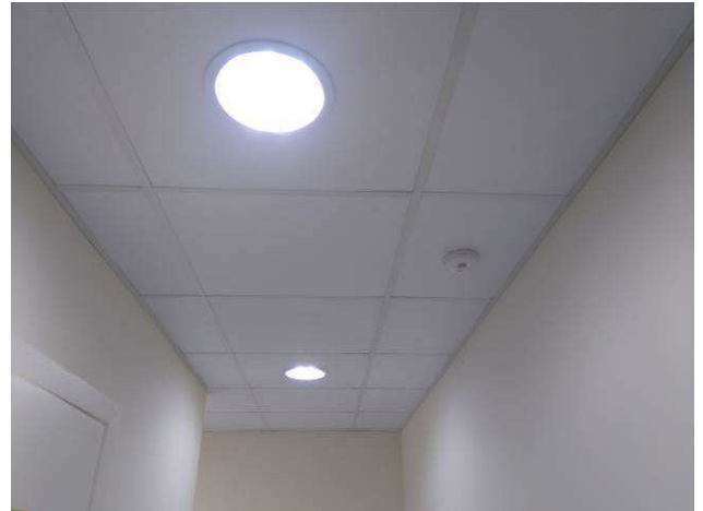
Figura 44E: sensor de presença, luminárias 2x20W.
