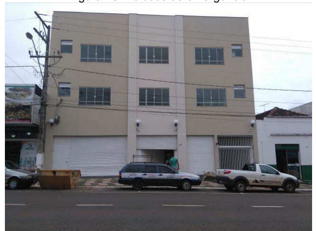
Figura 30E: luminárias externas fachada
