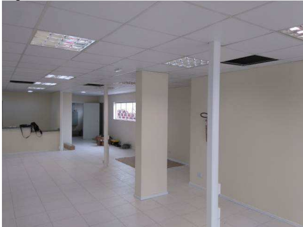
Figura 21E: colunas técnicas e tomadas elétricas Dutotec
