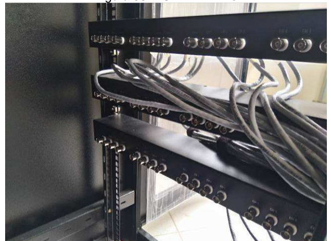
Figura 100E: CFTV - régua ballon
