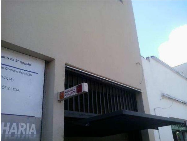
Figura 86C: Rufo instalado sobre o portão de acesso ao subsolo
