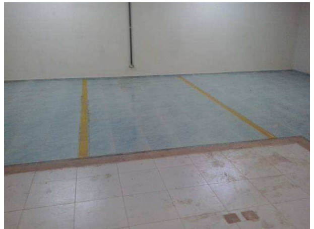
Figura 67C: Demarcação de vagas do estacionamento, no subsolo
