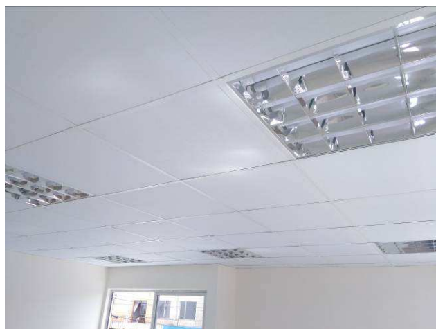
Figura 46C: Forro em placa de gesso acartonado removível (0,625x0,625 m) instalado na sala de audiências II (pav. superior).
