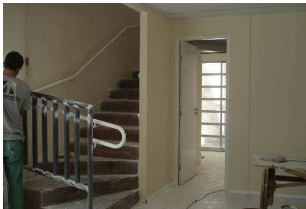
Figura 65C: Emassamento e lixamento executados em áreas remanescentes da Secretaria.
