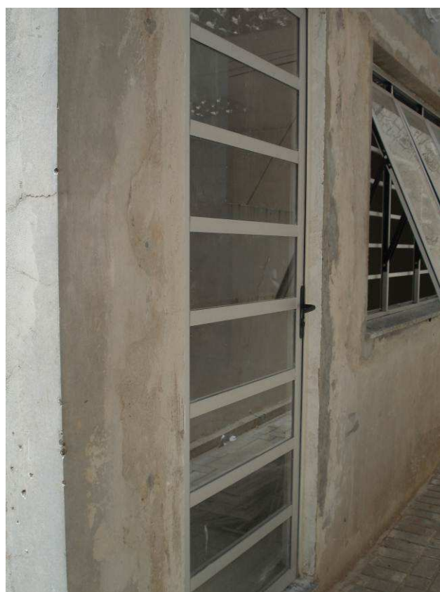
Figura 17C: Porta P04 com ajustes na vedação e alinhamento executados.
