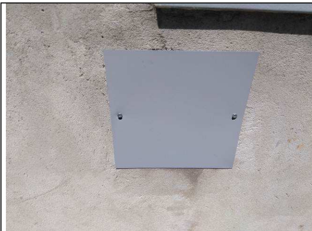
Figura 1E: caixa para entrada de telecomunicações
