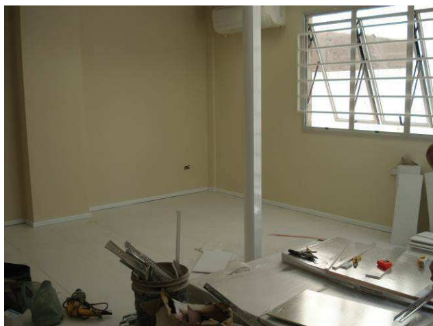
Figura 51C: Rodapé Santa Luzia, altura 5 cm, instalado em área do pavimento térreo (Secretaria).
