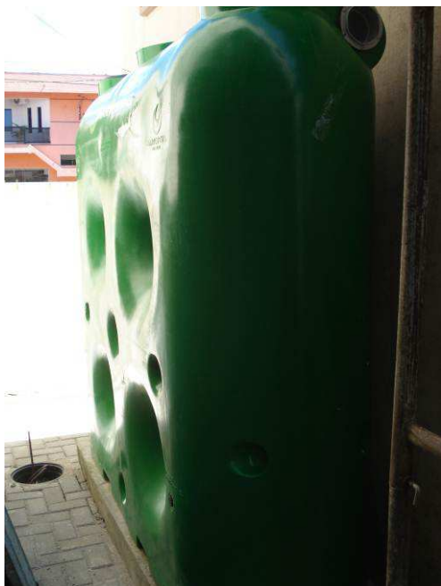
Figura 57C: Tanque aéreo Fatboy Slim, para armazenamento de águas pluviais.
