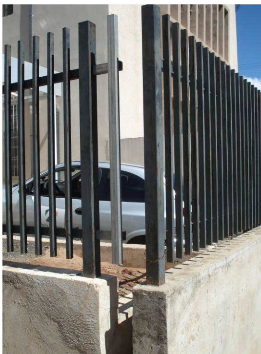
Figura 64C: Executado fechamento parcial do vão existente no gradil frontal (área da lixeira).
