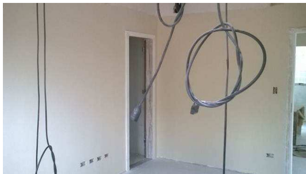
Figura 71C: Pintura executada em parede da sala de audiências II com tinta látex acrílica, cor erva doce, marca Acrillínea.
