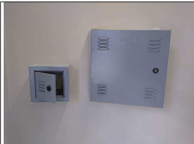
Figura 31E: caixa padrão Telebrás, para telefonia
