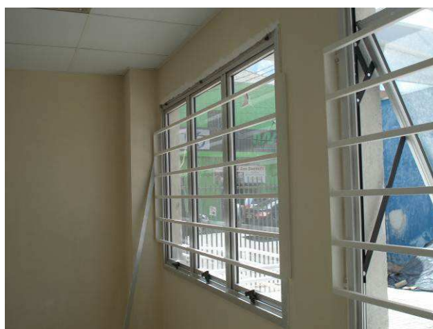
Figura 19C: Gradil em ferro tubular instalado junto às janelas da Reserva PAB.
