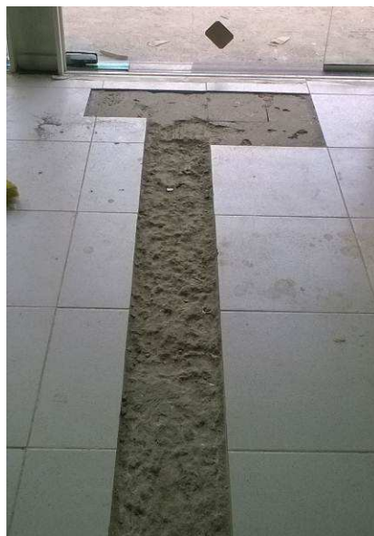
Figura 03C: Remoção de piso cerâmico para instalação de piso podotátil no Hall Público.
