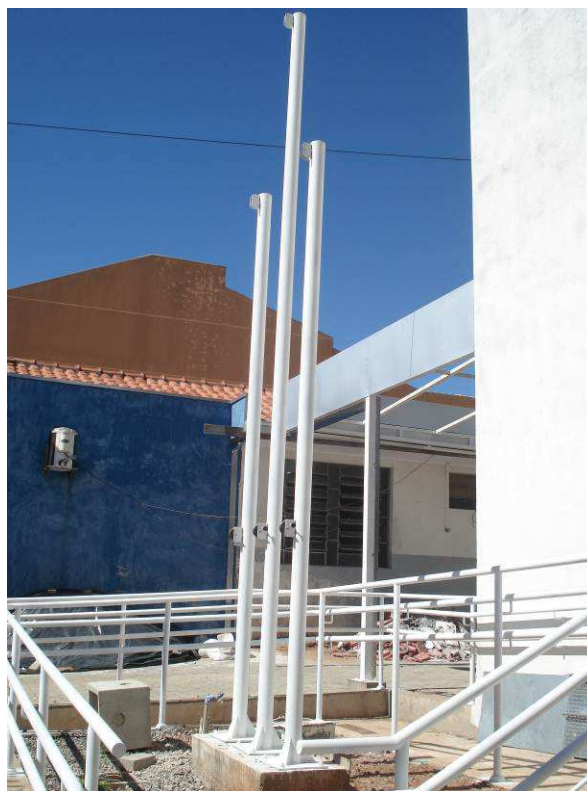
Figura 82C: Instalados 2 mastros de 3m de altura e 1 mastro de 4m de altura.
