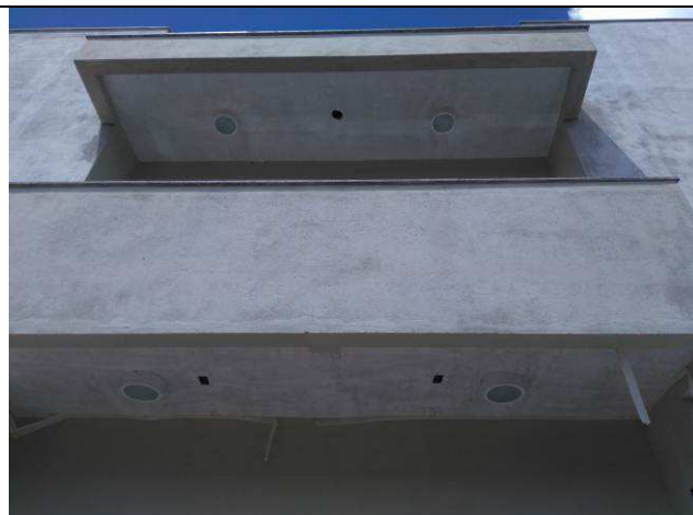
Figura 2E: caixa octogonal PVC 3" nas varandas
