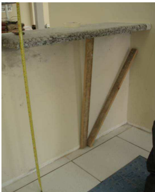
Figura 07C: Tampo inferior do balcão de atendimento rebaixado para altura final de 85 cm.
