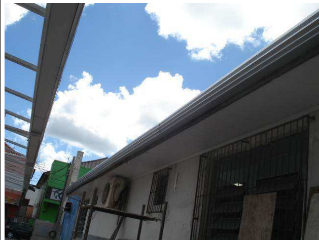
Figura 36C: Adequações executadas nas calhas do imóvel vizinho (lateral esquerda).
