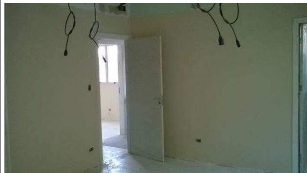
Figura 66C: Emassamento e lixamento executados no gabinete de juiz I.
