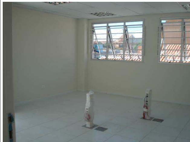
Figura 70C: Pintura executada em parede da sala de audiências I com tinta látex acrílica, cor erva doce, marca Acrillínea.
