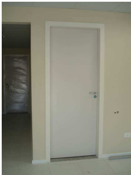
Figura 74C: Pintura em esmalte sintético, na cor branco acetinado, marca Ilva, executada na porta da sala da OAB (pavimento superior).
