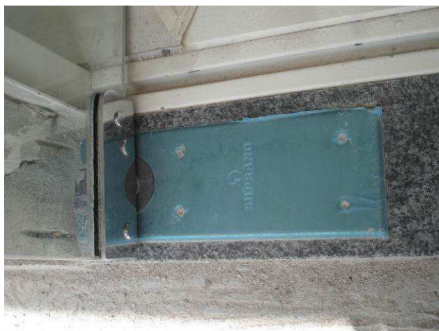
Figura 14C: Mola hidráulica (marca Soprano) utilizada na instalação das portas descritas na figura anterior.
