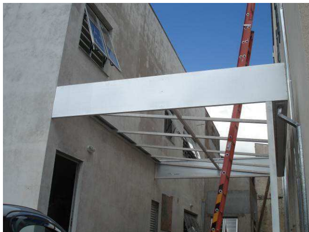
Figura 35C: Testeiras em chapa galvanizada instaladas na cobertura da vaga privativa de juiz.
