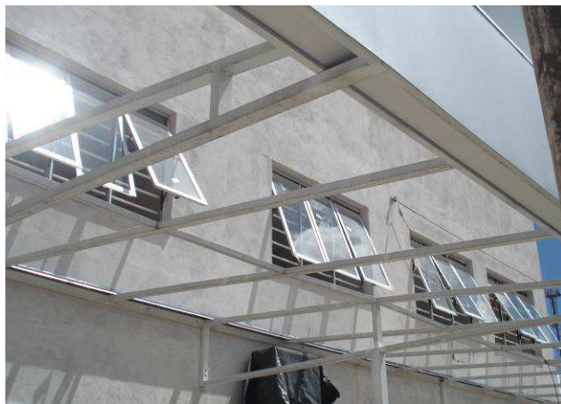
Figura 77C: Pintura em esmalte sintético, cor branco acetinado, marca Ilva executada nas grades de janelas do pavimento superior.
