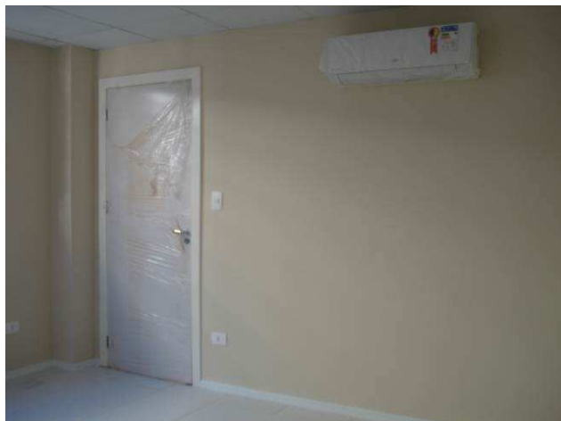
Figura 69C: Pintura executada em parede do gabinete de juiz I com tinta látex acrílica, cor palha, marca Acrillínea.
