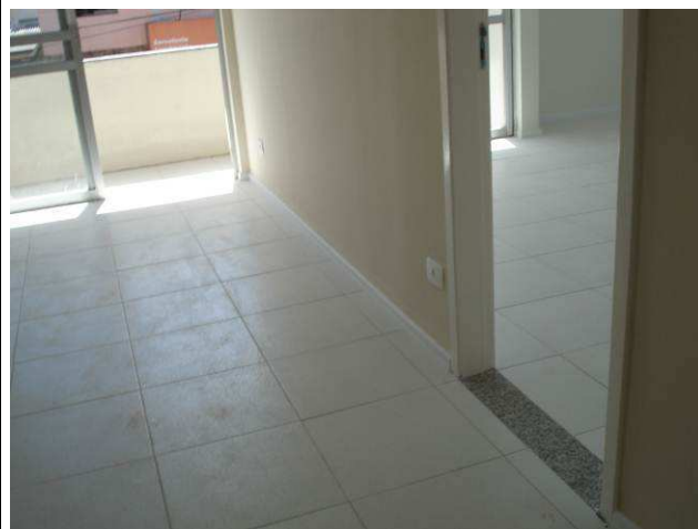
Figura 52C: Rodapé Santa Luzia, altura 5 cm, instalado em área do pavimento superior (sala de espera).
