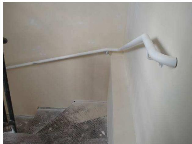
Figura 78C: Fundo zarcão aplicado no corrimão da escada metálica.
