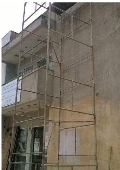
Figura 01C: Andaime utilizado para execução de revestimentos argamassados.
