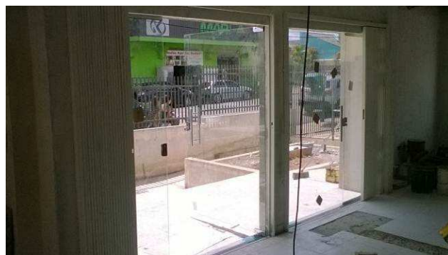
Figura 48C: Requadro de vão (emboço paulista) executado nos vãos das janelas PJ1A na entrada do edifício (térreo).
