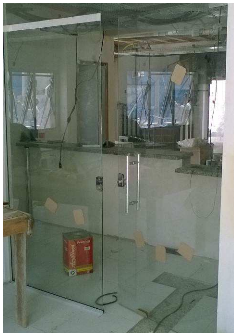
Figura 10C: Porta PJ2 em vidro temperado incolor (10mm) e painel em vidro fixo VF2 (10mm) instalada no acesso ao balcão de atendimento da Secretaria.
