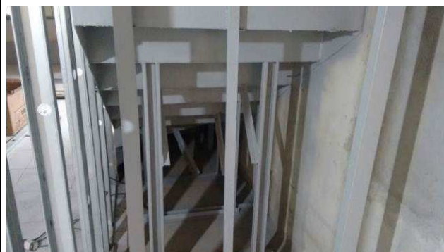
Figura 80C: Fundo zarcão e pintura em esmalte sintético acetinado, cor cinza platina, marca Ilva, executados na parte inferior da escada metálica.
