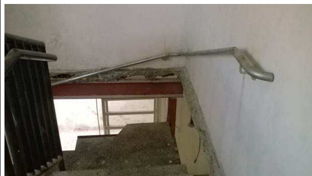
Figura 25C: Corrimão em aço galvanizado instalado junto em trecho remanescente da escada metálica.
