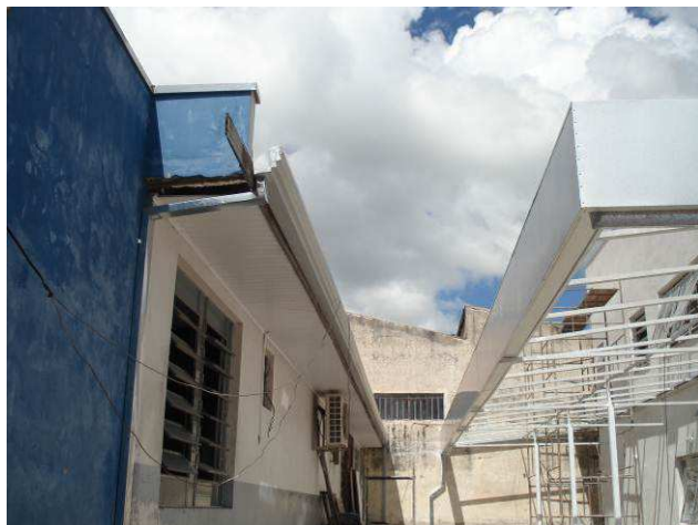
Figura 39C: Calhas e condutores instalados no imóvel vizinho (lateral esquerda).
