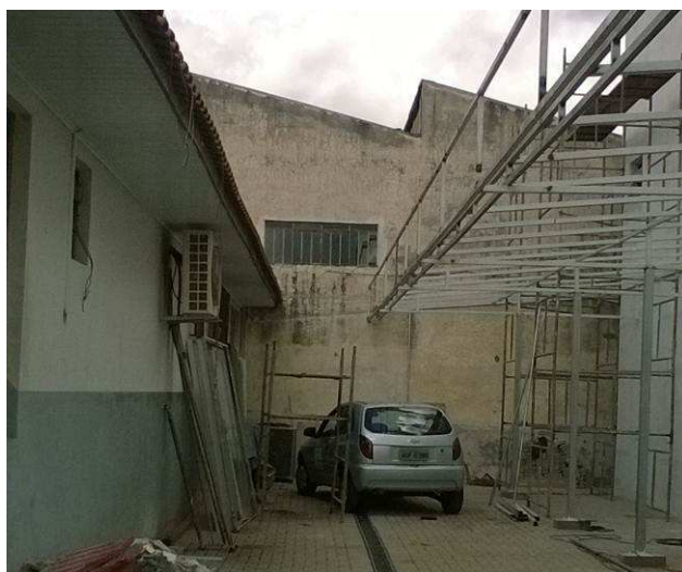
Figura 04C: Recortada estrutura da cobertura do estacionamento lateral esquerdo para adequações previstas.
