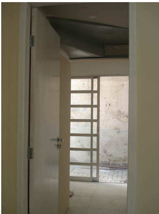
Figura 73C: Pintura em esmalte sintético (1ª demão), na cor branco acetinado, marca Ilva, executada na porta da copa.
