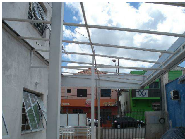
Figura 27C: Adequação na estrutura da cobertura do estacionamento coletivo executada para instalação de calhas.
