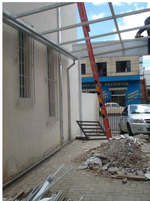
Figura 28C: Adequação na estrutura da cobertura da vaga privativa de juiz executada para instalação de calhas.
