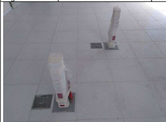
Figura 3E: totens das salas de audiências - tomadas e porta equipamentos
