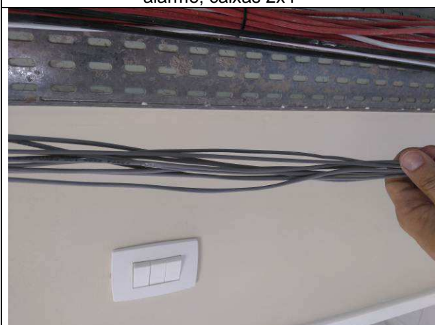
Figura 35E: cabeamento CCI50 2 e 3 pares para alarme
