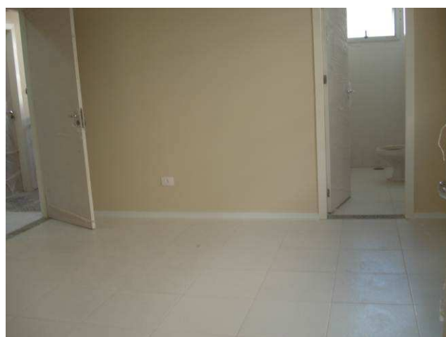
Figura 55C: Rodapé Santa Luzia, altura 5 cm, instalado em área do pavimento superior (gabinete de juiz I).
