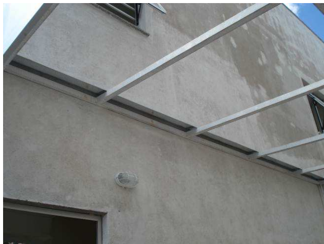
Figura 37C: Rufo instalado na junção da cobertura do estacionamento coletivo com a edificação.
