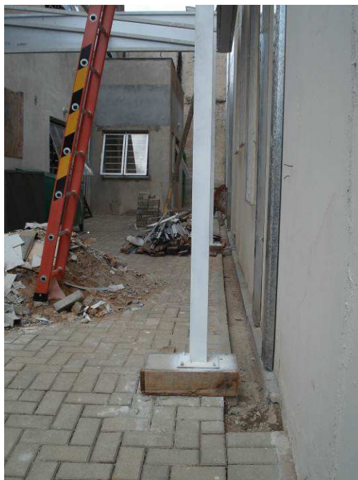
Figura 30C: Pilares metálicos instalados sob a cobertura da vaga privativa de juiz.
