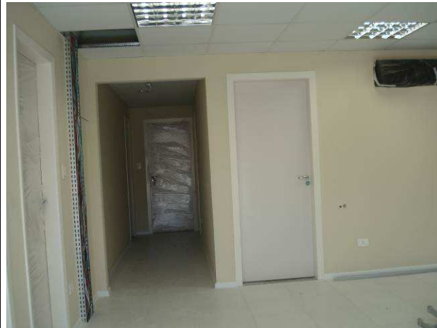
Figura 72C: Pintura executada em parede da sala de espera (pavimento superior) com tinta látex acrílica, cor palha, marca Acrillínea.
