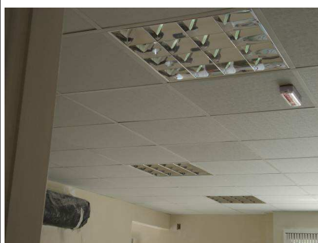
Figura 43C: Forro em placa de gesso acartonado removível (0,625x0,625 m) instalado Hall Público.
