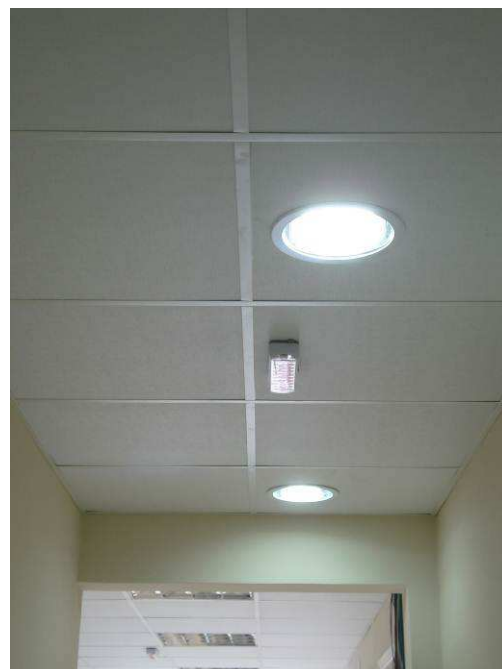
Figura 45C: Forro em placa de gesso acartonado removível (0,625x0,625 m) instalado no corredor do pavimento superior.
