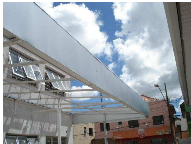
Figura 34C: Testeiras em chapa galvanizada instaladas na cobertura do estacionamento lateral esquerdo.
