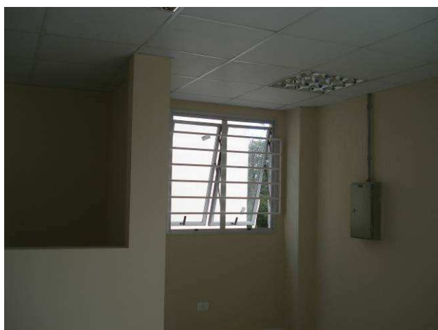
Figura 22C: Gradil em ferro tubular instalado junto à janela da sala de espera do pavimento superior.
