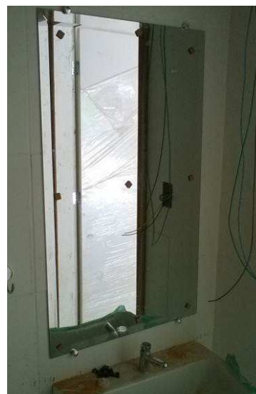
Figura 60C: Espelho cristal (e=5 mm), com bisotê de 1,5 cm, instalado no banheiro PNE.
