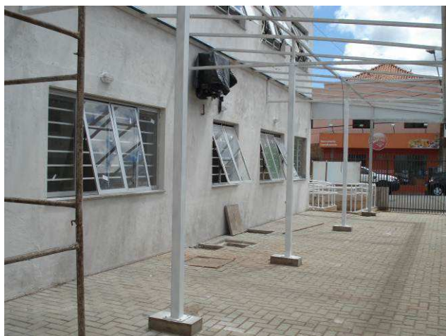
Figura 29C: Pilares metálicos instalados sob a cobertura do estacionamento coletivo.
