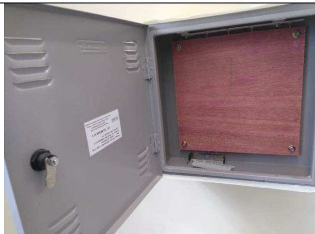
Figura 32E: caixa padrão Telebrás, para telefonia
