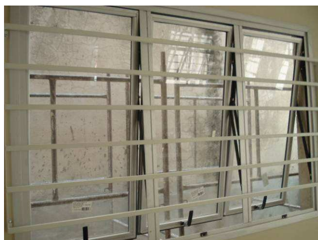
Figura 18C: Gradil em ferro tubular instalado junto à janela da Secretaria.
