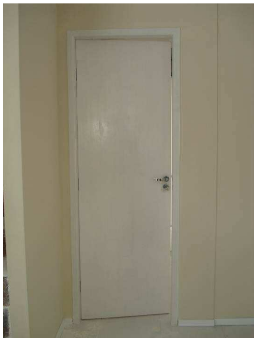
Figura 08C: Porta P03 instalada na copa.
