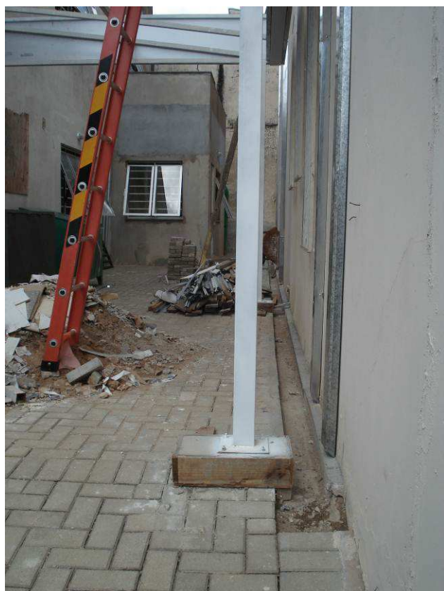
Figura 33C: Blocos de concreto em dimensão 20x40x30 executados sob a cobertura da vaga privativa de juiz.
