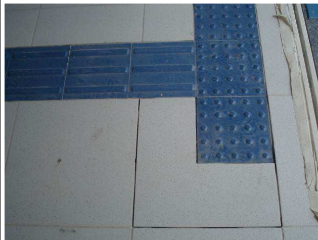
Figura 50C: Detalhe do piso podotátil junto à porta PJ1A.
