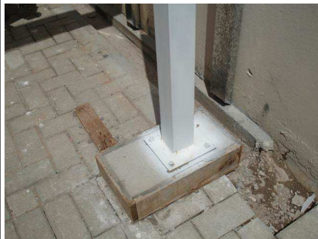
Figura 32C: Blocos de concreto em dimensão 20x40x30 executados sob a cobertura do estacionamento lateral esquerdo.
