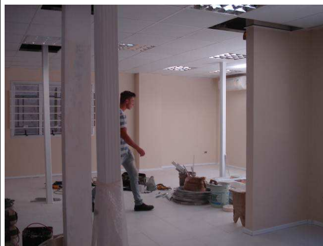
Figura 68C: Pintura em parede da Secretaria executada em tinta látex acrílica, cor palha, marca Acrillínea.
