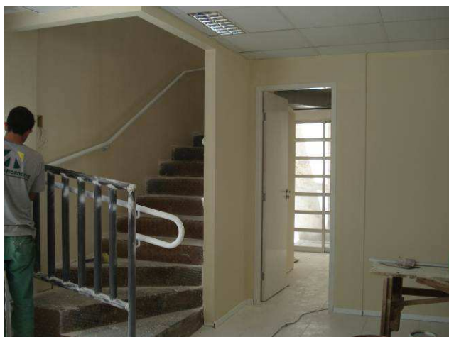
Figura 05C: Paredes em gesso acartonado ST – standard (cor cinza) – simples, instaladas no fechamento da copa.
