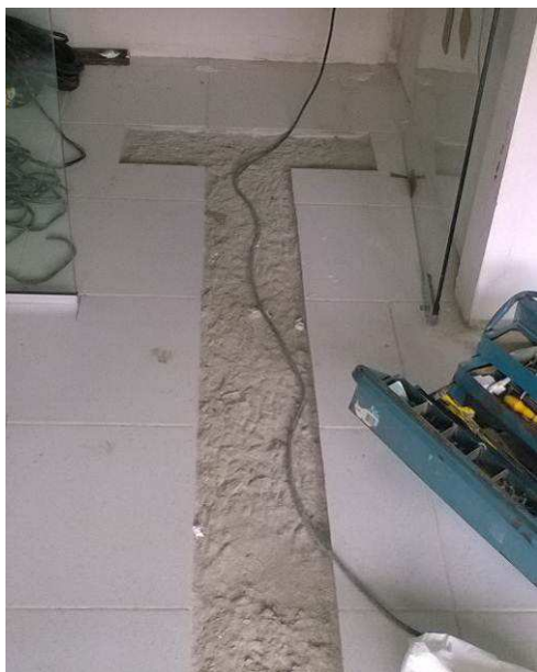
Figura 02C: Remoção de piso cerâmico para instalação de piso podotátil junto ao balcão de atendimento da Secretaria.
