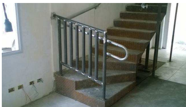
Figura 26C: Guarda corpo instalado em patamar da escada metálica.
