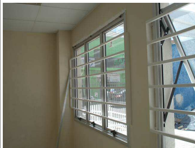
Figura 76C: Pintura em esmalte sintético, cor branco acetinado, marca Ilva, executada em grade de janela da Reserva PAB.
