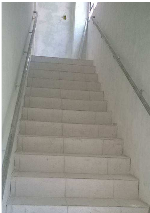
Figura 24C: Corrimão em aço galvanizado instalado nas laterais da escada em alvenaria.
