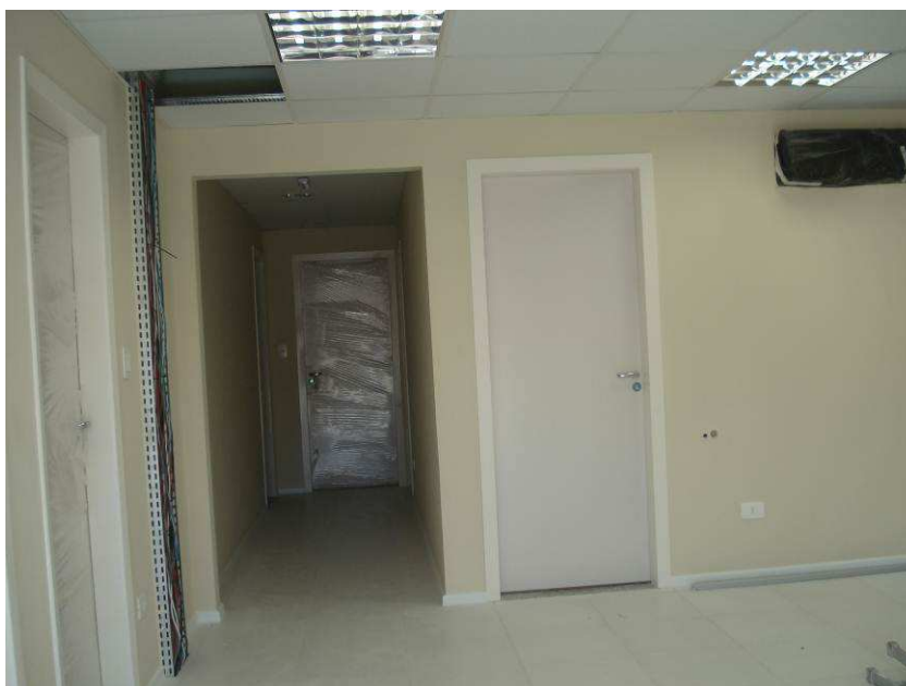
Figura 3 – Vista interna (pavimento superior).
