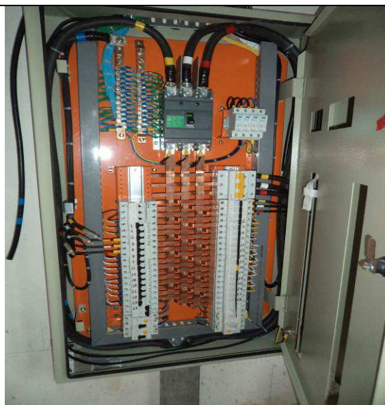
Figura 02E: Serviço de revisão das instalações existentes.
