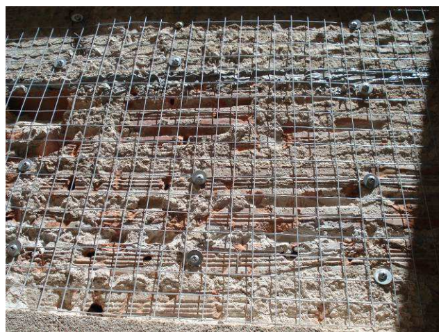
Figura 29C: Tela galvanizada aplicada em trecho da parede dos fundos.
