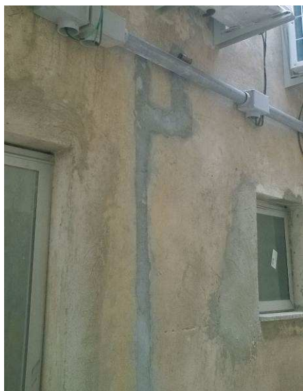
Figura 25C: Chapisco e emboço executados nos fundos do imóvel para fechamento da passagem de tubulação.
