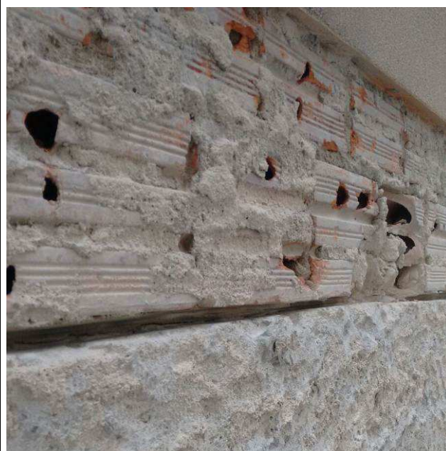
Figura 08C: Detalhe de recorte de junta onde seria aplicado selante elástico.
