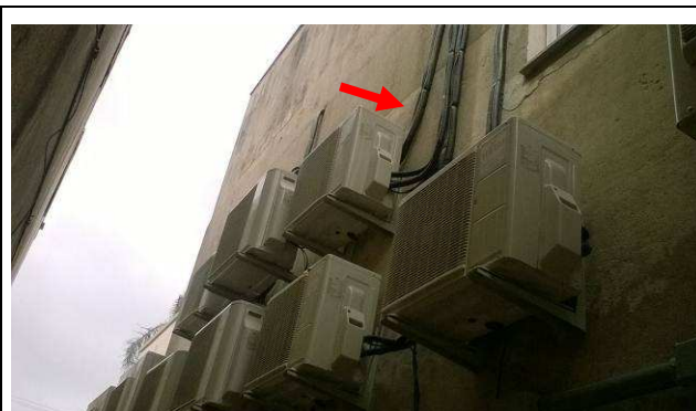
Figura 38C: Rede frigorígena em tubo de cobre, com respectivo isolamento térmico, trecho externo.
