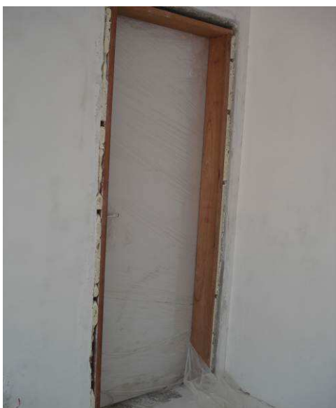
Figura 13C: Porta P03 instalada no banheiro do gabinete II. Pendente instalação de vistas.
