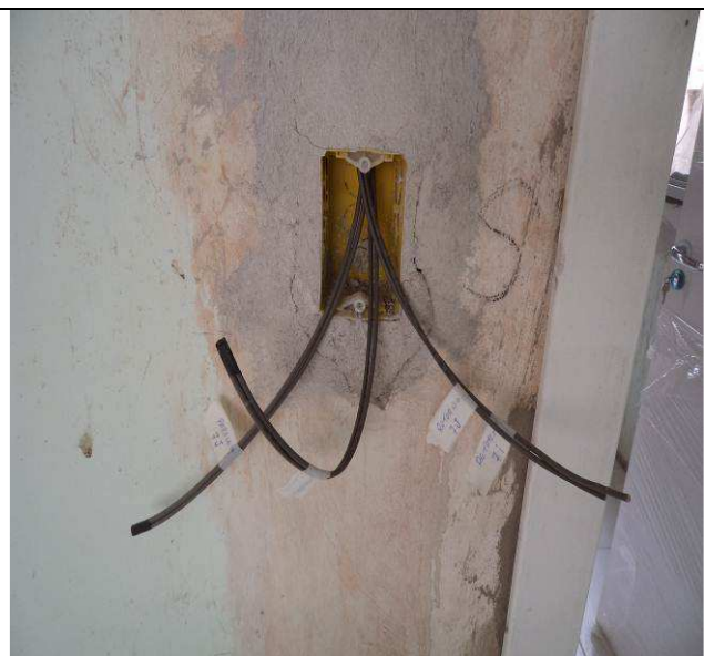
Figura 01E: Serviço de revisão das instalações existentes.
