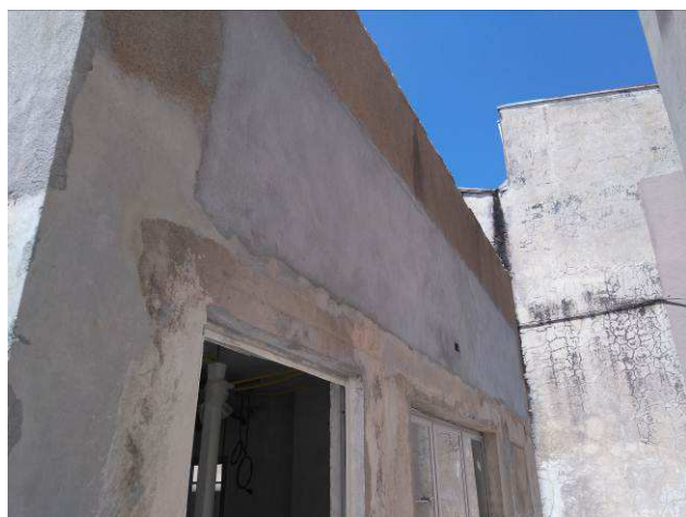
Figura 23C: Chapisco e emboço executados na lateral direita do imóvel (área abrangidas pela correção das trincas).
