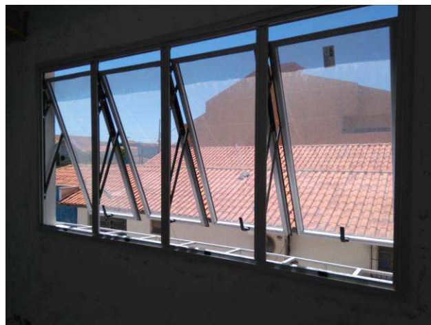
Figura 20C: Executados reparos nos contramarcos e folhas das janelas em alumínio.
