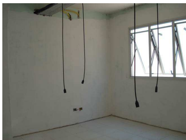
Figura 44C: Paredes emassadas e lixadas na sala de audiências I.
