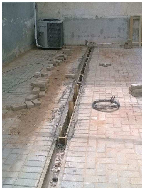
Figura 33C: Executado prolongamento de canaleta em concreto, localizada abaixo da cobertura do estacionamento lateral esquerdo.
