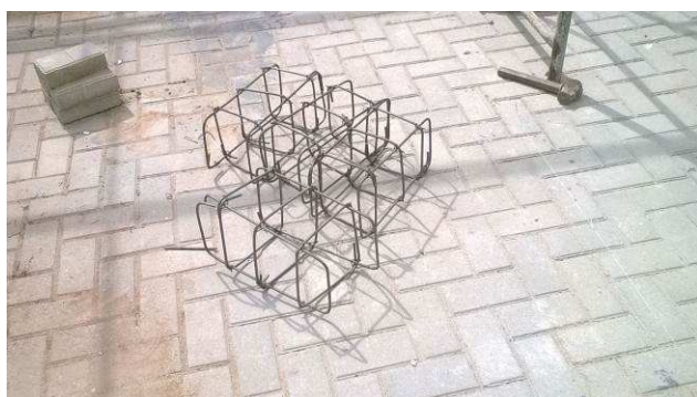
Figura 21C: Armação para blocos de concreto executados nas dimensões 20x40x30cm.
