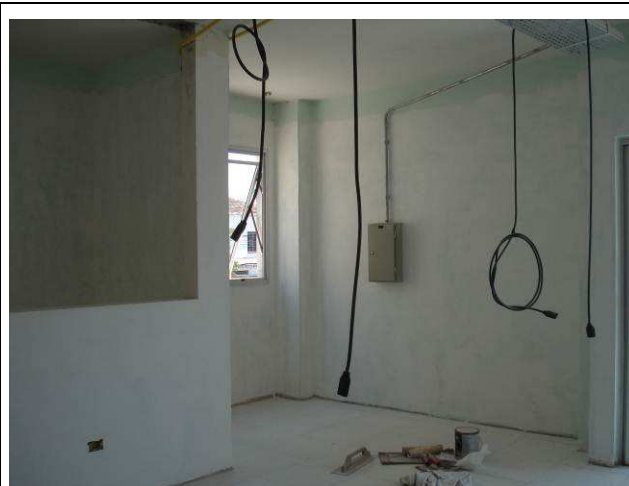
Figura 43C: Paredes emassadas e lixadas no pavimento superior (espera público).
