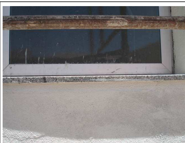
Figura 31C: Peitoril em granito polido cinza andorinha instalado no vão da janela do gabinete de juiz I.
