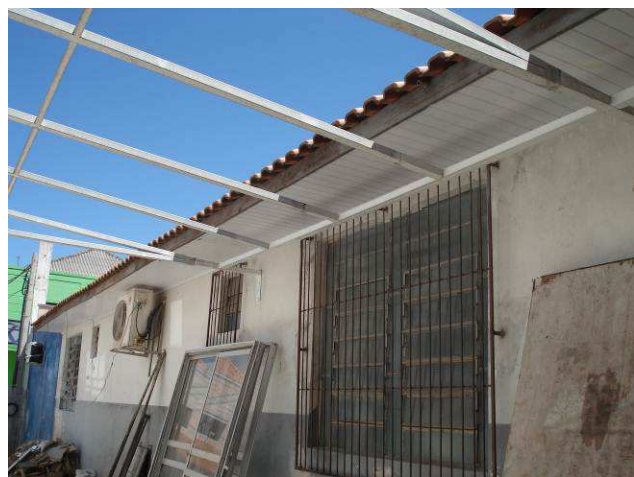
Figura 09C: Removidos calhas e condutores do imóvel vizinho, para posterior substituição.
