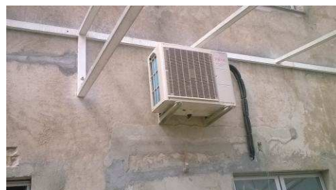
Figura 26C: Chapisco e emboço executados nas laterais do imóvel para fechamento de passagem de tubulação e de vãos indevidos.
