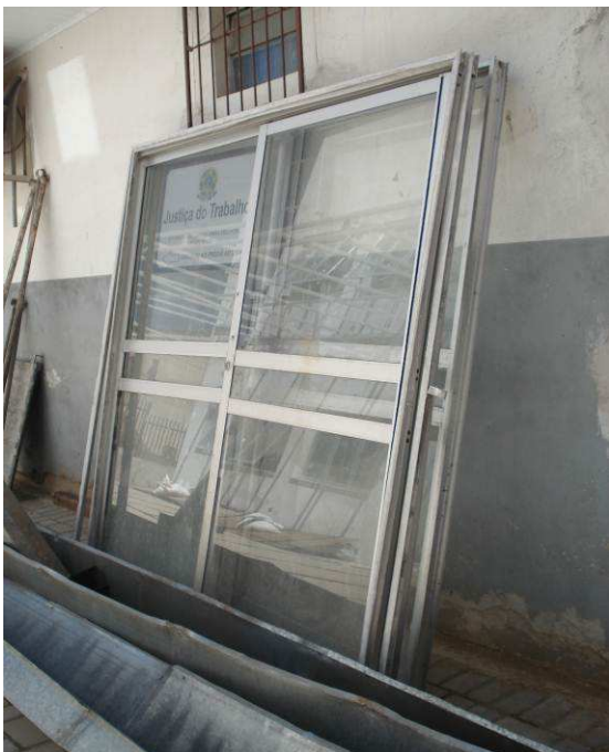
Figura 11C: Porta de acesso principal removida, para posterior substituição.
