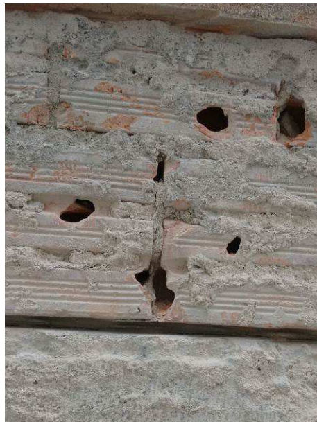
Figura 28C: Detalhe de junta recortada para subsequente aplicação do selante elástico identificado ao lado.
