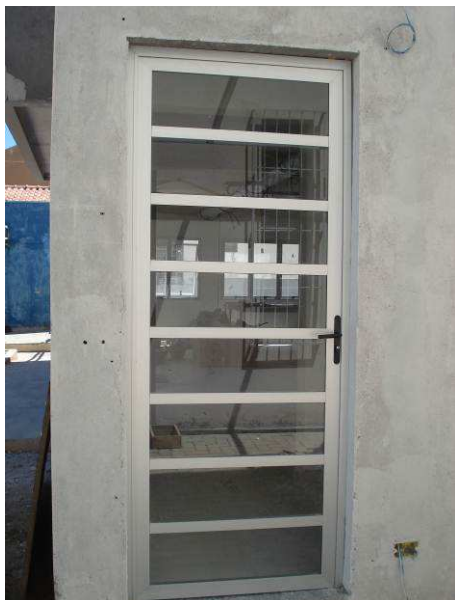
Figura 15C: Porta P04 de alumínio e vidro, instalada no acesso do estacionamento privativo do juiz à escada.
