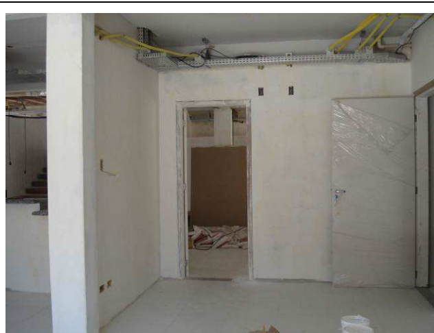
Figura 42C: Paredes emassadas e lixadas no pavimento térreo (hall público).
