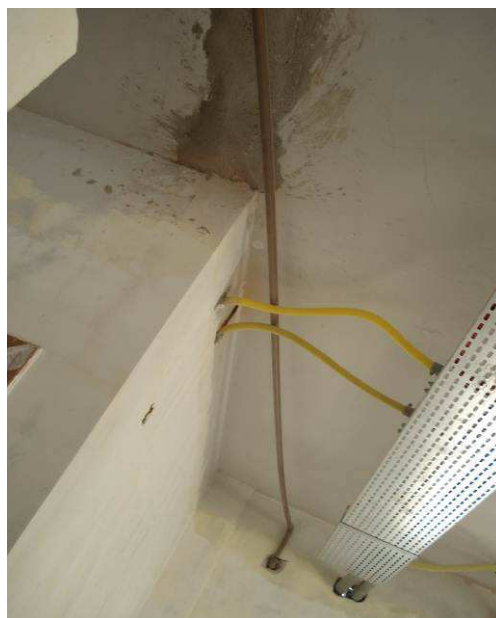
Figura 36C: Dreno de ar condicionado executado para evaporadora instalada na Secretaria.
