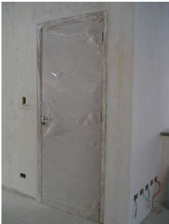
Figura 19C: Executados reparos nos batentes e folhas das portas previamente instaladas.
