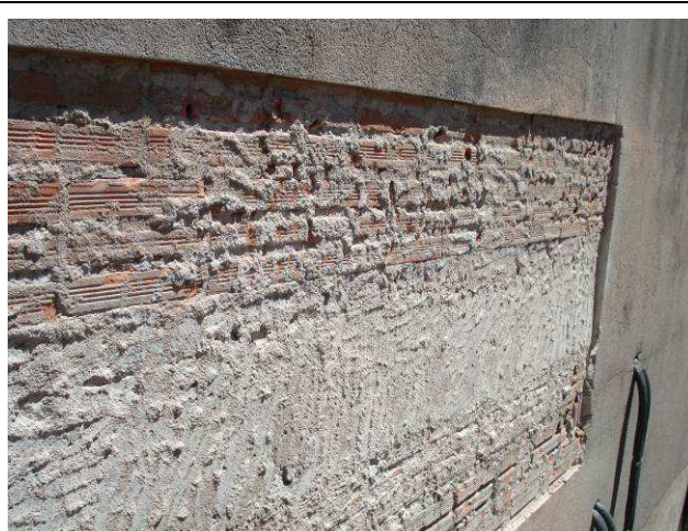
Figura 06C: Remoção de argamassa (faixa de 90 cm de largura) em área de correção de trincas, na parede lateral direita (lado externo).
