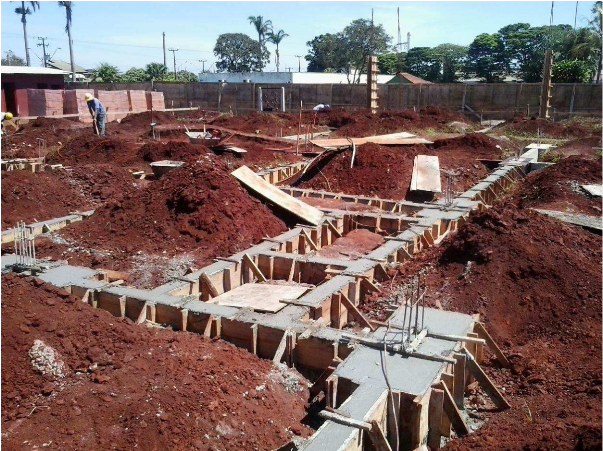
Figura 1 – Vista do canteiro de obras
