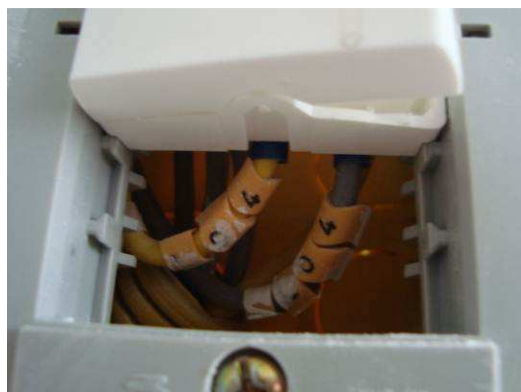
Figura 7 - Identificação de condutores, tomadas e interruptores
