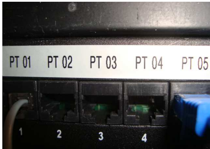
Figura 17 – Patch panel com identificação de pontos
