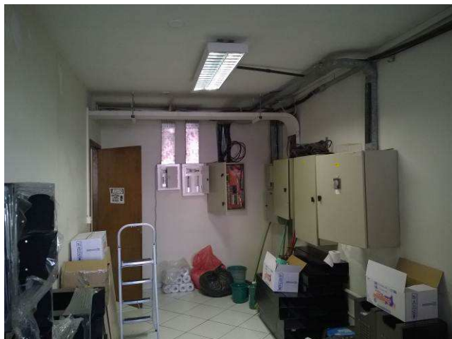
Figura 4 - Os quadros elétricos existentes devem ser removidos
