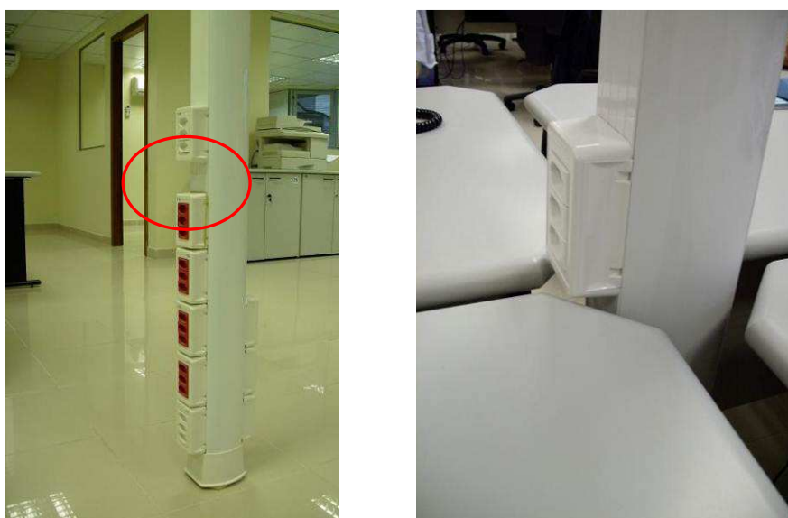
Figura 8 – Poste técnico (Observar interrupção dos porta-equipamentos para encaixe da mesa)
