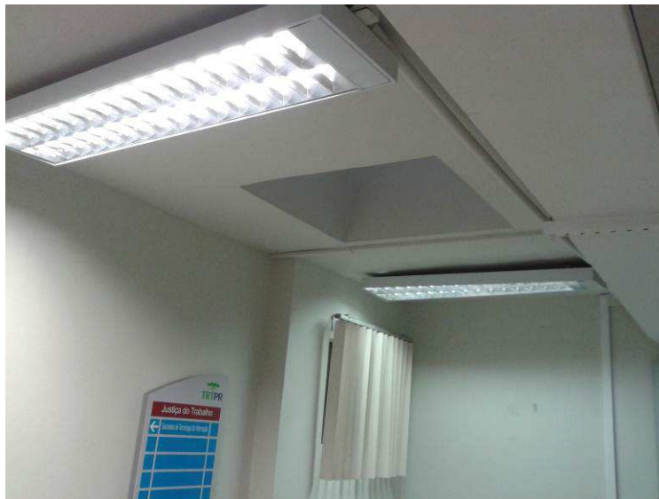
Figura 14 – Luminárias de sobrepor a serem reaproveitadas (substituição para lâmpadas LED tubulares de 18 W)
