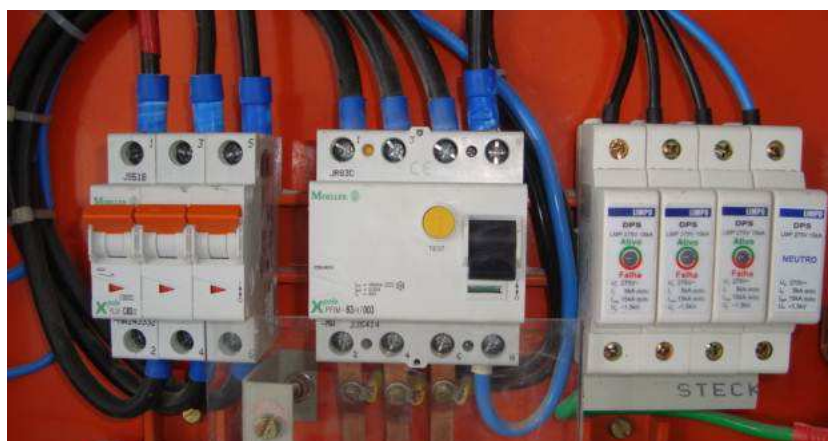
Figura 6 – Disjuntor, dispositivo DR e DPS em quadro
