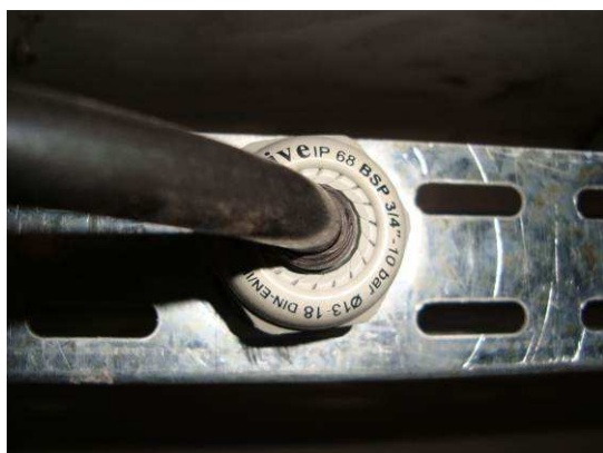
Figura 11 – Derivação para luminárias (prensa-cabo e plug)
