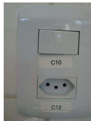
Figura 7 - Identificação de condutores, tomadas e interruptores
