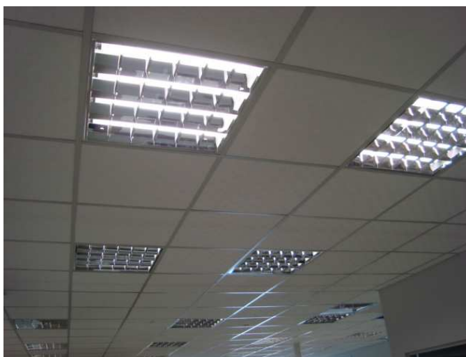
Figura 12 – Luminárias embutidas (lâmpadas LED 10W)
