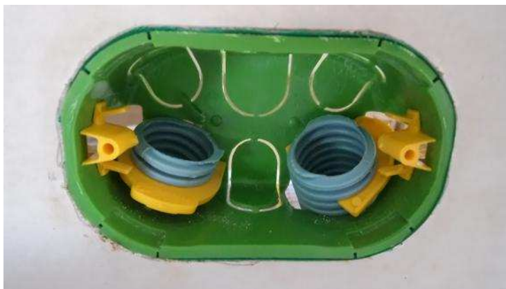
Figura 1 – Caixa de ligação em drywall
