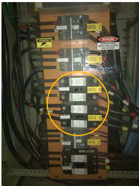
Figura 2 - Vista interna do quadro QDF-01 (Os disjuntores QEG4 e QEG5 serão reaproveitados)
