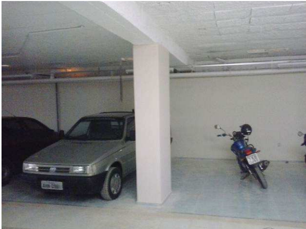
Figura 71C: Detalhe da pintura das paredes laterais do subsolo
