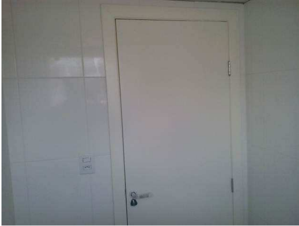
Figura 41C : Azulejo instalado em sanitário PNE do segundo pavimento
