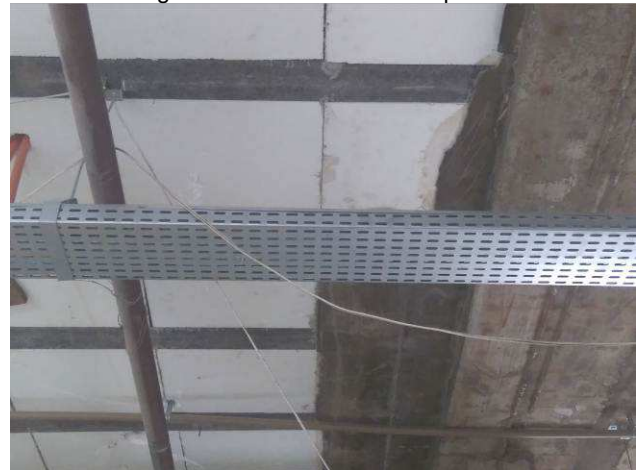
Figura 22E: eletrocalhas tampadas
