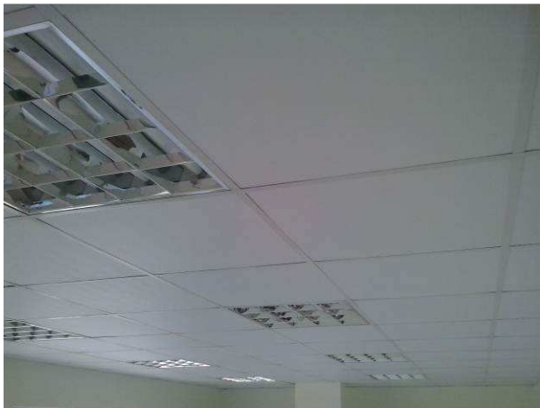
Figura 35C: Forro instalado na sala de audiência principal do primeiro pavimento
