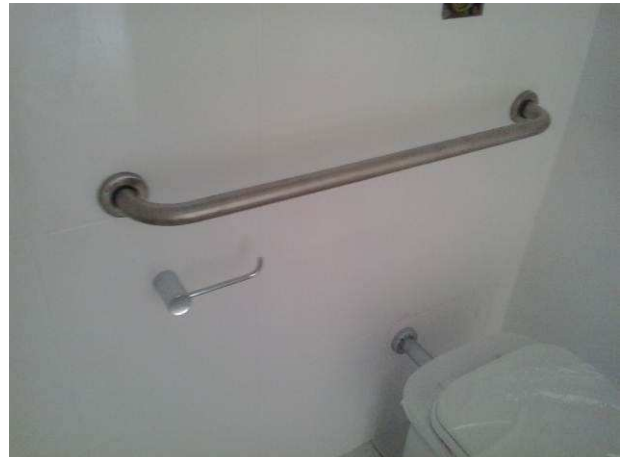
Figura 58C: detalhe da barra de apoio instalada junto a bacia sanitária
