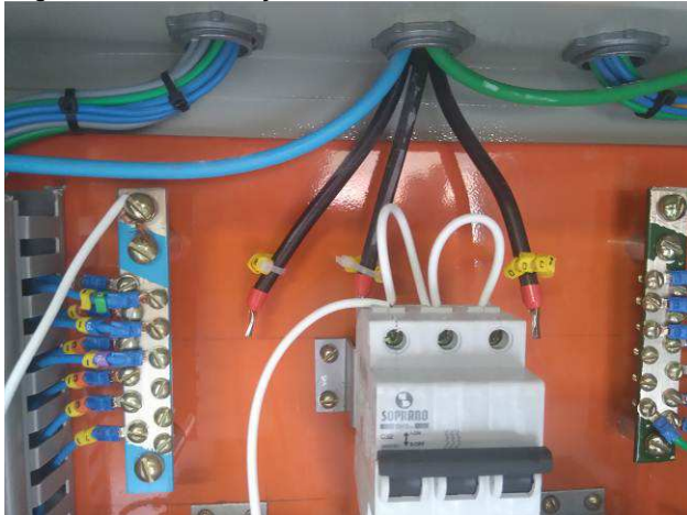
Figura 27E: Ramal alimentador QD IC
