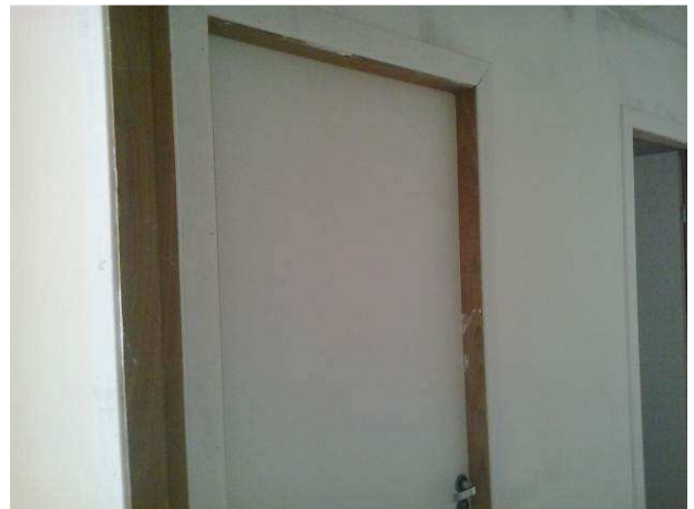
Figura 06C: Portas dos banheiros públicos
