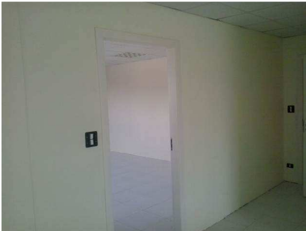
Figura 85C: Em detalhe, segunda demão de pintura das paredes do segundo pavimento e pintura completa de portas de madeira - corredor de acesso à sala dos assistentes
