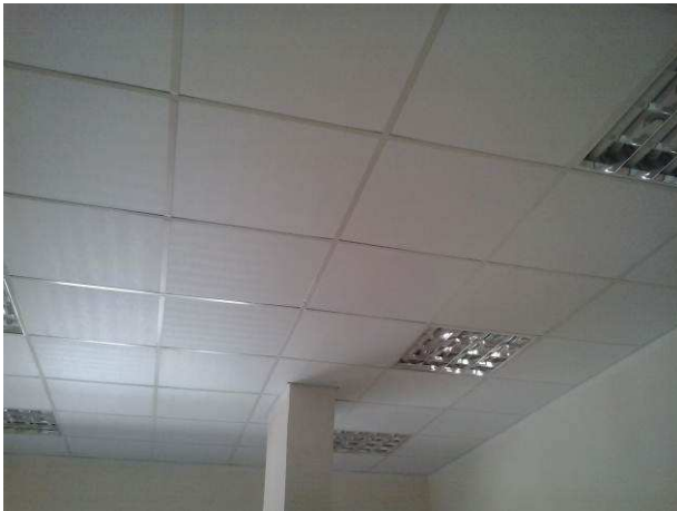
Figura 33C: Forro em gesso acartonado instalado na sala de múltiplo uso, no pavimento térreo
