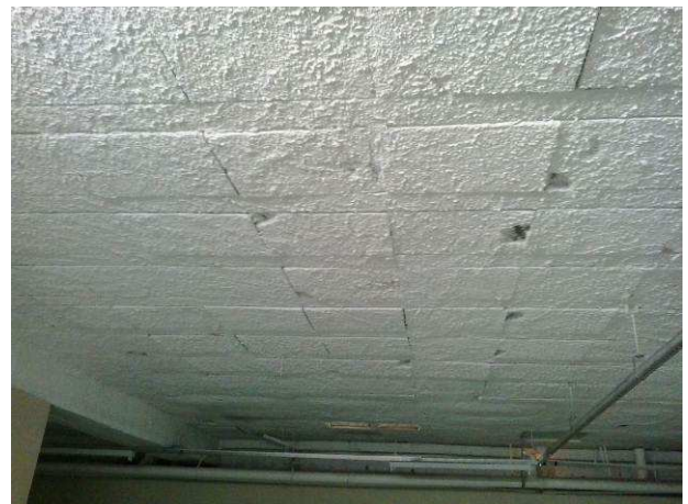
Figura 70C: Pintura do teto do subsolo
