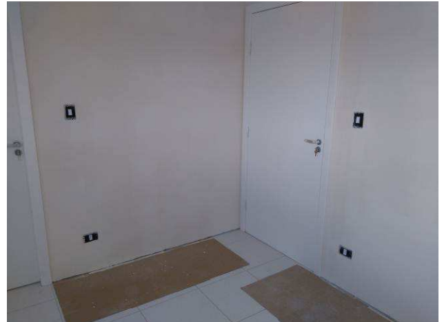
Figura 32E: interruptores e tomadas 2º pavimento
