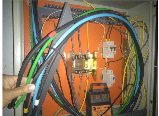
Figura 28E: Ramal alimentador QD Elev
