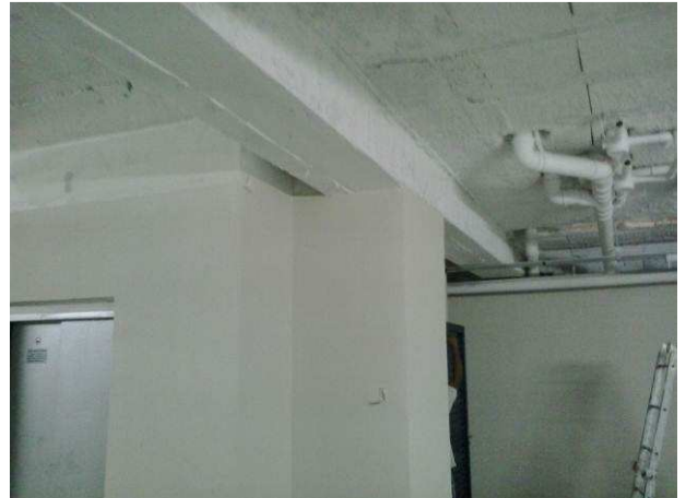
Figura 72C: Detalhe da pintura das paredes laterais do subsolo
