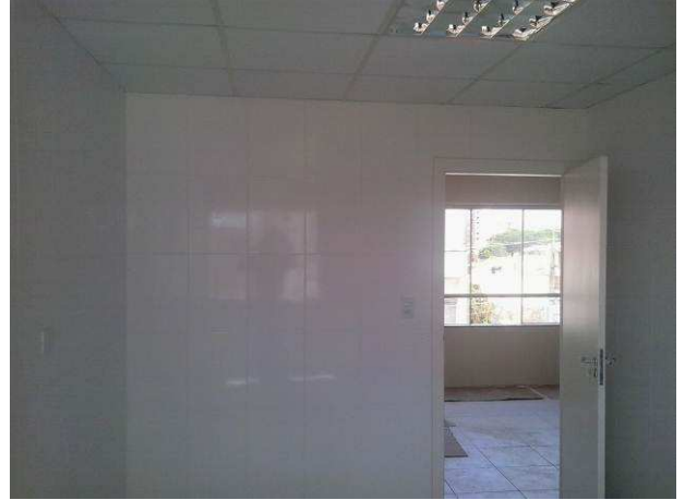
Figura 42C: Azulejo instalado na copa do segundo pavimento
