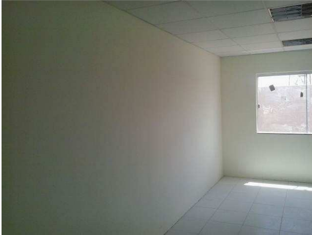
Figura 83C: Segunda demão de pintura das paredes do segundo pavimento - em detalhe, sala de audiência 2
