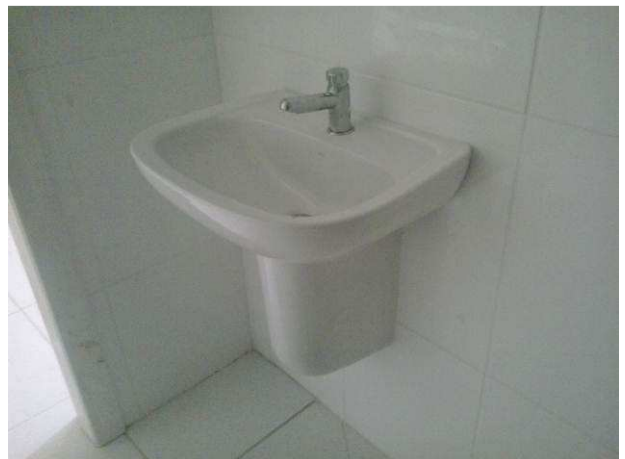
Figura 64C: Lavatório para PNE, linha Deca Vogue Plus, instalado no sanitário PNE do segundo pavimento
