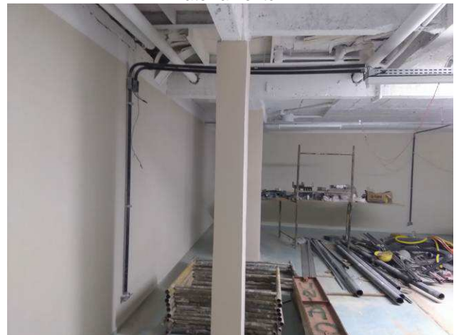
Figura 18E: infraestrutura subsolo
