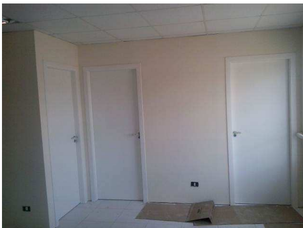
Figura 29C: Portas da Copa e dos banheiros da secretaria, no segundo pavimento
