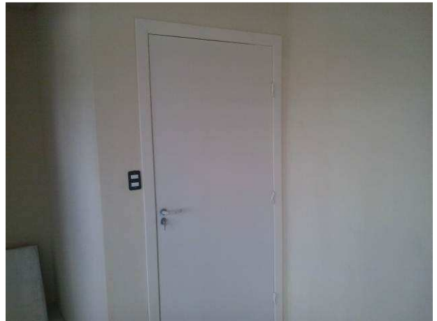
Figura 86C: Em detalhe, segunda demão de pintura nas paredes do segundo pavimento e pintura completa de portas de madeira - gabinete do juiz auxiliar
