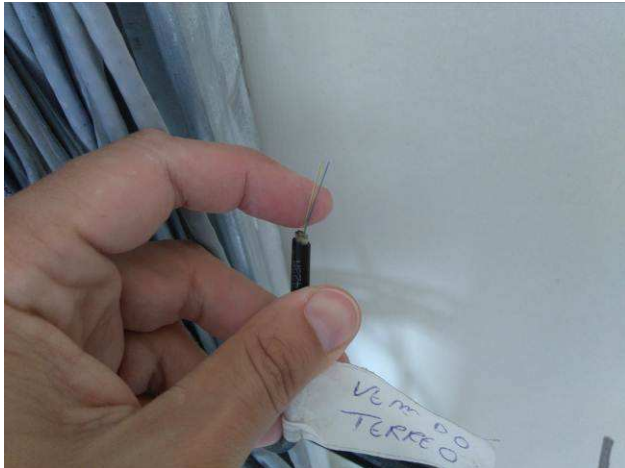
Figura 67E: fibra óptica MM 1º pavimento ao Térreo
