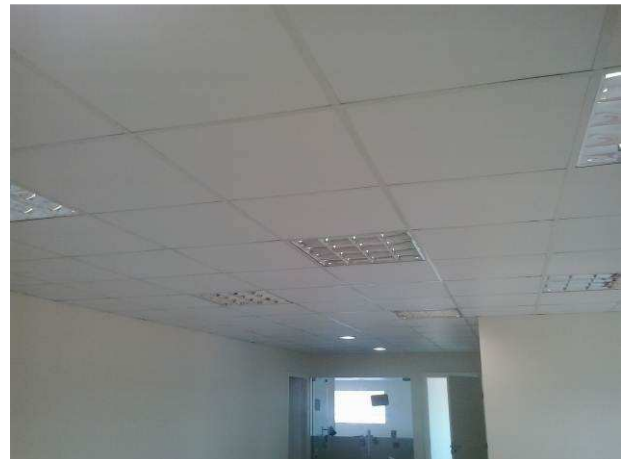
Figura 36C: Forro instalado no hall do primeiro pavimento
