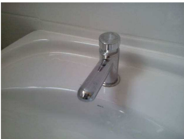
Figura 59C: Torneira de pressão cromada com fechamento automático, instalada em sanitário do primeiro pavimento
