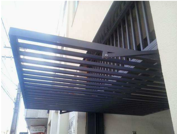
Figura 91C: Portão de ferro basculante instalado no acesso ao subsolo
