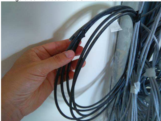
Figura 65E: fibra óptica MM 2º pavimento ao Térreo
