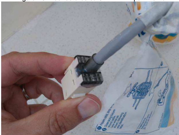
Figura 77E: conectores cat6 - acabamento
