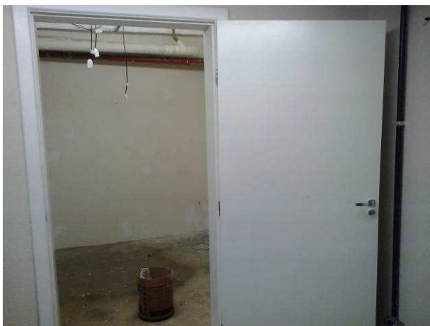
Figura 01C: Porta de madeira instalada no subsolo
