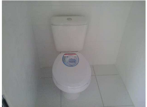
Figura 62C: Bacia de louça sanitária com caixa acoplada, instalada em boxe de sanitário público
