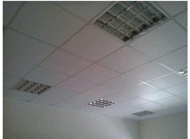
Figura 34C: Forro de gesso acartonado instalado na sala da OAB
