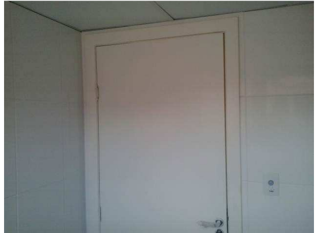
Figura 16C: Porta do banheiro da secretaria, no primeiro pavimento
