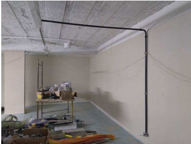
Figura 19E: infraestrutura subsolo
