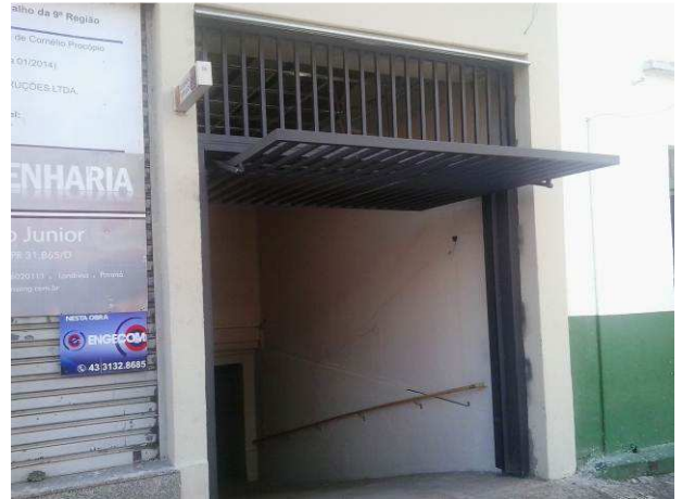
Figura 92C: Detalhe do portão de ferro basculante, instalado no acesso ao subsolo
