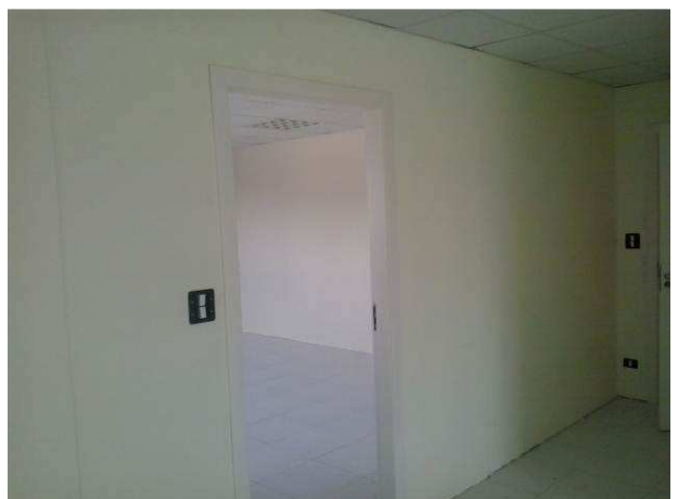
Figura 26C: porta do gabinete do juiz titular no segundo pavimento
