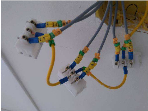
Figura 25E: identificação cabeamento elétrico - nº circuito
