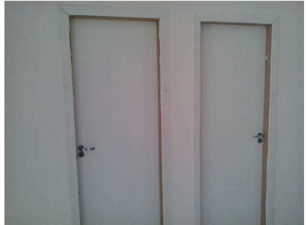
Figura 04C: Portas de madeira instaladas nos banheiros da distribuição
