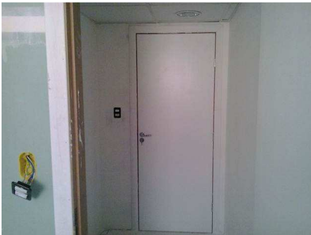
Figura 05C: Porta em banheiro de vestiário dos terceirizados
