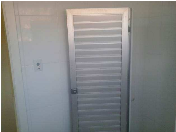
Figura 23C: Porta de alumínio de um dos boxes dos banheiros públicos do primeiro pavimento
