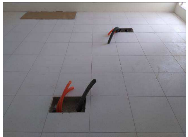
Figura 60E: infraestrutura salas de audiências
