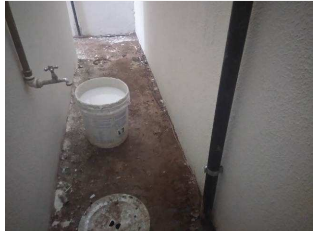
Figura 16E: entrada de energia em tensão primária - aterramento
