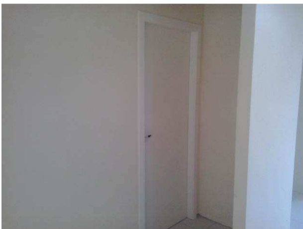
Figura 81C: Detalhe da pintura das portas de madeira do primeiro pavimento - sanitários públicos
