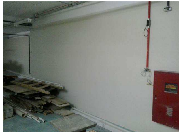
Figura 74C: Detalhe da pintura das paredes laterais do subsolo
