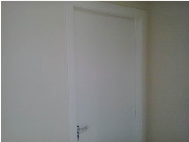
Figura 87C: Em detalhe, segunda demão de pintura nas paredes do segundo pavimento e pintura completa de portas de madeira - sala de conciliação
