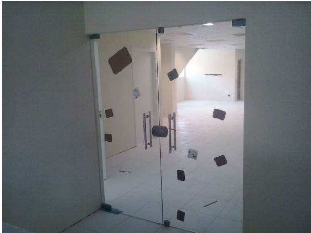
Figura 21C: Porta de vidro de acesso ao balcão da secretaria
