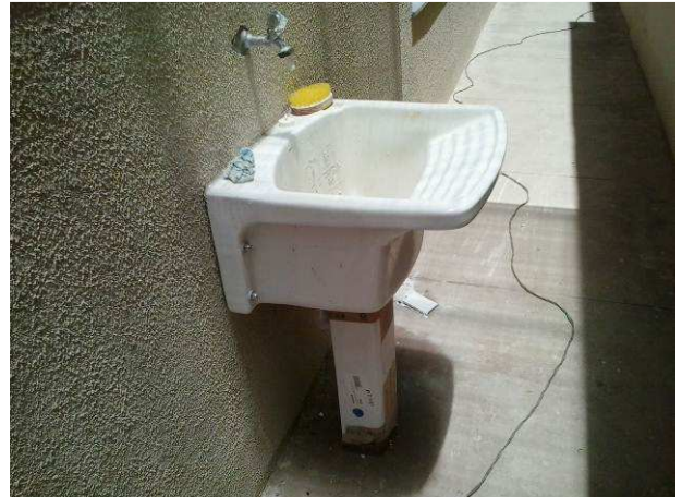
Figura 46C: Tanque de louça com coluna instalado no corredor dos fundos do imóvel
