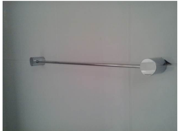
Figura 48C: Cabideiro metálico instalado na sala de perícia
