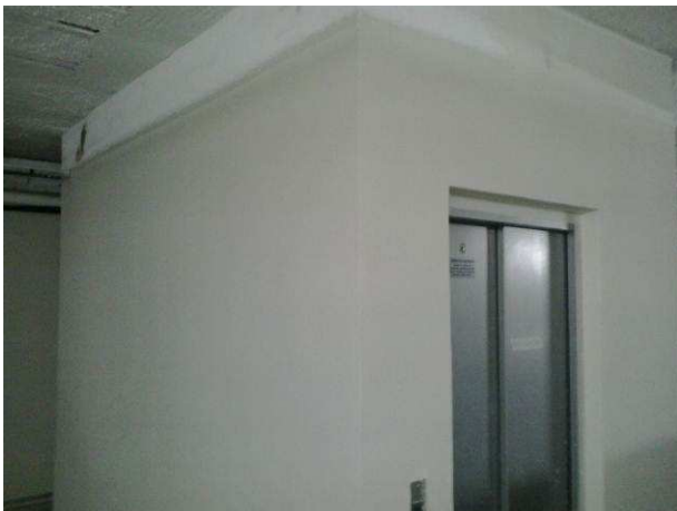
Figura 73C: Detalhe da pintura das paredes laterais do subsolo
