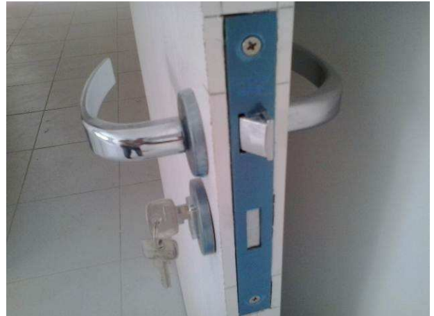
Figura 10C: detalhe a fechadura e suas linguetas
