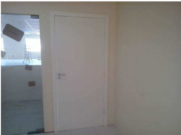
Figura 79C: Detalhe da pintura das portas de madeira do primeiro pavimento - acesso à sala de audiência principal
