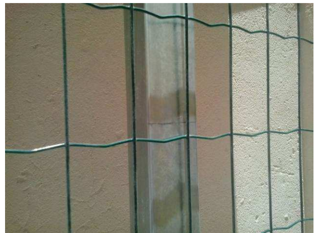
Figura 90C: Em detalhe, a malha de tela soldada com revestimento em PVC
