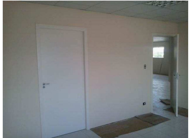
Figura 88C: Em detalhe, segunda demão de pintura nas paredes do segundo pavimento e pintura completa de portas de madeira - gabinete do juiz titular
