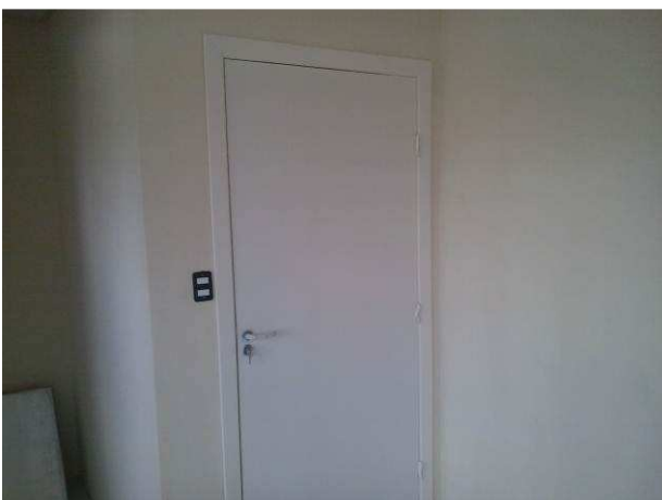
Figura 25C: Porta de acesso ao gabinete do juiz auxiliar, no segundo pavimento
