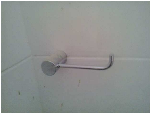
Figura 47C: Papeleira em metal cromado instalada no banheiro da sala de perícia
