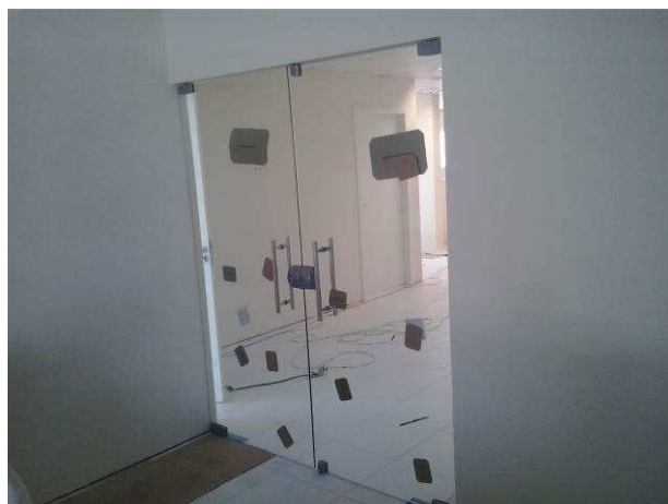
Figura 32C: Vista interna da porta de vidro que dá acesso ao balcão de atendimento
