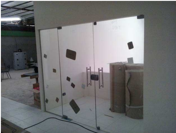
Figura 11C: Porta de vidro de acesso ao balcão da distribuição
