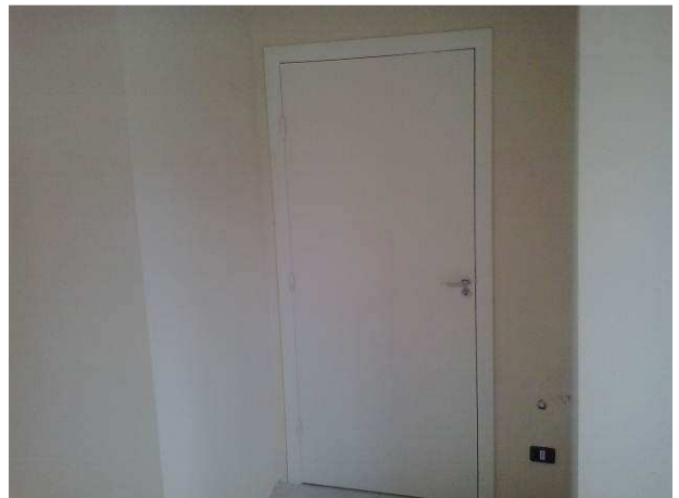
Figura 20C: Porta do banheiro PNE
