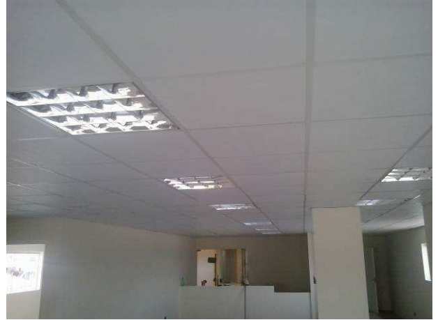
Figura 38C: Forro de gesso acartonado instalado no hall do segundo pavimento
