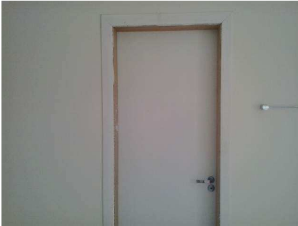
Figura 03C: Porta de madeira instalada no banheiro da sala de perícia
