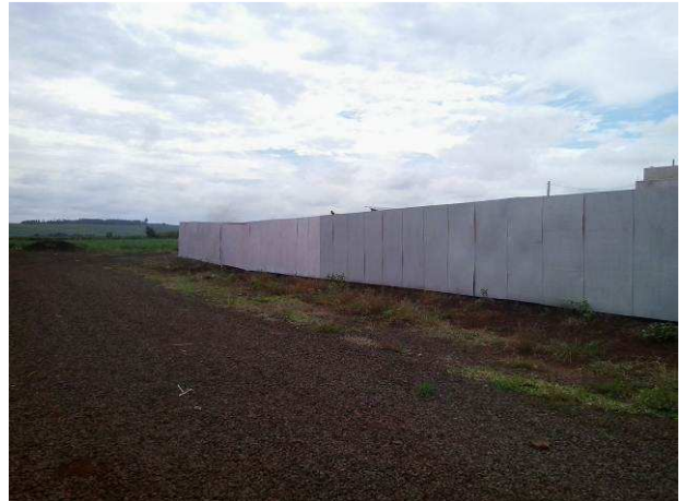
Figura 14C: Tapumes de fechamento da obra
