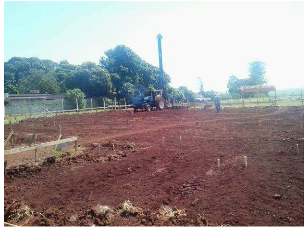
Figura 20C: Terreno limpo, após remoção da camada vegetal e entulhos, na área de construção do imóvel
