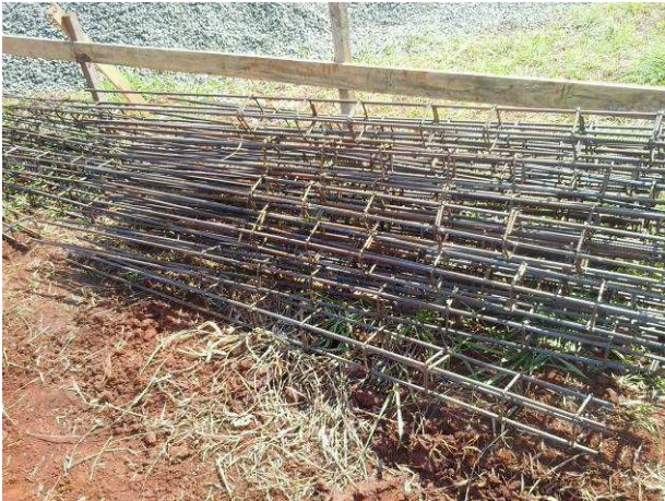
Figura 31C: Estoque de armaduras de estacas
