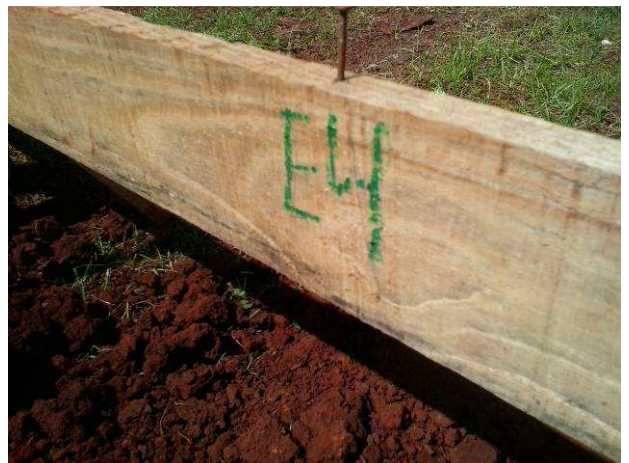
Figura 18C: Locação da obra
