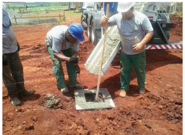
Figura 30C: Estaca sendo concretada
