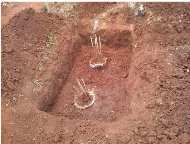
Figura 21C: Escavação de vala para execução de bloco de fundação
