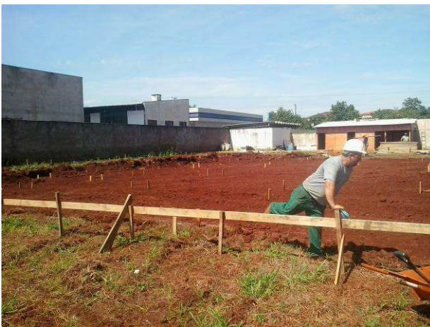
Figura 17C: Locação da obra
