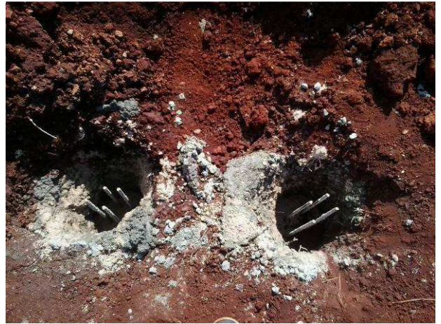
Figura 26C: Detalhe par de estacas de 25cm, concretadas
