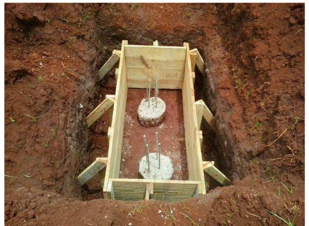
Figura 28C: Detalhe par de estacas de 25cm, já com caixaria de bloco sendo preparada
