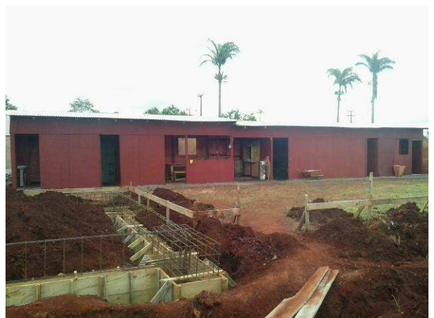
Figura 12C: Visão geral dos barracos de obra
