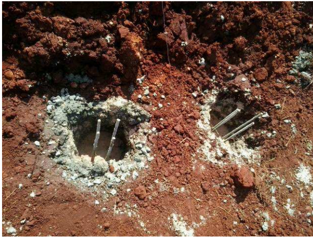
Figura 25C: Detalhe par de estacas de 25cm, concretadas
