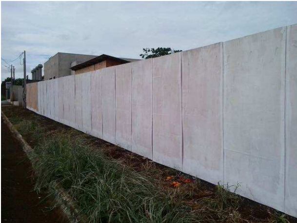
Figura 13C: Tapumes de fechamento da obra
