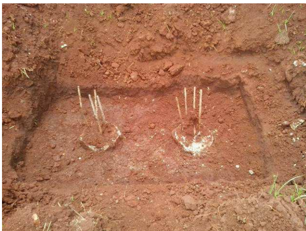
Figura 29C: Estacas executadas e com escavação no entorno para preparo do bloco de fundação
