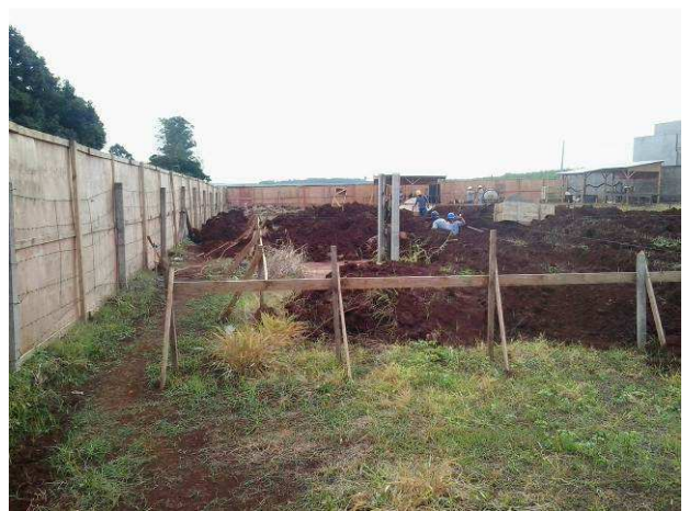
Figura 16C: Locação da obra
