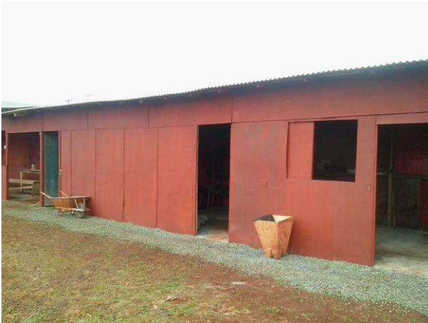
Figura 07C: Barracão de depósito
