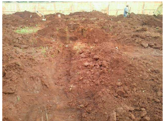
Figura 22C: Escavação de valas para execução de bloco de fundação e baldrame
