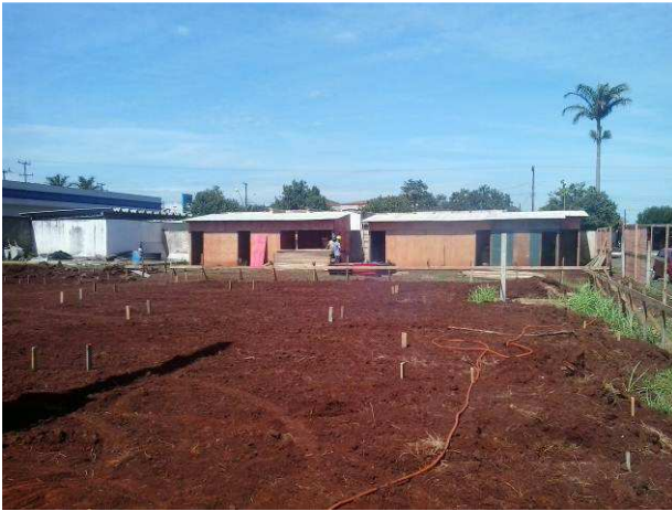
Figura 19C: Terreno limpo, após remoção da camada vegetal e entulhos, na área de construção do imóvel
