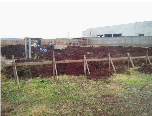
Figura 15C: Locação da obra
