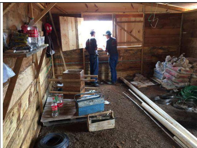
Figura 09C: Barracão de obra - depósito.
