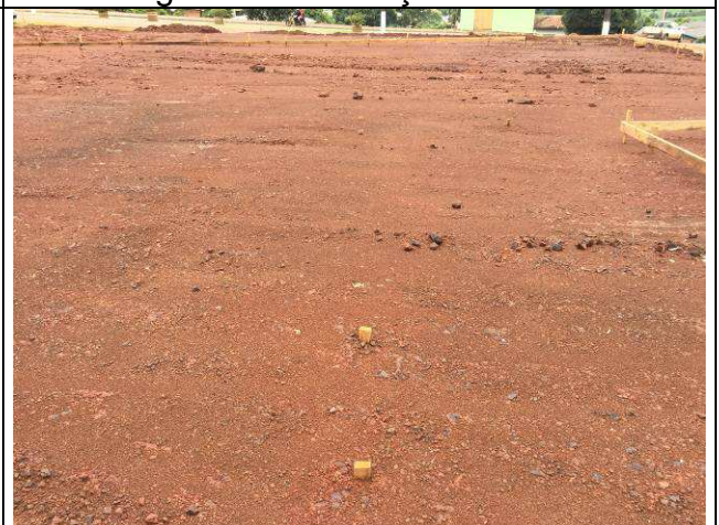
Figura 20C: Locação da obra - estacas.
