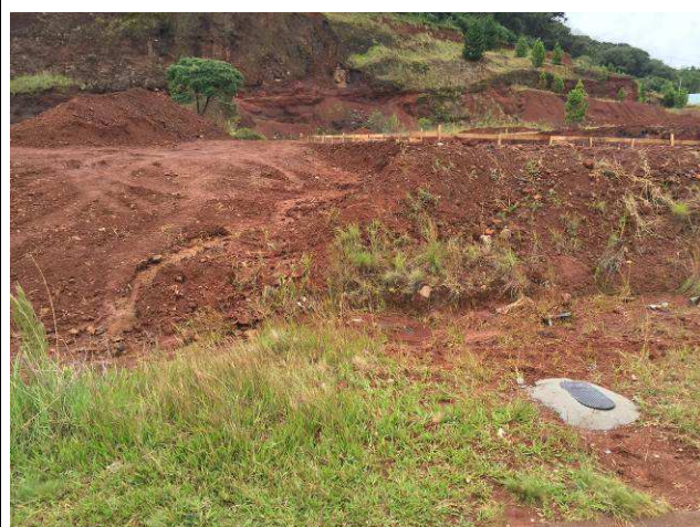
Figura 28C: Limpeza do terreno e movimentação de terra.
