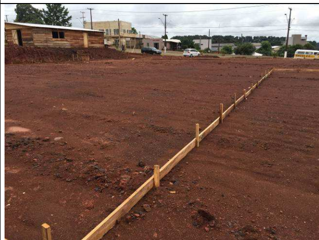
Figura 19C: Locação da obra.
