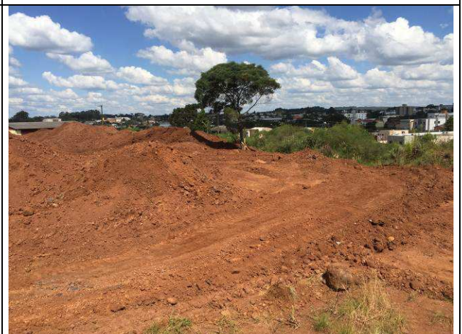
Figura 26C: Limpeza do terreno e movimentação de terra.
