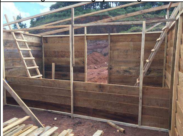
Figura 06C: Barracão de obra - construção.
