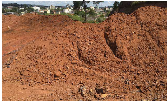
Figura 23C: Limpeza do terreno e movimentação de terra.
