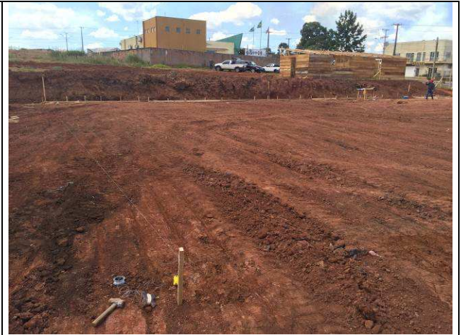
Figura 16C: Locação da obra - execução do gabarito.
