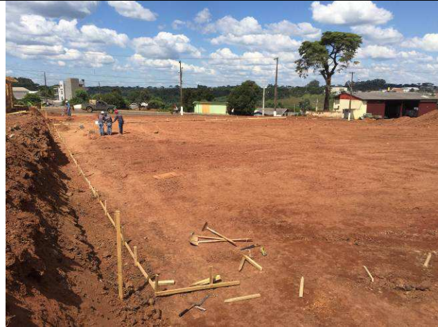
Figura 21C: Limpeza do terreno e movimentação de terra.
