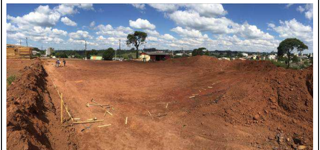
Figura 24C: Limpeza do terreno e movimentação de terra.
