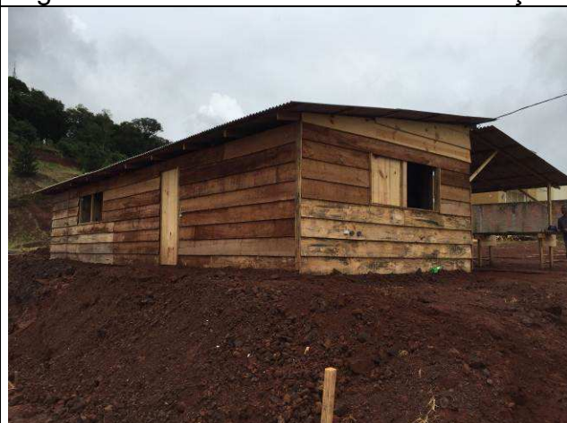
Figura 07C: Barracão de obra.
