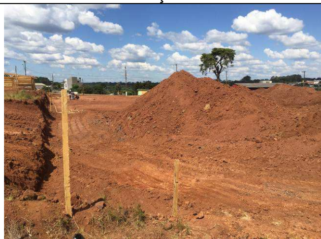
Figura 25C: Limpeza do terreno e movimentação de terra.
