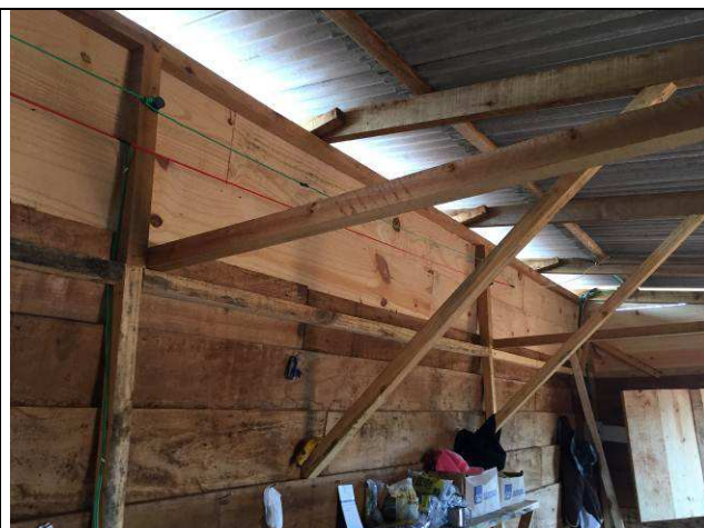
Figura 10C: Barracão de obra - depósito.
