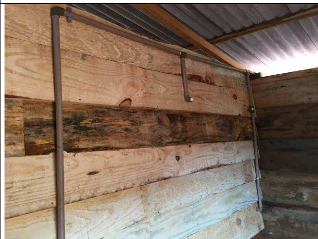
Figura 14C: Barracão de obra - banheiro.
