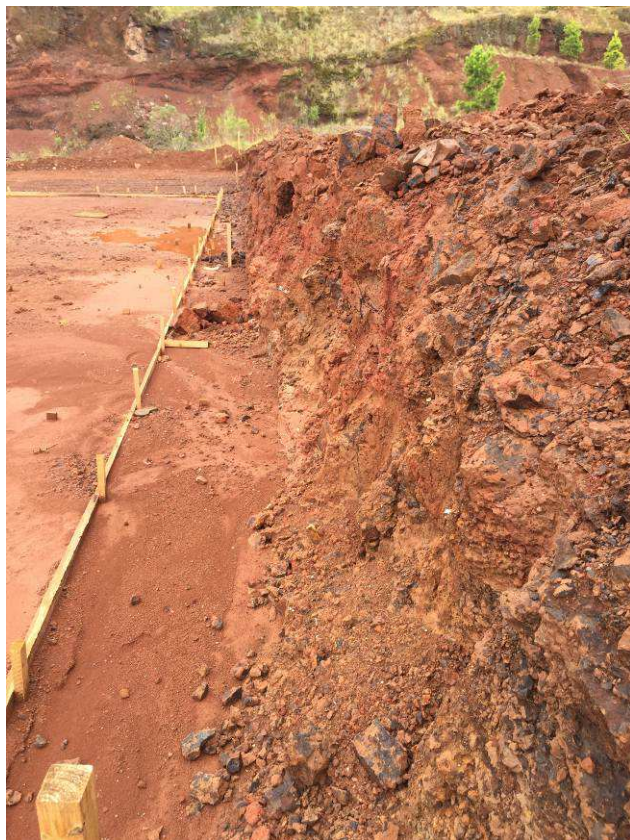
Figura 27C: Limpeza do terreno e movimentação de terra.
