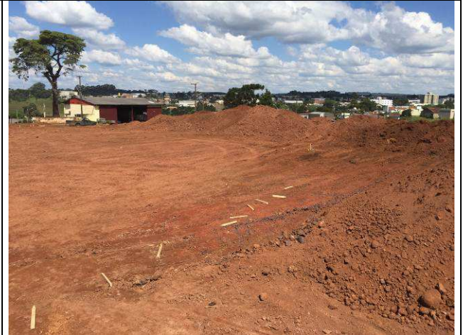
Figura 22C: Limpeza do terreno e movimentação de terra.
