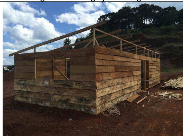
Figura 05C: Barracão de obra - construção.
