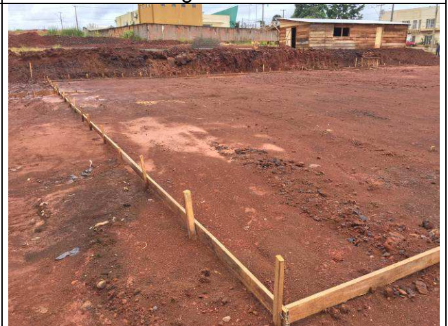
Figura 18C: Locação da obra.
