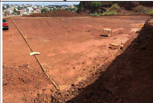
Figura 17C: Locação da obra - gabarito de madeira.
