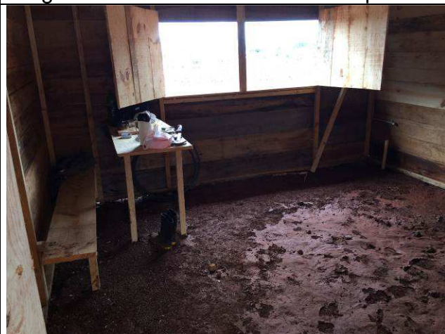
Figura 12C: Barracão de obra - refeitório.
