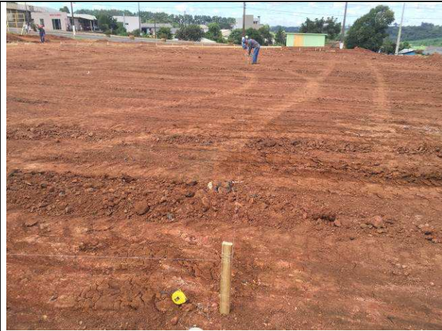
Figura 15C: Locação da obra - execução do gabarito.
