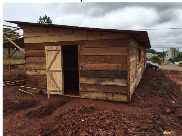
Figura 13C: Barracão de obra - banheiro.
