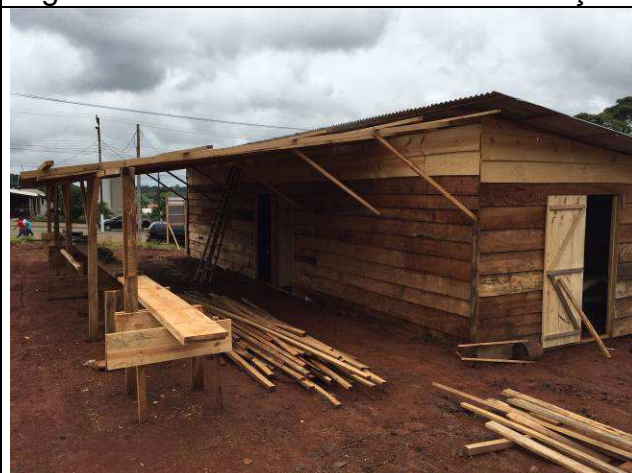
Figura 08C: Barracão de obra.
