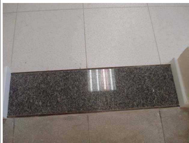
Figura 21: Soleira em granito polido cinza andorinha instalado na passagem aberta para acesso ao balcão de atendimento (Projeto Horizontes).
