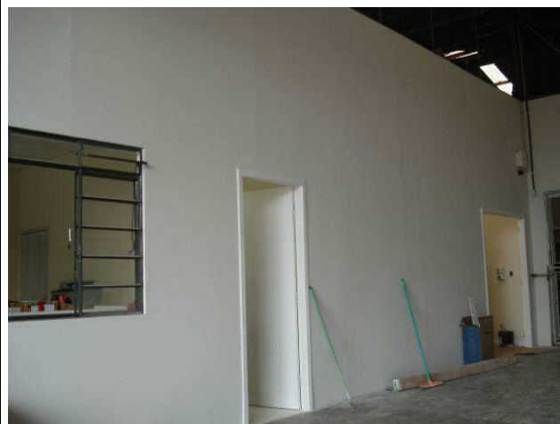
Figura 42C: Pintura executada na parede de divisa entre as salas da informática e a doca 05.
