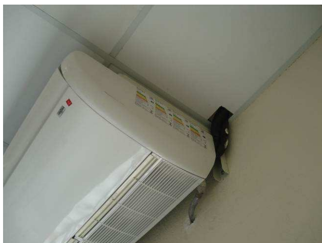
Figura 23C: Rede frigorígena executada para aparelho de ar condicionado de 36.000 BTUs instalado na Secretaria do Projeto Horizontes.
