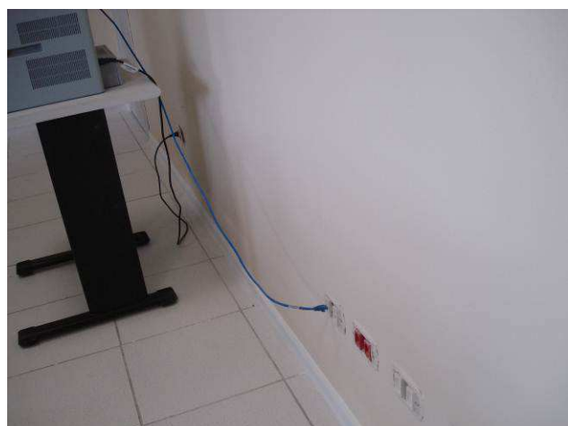
Figura 20C: Rodapé instalado em sala da informática (à esquerda da doca 05).
