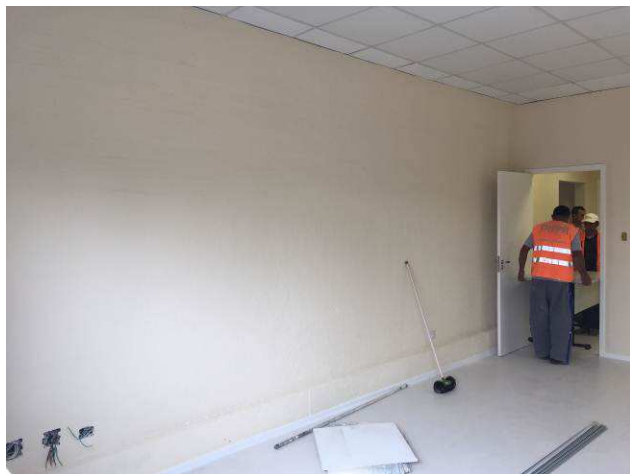
Figura 37C: Textura acrílica (e subsequente pintura) executada em parede de alvenaria da Secretaria do Projeto Horizontes.
