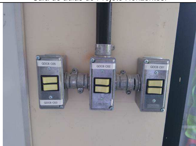
Figura 23E: alteração acionamento interruptores - Sala de aulas do Projeto Horizontes
