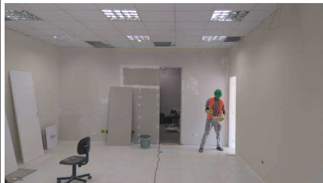
Figura 08C: Paredes em gesso acartonado simples executadas na área incorporada à Secretaria do Projeto Horizontes.
