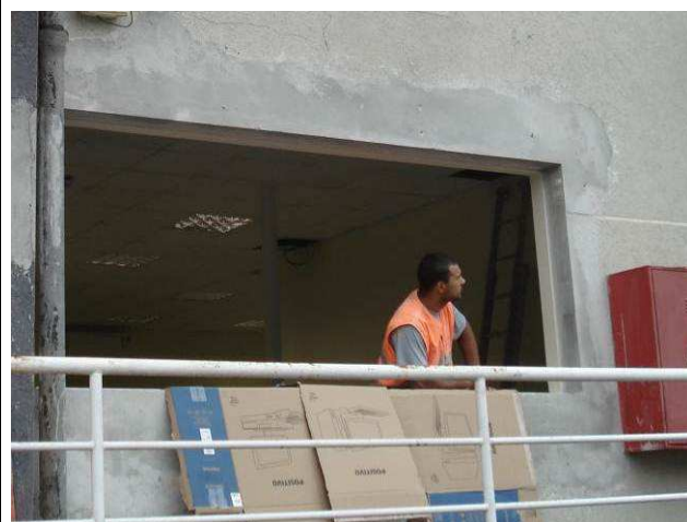
Figura 11C: Executado requadro de vão de janela da Secretaria do projeto Horizontes, após demolição parcial do mesmo (aumento do vão).
