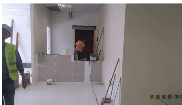
Figura 09C: Paredes em gesso acartonado simples executadas na área incorporada à Secretaria do Projeto Horizontes.
