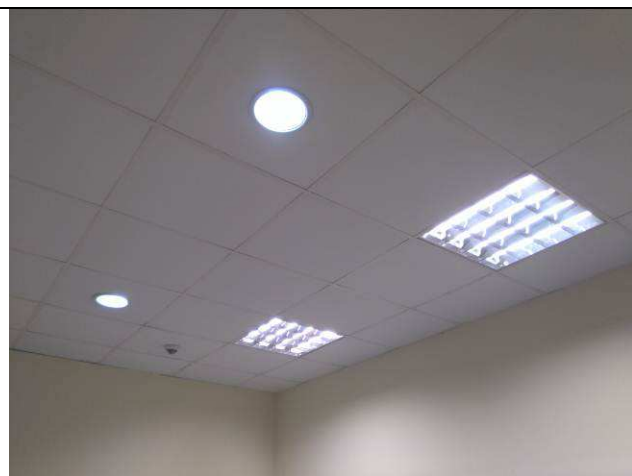
Figura 03E: luminárias remanejadas Proj. Horizontes.
