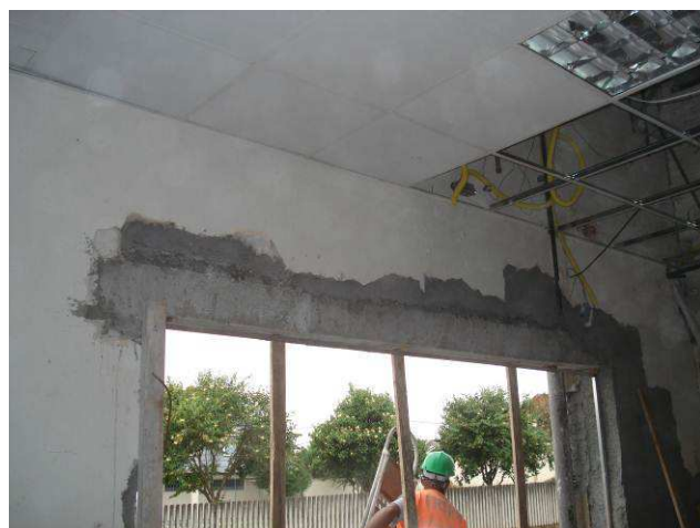
Figura 12C: Verga executada acima da janela da secretaria do Projeto Horizontes.
