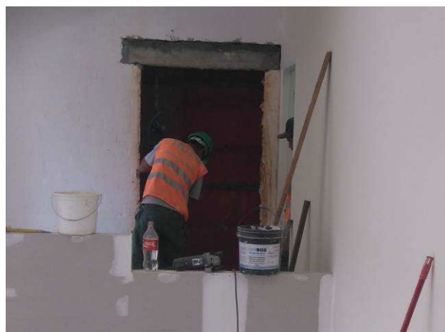
Figura 13C: Verga executada acima da passagem aberta para acesso ao balcão da secretaria do Projeto Horizontes.
