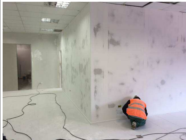
Figura 36C: Paredes emassadas na Secretaria do Projeto Horizontes.
