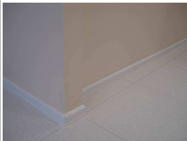
Figura 17: Rodapé Santa Luzia (h=5cm) instalado na secretaria do Projeto Horizontes.
