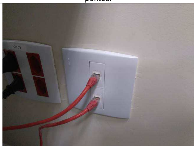
Figura 44E: Tomadas RJ45 cat6.
