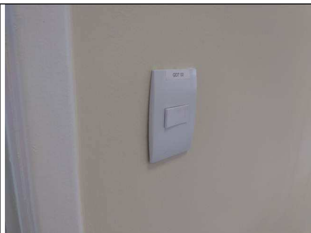
Figura 15E: Interruptores padrão modular.
