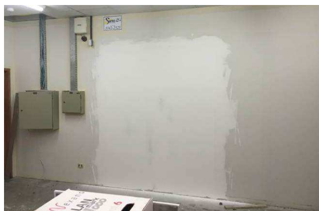
Figura 07C: Fechamento de vão de porta existente na sala da informática, na divisa com Projeto Horizontes, executado em gesso acartonado simples.
