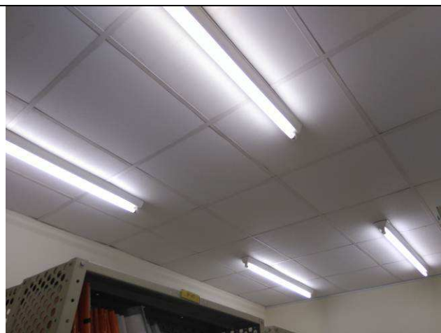
Figura 04E: Luminárias remanejadas Arquivo Horizontes.
