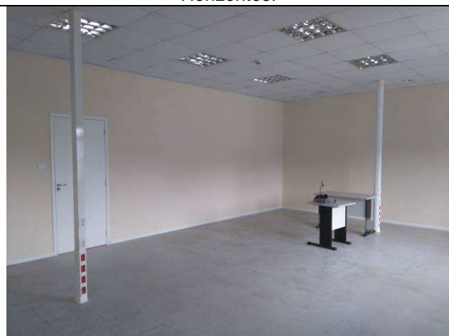
Figura 05E: Colunas técnicas reaproveitadas - Sala de audiências.
