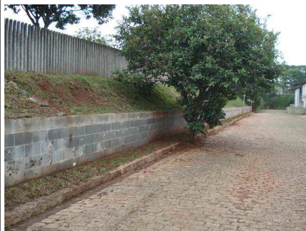
Figura 55C: Limpeza com alta pressão concluída no pátio externo anexo muro de arrimo.
