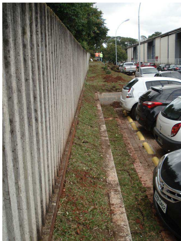
Figura 49C: Grama plantada no talude e base do muro de arrimo executado (trecho "B").
