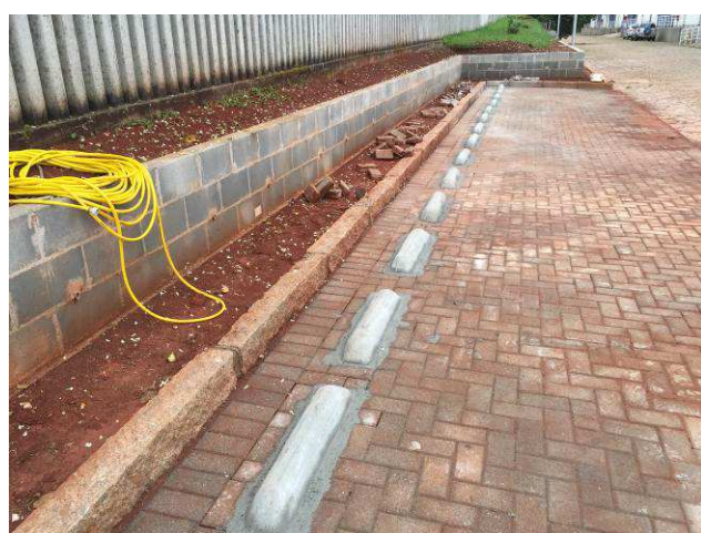
Figura 50C: Bate-rodas instalados no estacionamento do barracão. Total de 16 unidades.
