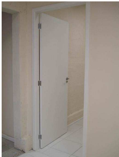
Figura 29C: Porta PM 80 instalada no arquivo do Projeto Horizontes.
