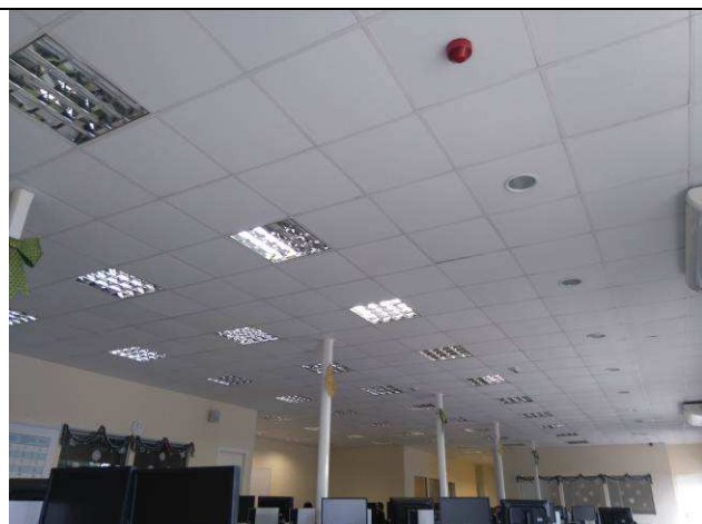
Figura 22E: alteração acionamento interruptores - Sala de aulas do Projeto Horizontes.
