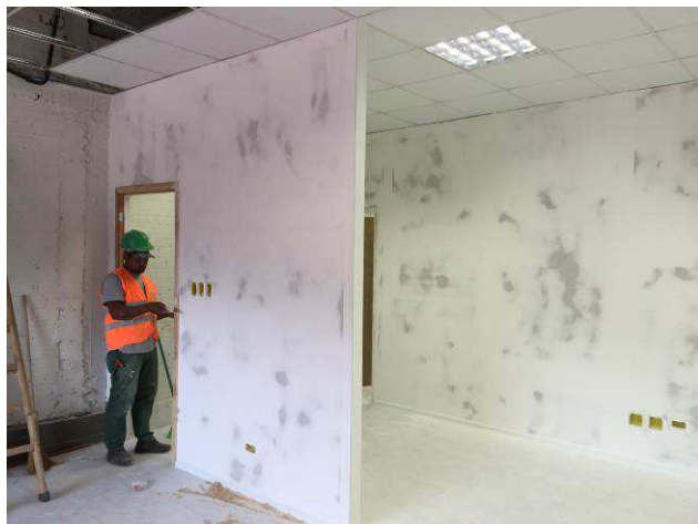
Figura 35C: Paredes emassadas na Secretaria do Projeto Horizontes.
