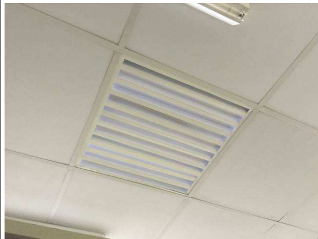
Figura 26C: Instaladas 8 grelhas de ventilação em aço galvanizado com pintura em esmalte acetinado Suvnil na cor branca, na área identificada ao lado.
