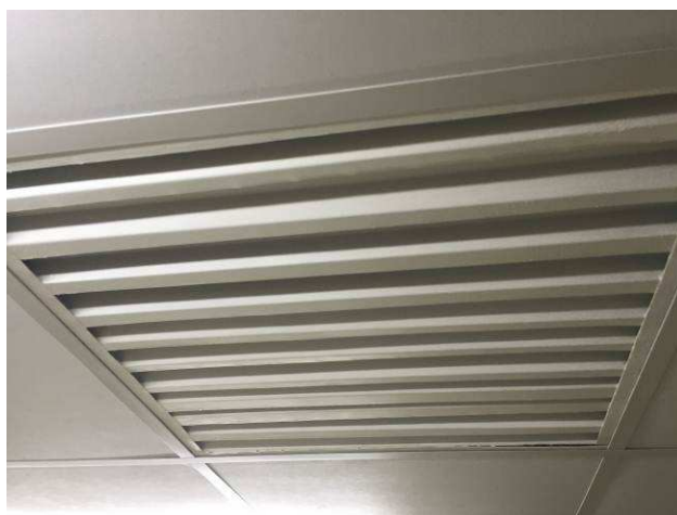
Figura 27C: Detalhe da estrutura identificada na figura anterior.
