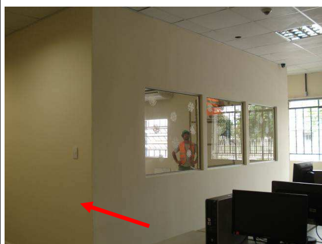
Figura 04C: Área onde houve remoção de painel de vidro para abertura de passagem para o balcão de atendimento.
