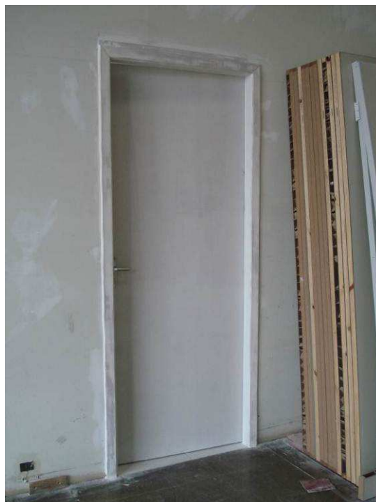
Figura 46C: Porta PM 80, no acesso à sala da informática pela doca 05, pintada com esmalte acetinado branco da Suvinil.
