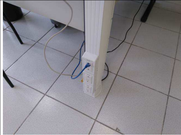
Figura 45E: Tomadas RJ45 cat6.
