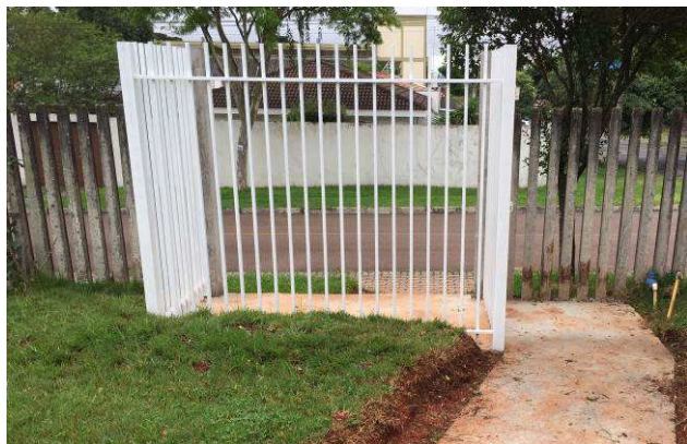
Figura 43C: Pintura executada no gradil delimitador da área da lixeira e respectivo portão.
