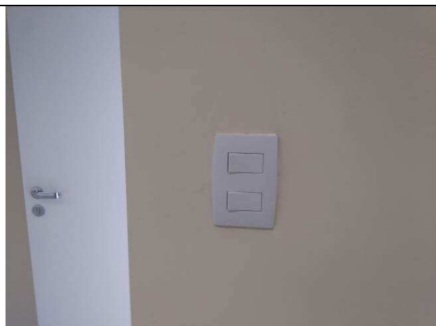
Figura 16E: Interruptores padrão modular.
