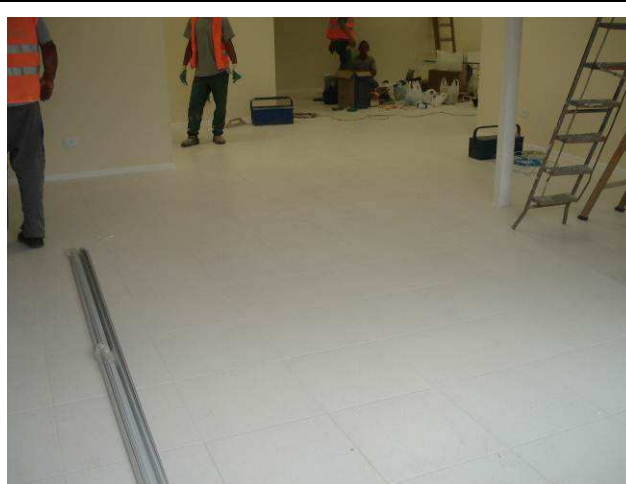
Figura 15: Piso cerâmico Eliane, linha Cargo Plus, cor branca, assentado na secretaria do Projeto Horizontes.
