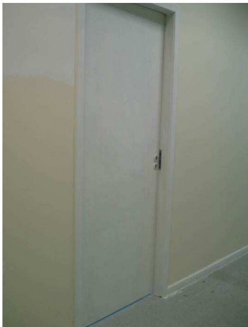
Figura 28C: Porta PM 80 instalada na sala de audiências do Projeto Horizontes (na foto ainda sem fechadura/maçaneta).
