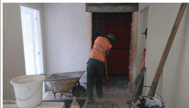
Figura 02C: Vão demolido em parede de alvenaria para abertura de passagem localizada na Secretaria do Projeto Horizontes.
