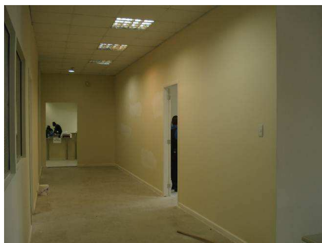
Figura 10C: Paredes em gesso acartonado simples executadas na sala de audiências do Projeto Horizontes.
