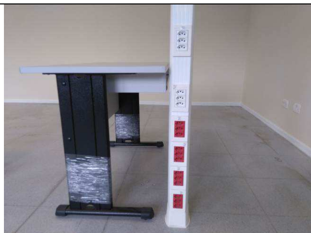
Figura 14E: tomadas padrão Dutotec.
